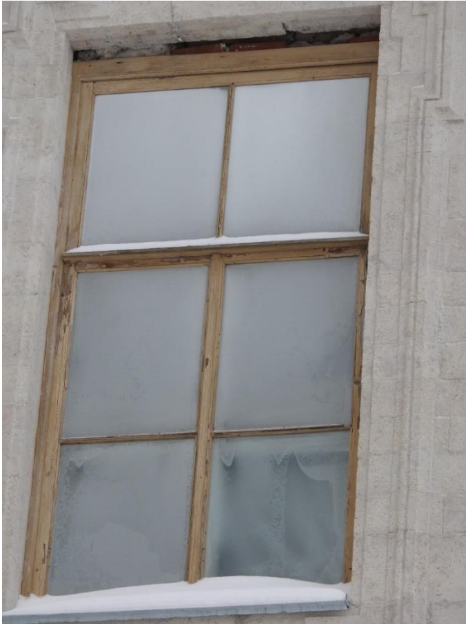
22. «Гатчинский дворец (с Арсенальным и Кухонным каре), 1766-1781 гг., арх. А. Ринальди, Ленинградская область, г. Гатчина, Красноармейский пр., д. 1(Литера А). Смотровая башня (4) Кухонного каре. Северо-западный фасад. Фрагмент. Фото 02.03.2021 г.
