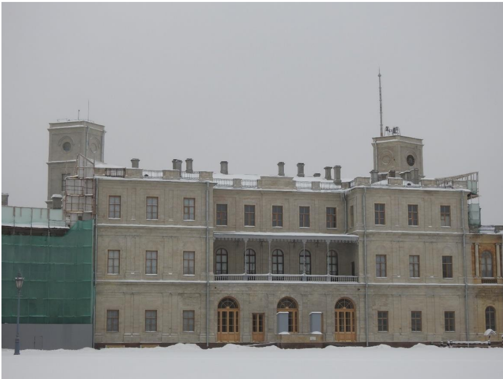
7. «Гатчинский дворец (с Арсенальным и Кухонным каре), 1766-1781 гг., арх. А. Ринальди, Ленинградская область, г. Гатчина, Красноармейский пр., д. 1(Литера А). Юго-западный фасад. Центральный корпус. Фото 02.03.2021 г.
