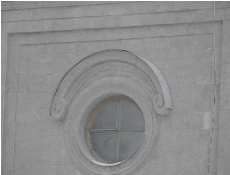
9. «Гатчинский дворец (с Арсенальным и Кухонным каре), 1766-1781 гг., арх. А. Ринальди, Ленинградская область, г. Гатчина, Красноармейский пр., д. 1(Литера А). Смотровая (северная) башня Кухонного каре. Юго-западный фасад. Фрагмент. Фото 02.03.2021 г.
