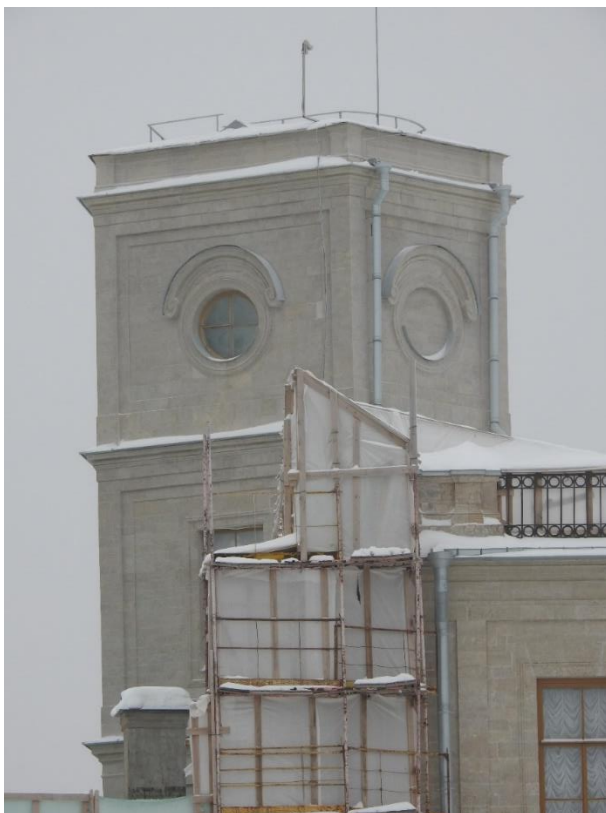
8. «Гатчинский дворец (с Арсенальным и Кухонным каре), 1766-1781 гг., арх. А. Ринальди, Ленинградская область, г. Гатчина, Красноармейский пр., д. 1(Литера А). Смотровая (северная) башня Кухонного каре. Юго-западный фасад. Фрагмент. Фото 02.03.2021 г.
