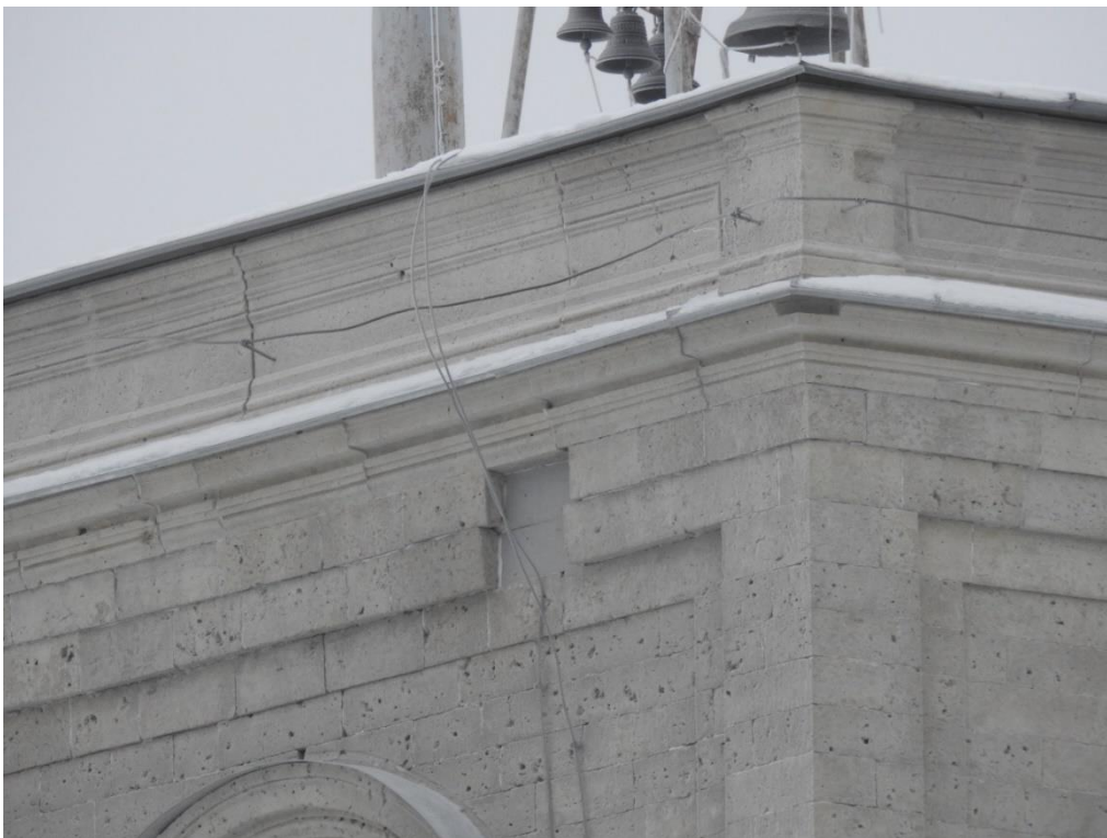
16. «Гатчинский дворец (с Арсенальным и Кухонным каре), 1766-1781 гг., арх. А. Ринальди, Ленинградская область, г. Гатчина, Красноармейский пр., д. 1(Литера А). Часовая башня Центрального корпуса. Фрагмент. Фото 02.03.2021 г.
