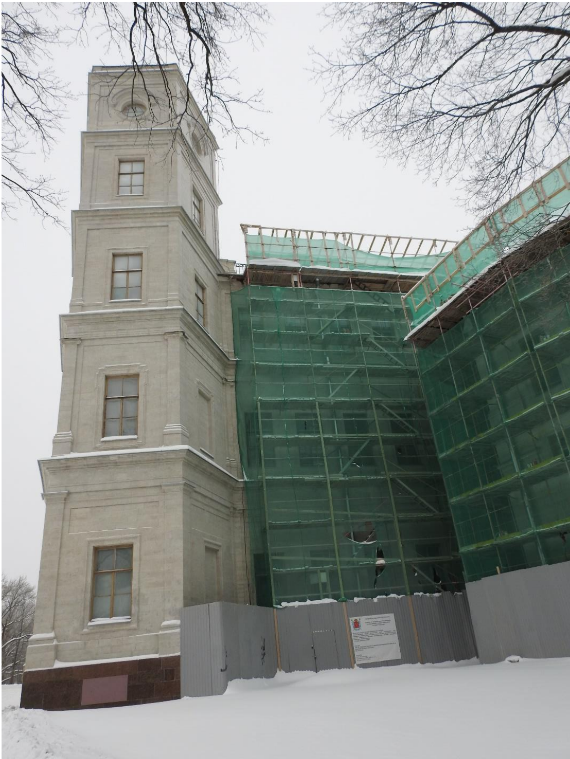
24. «Гатчинский дворец (с Арсенальным и Кухонным каре), 1766-1781 гг., арх. А. Ринальди, Ленинградская область, г. Гатчина, Красноармейский пр., д. 1 (Литера А). Смотровая башня (4) Кухонного каре. Общий вид с северо-востока. Фото 02.03.2021 г.
