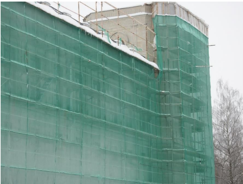
35. «Гатчинский дворец (с Арсенальным и Кухонным каре), 1766-1781 гг., арх. А. Ринальди, Ленинградская область, г. Гатчина, Красноармейский пр., д. 1(Литера А). Кухонное каре. Восточная башня (3). Северо-восточный фасад. Фрагмент. Фото 02.03.2021 г.
