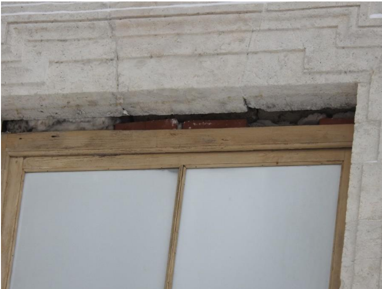
23. «Гатчинский дворец (с Арсенальным и Кухонным каре), 1766-1781 гг., арх. А. Ринальди, Ленинградская область, г. Гатчина, Красноармейский пр., д. 1(Литера А). Смотровая башня (4) Кухонного каре. Северо-западный фасад. Фрагмент. Фото 02.03.2021 г.
