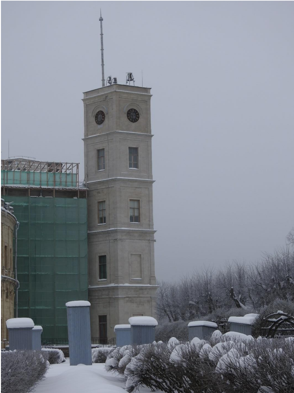
13. «Гатчинский дворец (с Арсенальным и Кухонным каре), 1766-1781 гг., арх. А. Ринальди, Ленинградская область, г. Гатчина, Красноармейский пр., д. 1(Литера А). Часовая башня Центрального корпуса. Северо-западный фасад. Фото 02.03.2021 г.
