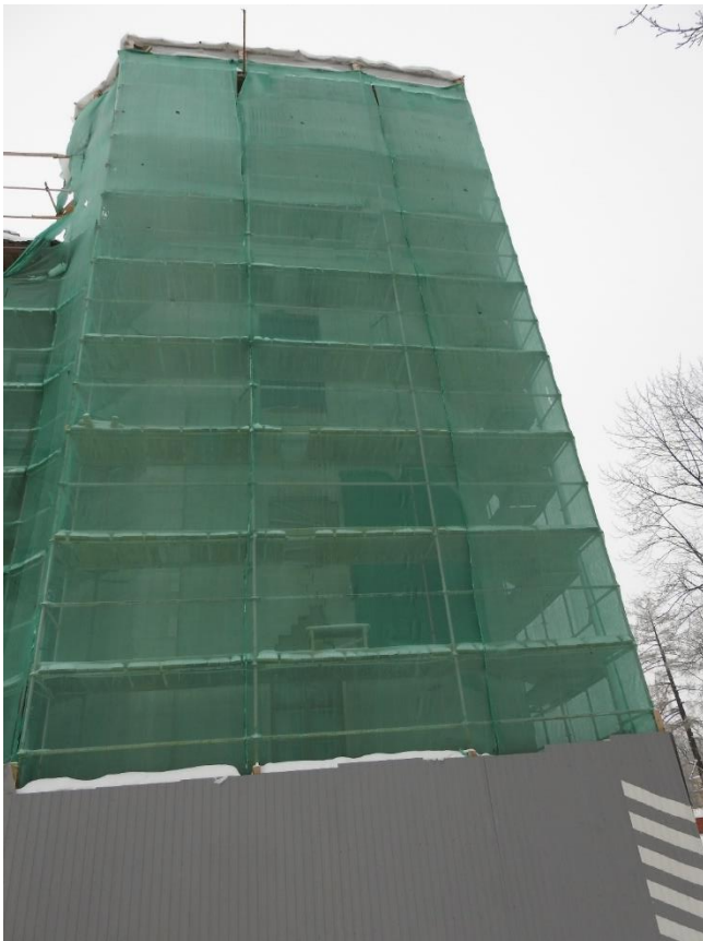
28. «Гатчинский дворец (с Арсенальным и Кухонным каре), 1766-1781 гг., арх. А. Ринальди, Ленинградская область, г. Гатчина, Красноармейский пр., д. 1(Литера А). Северная башня (4) Кухонного каре. Общий вид с северо-востока. Фото 02.03.2021 г.
