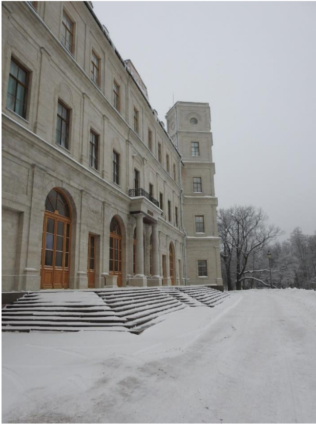
17. «Гатчинский дворец (с Арсенальным и Кухонным каре), 1766-1781 гг., арх. А. Ринальди, Ленинградская область, г. Гатчина, Красноармейский пр., д. 1(Литера А). Центральный корпус. Общий вид с северо-запада. Фото 02.03.2021 г.
