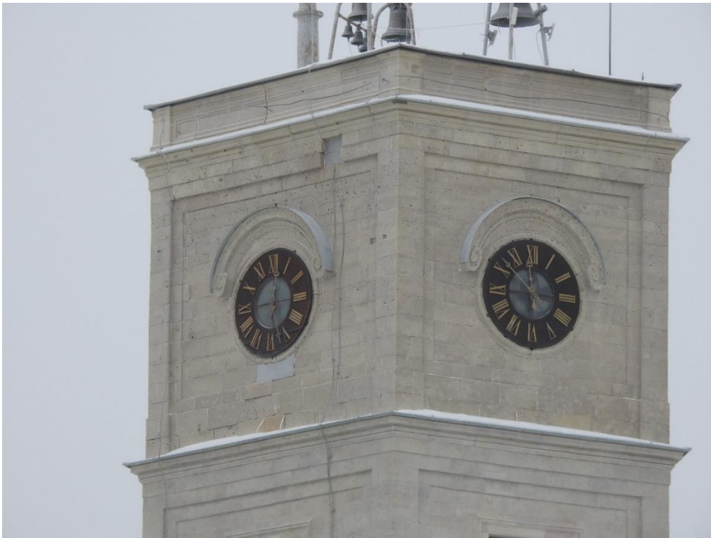
15. «Гатчинский дворец (с Арсенальным и Кухонным каре), 1766-1781 гг., арх. А. Ринальди, Ленинградская область, г. Гатчина, Красноармейский пр., д. 1(Литера А). Часовая башня Центрального корпуса. Фрагмент. Фото 02.03.2021 г.
