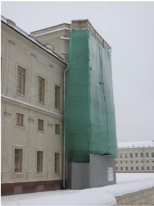
3. «Гатчинский дворец (с Арсенальным и Кухонным каре), 1766-1781 гг., арх. А. Ринальди, Ленинградская область, г. Гатчина, Красноармейский пр., д. 1(Литера А). Кухонное каре. Юго-восточный фасад. Общий вид южной башни (2). Фото 02.03.2021 г.
