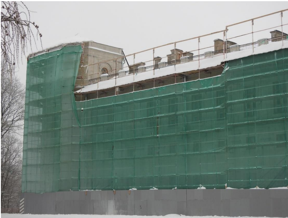
30. «Гатчинский дворец (с Арсенальным и Кухонным каре), 1766-1781 гг., арх. А. Ринальди, Ленинградская область, г. Гатчина, Красноармейский пр., д. 1(Литера А). Кухонное каре. Северо-восточный фасад. Фрагмент. Фото 02.03.2021 г.
