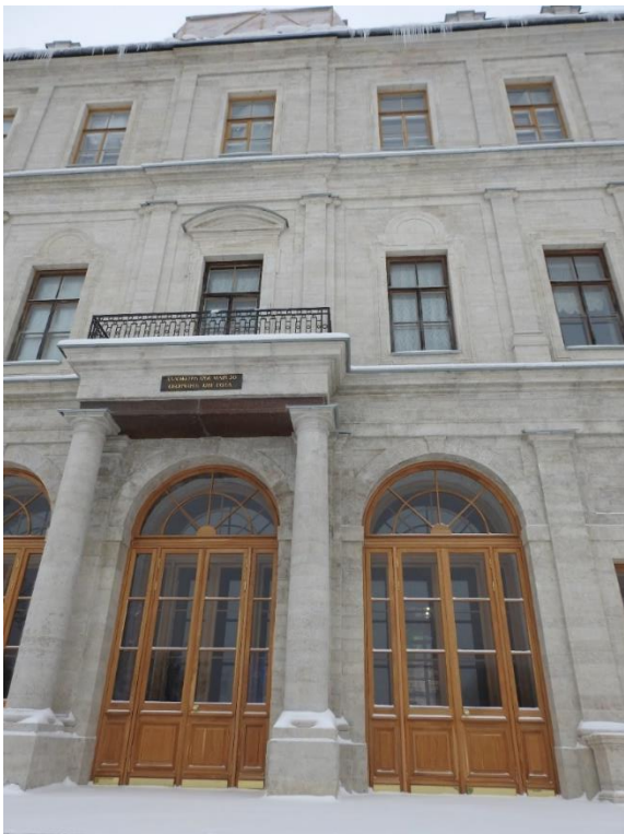
18. «Гатчинский дворец (с Арсенальным и Кухонным каре), 1766-1781 гг., арх. А. Ринальди, Ленинградская область, г. Гатчина, Красноармейский пр., д. 1(Литера А). Центральный корпус. Общий вид с северо-запада. Фрагмент. Фото 02.03.2021 г.
