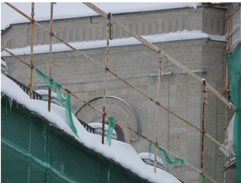
36. «Гатчинский дворец (с Арсенальным и Кухонным каре), 1766-1781 гг., арх. А. Ринальди, Ленинградская область, г. Гатчина, Красноармейский пр., д. 1 (Литера А). Кухонное каре. Восточная башня (3). Северо-восточный фасад. Фрагмент. Фото 02.03.2021 г.
