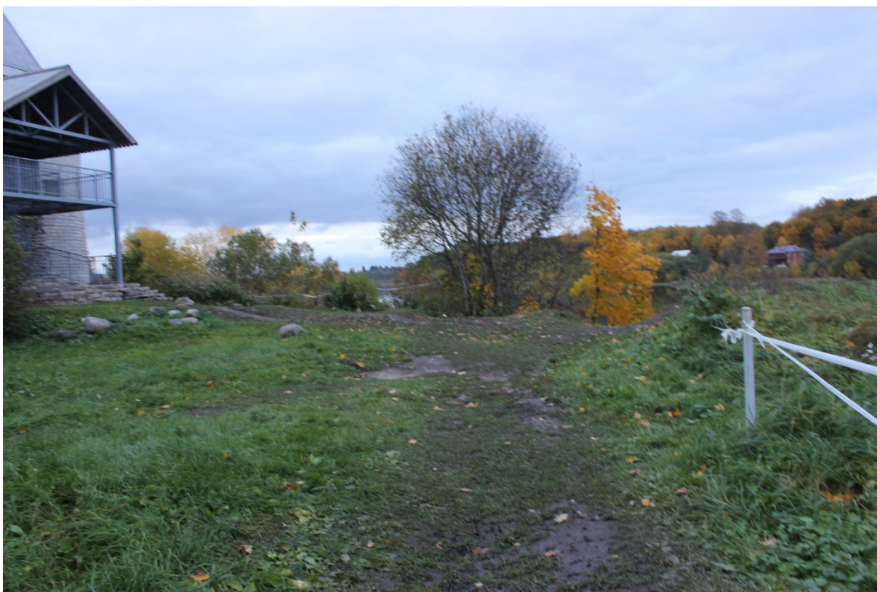
45. Место расположения северо-восточного прясла. Вид с юго-запада.
