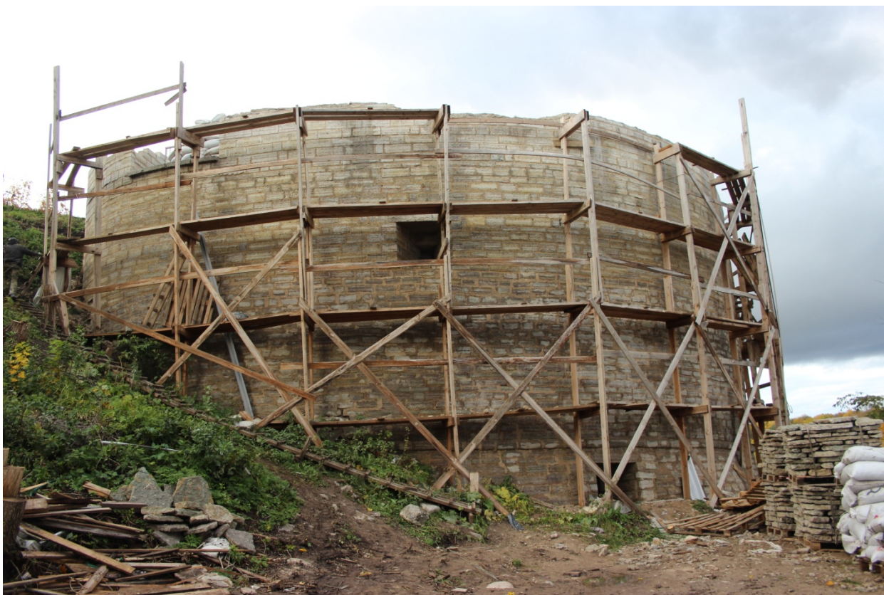
42. Раскатная башня. Вид с юга.
