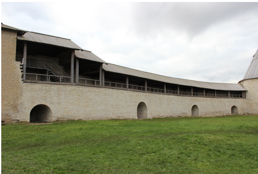
10. Северо-западное прясло. Вид с юго-востока.
