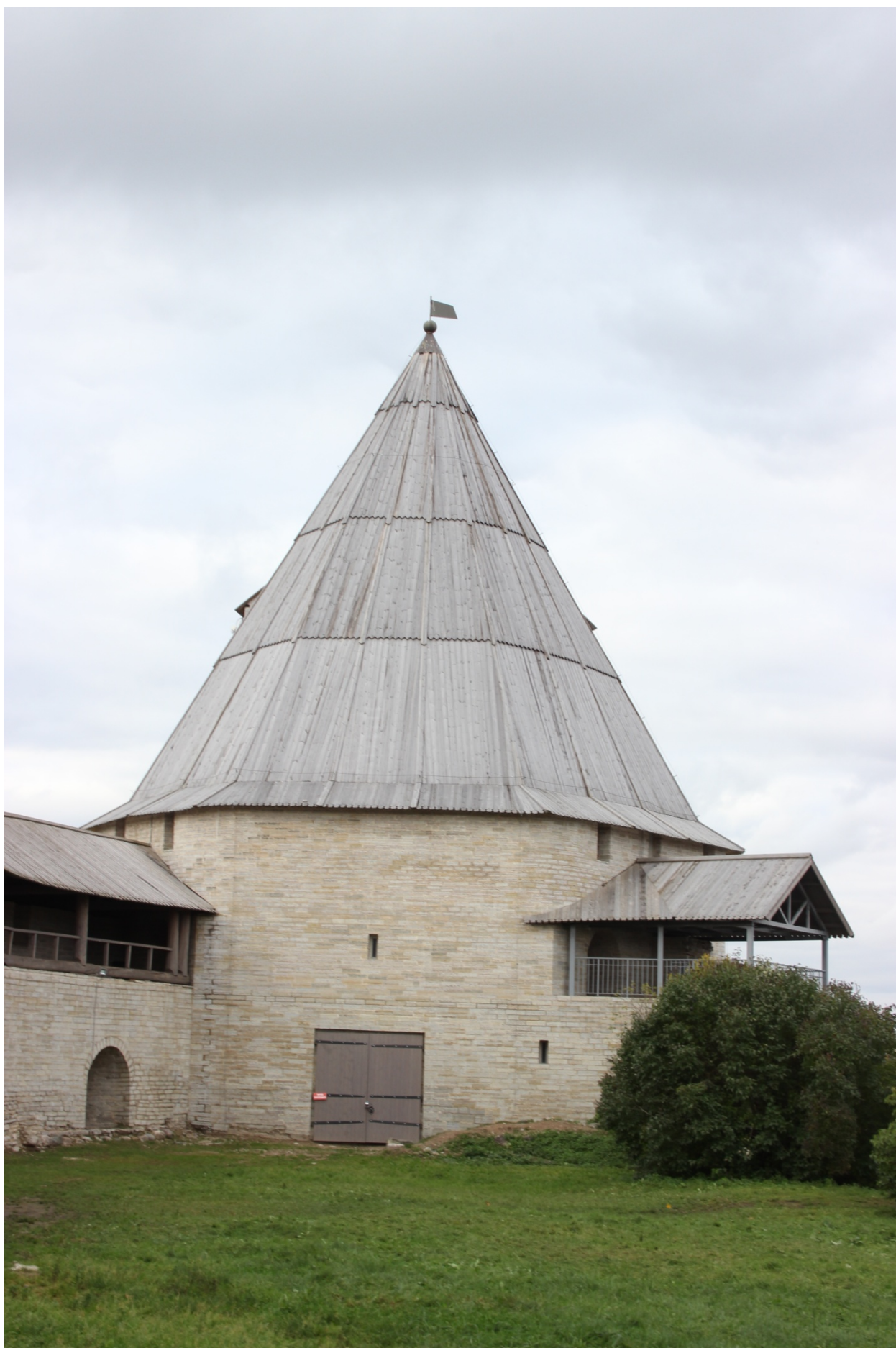
14. Стрелочная башня. Вид с юга.
