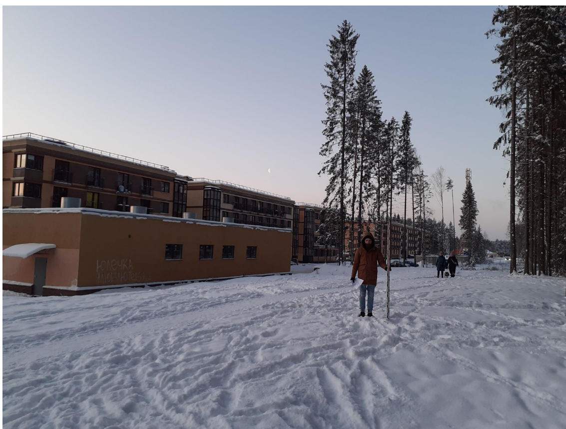
Рис. 31. Фотофиксация 2021 г. ОКН «Углежогная куча Сертолово 4». Общий вид с востока.
