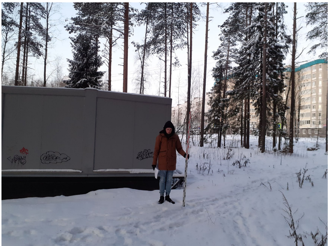
Рис. 23. Фотофиксация 2021 г. ОКН «Углежогная куча Сертолово 1». Общий вид с юго-востока на взаимное расположение трансформаторной подстанции и углежогной кучи.
