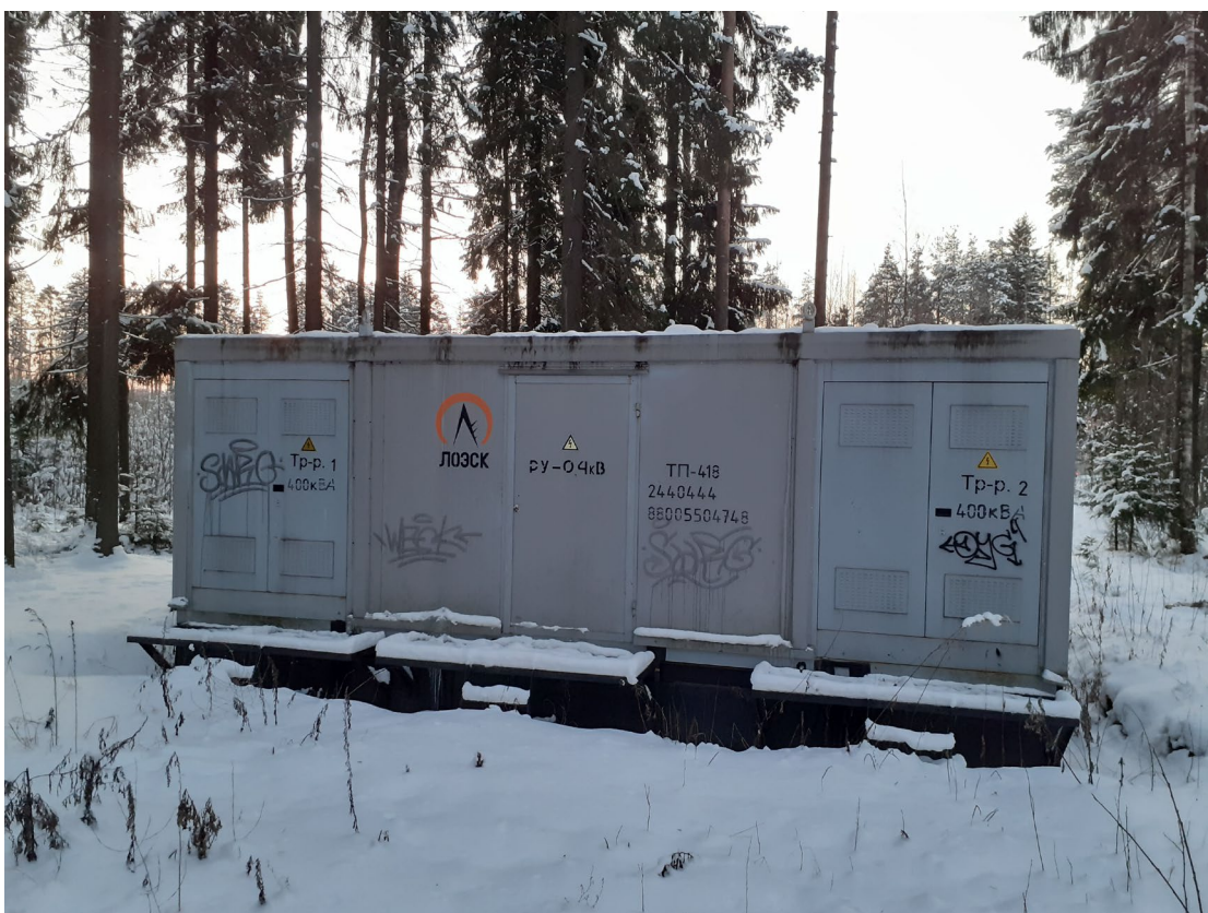
Рис. 21. Фотофиксация 2021 г. ОКН «Углежогная куча Сертолово 1». Общий вид на трансформаторную подстанцию (ТП-418) с севера.
