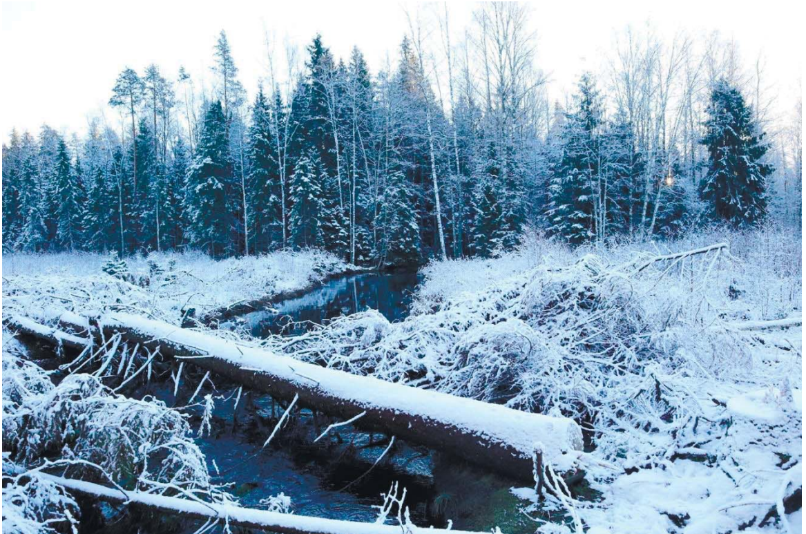
Рис. 493. Ленинградская область, Выборгский район. Строительство подъездной автомобильной дороги к «Приморскому универсально-перегрузочному комплексу» в Морском порту Приморск от автомобильной дороги федерального значения А-181 «Скандинавия». Переход трассы проектируемой автодороги через р. Большая. Вид с юго-запада
