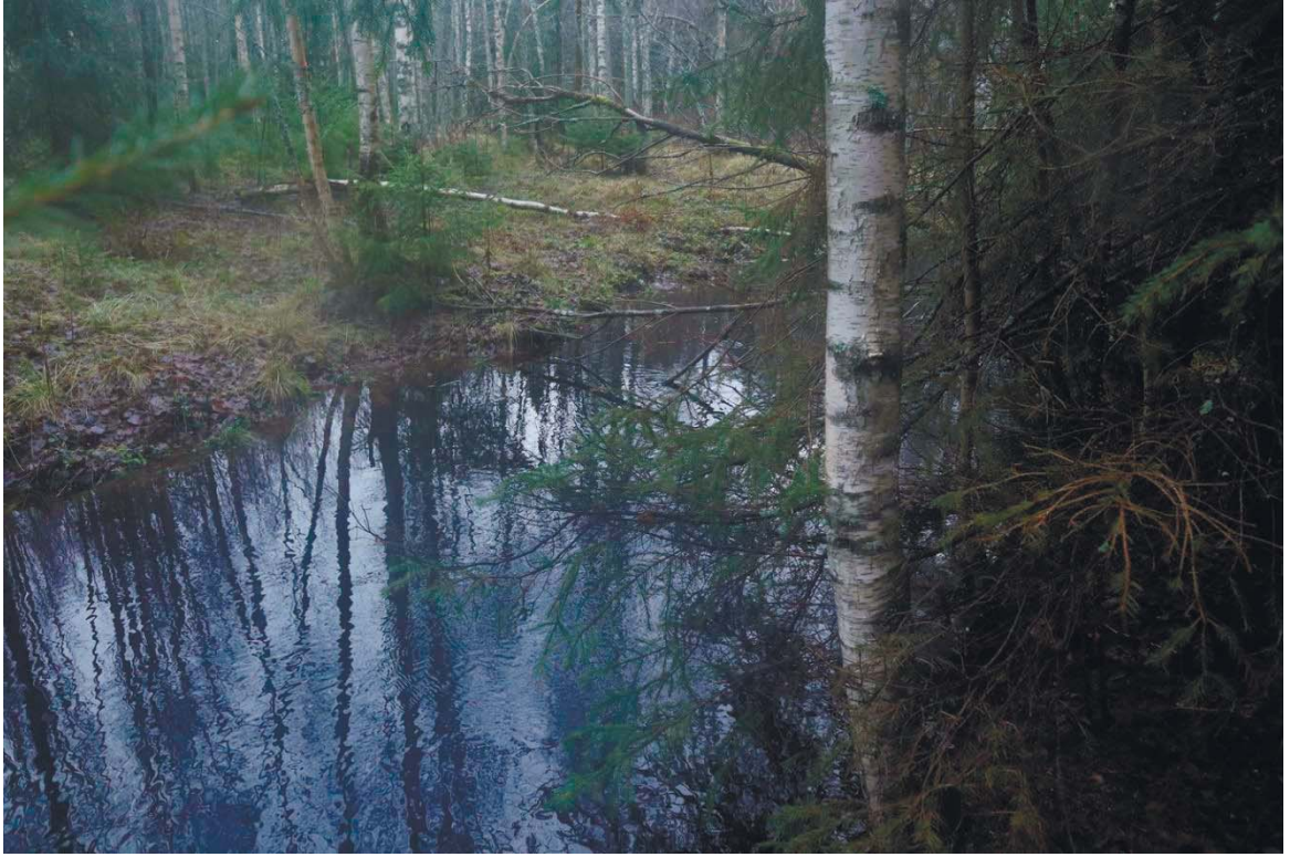
Рис. 363. Ленинградская область, Выборгский район. Строительство подъездной автомобильной дороги к «Приморскому универсально-перегрузочному комплексу» в Морском порту Приморск от автомобильной дороги федерального значения А-181 «Скандинавия». Прохождение трассы проектируемой автодороги через безымянный ручей, впадающий в озеро Каменка. Вид с востока
