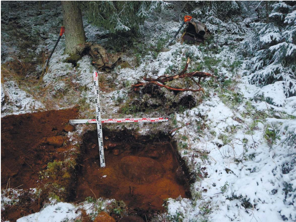
Рис. 511. Ленинградская область, Выборгский район. Строительство подъездной автомобильной дороги к «Приморскому универсально-перегрузочному комплексу» в Морском порту Приморск от автомобильной дороги федерального значения А-181 «Скандинавия». Шурф 98. Общий вид зачистки по материковому слою. Вид с юга
