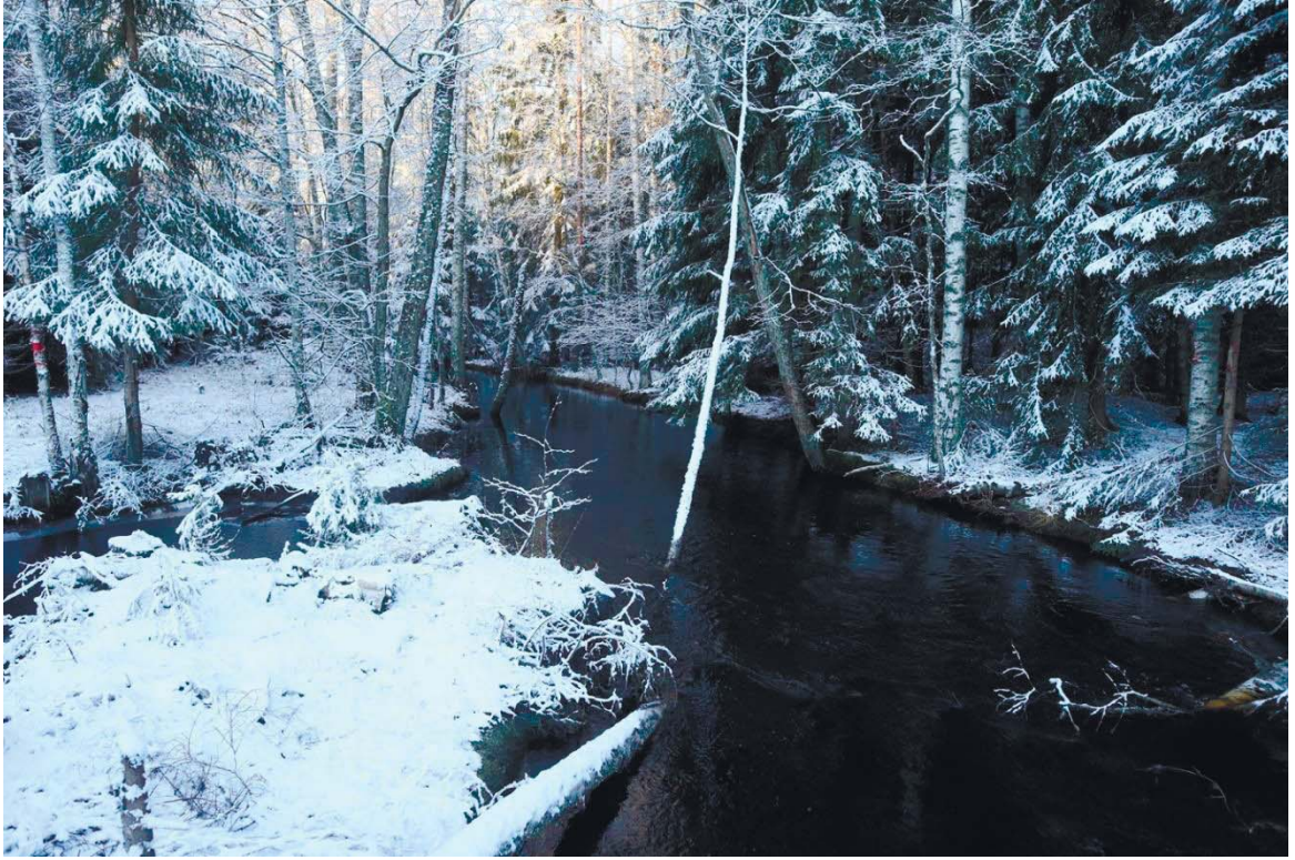
Рис. 492. Ленинградская область, Выборгский район. Строительство подъездной автомобильной дороги к «Приморскому универсально-перегрузочному комплексу» в Морском порту Приморск от автомобильной дороги федерального значения А-181 «Скандинавия». Переход трассы проектируемой автодороги через р. Большая. Вид с юга
