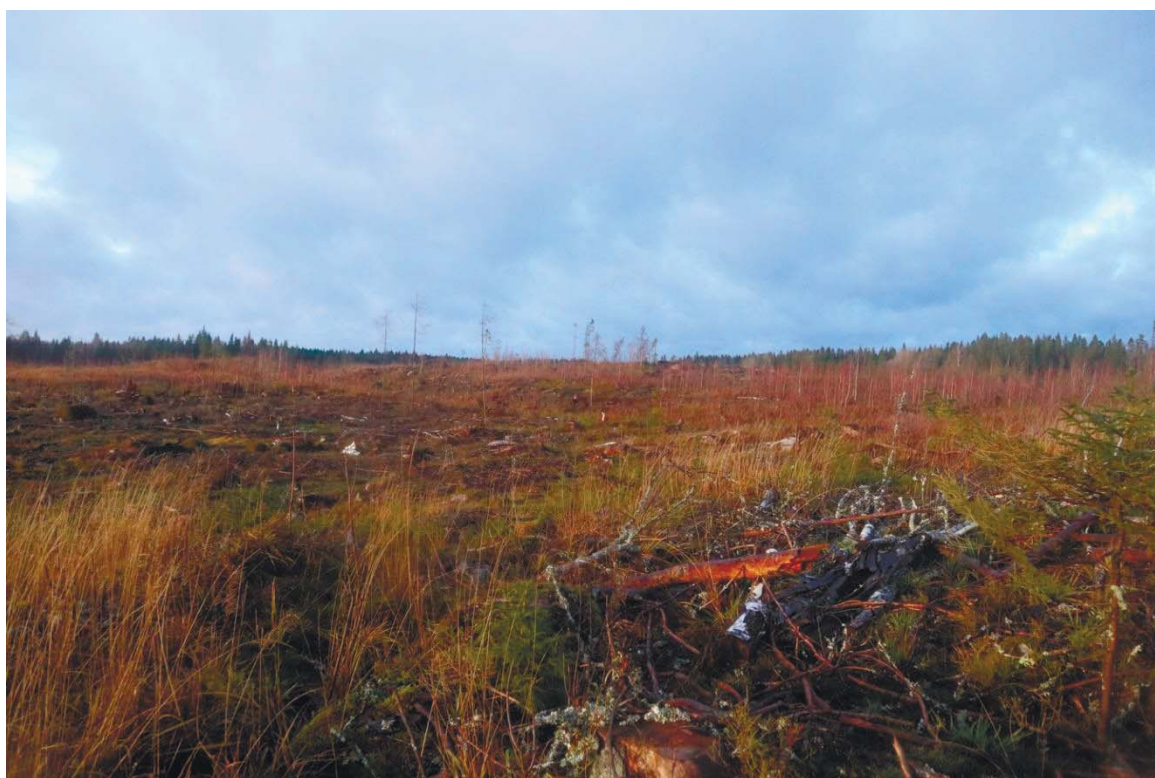
Рис. 368. Ленинградская область, Выборгский район. Строительство подъездной автомобильной дороги к «Приморскому универсально-перегрузочному комплексу» в Морском порту Приморск от автомобильной дороги федерального значения А-181 «Скандинавия». Прохождение трассы проектируемой автодороги по вырубке к югу от р. Гороховка. Вид с севера
