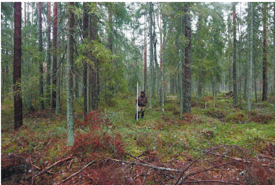
Рис. 334. Ленинградская область, Выборгский район. Строительство подъездной автомобильной дороги к «Приморскому универсально-перегрузочному комплексу» в Морском порту Приморск от автомобильной дороги федерального значения А-181 «Скандинавия». Прохождение трассы проектируемой автодороги по лесному массиву к северо-востоку от оз. Мережное. Вид с севера
