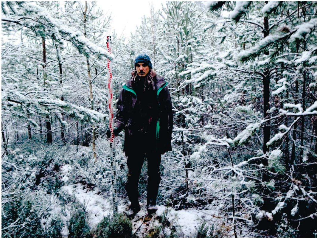
Рис. 230. Ленинградская область, Выборгский район. Строительство подъездной автомобильной дороги к «Приморскому универсально-перегрузочному комплексу» в Морском порту Приморск от автомобильной дороги федерального значения А-181 «Скандинавия». Шурф 47. Общий вид до начала работ. Вид с юга
