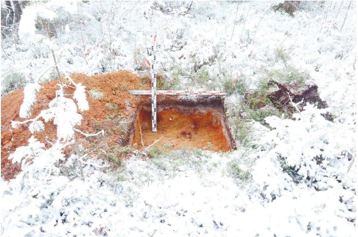
Рис. 489. Ленинградская область, Выборгский район. Строительство подъездной автомобильной дороги к «Приморскому универсально-перегрузочному комплексу» в Морском порту Приморск от автомобильной дороги федерального значения А-181 «Скандинавия». Шурф 94. Общий вид зачистки по материковому слою. Вид с юга
