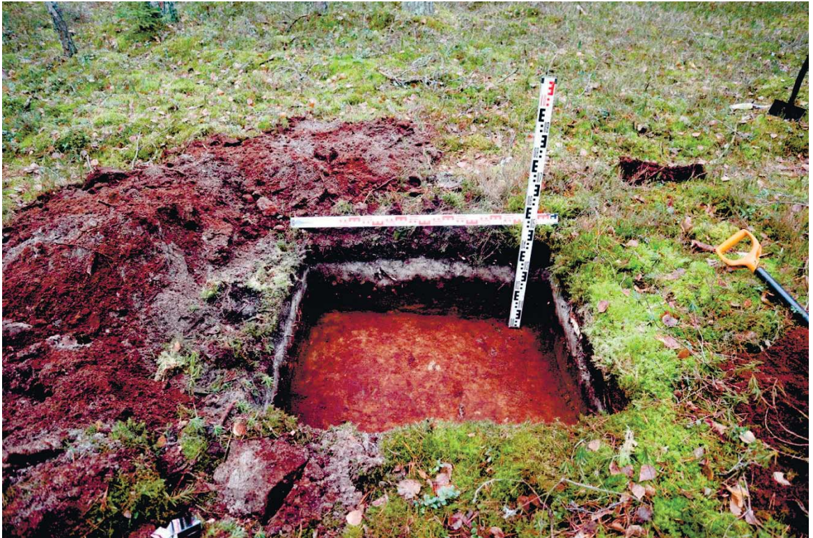
Рис. 68. Ленинградская область, Выборгский район. Строительство подъездной автомобильной дороги к «Приморскому универсально-перегрузочному комплексу» в Морском порту Приморск от автомобильной дороги федерального значения А-181 «Скандинавия». Шурф 10. Общий вид зачистки по материковому слою. Вид с юга
