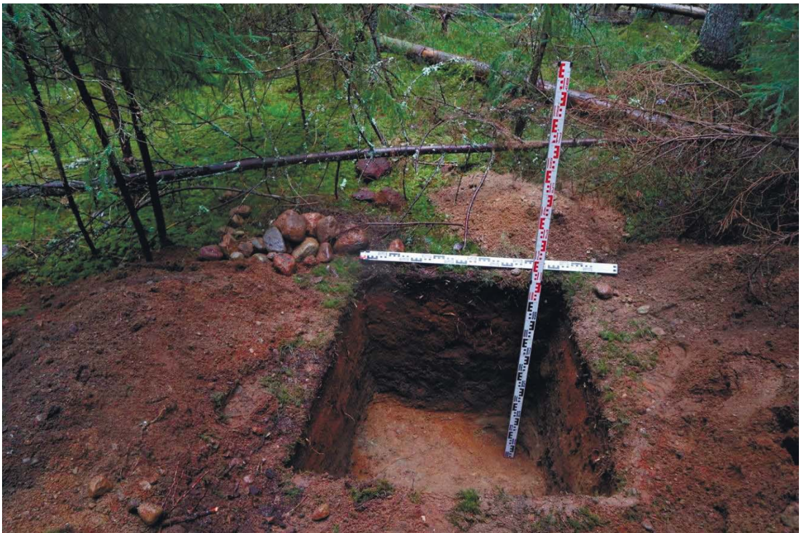
Рис. 391. Ленинградская область, Выборгский район. Строительство подъездной автомобильной дороги к «Приморскому универсально-перегрузочному комплексу» в Морском порту Приморск от автомобильной дороги федерального значения А-181 «Скандинавия». ОАН «Стоянка Черничное 2». Шурф 75. Общий вид зачистки по материковому слою. Вид с юга
