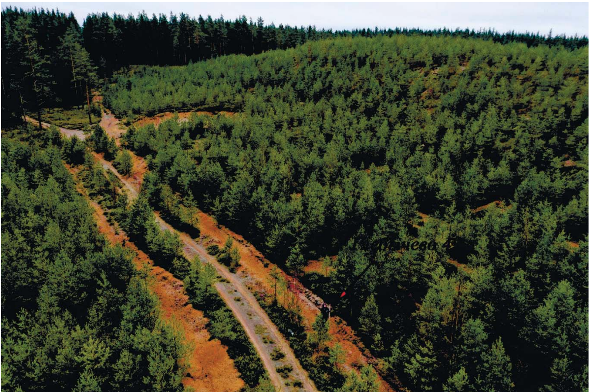
Рис. 269. Ленинградская область, Выборгский район. Строительство подъездной автомобильной дороги к «Приморскому универсально-перегрузочному комплексу» в Морском порту Приморск от автомобильной дороги федерального значения А-181 «Скандинавия». ОАН «Глебычево 4. Стоянка». Общий вид стоянки. Вид с севера
