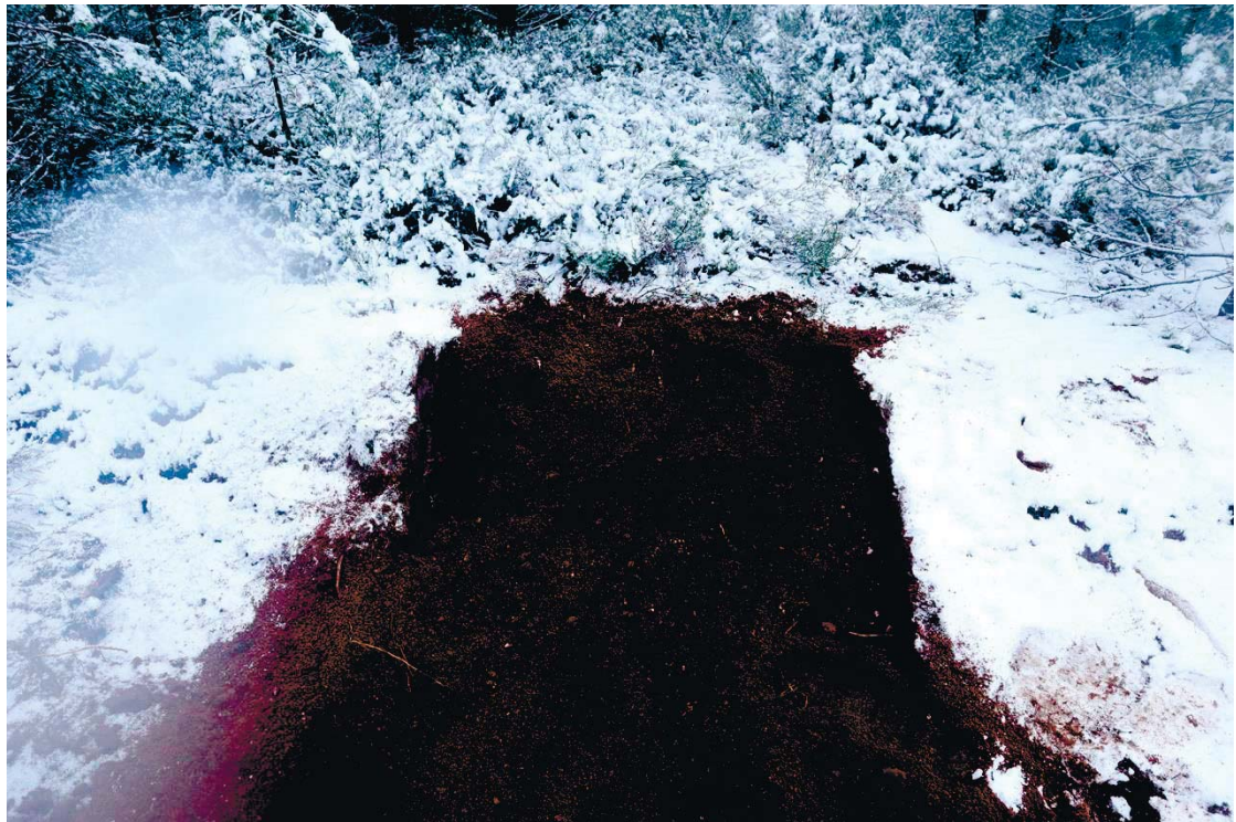
Рис. 294. Ленинградская область, Выборгский район. Строительство подъездной автомобильной дороги к «Приморскому универсально-перегрузочному комплексу» в Морском порту Приморск от автомобильной дороги федерального значения А-181 «Скандинавия». Шурф 60. Рекультивация. Вид с юга
