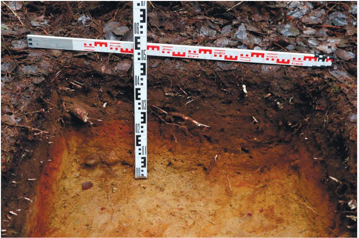
Рис. 400. Ленинградская область, Выборгский район. Строительство подъездной автомобильной дороги к «Приморскому универсально-перегрузочному комплексу» в Морском порту Приморск от автомобильной дороги федерального значения А-181 «Скандинавия». ОАН «Стоянка Черничное 2». Шурф 76. Стратиграфия северной стенки. Вид с юга
