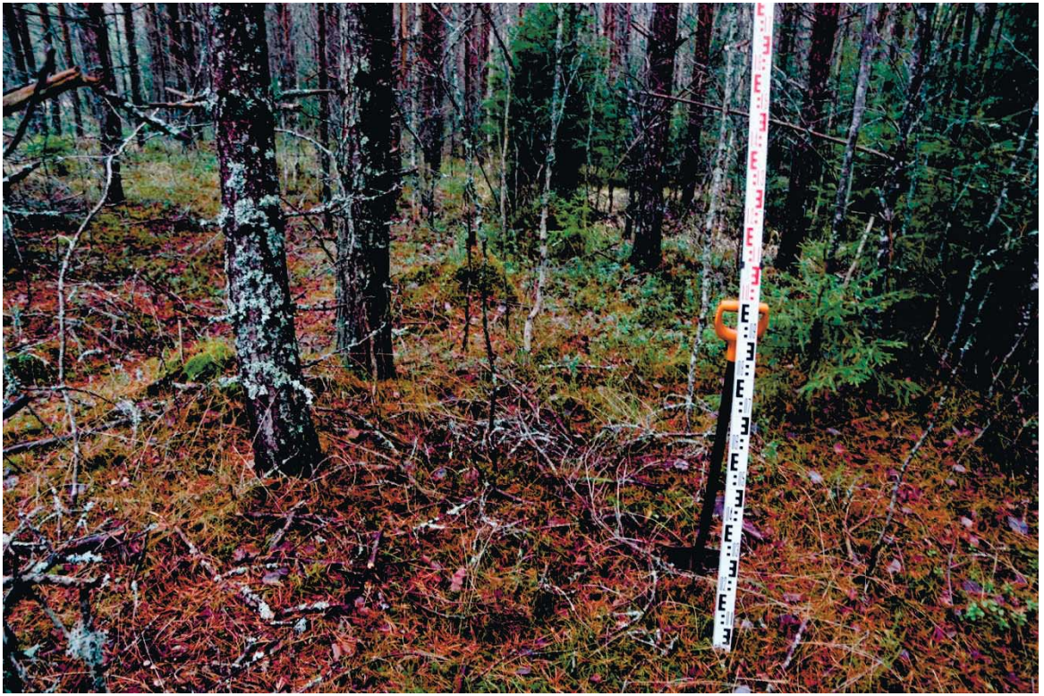
Рис. 95. Ленинградская область, Выборгский район. Строительство подъездной автомобильной дороги к «Приморскому универсально-перегрузочному комплексу» в Морском порту Приморск от автомобильной дороги федерального значения А-181 «Скандинавия». Шурф 17. Общий вид до начала работ. Вид с юга
