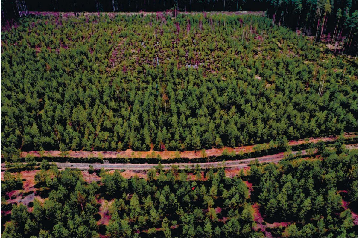
Рис. 268. Ленинградская область, Выборгский район. Строительство подъездной автомобильной дороги к «Приморскому универсально-перегрузочному комплексу» в Морском порту Приморск от автомобильной дороги федерального значения А-181 «Скандинавия». ОАН «Глебычево 4. Стоянка». Общий вид стоянки. Вид с юго-запада
