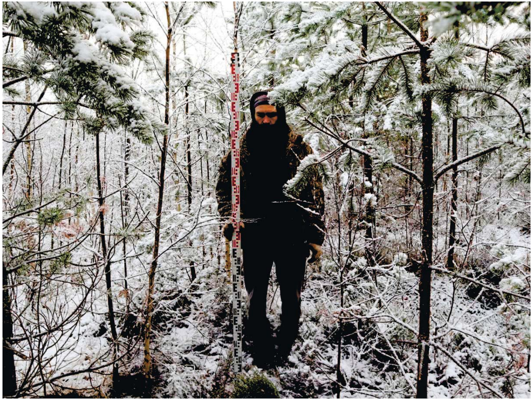
Рис. 242. Ленинградская область, Выборгский район. Строительство подъездной автомобильной дороги к «Приморскому универсально-перегрузочному комплексу» в Морском порту Приморск от автомобильной дороги федерального значения А-181 «Скандинавия». Шурф 50. Общий вид до начала работ. Вид с юга
