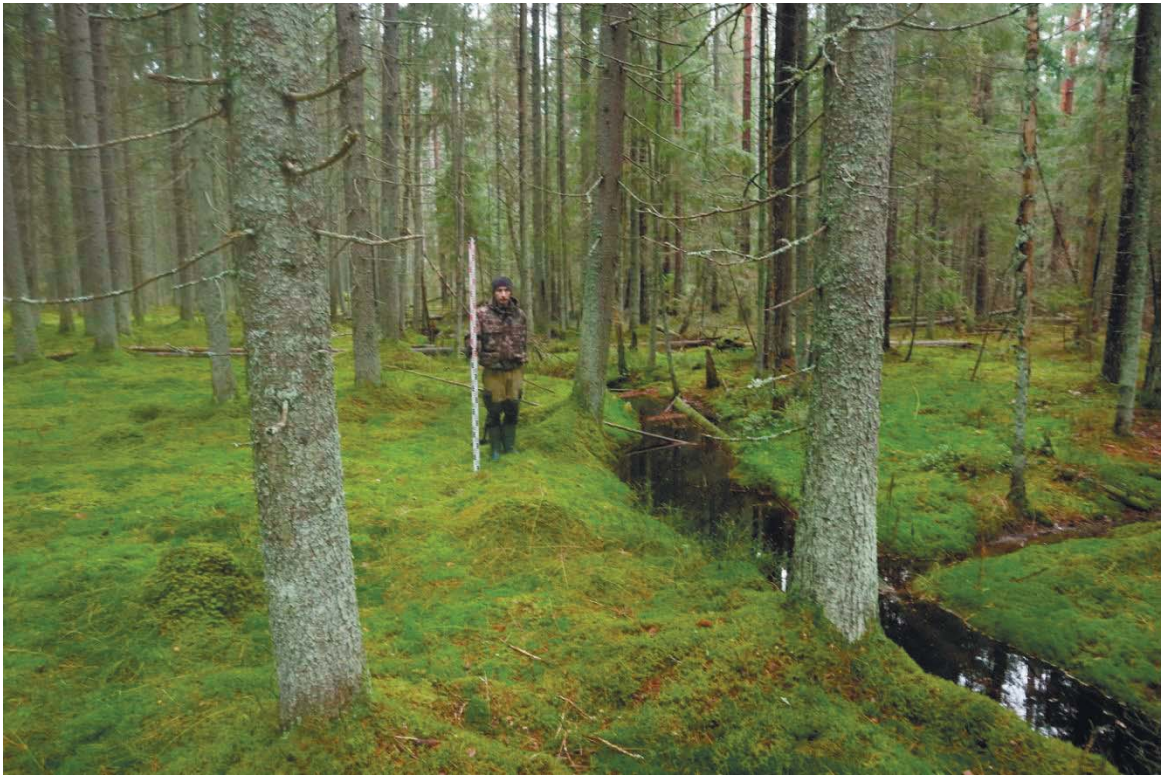
Рис. 303. Ленинградская область, Выборгский район. Строительство подъездной автомобильной дороги к «Приморскому универсально-перегрузочному комплексу» в Морском порту Приморск от автомобильной дороги федерального значения А-181 «Скандинавия». Прохождение трассы проектируемой автодороги вдоль безымянного ручья к северу от поселения Глебычево 3. Вид с северо-востока
