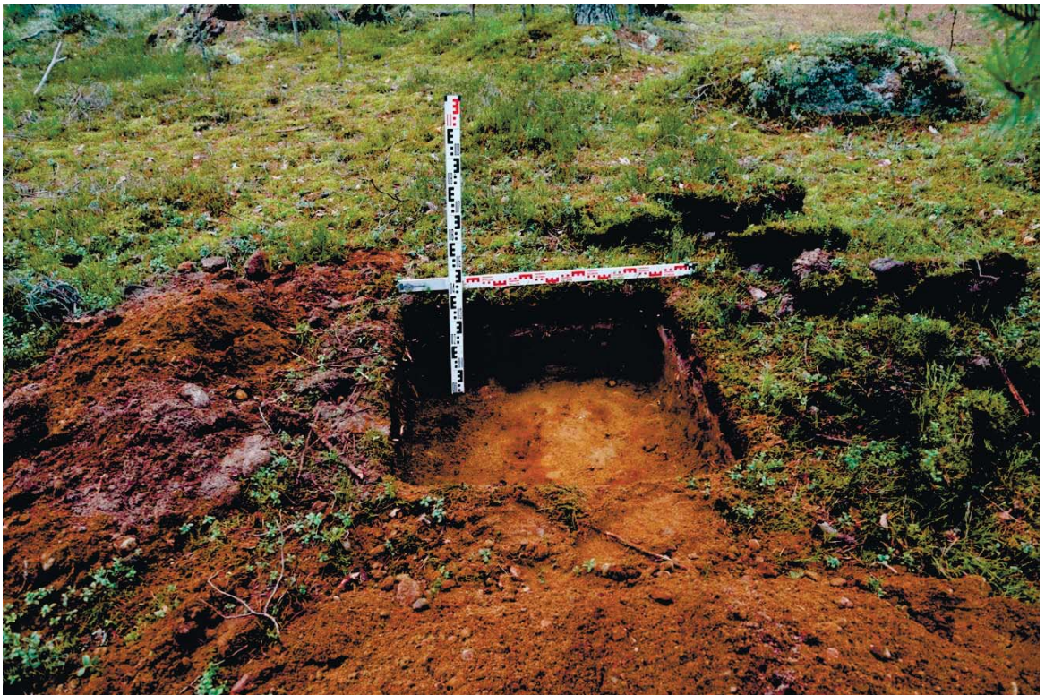
Рис. 80. Ленинградская область, Выборгский район. Строительство подъездной автомобильной дороги к «Приморскому универсально-перегрузочному комплексу» в Морском порту Приморск от автомобильной дороги федерального значения А-181 «Скандинавия». Шурф 13. Общий вид зачистки по материковому слою. Вид с юга
