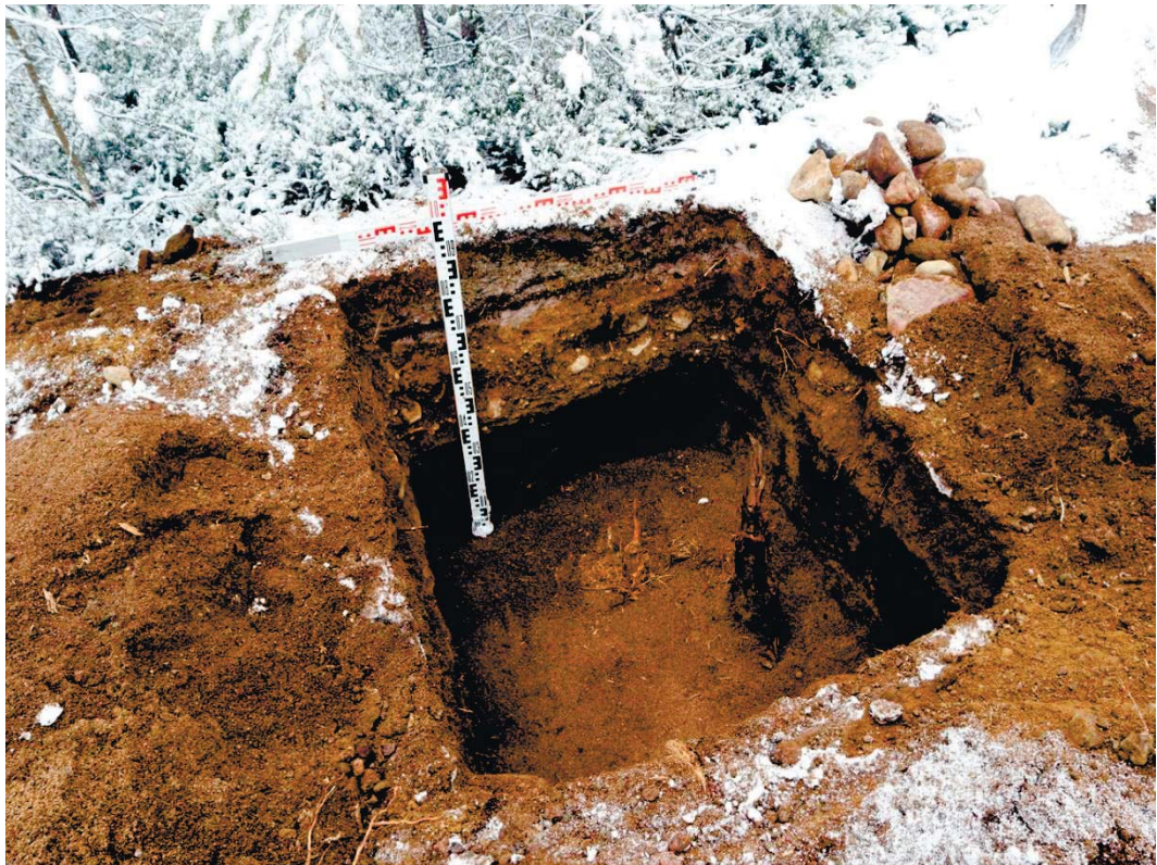
Рис. 259. Ленинградская область, Выборгский район. Строительство подъездной автомобильной дороги к «Приморскому универсально-перегрузочному комплексу» в Морском порту Приморск от автомобильной дороги федерального значения А-181 «Скандинавия». Шурф 54. Общий вид зачистки по материковому слою. Вид с юга
