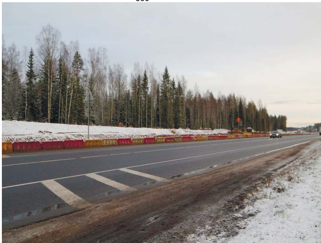
Рис. 530. Ленинградская область, Выборгский район. Строительство подъездной автомобильной дороги к «Приморскому универсально-перегрузочному комплексу» в Морском порту Приморск от автомобильной дороги федерального значения А-181 «Скандинавия». Присоединение трассы проектируемой автодороги к автодороге А-181 «Скандинавия». Вид с юго-востока
