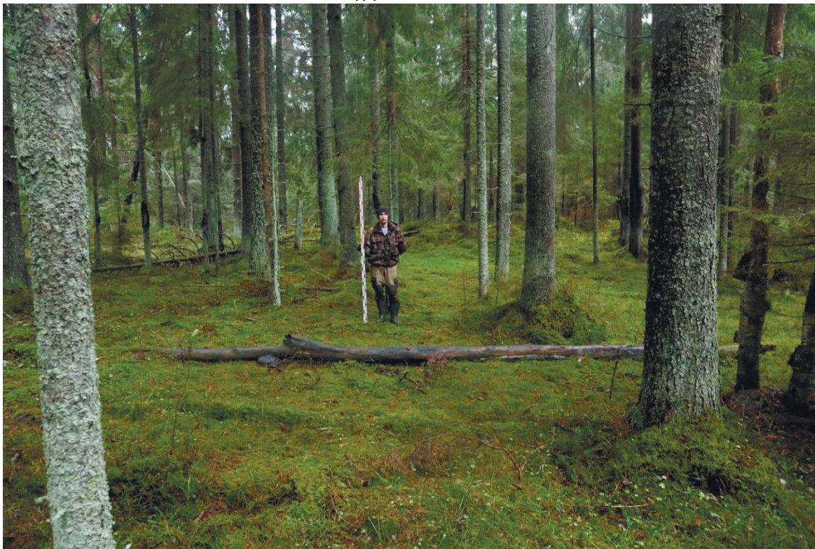
Рис. 466. Ленинградская область, Выборгский район. Строительство подъездной автомобильной дороги к «Приморскому универсально-перегрузочному комплексу» в Морском порту Приморск от автомобильной дороги федерального значения А-181 «Скандинавия». Характер леса к северу от урочища Осинник. Вид с юга
