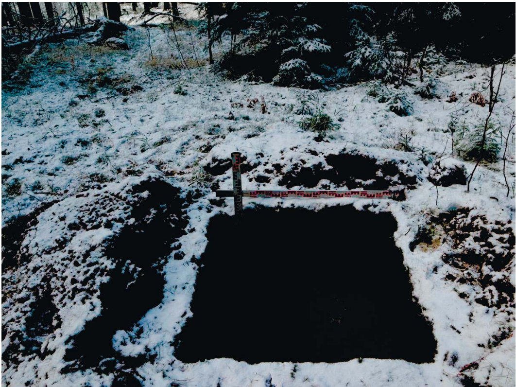
Рис. 164. Ленинградская область, Выборгский район. Строительство подъездной автомобильной дороги к «Приморскому универсально-перегрузочному комплексу» в Морском порту Приморск от автомобильной дороги федерального значения А-181 «Скандинавия». Шурф 33. Общий вид зачистки по материковому слою. Вид с юга
