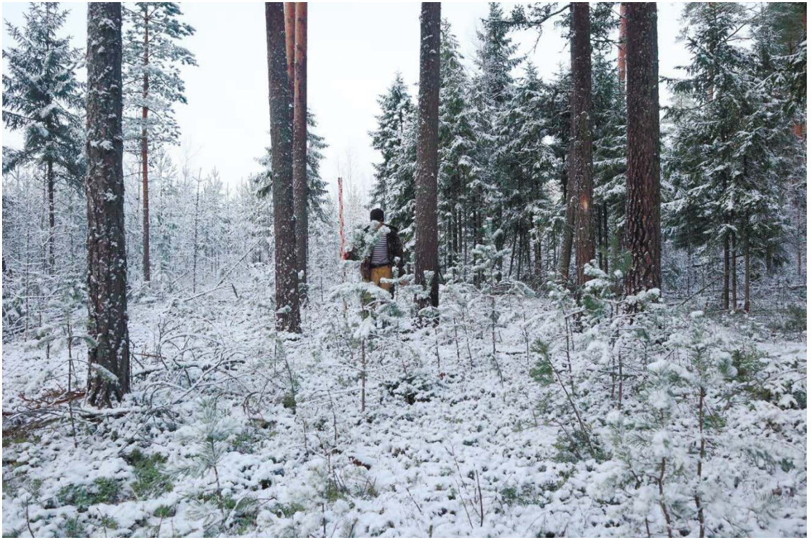
Рис. 484. Ленинградская область, Выборгский район. Строительство подъездной автомобильной дороги к «Приморскому универсально-перегрузочному комплексу» в Морском порту Приморск от автомобильной дороги федерального значения А-181 «Скандинавия». Шурф 93. Общий вид до начала работ. Вид с юга
