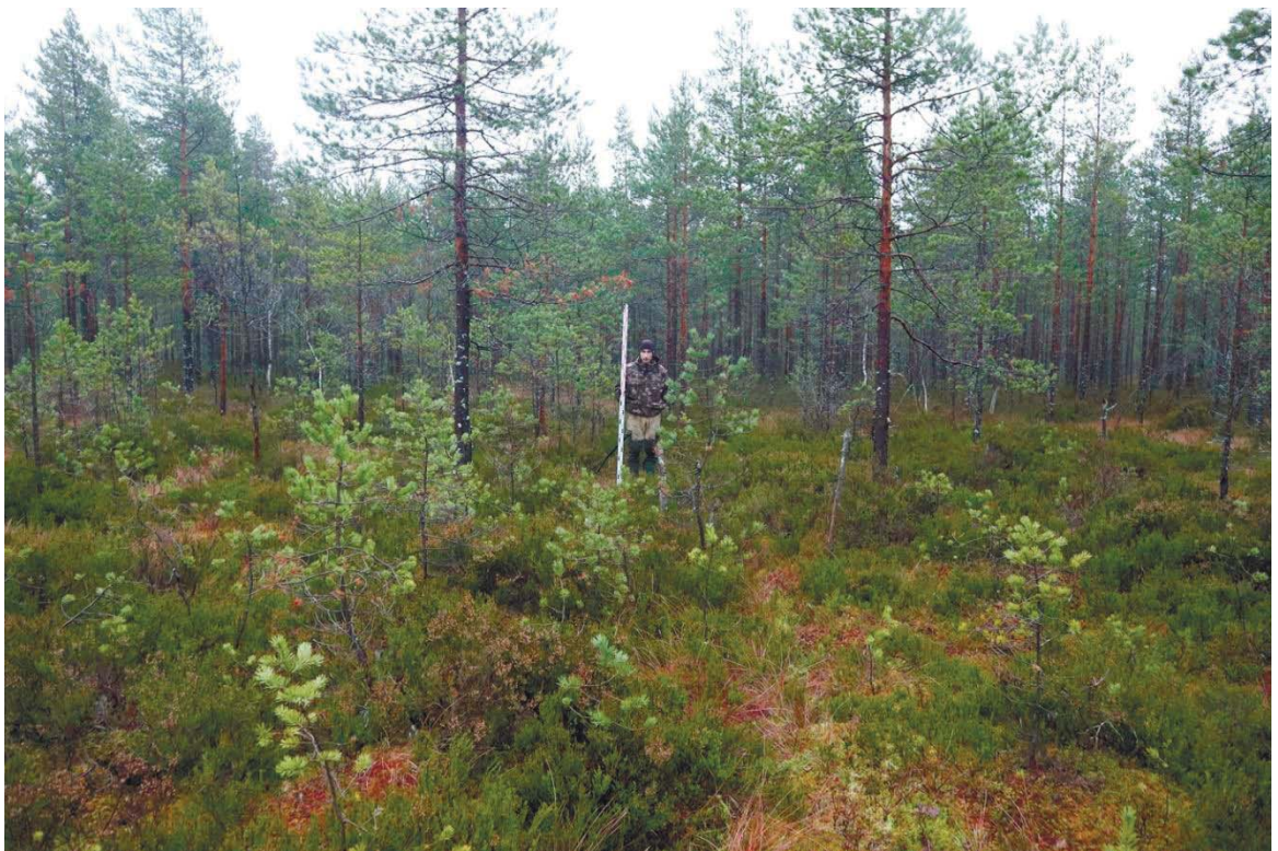
Рис. 336. Ленинградская область, Выборгский район. Строительство подъездной автомобильной дороги к «Приморскому универсально-перегрузочному комплексу» в Морском порту Приморск от автомобильной дороги федерального значения А-181 «Скандинавия». Прохождение трассы проектируемой автодороги по лесному массиву к северу от «болота Цветково». Вид с севера
