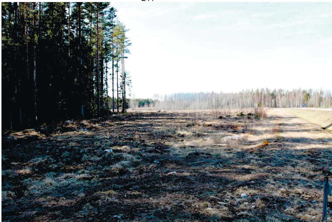
Рис. 11. Ленинградская область, Выборгский район. Строительство подъездной автомобильной дороги к «Приморскому универсально-перегрузочному комплексу» в Морском порту Приморск от автомобильной дороги федерального значения А-181 «Скандинавия». Общий вид трассы проектируемой автодороги в месте подхода к «Приморскому универсально-перегрузочному комплексу». Вид с северо-запада
