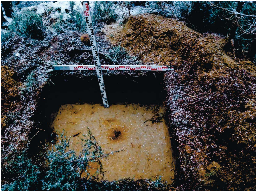
Рис. 231. Ленинградская область, Выборгский район. Строительство подъездной автомобильной дороги к «Приморскому универсально-перегрузочному комплексу» в Морском порту Приморск от автомобильной дороги федерального значения А-181 «Скандинавия». Шурф 47. Общий вид зачистки по материковому слою. Вид с юга
