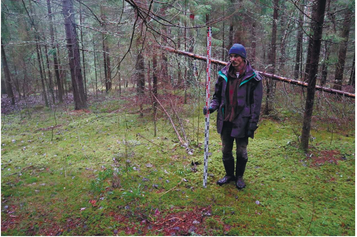
Рис. 429. Ленинградская область, Выборгский район. Строительство подъездной автомобильной дороги к «Приморскому универсально-перегрузочному комплексу» в Морском порту Приморск от автомобильной дороги федерального значения А-181 «Скандинавия». ОАН «Стоянка Черничное 2». Шурф 82. Общий вид до начала работ. Вид с юга
