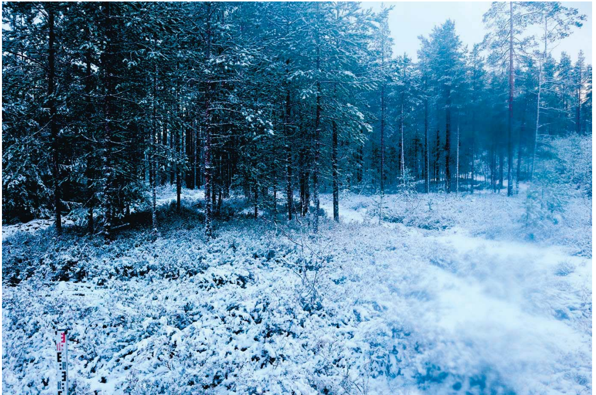
Рис. 295. Ленинградская область, Выборгский район. Строительство подъездной автомобильной дороги к «Приморскому универсально-перегрузочному комплексу» в Морском порту Приморск от автомобильной дороги федерального значения А-181 «Скандинавия». Шурф 61. Общий вид до начала работ. Вид с юга
