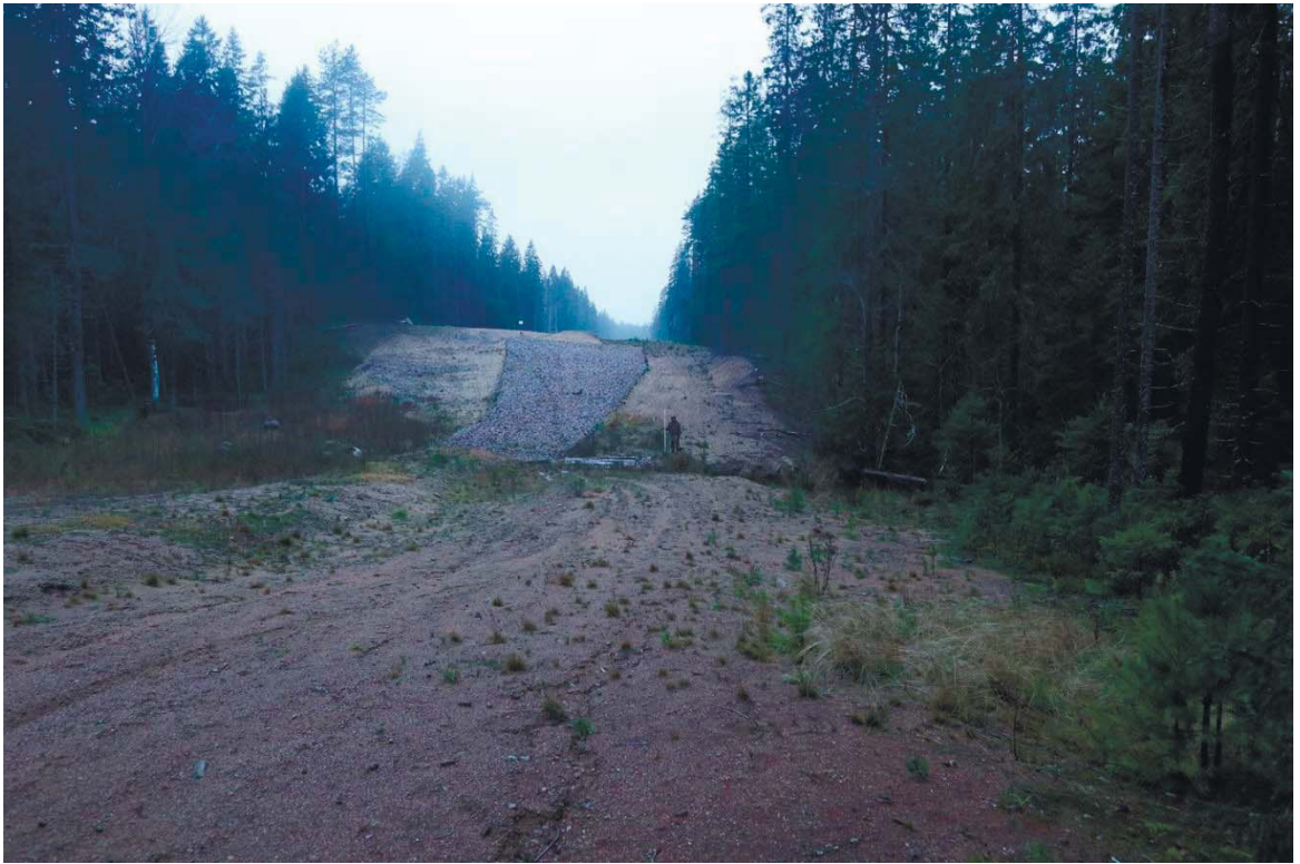
Рис. 339. Ленинградская область, Выборгский район. Строительство подъездной автомобильной дороги к «Приморскому универсально-перегрузочному комплексу» в Морском порту Приморск от автомобильной дороги федерального значения А-181 «Скандинавия». Прохождение трассы проектируемой автодороги через безымянный ручей к северу от автодороги 41К-094 на участке Малышево - Глебычево. Вид с юго-востока
