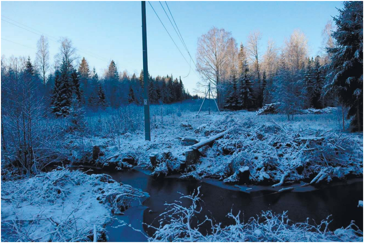
Рис. 494. Ленинградская область, Выборгский район. Строительство подъездной автомобильной дороги к «Приморскому универсально-перегрузочному комплексу» в Морском порту Приморск от автомобильной дороги федерального значения А-181 «Скандинавия». Вид на левый берег р. Большая. Вид с северо-востока
