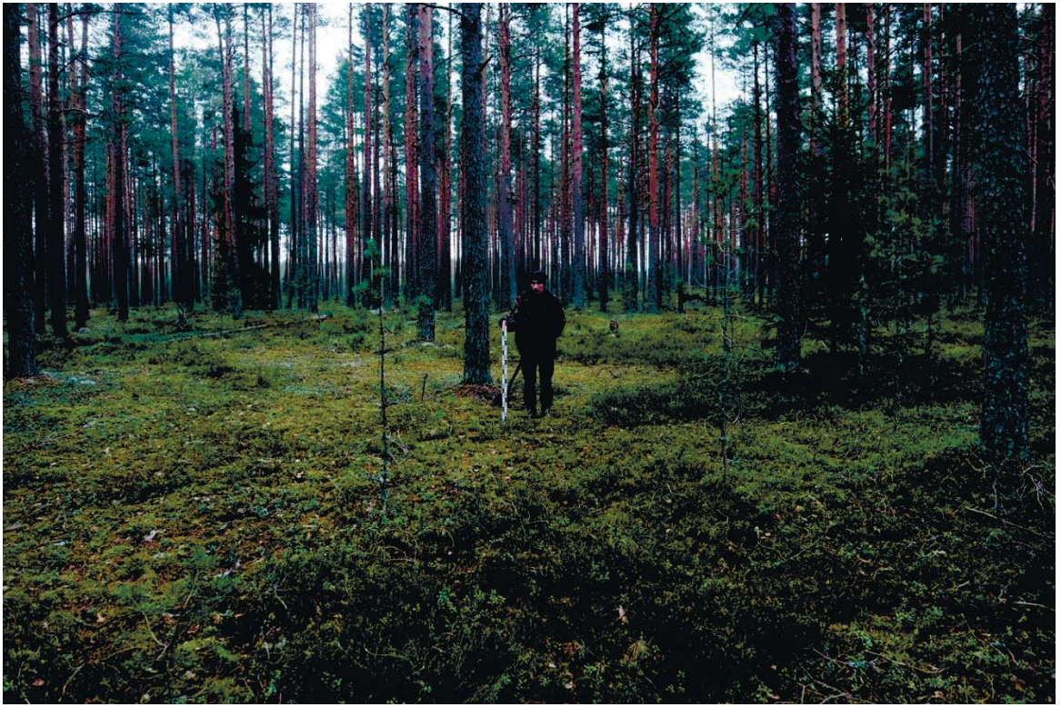
Рис. 75. Ленинградская область, Выборгский район. Строительство подъездной автомобильной дороги к «Приморскому универсально-перегрузочному комплексу» в Морском порту Приморск от автомобильной дороги федерального значения А-181 «Скандинавия». Шурф 12. Общий вид до начала работ. Вид с юга
