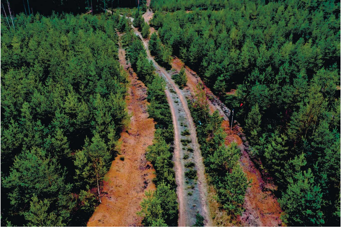
Рис. 266. Ленинградская область, Выборгский район. Строительство подъездной автомобильной дороги к «Приморскому универсально-перегрузочному комплексу» в Морском порту Приморск от автомобильной дороги федерального значения А-181 «Скандинавия». ОАН «Глебычево 4. Стоянка». Общий вид стоянки. Вид с юго-востока
