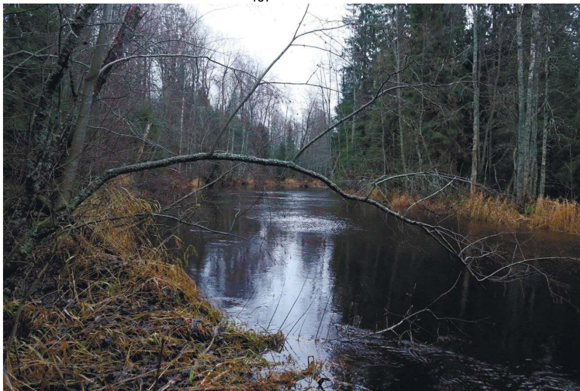
Рис. 446. Ленинградская область, Выборгский район. Строительство подъездной автомобильной дороги к «Приморскому универсально-перегрузочному комплексу» в Морском порту Приморск от автомобильной дороги федерального значения А-181 «Скандинавия». Переход трассы проектируемой автодороги через реку Гороховка. Вид с юго-востока
