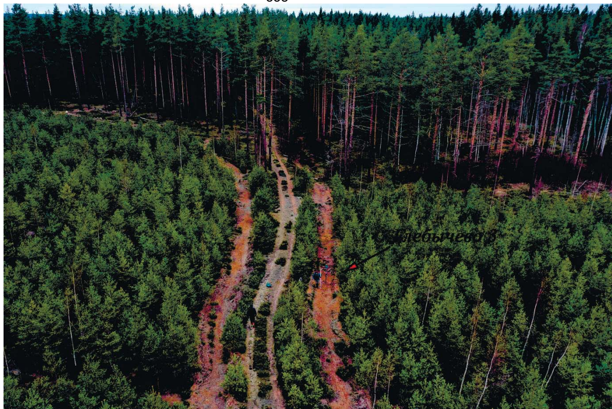
Рис. 202. Ленинградская область, Выборгский район. Строительство подъездной автомобильной дороги к «Приморскому универсально-перегрузочному комплексу» в Морском порту Приморск от автомобильной дороги федерального значения А-181 «Скандинавия». ОАН «Глебычево 3. Стоянка». Общий вид стоянки. Вид с юго-востока
