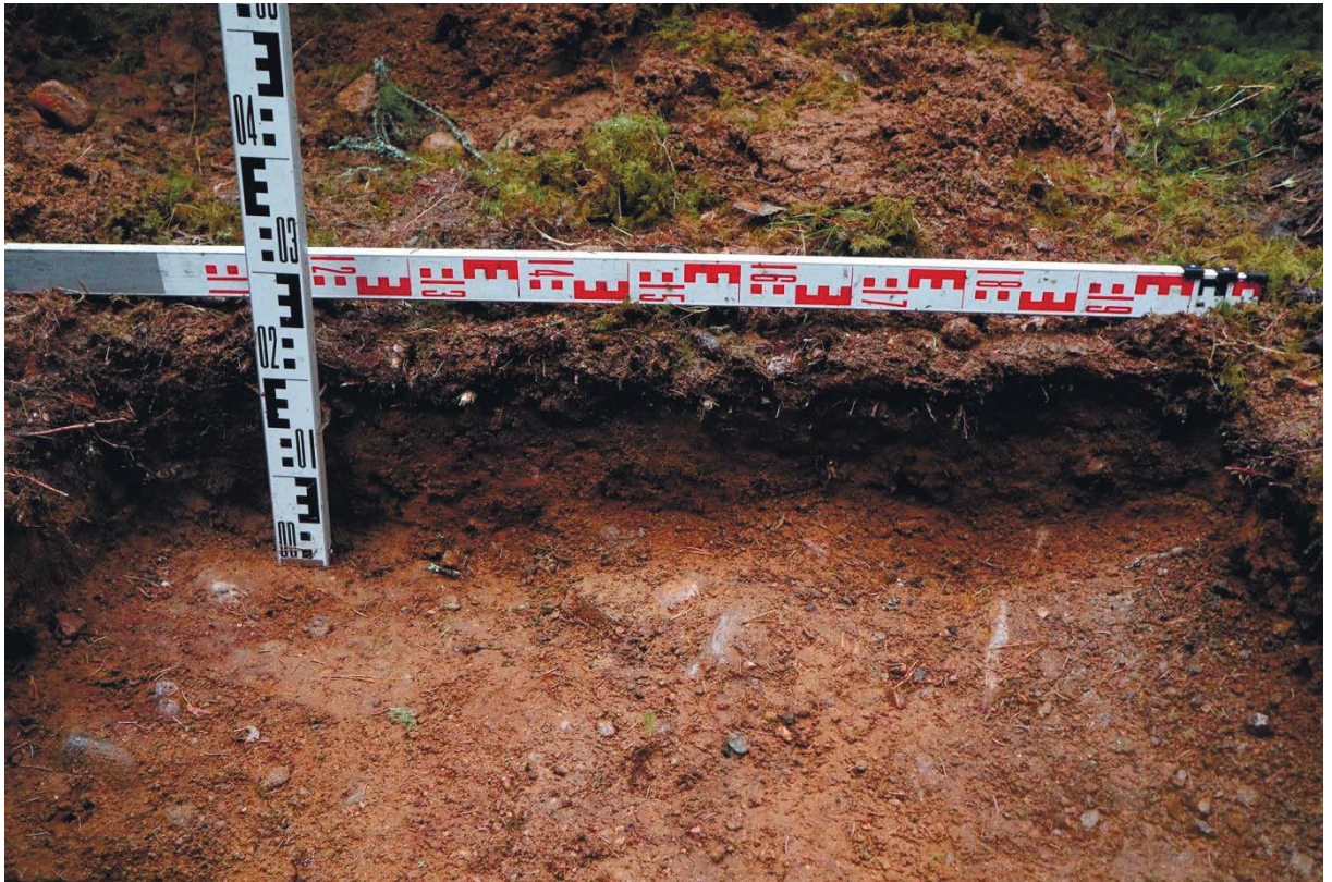
Рис. 380. Ленинградская область, Выборгский район. Строительство подъездной автомобильной дороги к «Приморскому универсально-перегрузочному комплексу» в Морском порту Приморск от автомобильной дороги федерального значения А-181 «Скандинавия». ОАН «Стоянка Черничное 2». Шурф 73. Стратиграфия южной стенки. Вид с севера
