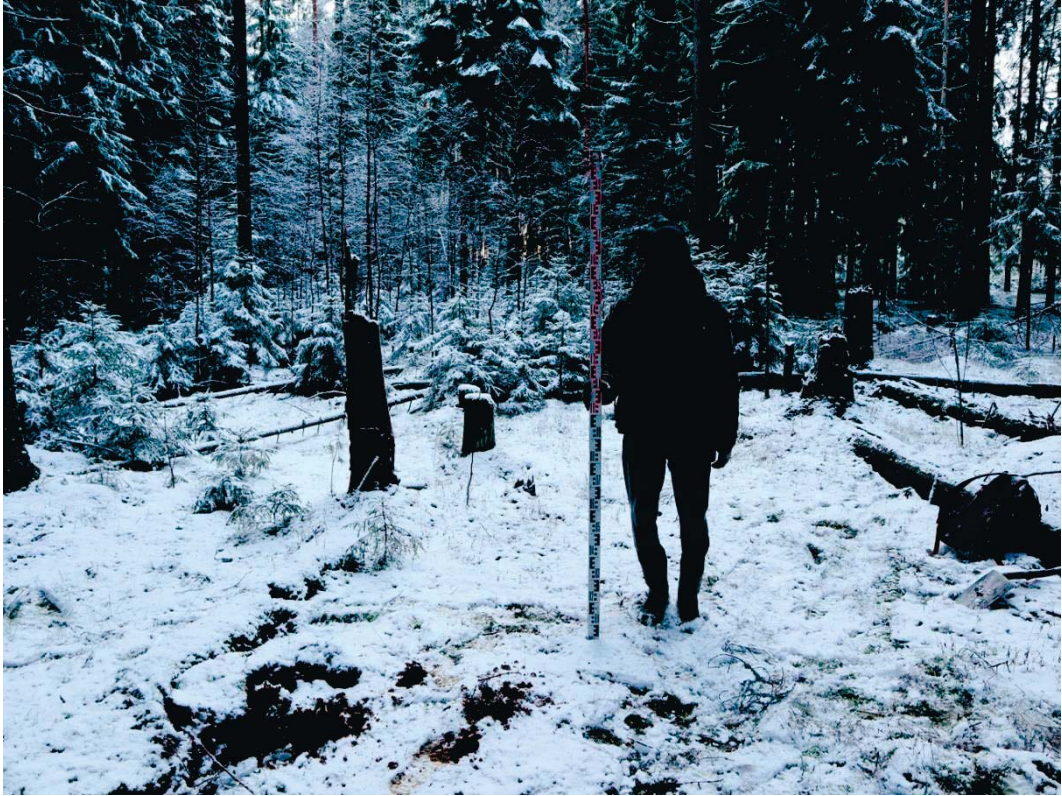
Рис. 167. Ленинградская область, Выборгский район. Строительство подъездной автомобильной дороги к «Приморскому универсально-перегрузочному комплексу» в Морском порту Приморск от автомобильной дороги федерального значения А-181 «Скандинавия». Шурф 34. Общий вид до начала работ. Вид с юга
