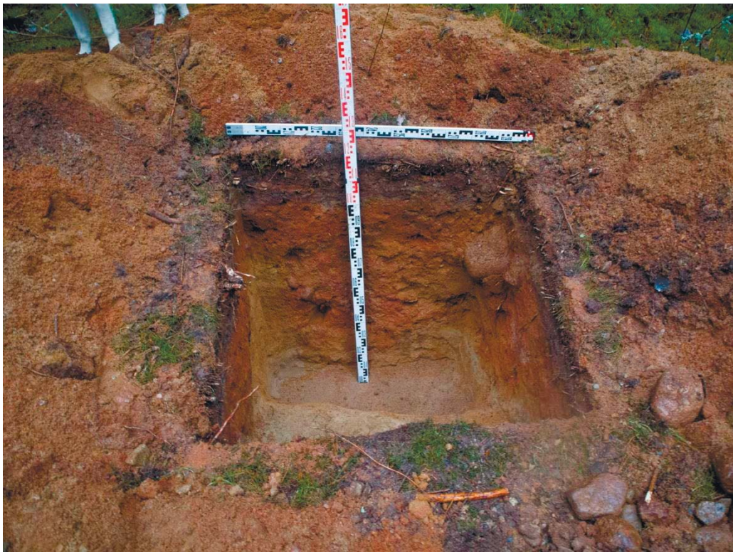
Рис. 430. Ленинградская область, Выборгский район. Строительство подъездной автомобильной дороги к «Приморскому универсально-перегрузочному комплексу» в Морском порту Приморск от автомобильной дороги федерального значения А-181 «Скандинавия». ОАН «Стоянка Черничное 2». Шурф 82. Общий вид зачистки по материковому слою. Вид с юга
