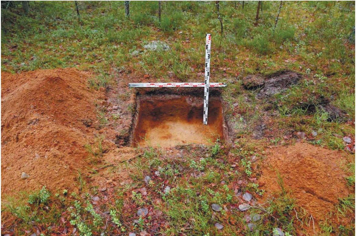
Рис. 330. Ленинградская область, Выборгский район. Строительство подъездной автомобильной дороги к «Приморскому универсально-перегрузочному комплексу» в Морском порту Приморск от автомобильной дороги федерального значения А-181 «Скандинавия». Шурф 68. Общий вид зачистки по материковому слою. Вид с юга
