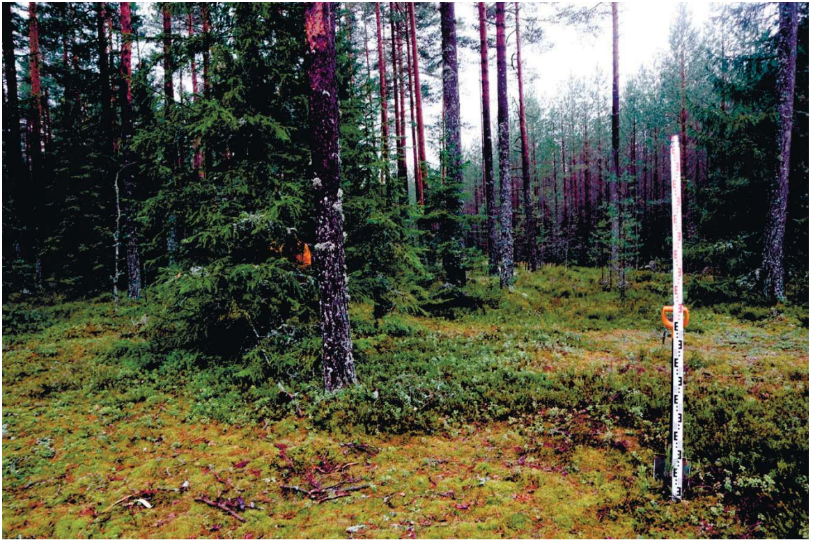
Рис. 87. Ленинградская область, Выборгский район. Строительство подъездной автомобильной дороги к «Приморскому универсально-перегрузочному комплексу» в Морском порту Приморск от автомобильной дороги федерального значения А-181 «Скандинавия». Шурф 15. Общий вид до начала работ. Вид с юга
