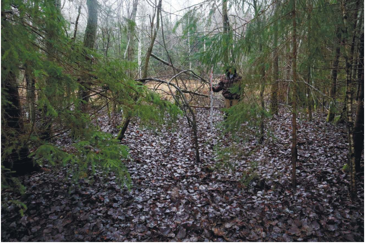
Рис. 458. Ленинградская область, Выборгский район. Строительство подъездной автомобильной дороги к «Приморскому универсально-перегрузочному комплексу» в Морском порту Приморск от автомобильной дороги федерального значения А-181 «Скандинавия». Шурф 88. Общий вид до начала работ. Вид с юга
