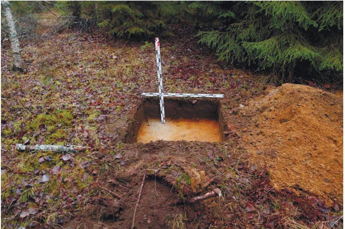
Рис. 455. Ленинградская область, Выборгский район. Строительство подъездной автомобильной дороги к «Приморскому универсально-перегрузочному комплексу» в Морском порту Приморск от автомобильной дороги федерального значения А-181 «Скандинавия». Шурф 87. Общий вид зачистки по материковому слою. Вид с юга
