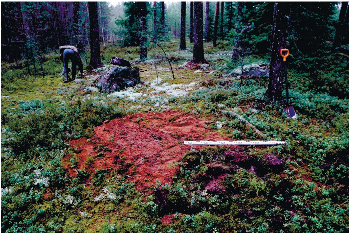
Рис. 86. Ленинградская область, Выборгский район. Строительство подъездной автомобильной дороги к «Приморскому универсально-перегрузочному комплексу» в Морском порту Приморск от автомобильной дороги федерального значения А-181 «Скандинавия». Шурф 14. Рекультивация. Вид с юга
