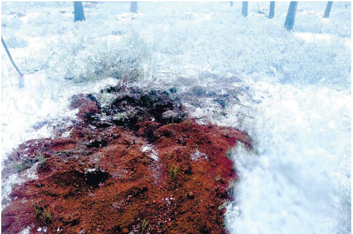
Рис. 194. Ленинградская область, Выборгский район. Строительство подъездной автомобильной дороги к «Приморскому универсально-перегрузочному комплексу» в Морском порту Приморск от автомобильной дороги федерального значения А-181 «Скандинавия». Шурф 40. Рекультивация. Вид с юга
