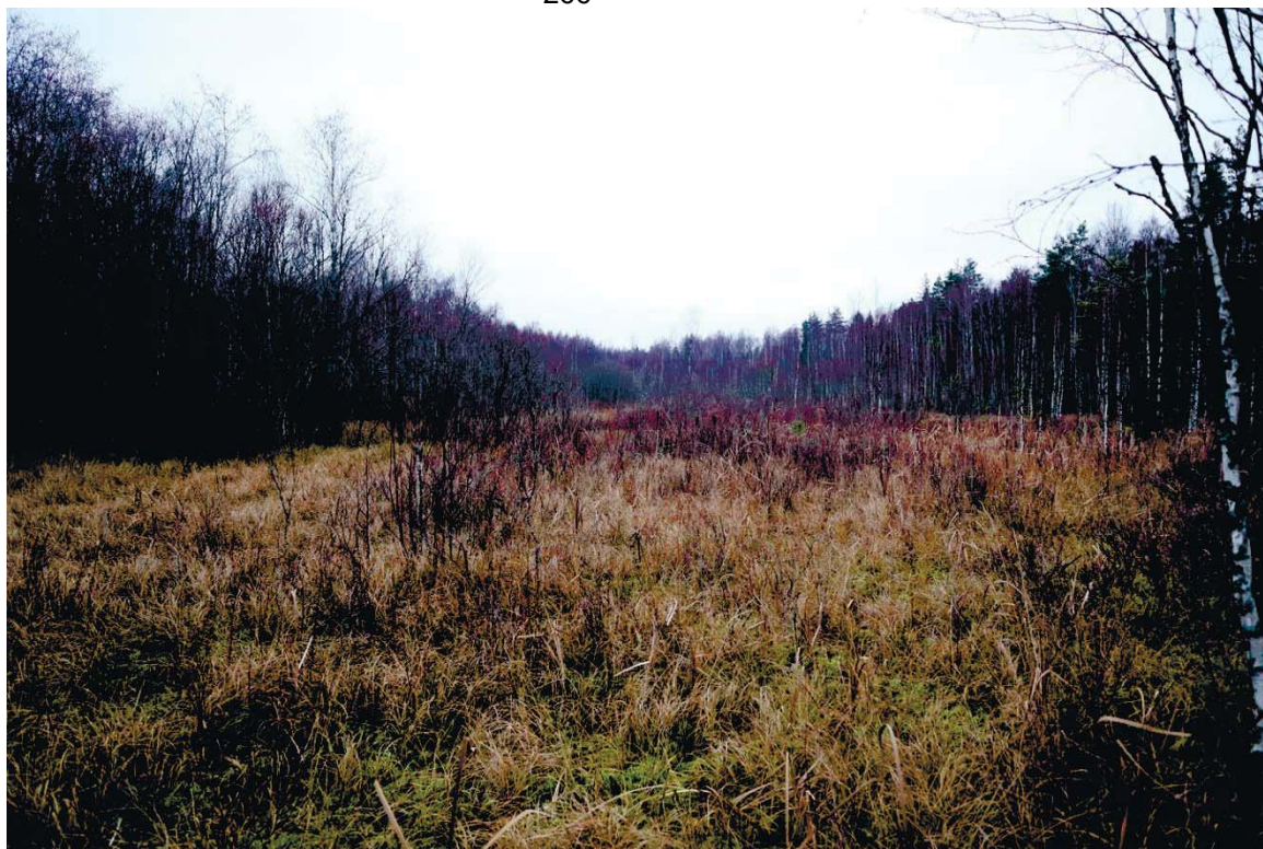
Рис. 61. Ленинградская область, Выборгский район. Строительство подъездной автомобильной дороги к «Приморскому универсально-перегрузочному комплексу» в Морском порту Приморск от автомобильной дороги федерального значения А-181 «Скандинавия». Прохождение трассы проектируемой артодороги через р. Ермиловка. Вид с северо-востока
