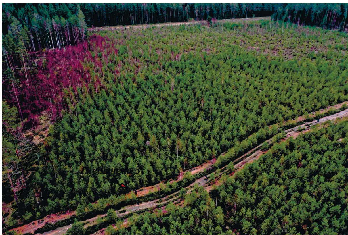
Рис. 203. Ленинградская область, Выборгский район. Строительство подъездной автомобильной дороги к «Приморскому универсально-перегрузочному комплексу» в Морском порту Приморск от автомобильной дороги федерального значения А-181 «Скандинавия». ОАН «Глебычево 3. Стоянка». Общий вид стоянки. Вид с юга
