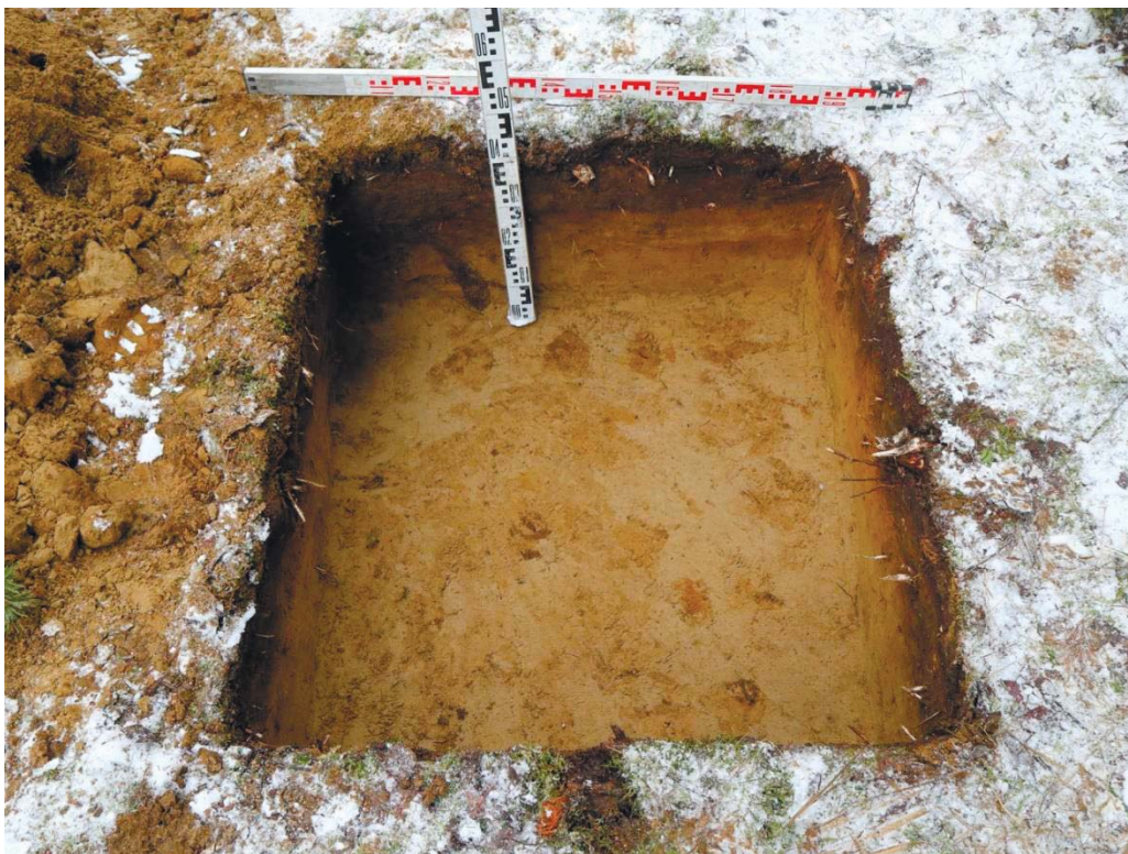
Рис. 523. Ленинградская область, Выборгский район. Строительство подъездной автомобильной дороги к «Приморскому универсально-перегрузочному комплексу» в Морском порту Приморск от автомобильной дороги федерального значения А-181 «Скандинавия». Шурф 101. Общий вид зачистки по материковому слою. Вид с юга
