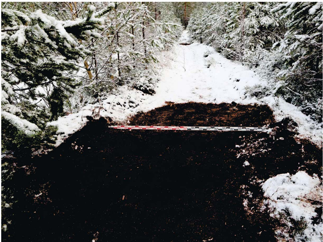
Рис. 285. Ленинградская область, Выборгский район. Строительство подъездной автомобильной дороги к «Приморскому универсально-перегрузочному комплексу» в Морском порту Приморск от автомобильной дороги федерального значения А-181 «Скандинавия». Шурф 58. Рекультивация. Вид с северо-запада
