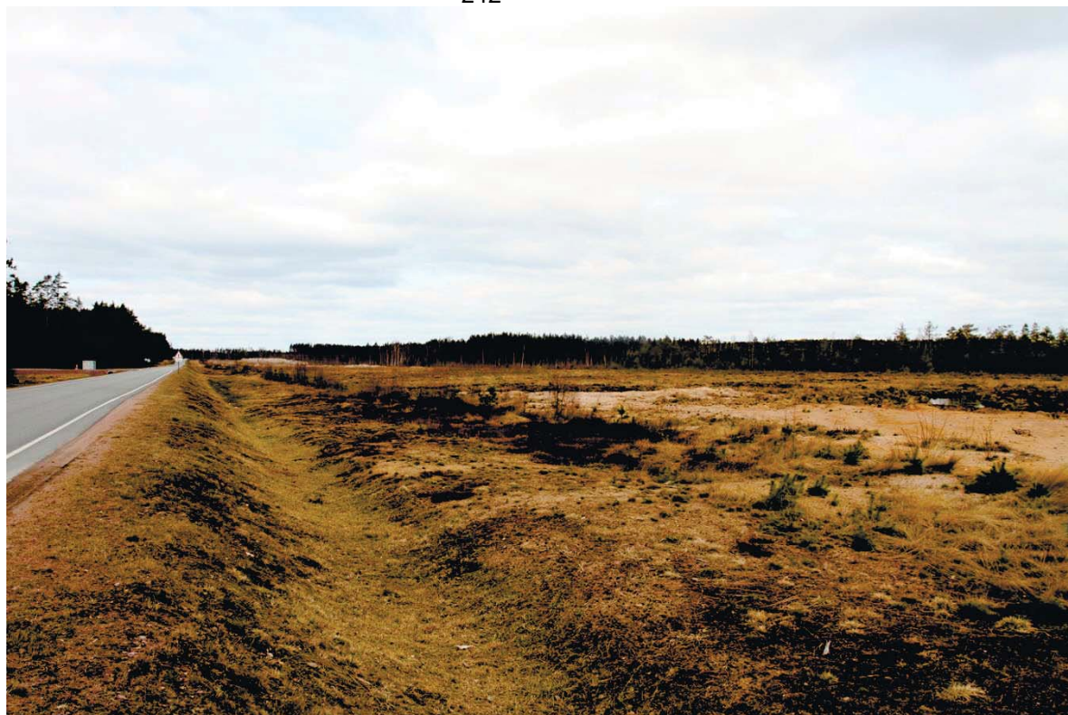
Рис. 13. Ленинградская область, Выборгский район. Строительство подъездной автомобильной дороги к «Приморскому универсально-перегрузочному комплексу» в Морском порту Приморск от автомобильной дороги федерального значения А-181 «Скандинавия». Общий вид трассы проектируемой автодороги в месте подхода к «Приморскому универсально-перегрузочному комплексу». Вид с Приморского шоссе с юго-запада
