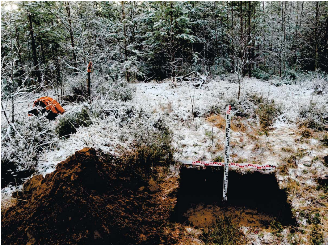
Рис. 247. Ленинградская область, Выборгский район. Строительство подъездной автомобильной дороги к «Приморскому универсально-перегрузочному комплексу» в Морском порту Приморск от автомобильной дороги федерального значения А-181 «Скандинавия». Шурф 51. Общий вид зачистки по материковому слою. Вид с юга
