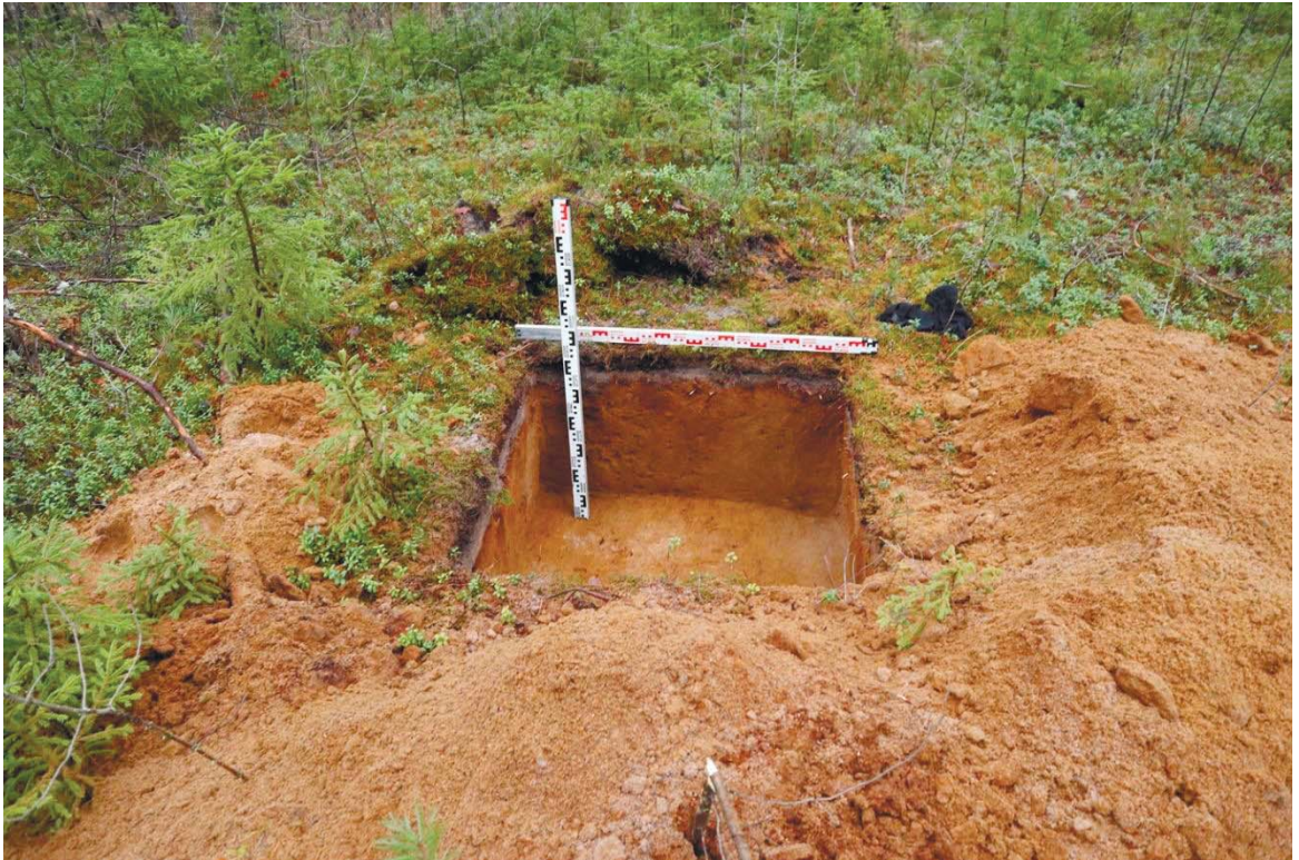
Рис. 312. Ленинградская область, Выборгский район. Строительство подъездной автомобильной дороги к «Приморскому универсально-перегрузочному комплексу» в Морском порту Приморск от автомобильной дороги федерального значения А-181 «Скандинавия». Шурф 63. Общий вид зачистки по материковому слою. Вид с юга
