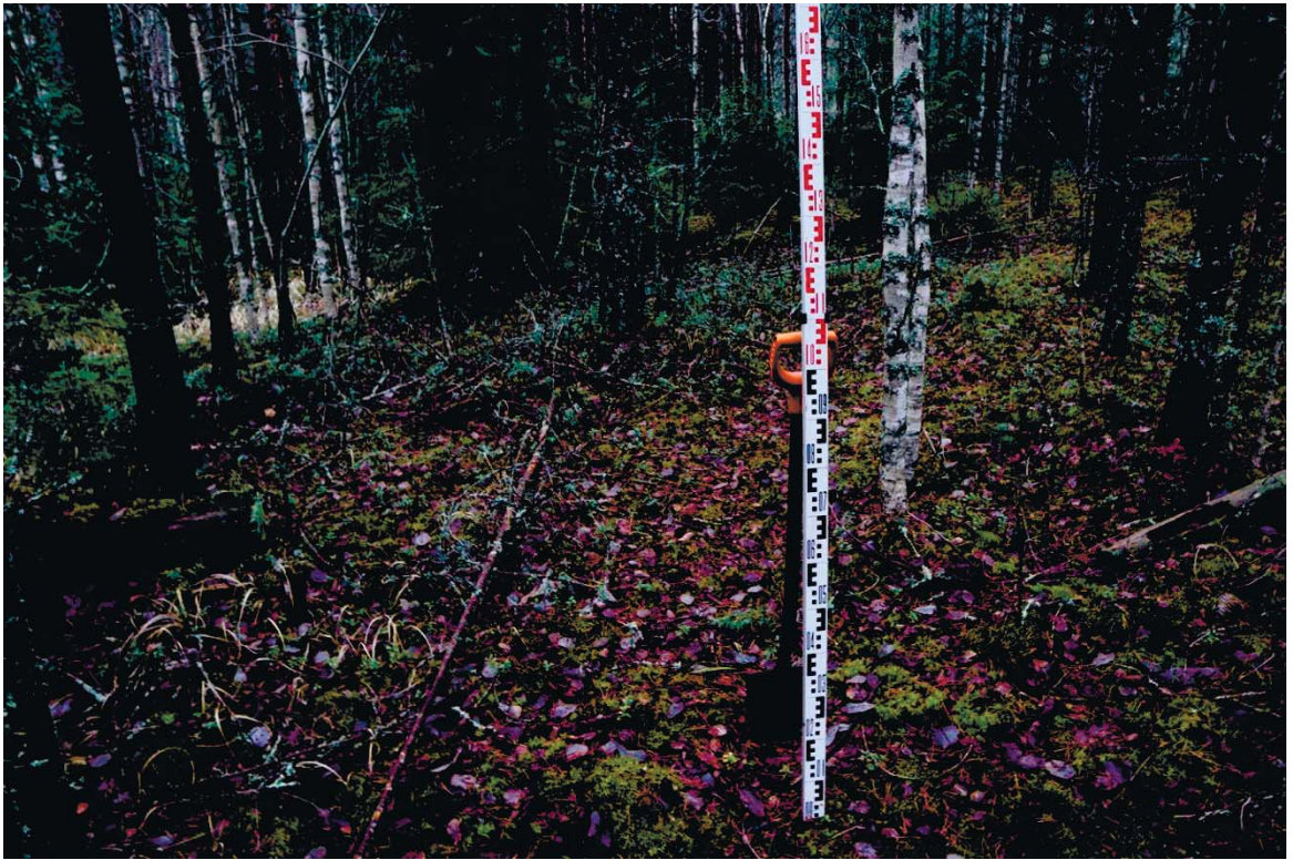
Рис. 91. Ленинградская область, Выборгский район. Строительство подъездной автомобильной дороги к «Приморскому универсально-перегрузочному комплексу» в Морском порту Приморск от автомобильной дороги федерального значения А-181 «Скандинавия». Шурф 16. Общий вид до начала работ. Вид с юга
