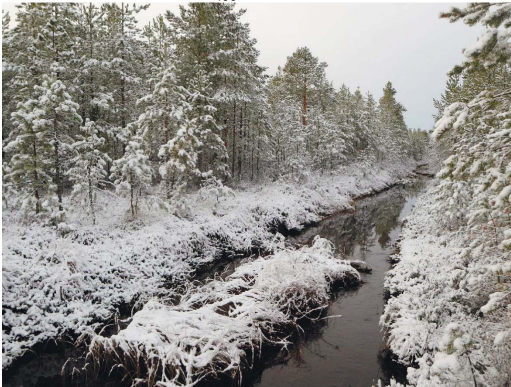
Рис. 504. Ленинградская область, Выборгский район. Строительство подъездной автомобильной дороги к «Приморскому универсально-перегрузочному комплексу» в Морском порту Приморск от автомобильной дороги федерального значения А-181 «Скандинавия». Пересечение трассой проектируемой автодороги р. Перовка. Вид с северо-запада
