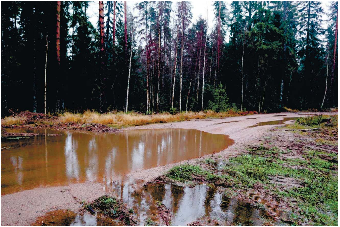
Рис. 35. Ленинградская область, Выборгский район. Строительство подъездной автомобильной дороги к «Приморскому универсально-перегрузочному комплексу» в Морском порту Приморск от автомобильной дороги федерального значения А-181 «Скандинавия». Прохождение трассы проектируемой автодороги к северу от Каменного ручья. Вид с юга
