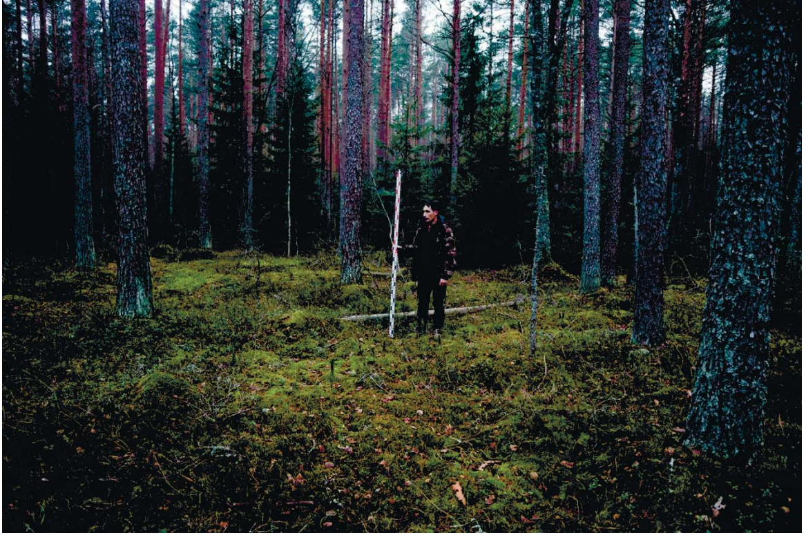
Рис. 71. Ленинградская область, Выборгский район. Строительство подъездной автомобильной дороги к «Приморскому универсально-перегрузочному комплексу» в Морском порту Приморск от автомобильной дороги федерального значения А-181 «Скандинавия». Шурф 11. Общий вид до начала работ. Вид с юга
