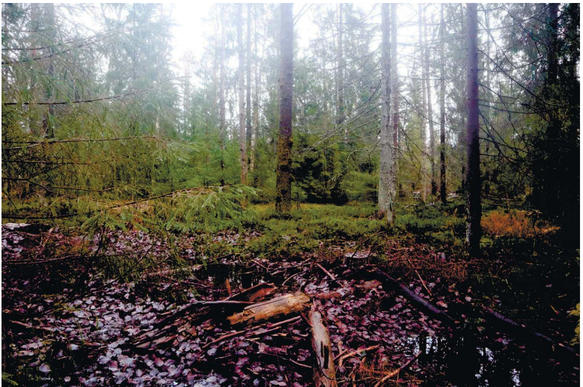
Рис. 18. Ленинградская область, Выборгский район. Строительство подъездной автомобильной дороги к «Приморскому универсально-перегрузочному комплексу» в Морском порту Приморск от автомобильной дороги федерального значения А-181 «Скандинавия». Прохождение трассы проектируемой автодороги в междуречье ручьев Каменный и Мельничный. Вид с севера
