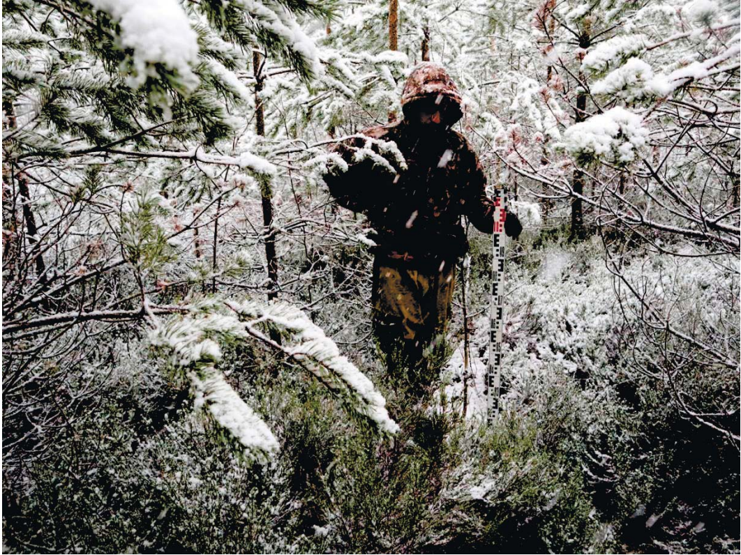
Рис. 226. Ленинградская область, Выборгский район. Строительство подъездной автомобильной дороги к «Приморскому универсально-перегрузочному комплексу» в Морском порту Приморск от автомобильной дороги федерального значения А-181 «Скандинавия». Шурф 46. Общий вид до начала работ. Вид с юга
