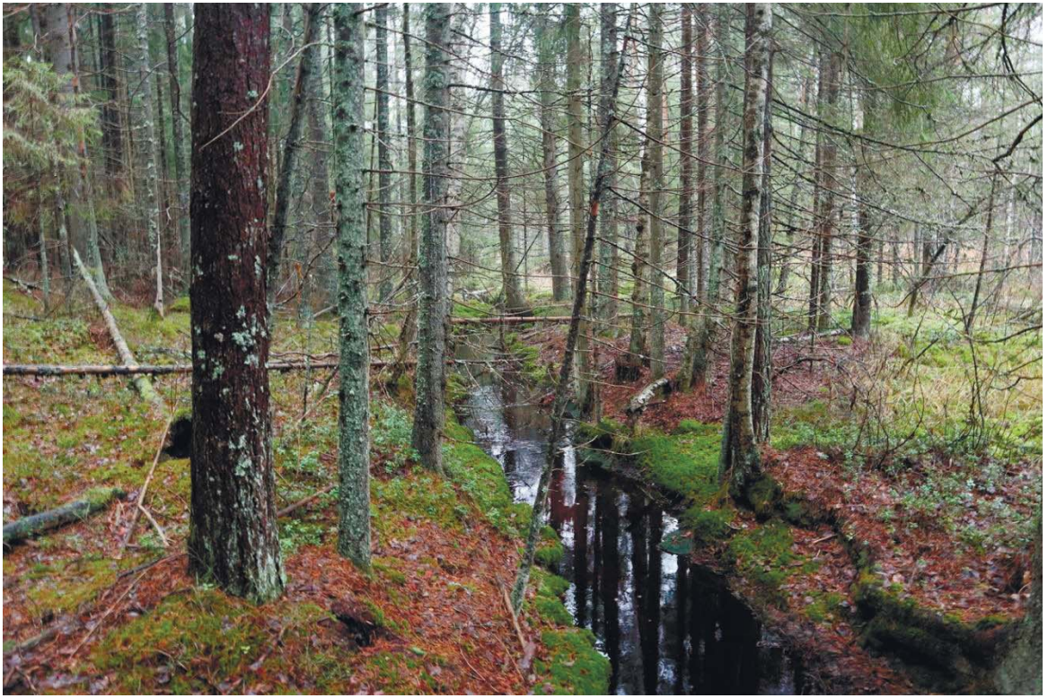
Рис. 309. Ленинградская область, Выборгский район. Строительство подъездной автомобильной дороги к «Приморскому универсально-перегрузочному комплексу» в Морском порту Приморск от автомобильной дороги федерального значения А-181 «Скандинавия». Прохождение трассы проектируемой автодороги через безымянный ручей, впадающий в оз. Мережное. Вид с юга
