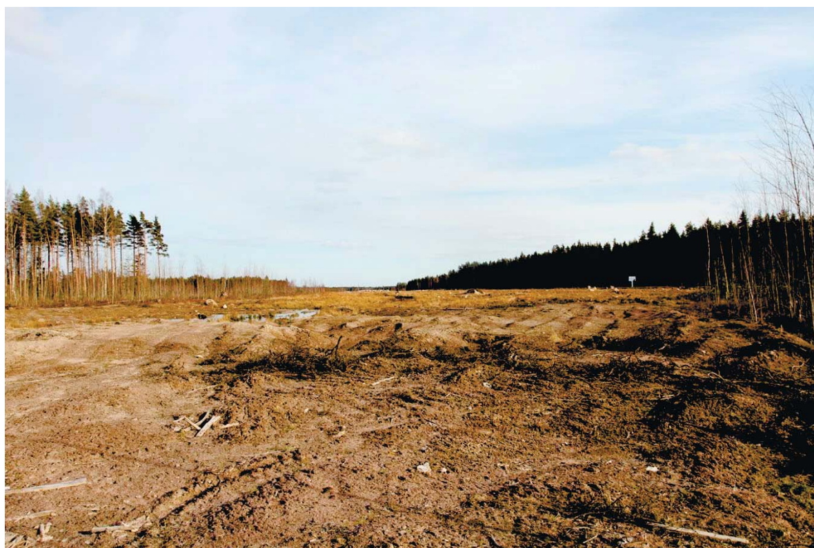
Рис. 12. Ленинградская область, Выборгский район. Строительство подъездной автомобильной дороги к «Приморскому универсально-перегрузочному комплексу» в Морском порту Приморск от автомобильной дороги федерального значения А-181 «Скандинавия». Общий вид трассы проектируемой автодороги в месте подхода к «Приморскому универсально-перегрузочному комплексу». Вид с юго-востока
