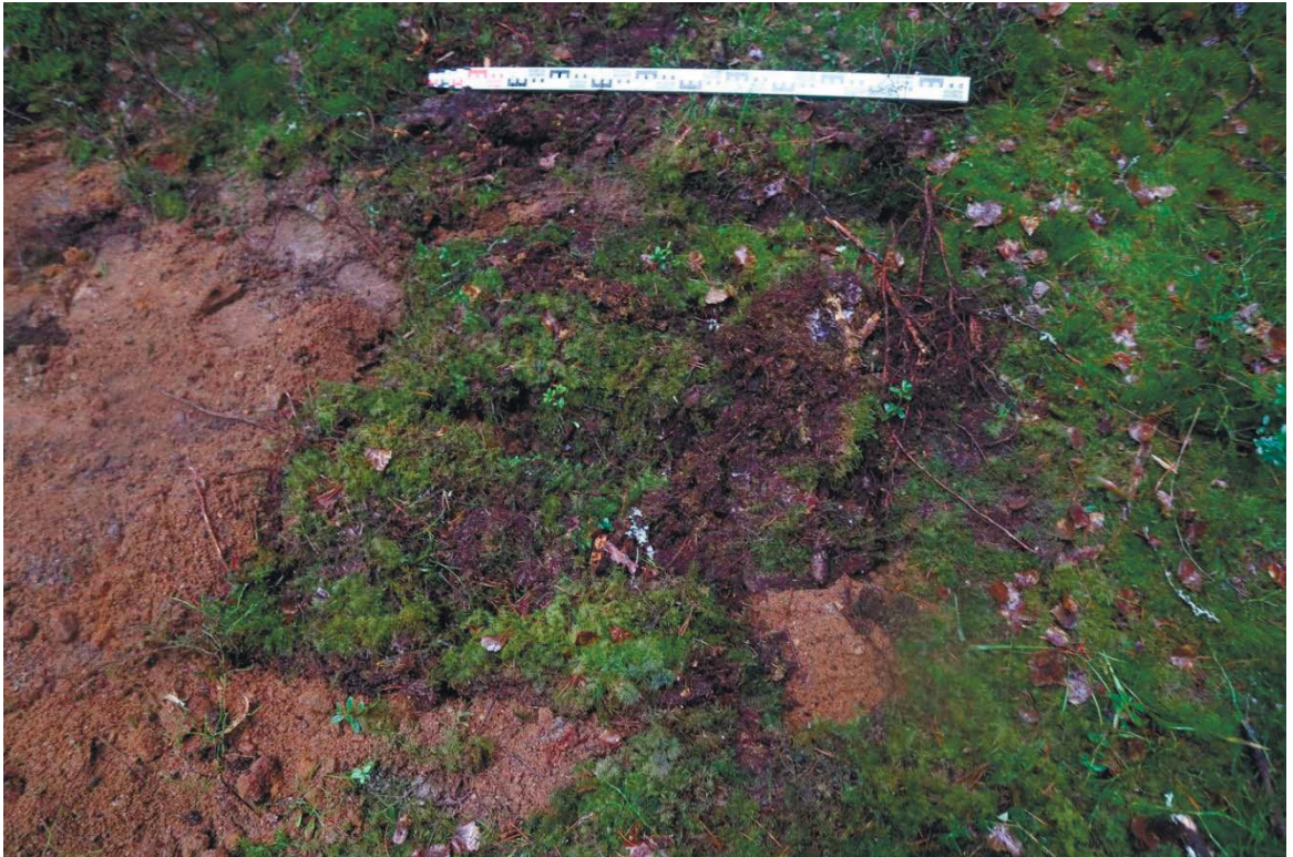
Рис. 424. Ленинградская область, Выборгский район. Строительство подъездной автомобильной дороги к «Приморскому универсально-перегрузочному комплексу» в Морском порту Приморск от автомобильной дороги федерального значения А-181 «Скандинавия». ОАН «Стоянка Черничное 2». Шурф 80. Рекультивация. Вид с юга
