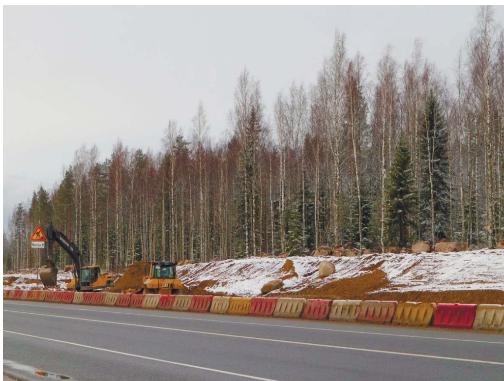
Рис. 531. Ленинградская область, Выборгский район. Строительство подъездной автомобильной дороги к «Приморскому универсально-перегрузочному комплексу» в Морском порту Приморск от автомобильной дороги федерального значения А-181 «Скандинавия». Присоединение трассы проектируемой автодороги к автодороге А-181 «Скандинавия». Вид с юга
