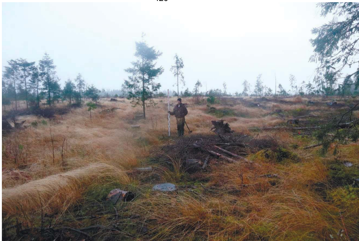
Рис. 359. Ленинградская область, Выборгский район. Строительство подъездной автомобильной дороги к «Приморскому универсально-перегрузочному комплексу» в Морском порту Приморск от автомобильной дороги федерального значения А-181 «Скандинавия». Прохождение трассы проектируемой автодороги через вырубку к северо-западу от г. Курганная. Вид с юга
