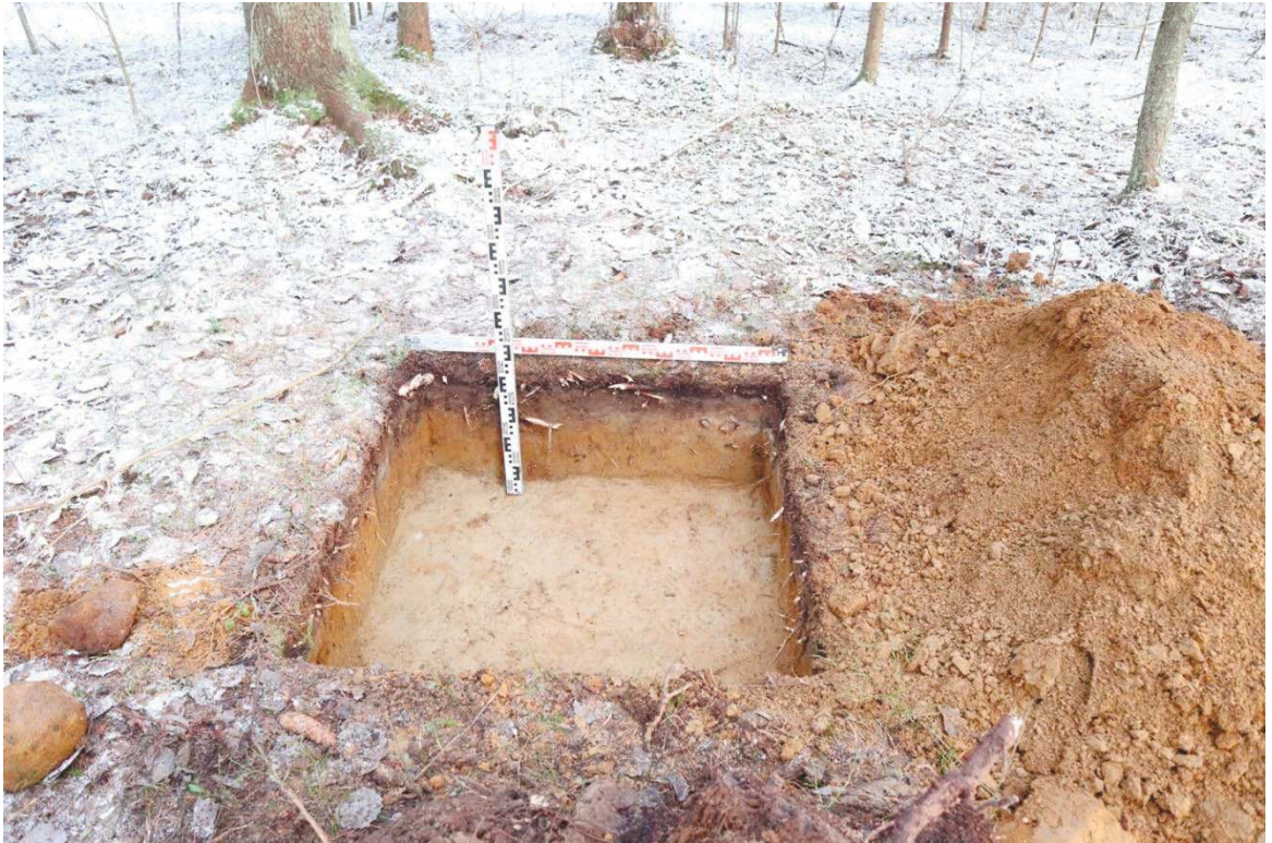
Рис. 501. Ленинградская область, Выборгский район. Строительство подъездной автомобильной дороги к «Приморскому универсально-перегрузочному комплексу» в Морском порту Приморск от автомобильной дороги федерального значения А-181 «Скандинавия». Шурф 96. Общий вид зачистки по материковому слою. Вид с юга
