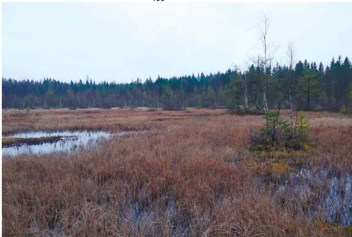
Рис. 337. Ленинградская область, Выборгский район. Строительство подъездной автомобильной дороги к «Приморскому универсально-перегрузочному комплексу» в Морском порту Приморск от автомобильной дороги федерального значения А-181 «Скандинавия». Прохождение трассы проектируемой автодороги через заболоченную низину к югу от автодороги 41К-094 на участке Малышево - Глебычево. Вид с севера
