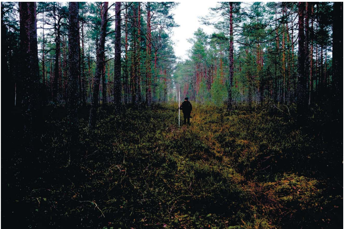
Рис. 64. Ленинградская область, Выборгский район. Строительство подъездной автомобильной дороги к «Приморскому универсально-перегрузочному комплексу» в Морском порту Приморск от автомобильной дороги федерального значения А-181 «Скандинавия». Прохождение трассы проектируемой артодороги по заболоченной низине к северо-востоку от р. Ермиловка. Вид с юго-запада
