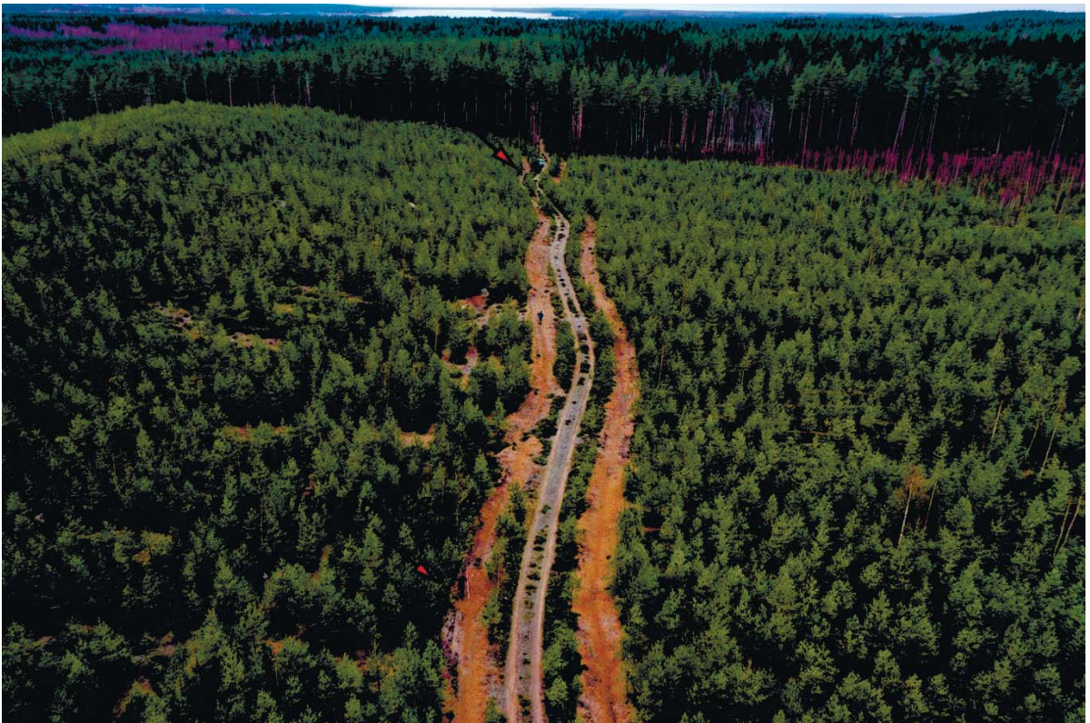
Рис. 267. Ленинградская область, Выборгский район. Строительство подъездной автомобильной дороги к «Приморскому универсально-перегрузочному комплексу» в Морском порту Приморск от автомобильной дороги федерального значения А-181 «Скандинавия». ОАН «Глебычево 4. Стоянка». Общий вид стоянки. Вид с юго-востока
