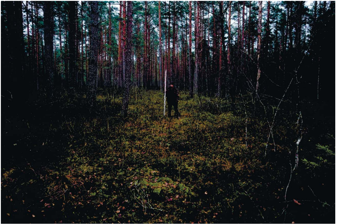
Рис. 63. Ленинградская область, Выборгский район. Строительство подъездной автомобильной дороги к «Приморскому универсально-перегрузочному комплексу» в Морском порту Приморск от автомобильной дороги федерального значения А-181 «Скандинавия». Прохождение трассы проектируемой артодороги по заболоченной низине к северо-востоку от р. Ермиловка. Вид с юго-запада
