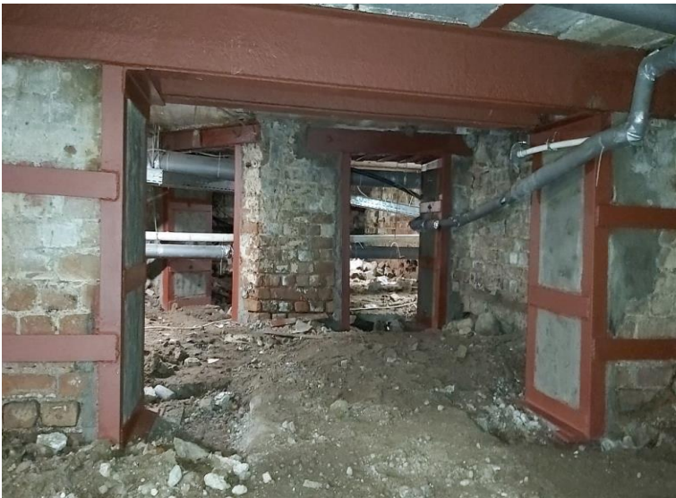
17. «Дом Петинена,1908 г.», Ленинградская область, Выборгский район, г. Выборг, Ленинградский пр., д. 31. Подвал. Общий вид. Фото 05.03.2021 г.
