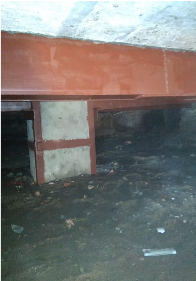
27. «Дом Петинена,1908 г.», Ленинградская область, Выборгский район, г. Выборг, Ленинградский пр., д. 31. Подвал. Фрагмент. Фото 05.03.2021 г.
