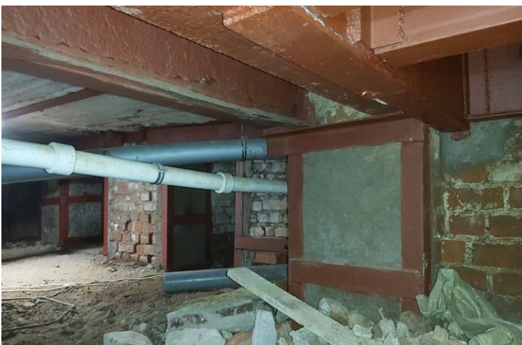
19. «Дом Петинена,1908 г.», Ленинградская область, Выборгский район, г. Выборг, Ленинградский пр., д. 31. Подвал. Общий вид. Фото 05.03.2021 г.
