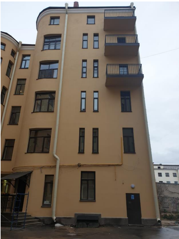
8. «Дом Петинена,1908 г.», Ленинградская область, Выборгский район, г. Выборг, Ленинградский пр., д. 31. Дворовый фасад. Общий вид. Фото 05.03.2021 г.
