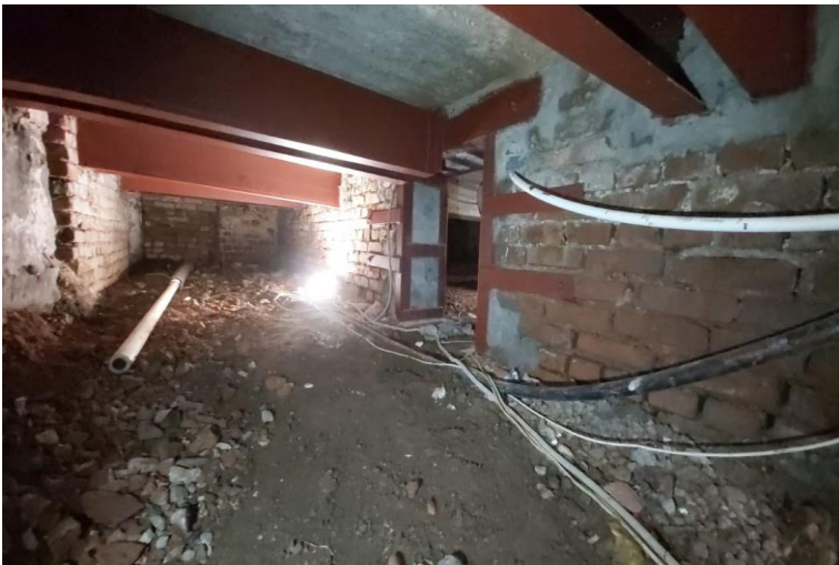
20. «Дом Петинена,1908 г.», Ленинградская область, Выборгский район, г. Выборг, Ленинградский пр., д. 31. Подвал. Фрагмент. Фото 05.03.2021 г.
