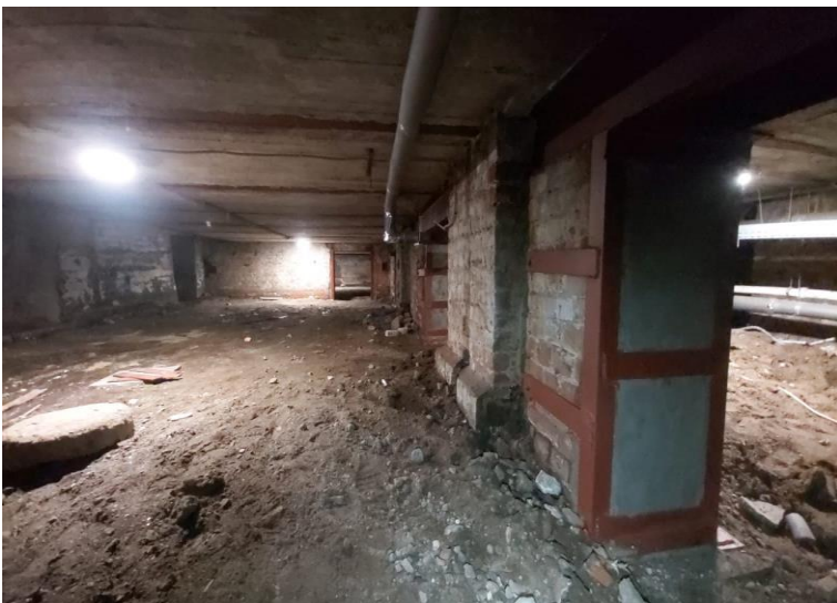
18. «Дом Петинена,1908 г.», Ленинградская область, Выборгский район, г. Выборг, Ленинградский пр., д. 31. Подвал. Общий вид. Фото 05.03.2021 г.
