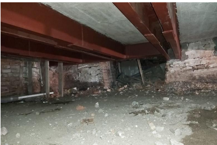
21. «Дом Петинена,1908 г.», Ленинградская область, Выборгский район, г. Выборг, Ленинградский пр., д. 31. Подвал. Фрагмент. Фото 05.03.2021 г.
