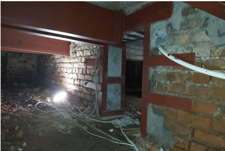
23. «Дом Петинена,1908 г.», Ленинградская область, Выборгский район, г. Выборг, Ленинградский пр., д. 31. Подвал. Фрагмент. Фото 05.03.2021 г.
