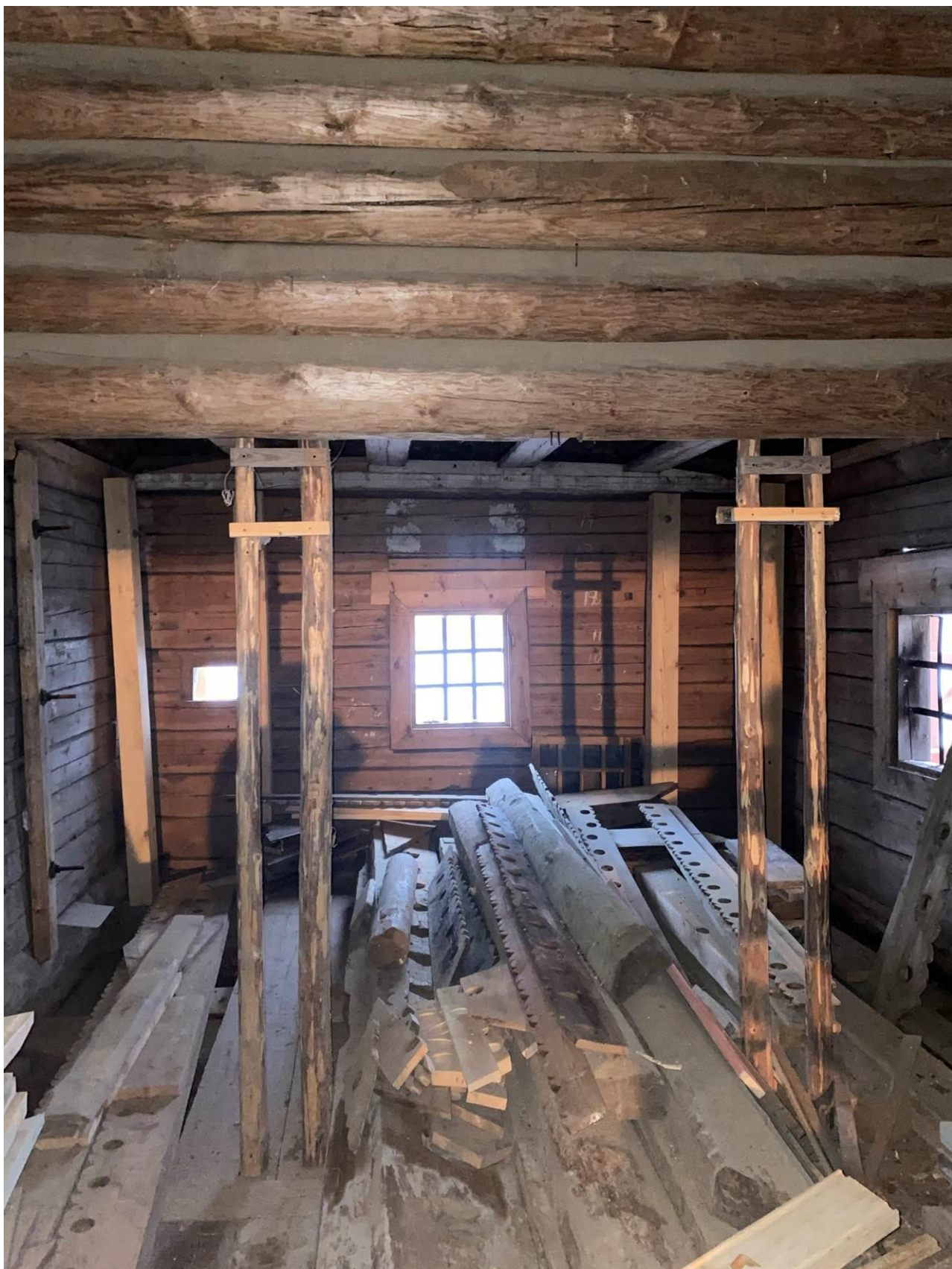
7. Никольская церковь (деревянная). Интерьер в процессе реставрации. Давыдова Н.А. 15.12.2020.
