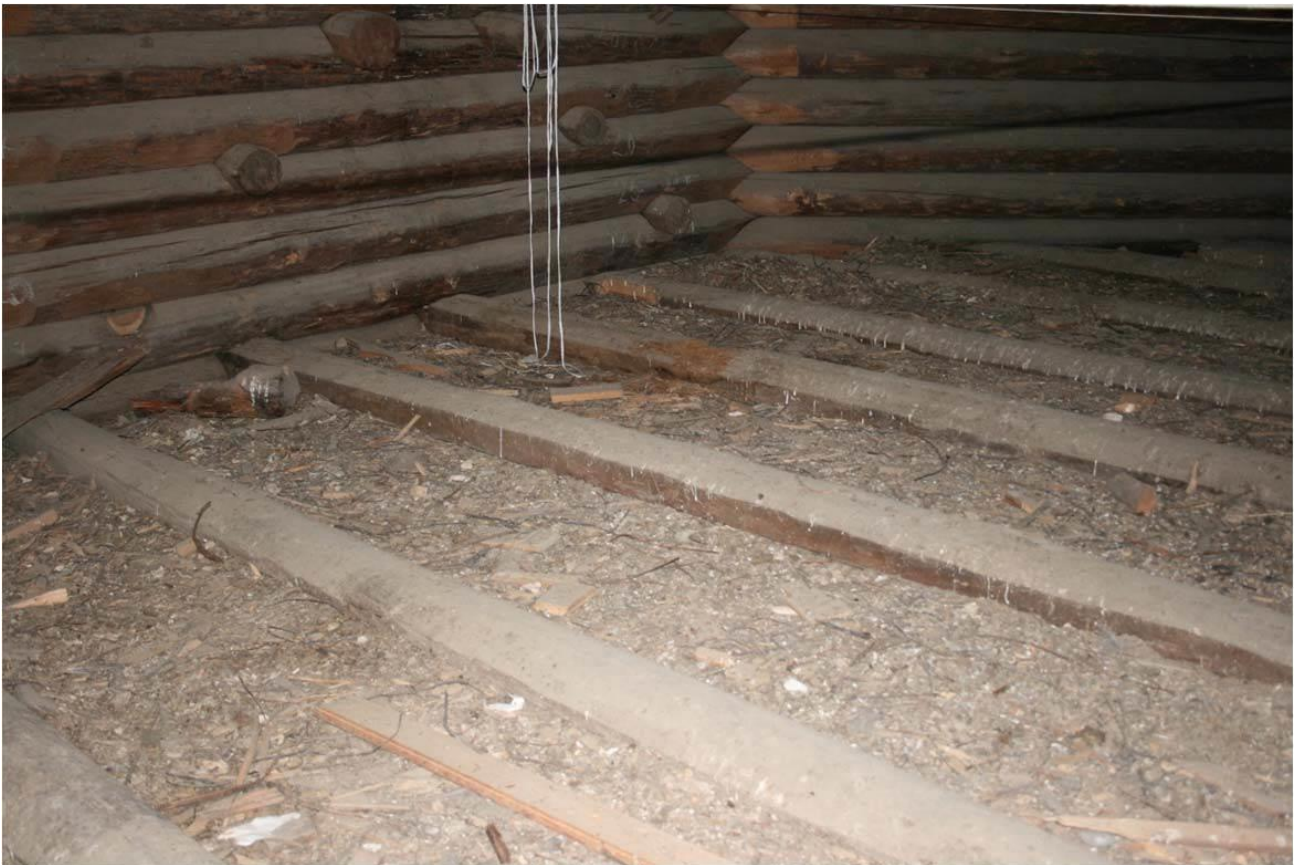
20. Никольская церковь (деревянная). Балки перекрытия восьмерика церкви. Давыдова Н.А. 30.08.2018.
