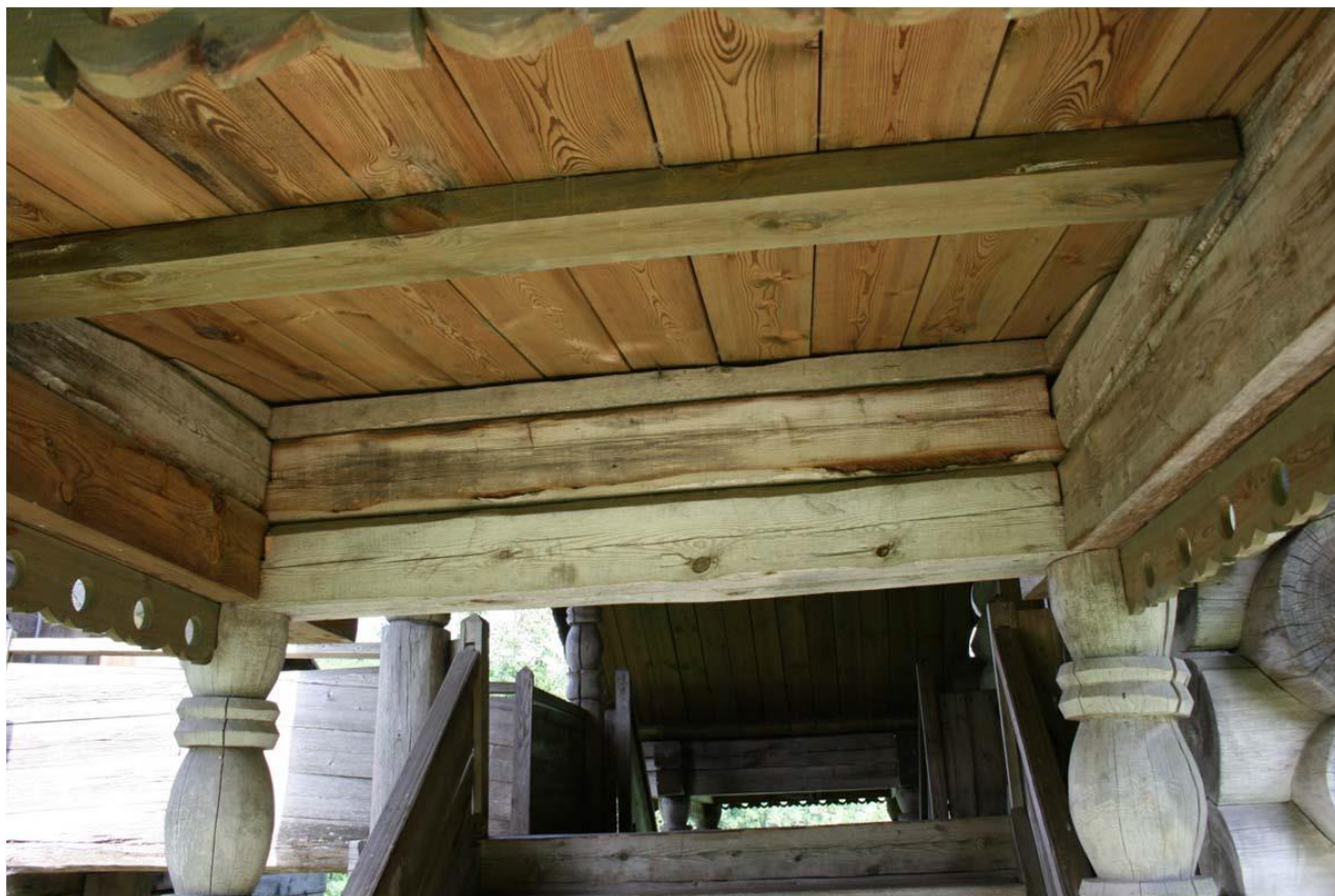
8. Никольская церковь (деревянная). Конструкции кровли крыльца. Давыдова Н.А. 30.08.2018.
