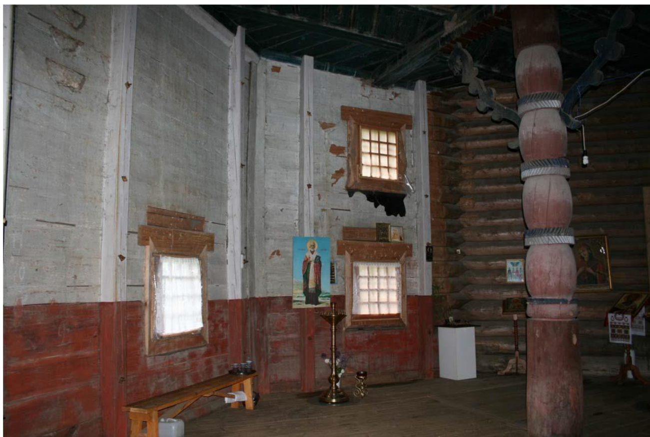
18. Никольская церковь (деревянная). Внутренняя сторона бревен стен восьмерика. Давыдова Н.А. 30.08.2018.
