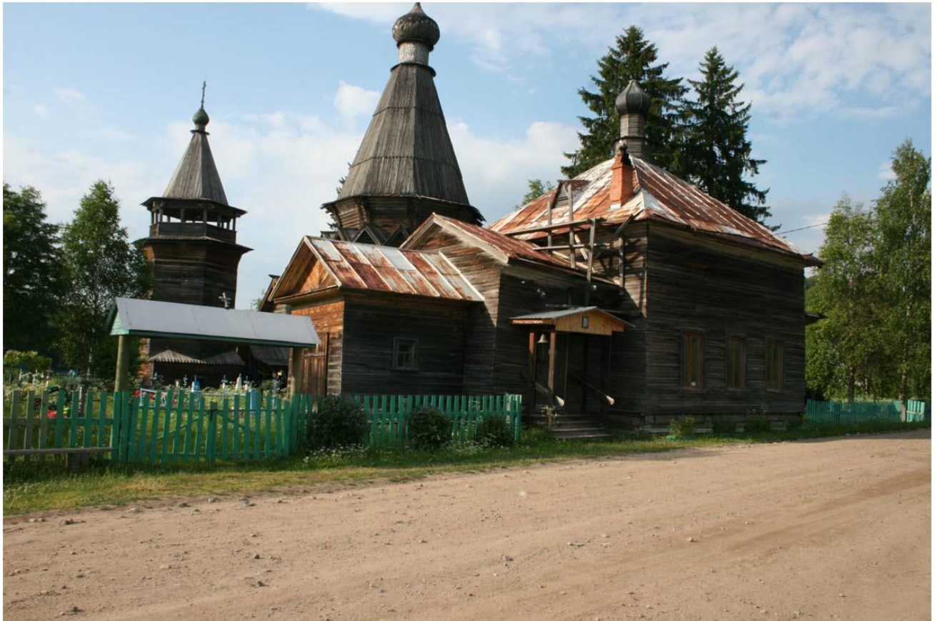
Илл. 25. Современное состояние церкви святого пророка Илии.
