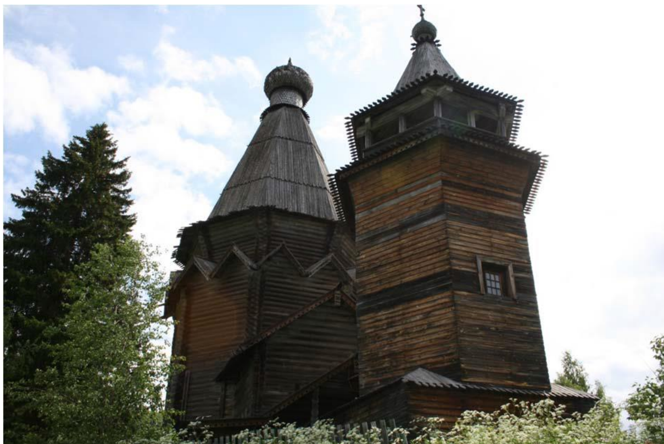
5. Никольская церковь (деревянная). Вид на северо-восточную часть. Давыдова Н.А. 30.08.2018.
