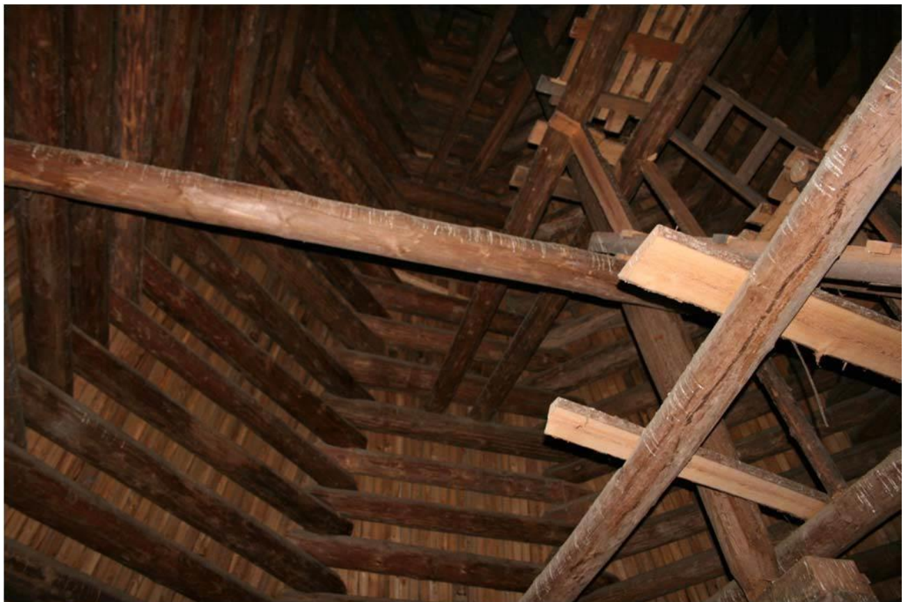
22. Никольская церковь (деревянная). Конструкции шатра церкви. Давыдова Н.А. 30.08.2018.
