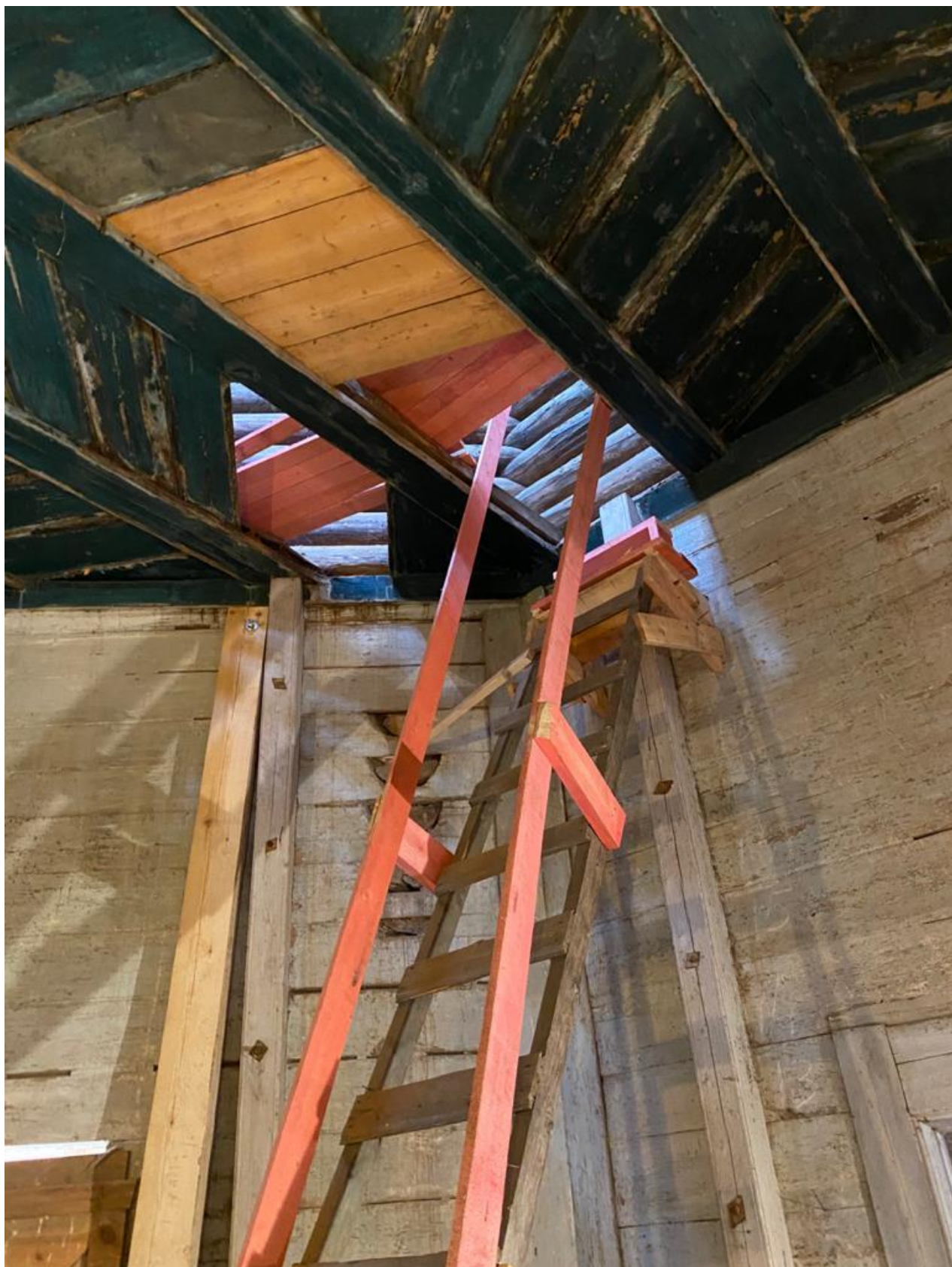
9. Никольская церковь (деревянная). Интерьер в процессе реставрации. Давыдова Н.А. 15.12.2020.
