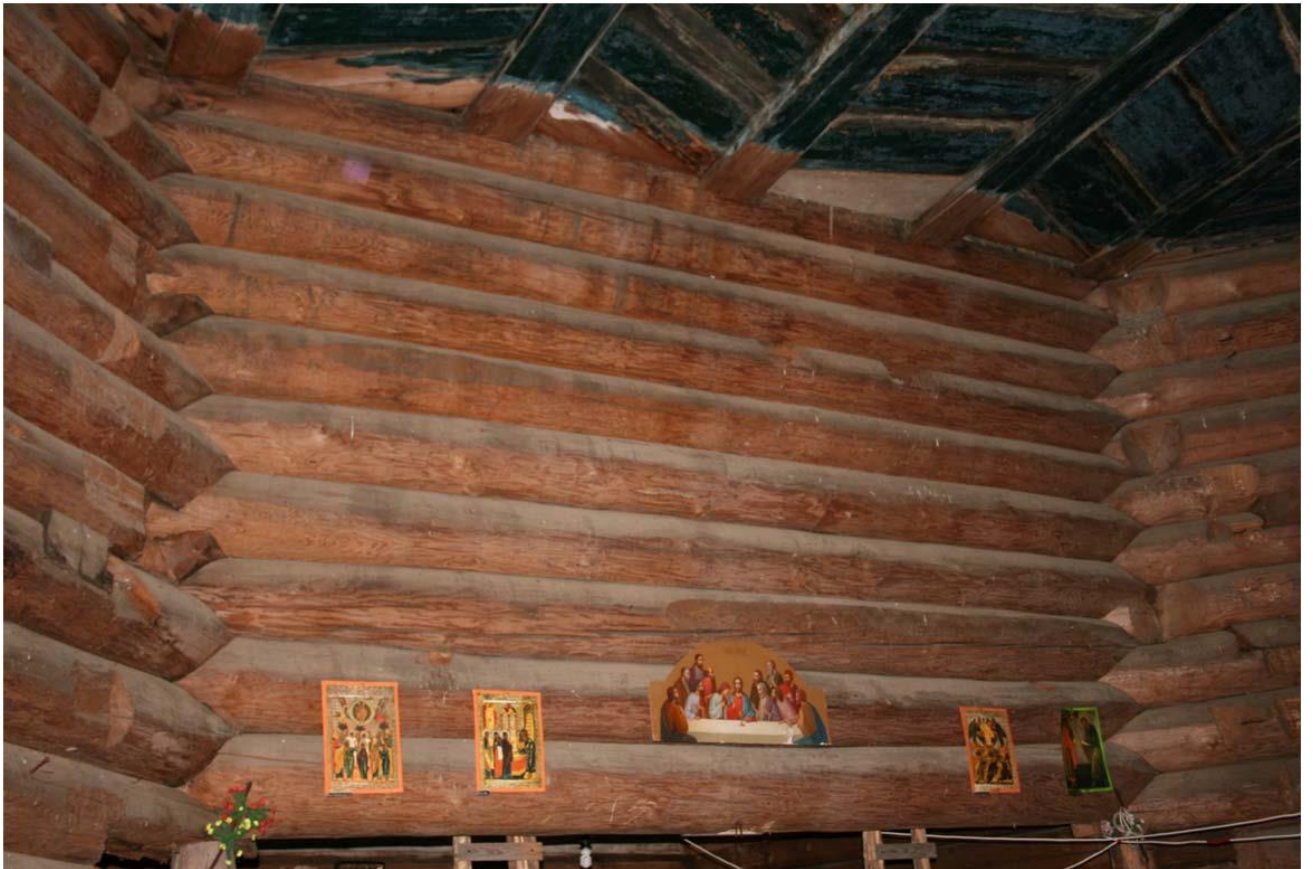
19. Никольская церковь (деревянная). Внутренне стороны бревен стен. Давыдова Н.А. 30.08.2018.
