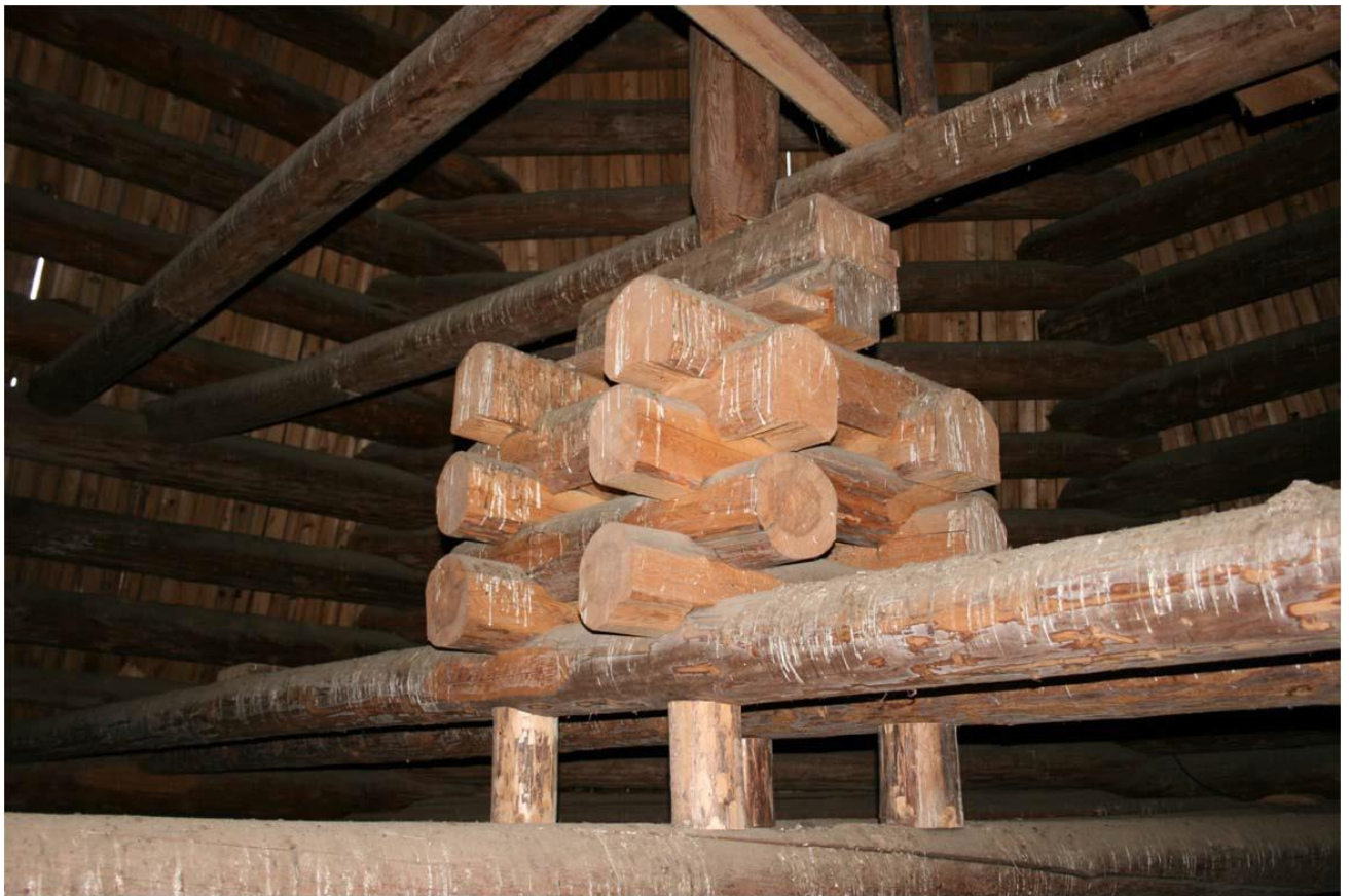
21. Никольская церковь (деревянная). Конструкция нижней части шатра. Давыдова Н.А. 30.08.2018.
