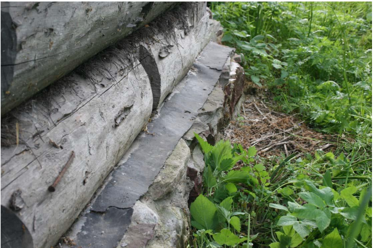
36. Церковь Святого пророка Илии. Ленточный фундамент из валунов, колотого и пиленого гранита. Давыдова Н.А. 30.08.2018.
