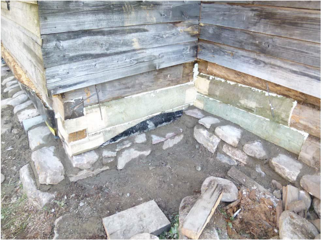
Илл. 31. Процесс ремонтных работ церкви святого пророка Илии. 2010-е г. Устройство цоколя по периметру церкви из гранитных колотых блоков и булыжников на цементном растворе.
