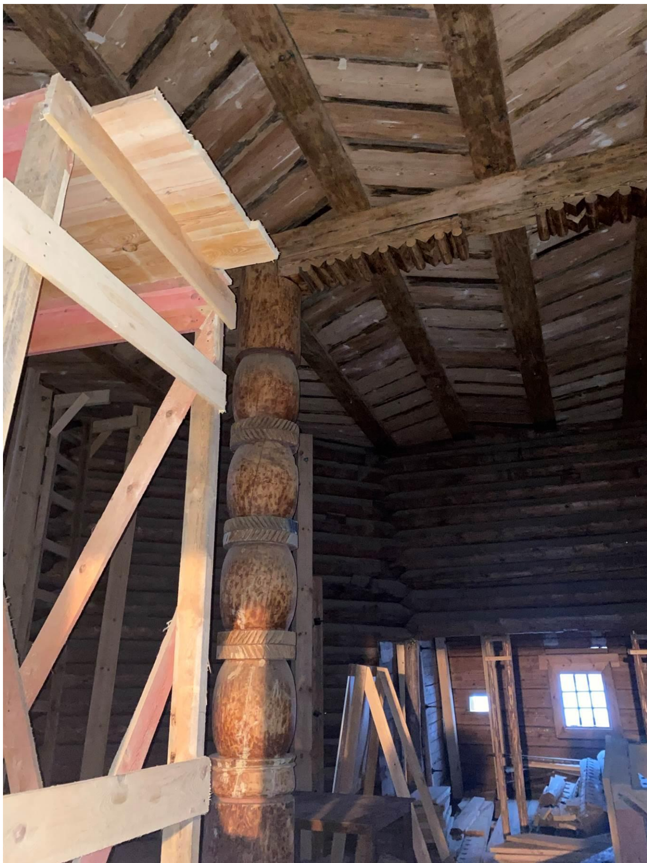
6. Никольская церковь (деревянная). Интерьер в процессе реставрации. Давыдова Н.А. 15.12.2020.
