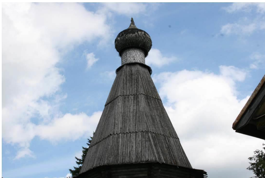
13. Никольская церковь (деревянная). Тесовое покрытие шатра, лемеха барабана и маковки. Давыдова Н.А. 30.08.2018.
