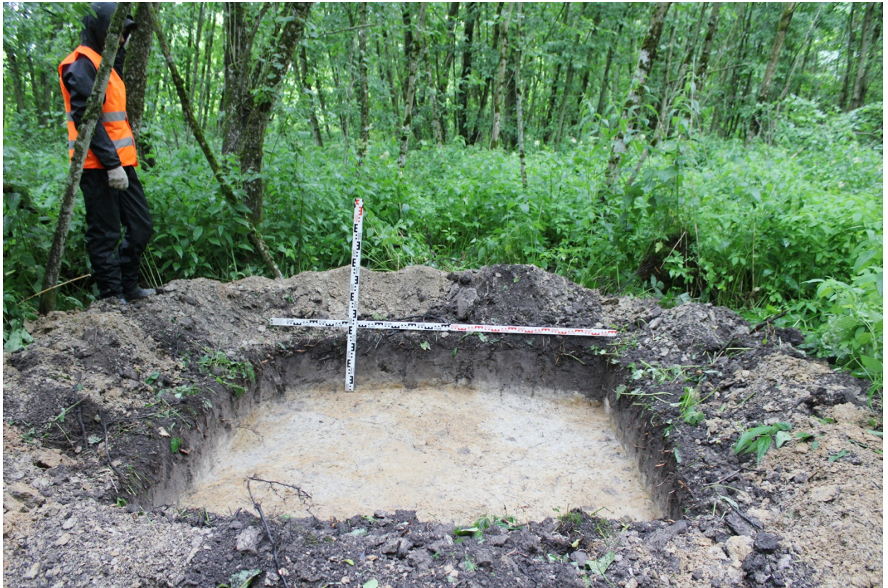
Рисунок 80. Волховский район Ленинградской области, ст. Мурманские Ворота. Шурф 8. Общий вид. Вид на север
