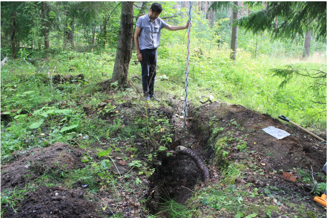
Илл. 34. Ленинградская область. Лужский муниципальный район. г. Луга. Участок с кадастровым номером 47:29:0103018:316. Зачистка №1. Месторасположение. Вид с северо-запада.
