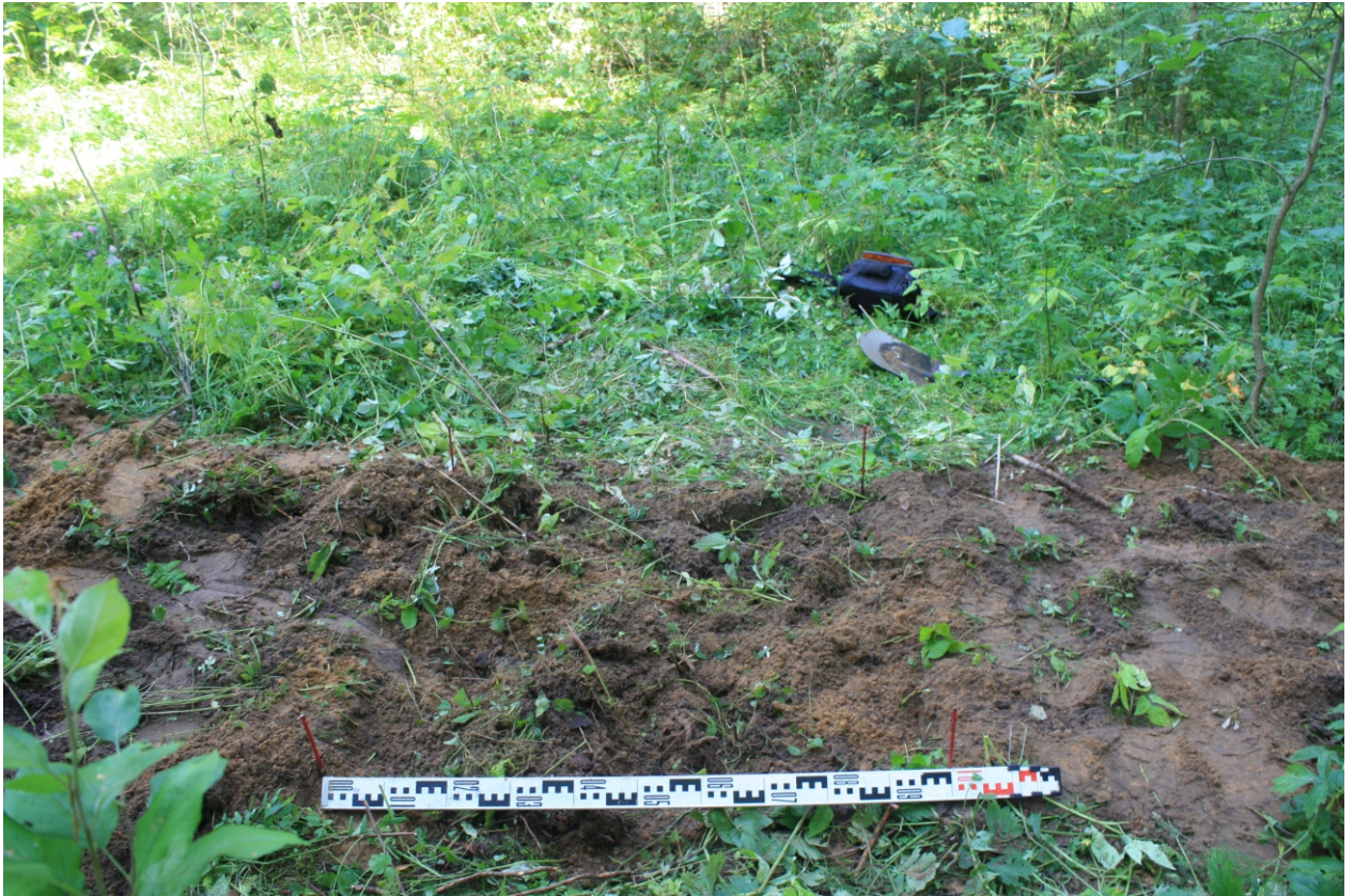
Илл. 67. Ленинградская область. Лужский муниципальный район. г. Луга. Участок с кадастровым номером 47:29:0103018:316. Шурф №3. Рекультивация. Вид с юга.
