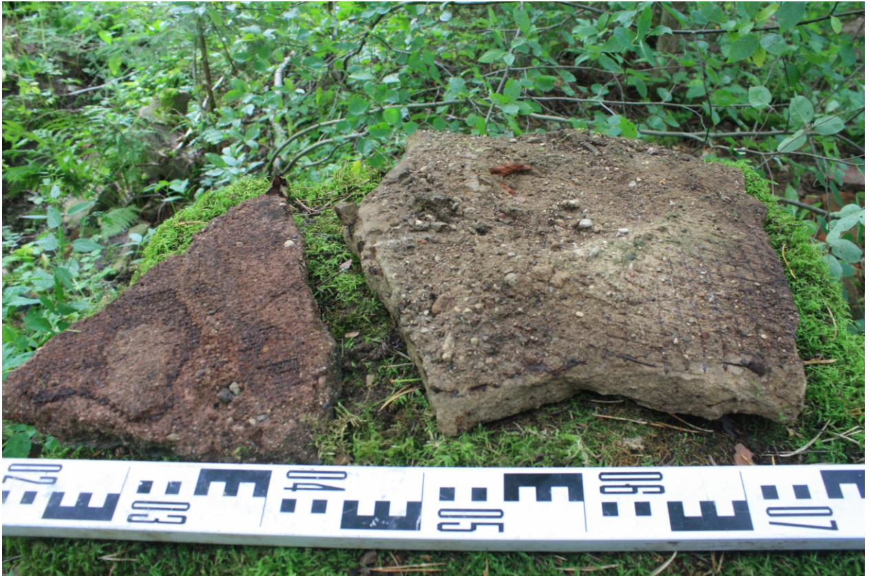
Илл. 19. Ленинградская область. Лужский муниципальный район. г. Луга. Участок с кадастровым номером 47:29:0103018:316. Подъемный материал из постройки в центральной части. Фрагменты штукатурки на армирующей металлической сетке.
