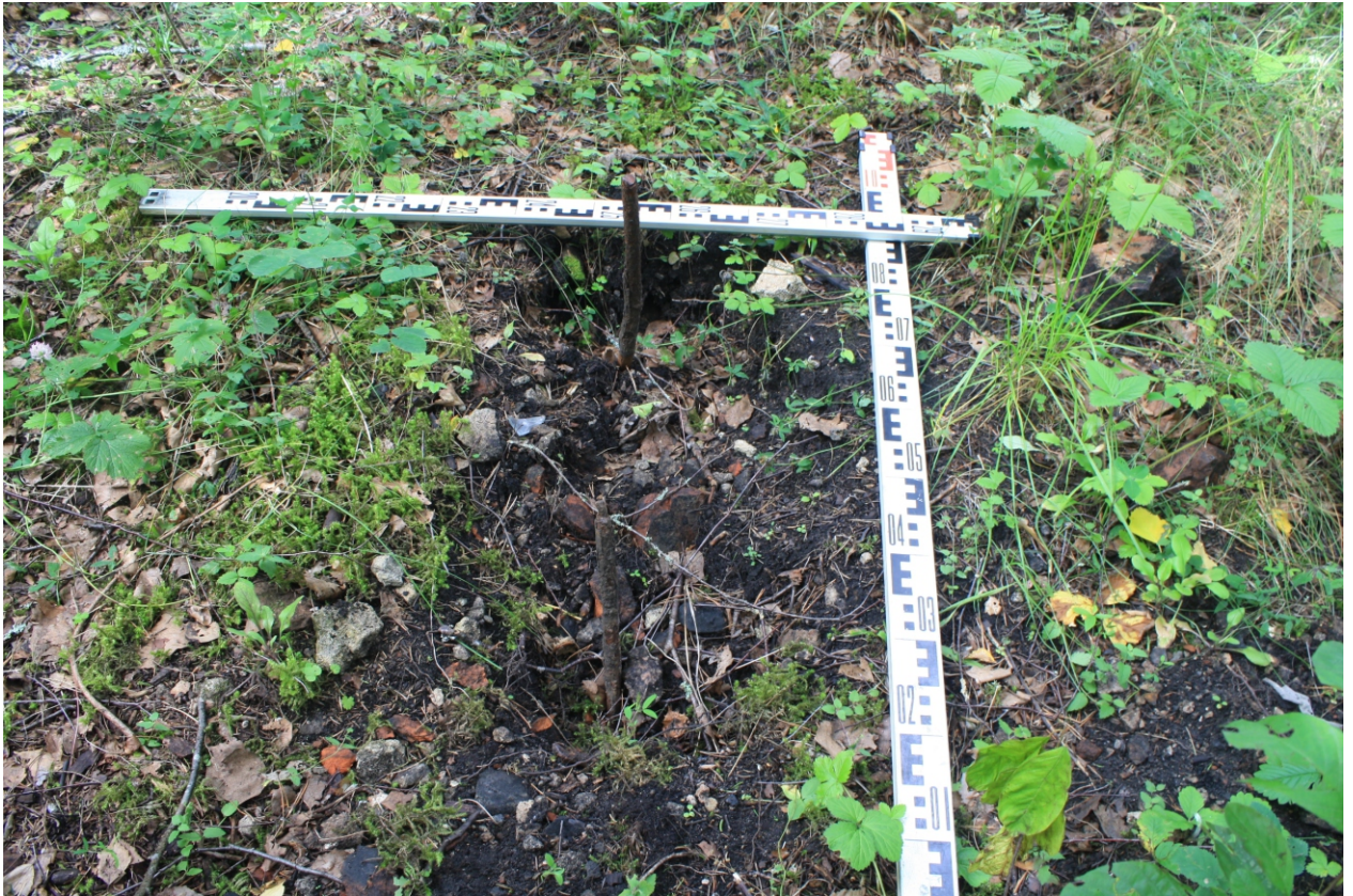
Илл. 33. Ленинградская область. Лужский муниципальный район. г. Луга. Участок с кадастровым номером 47:29:0103018:316. Точка фото-фиксации №14. Разрытие в навале строительного мусора, арматура. Вид с северо-запада.
