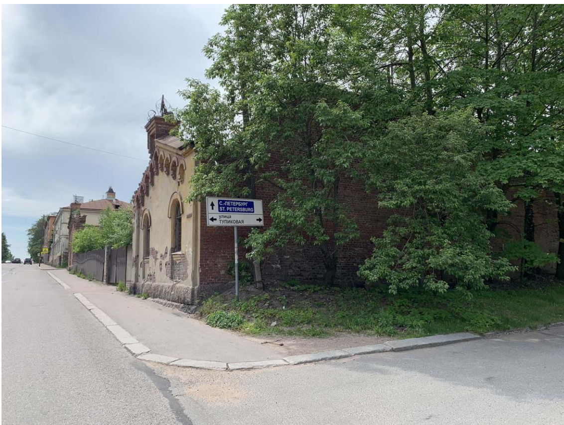
Фото 5. Второй производственный корпус бывшего Стеаринового завода по ул. Кривоносова, 20. Фото с востока (22 июня 2020 г.).
