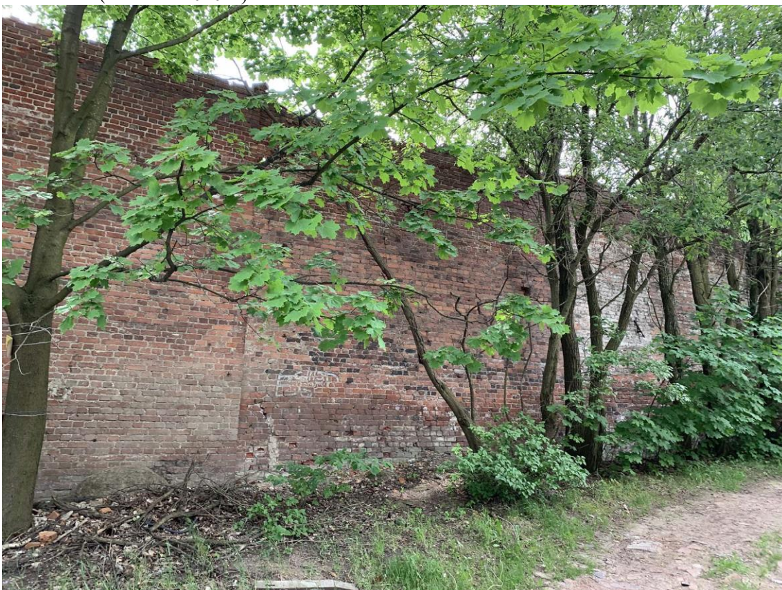
Фото 6. Надстроенная и перестроенная в послевоенное время северо-восточная стена второго производственного корпуса бывшего Стеаринового завода. Фото с севера (22 июня 2020 г.).
