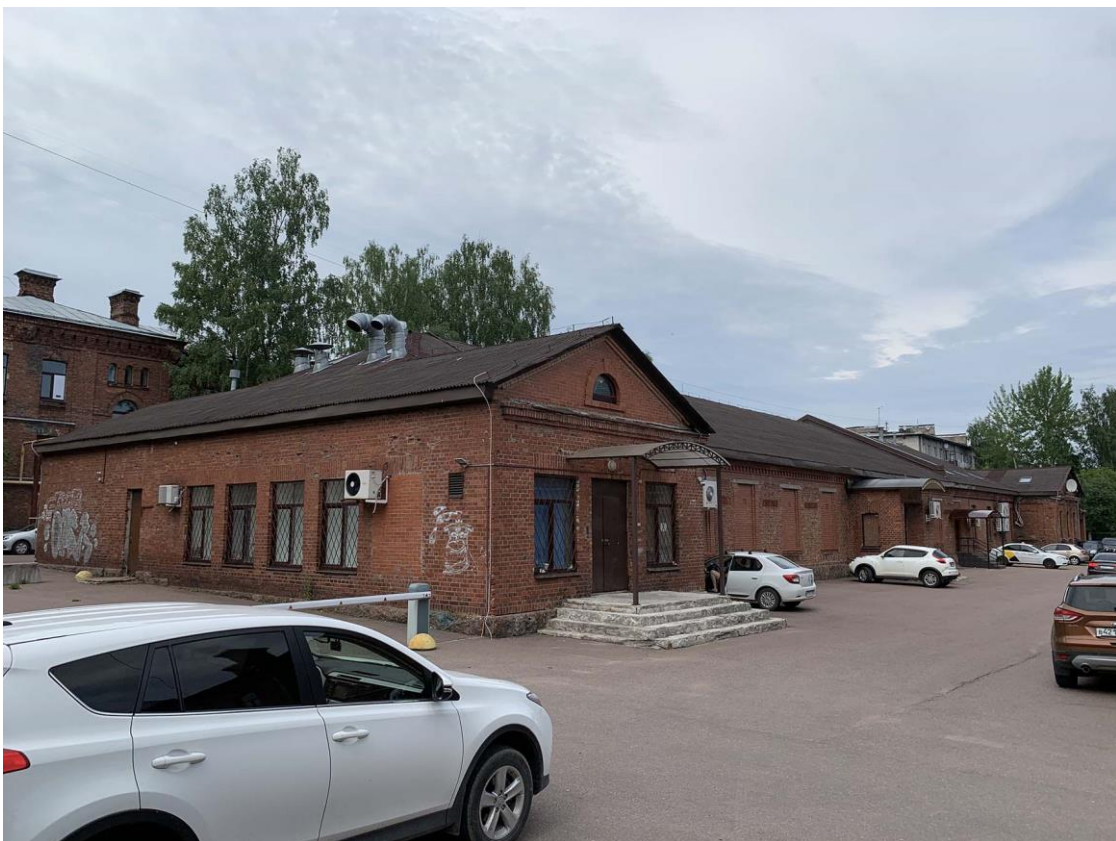
Фото 18. Общий вид кухни со столовой по ул. Кривоносова, 13, корп. 2, элемента «Комплекса казарм Финляндского стрелкового полка». Фото с юга (22 июня 2020 г.).
