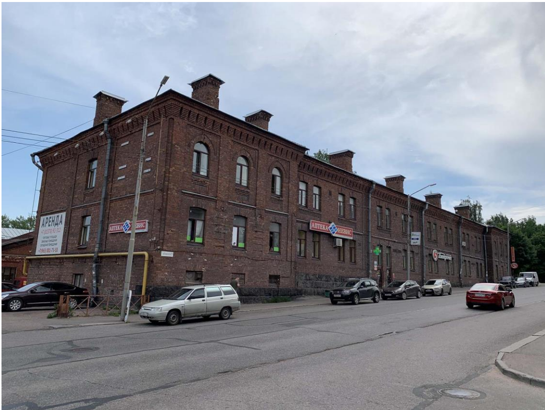
Фото 14. Общий вид казармы по ул. Кривоносова, 13, корп. 1, элемента «Комплекса казарм Финляндского стрелкового полка». Фото с ул. Кривоносова, с севера (22 июня 2020 г.).
