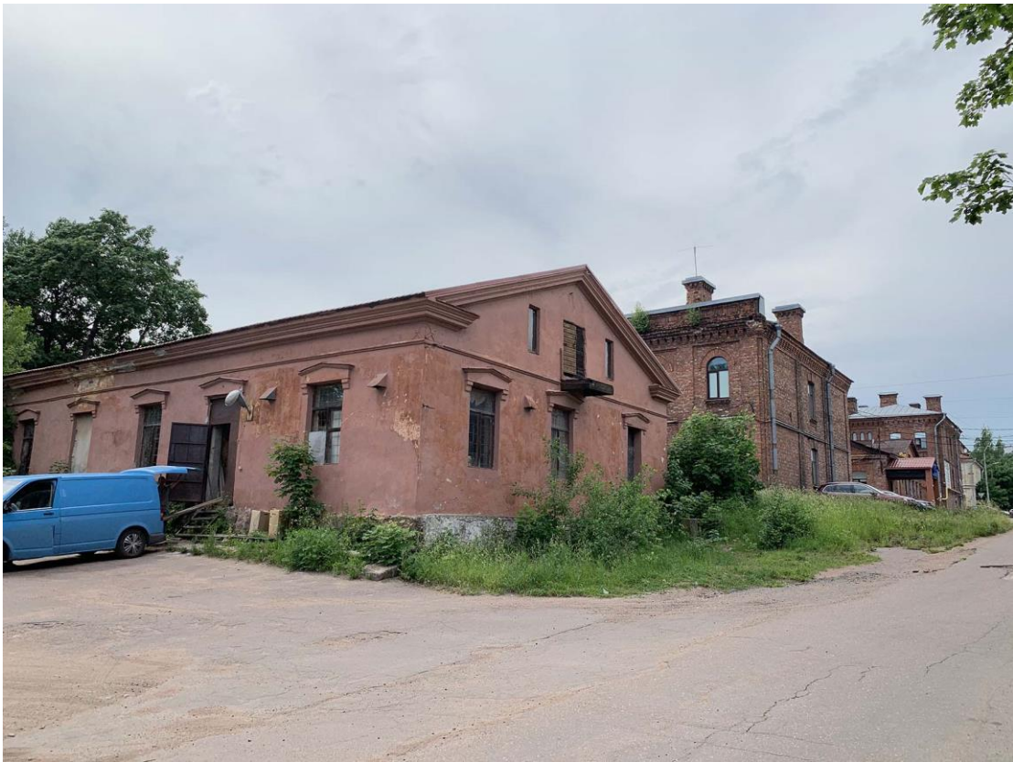
Фото 13. Общий вид склада, кухни со столовой и казармы, элементов «Комплекса казарм Финляндского стрелкового полка». Фото с ул. Кривоносова. Фото с востока (22 июня 2020 г.).
