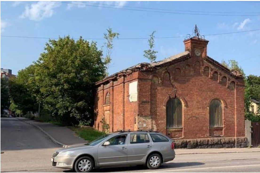
Фото 1. Общий вид застройки участка по ул. Кривоносова, 20, и двух производственных корпусов бывшего Стеаринового завода. Фото с юга (22 июня 2020 г.).
