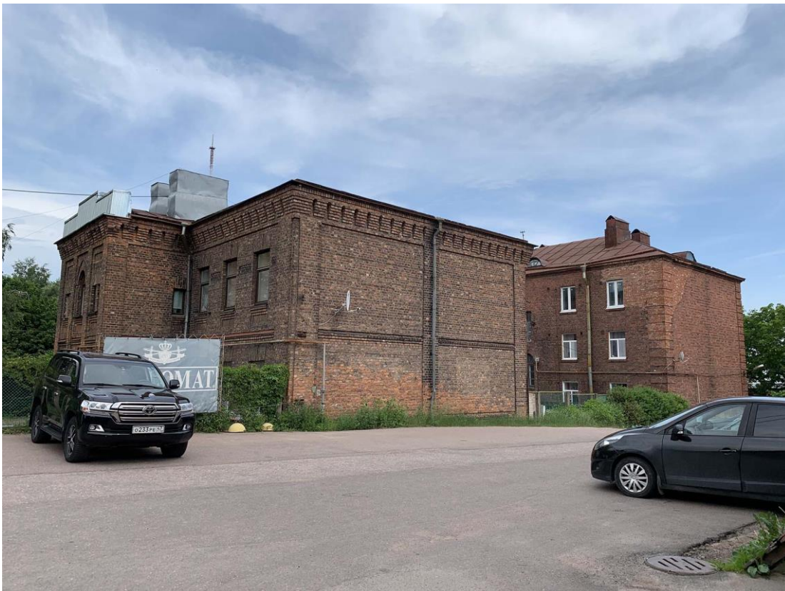
Фото 24. Общий вид офицерских домов, элементов «Комплекса казарм Финляндского стрелкового полка». Фото с ул. Тупиковой, с запада (22 июня 2020 г.).
