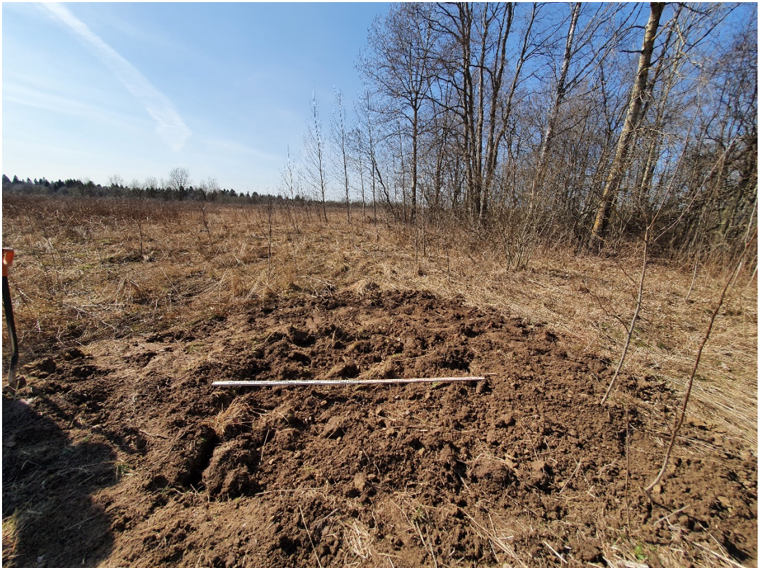
Рис. 33. Ленинградская область, Гатчинский район, Никольское. Шурф 1. Рекультивация
