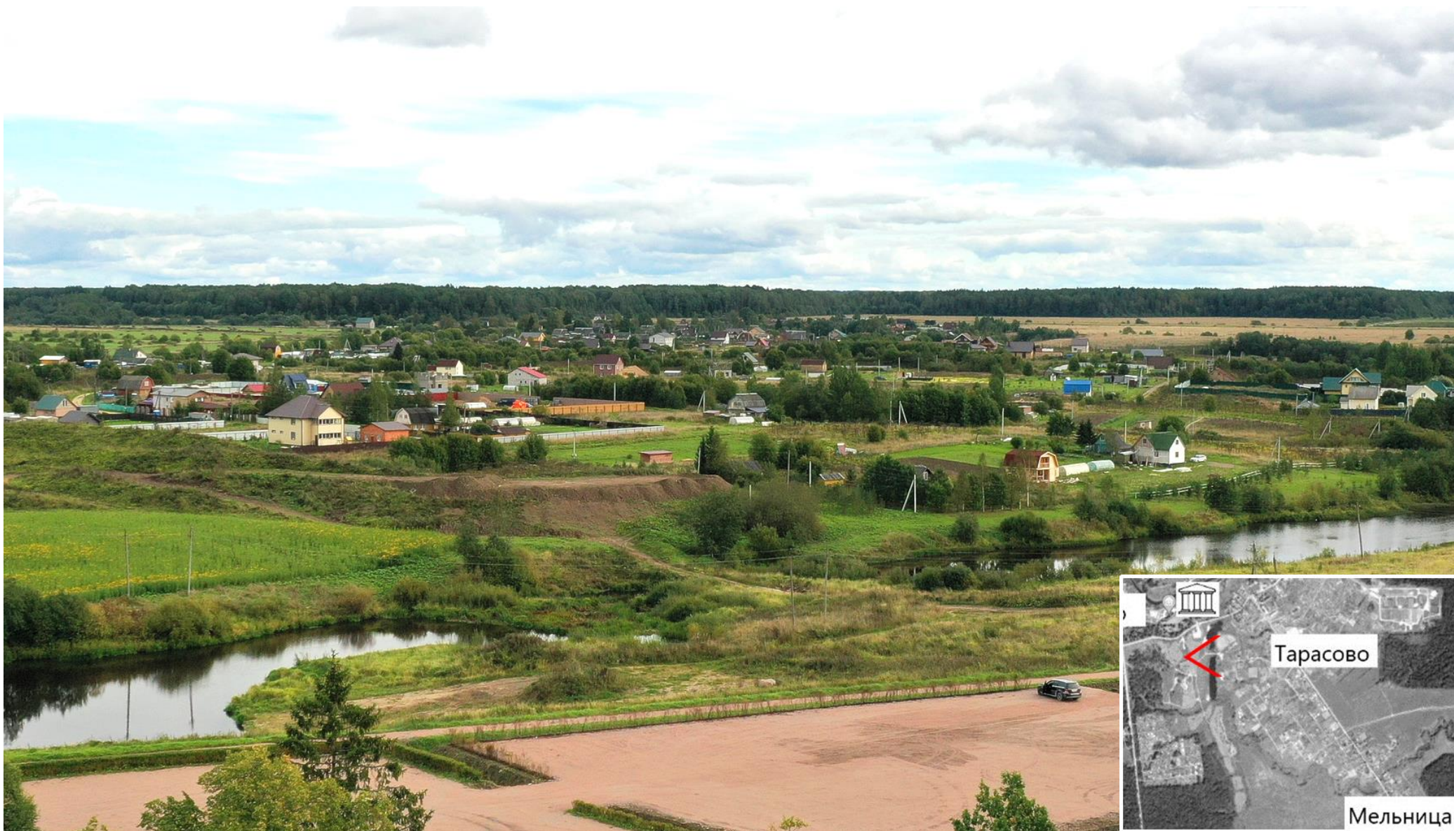
20 Вид с запада на современную застройку между Тарасовским проспектом и рекой Пяльей.
