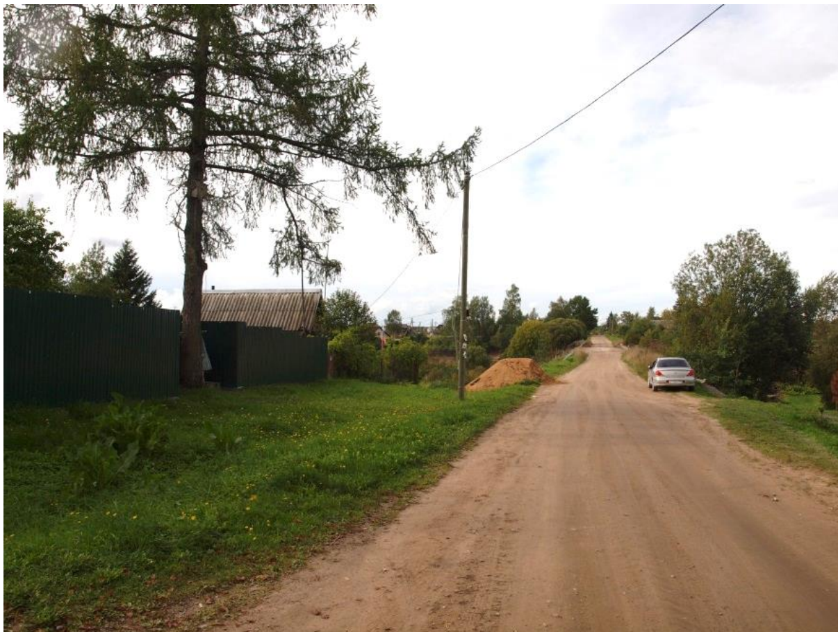
32 Имение Строгановых (Марьино). Деревня Мельница. Вид на север, на мост через реку Пялью.
