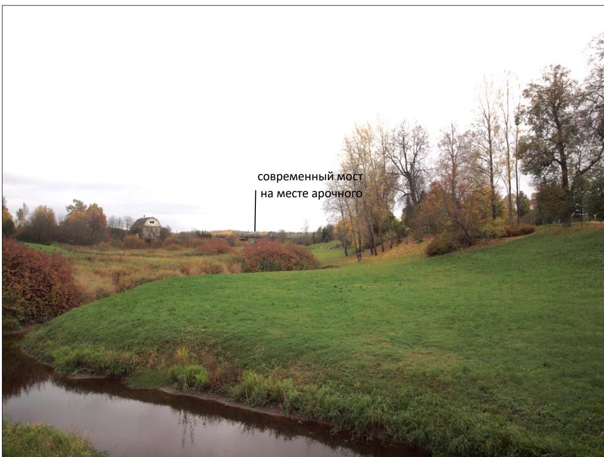
2а. Вид с территории усадьбы, с берега реки Пяльи, на юг. На месте утраченной ранее Зелёной мызы установлена беседка-ротонда (вне кадра). Исторический крутой спуск к руслу утрачен. Фото 2020 г.
