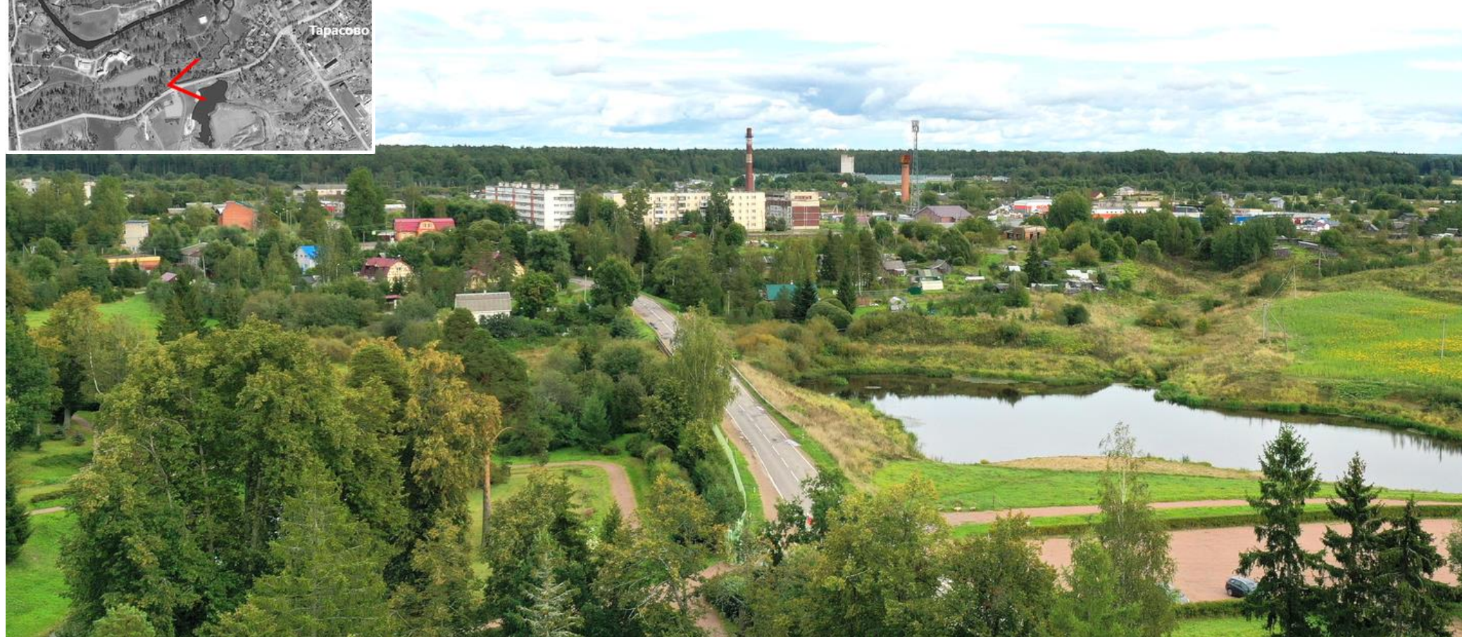
12 Вид на застройку деревни Тарасовой от центральной части имения (с пересечения исторического Почтового тракта и русла Пяльи ). Справа – пруды на р. Пялье.
