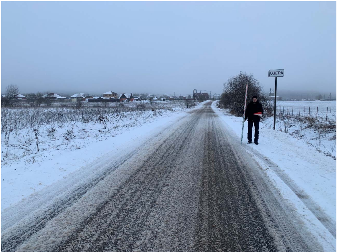
Илл.20. Ленинградская обл. Калитинское сельское поселение, Волосовский район. Точка фотофиксации 8. Общий вид на участок обследования с запада. Для масштаба использована нивелировочная рейка длиной 2 м.
