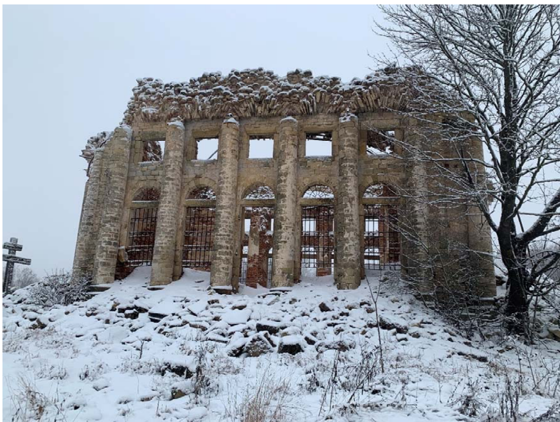
Илл.26. Ленинградская обл. Калитинское сельское поселение, Волосовский район. Точка фотофиксации 11. Общий вид на участок обследования с востока. Для масштаба использована нивелировочная рейка длиной 2 м.
