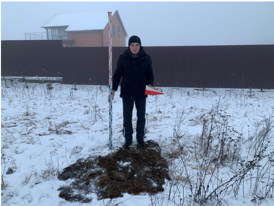
Илл.120. Ленинградская обл. Калитинское сельское поселение, Волосовский район. Шурф 9. Общий вид после рекультивации. Вид с востока. Для масштаба использована нивелировочная рейка длиной 2 м.
