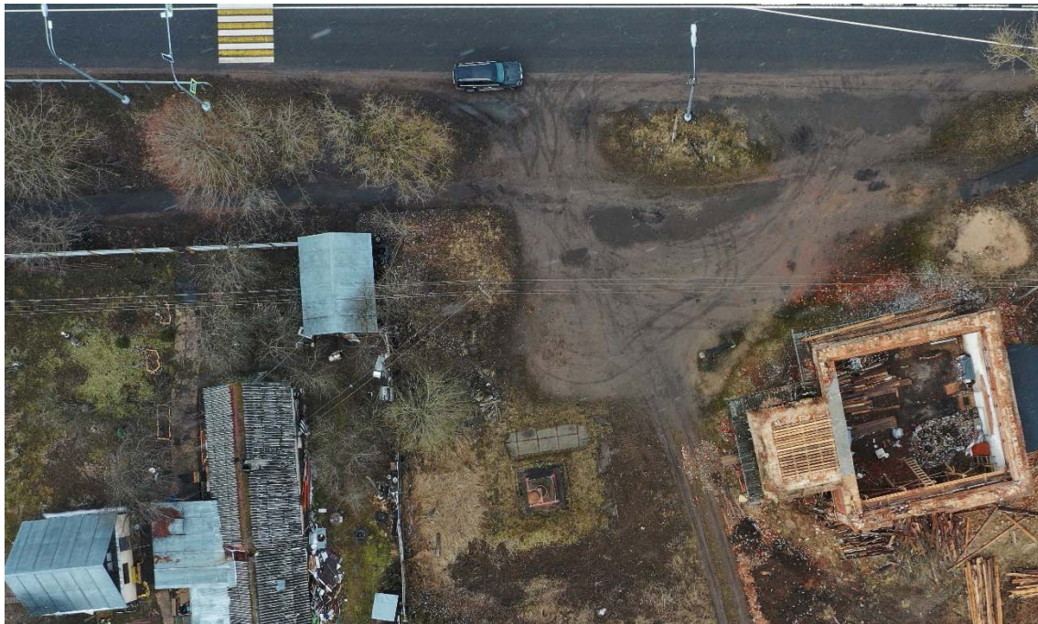
Фото 1. Аэрофотосъемка. Вид на объект сверху. Общий вид.
