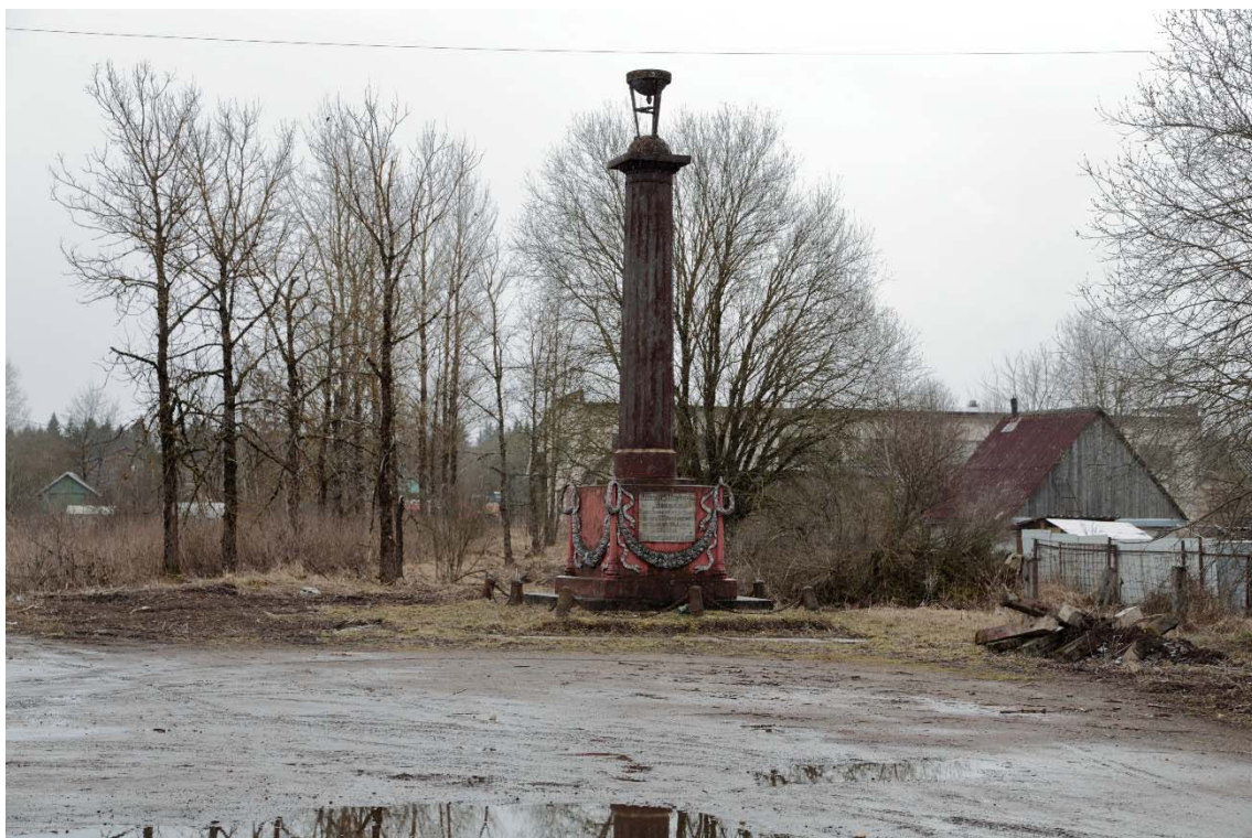
Фото 7. Наземная фотосъемка. Общий вид на сооружение с северо-востока.
