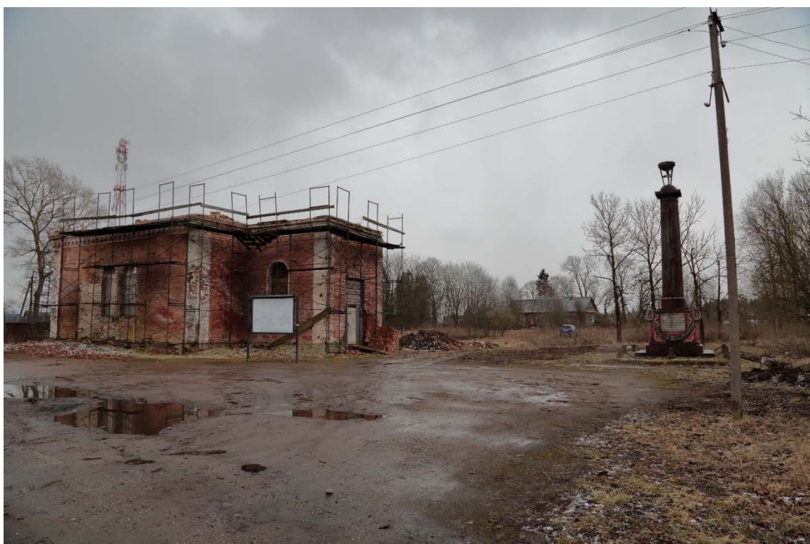
Фото 8. Наземная фотосъемка. Общий вид на сооружение с юго-запада.
