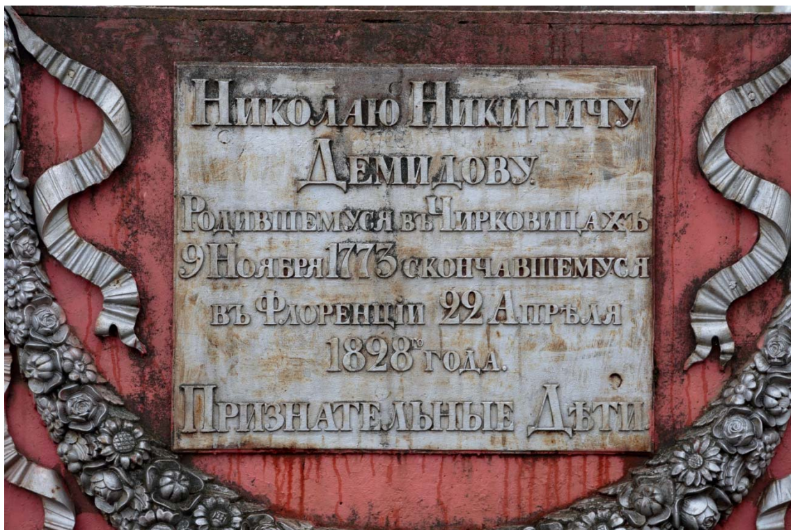
Фото 10. Наземная фотосъемка. Выпуклая надпись на постаменте, выполненная методом чугунного литья.
