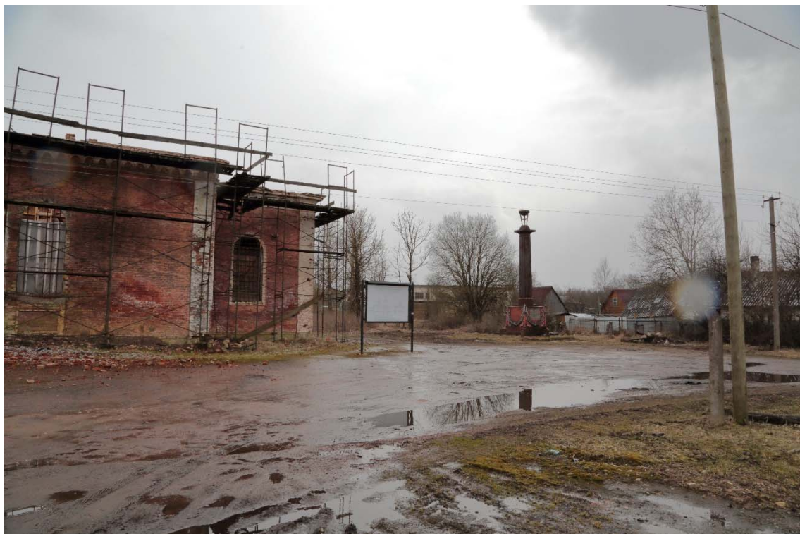
Фото 12. Наземная фотосъемка. Фото с северо-востока.
