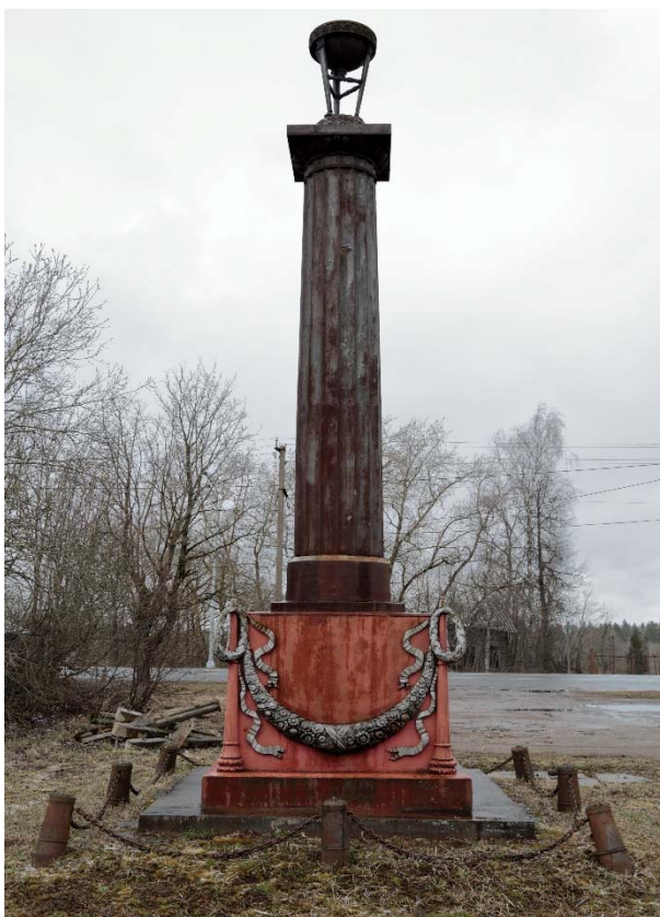
Фото 5. Наземная фотосъемка. Южный фасад сооружения.
