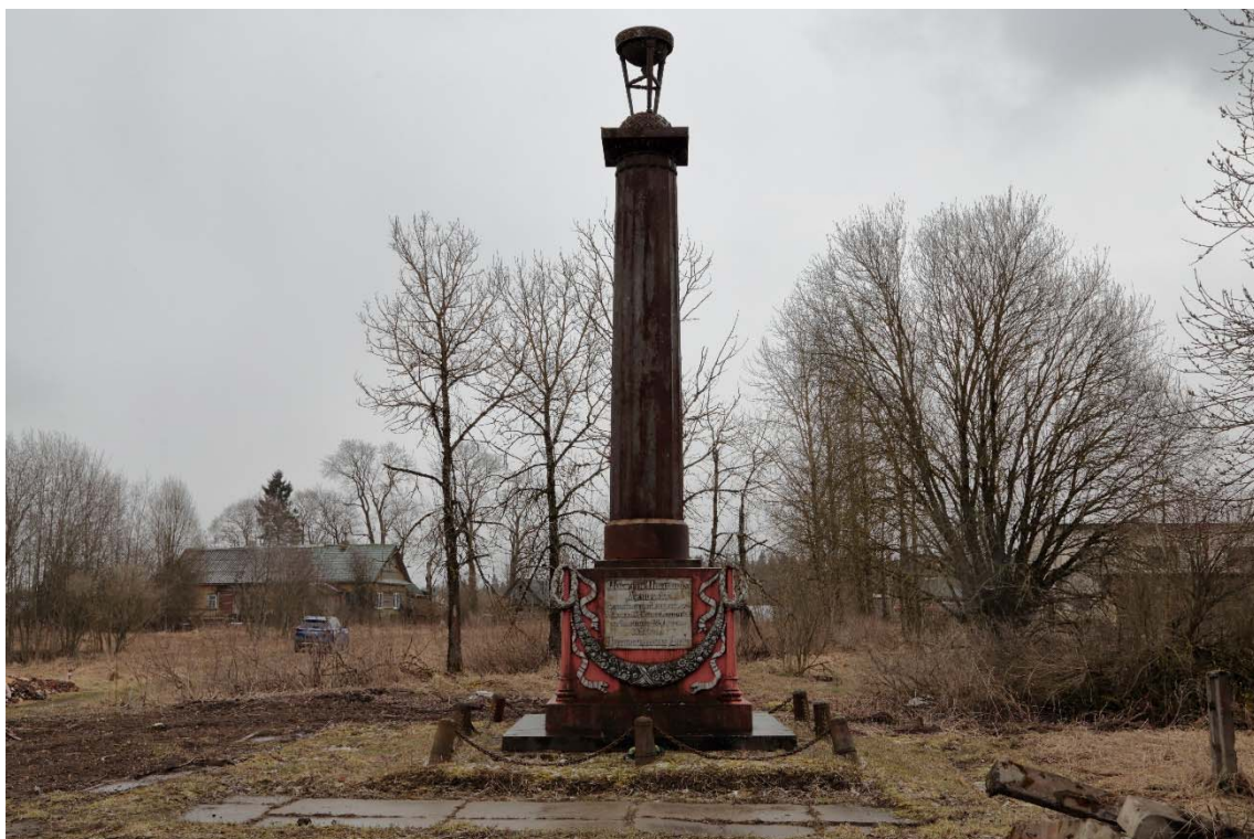
Фото 3. Наземная фотосъемка. Северный (главный) фасад сооружения.
