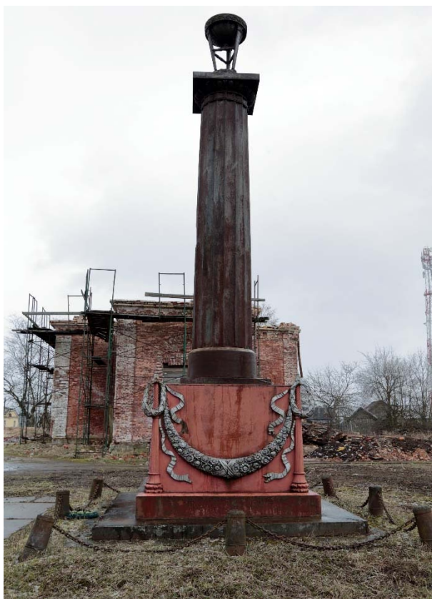
Фото 6. Наземная фотосъемка. Восточный фасад сооружения.
