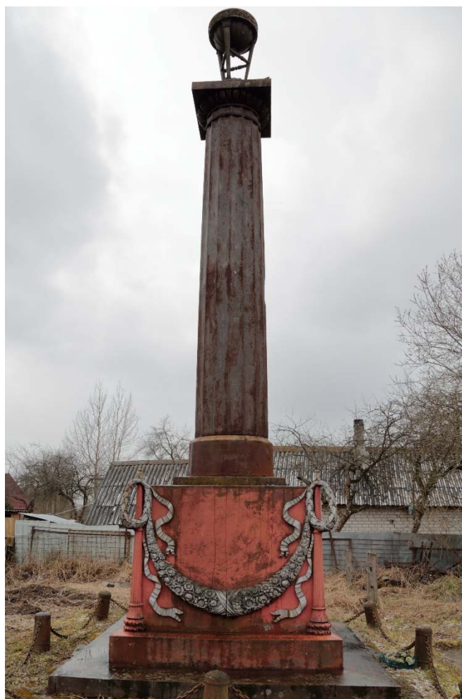
Фото 4. Наземная фотосъемка. Восточный фасад сооружения.
