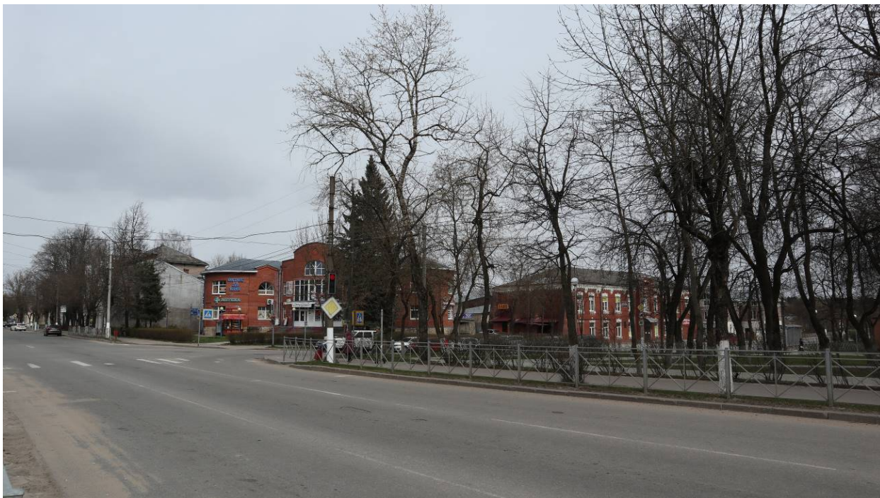
12. Объект культурного наследия регионального значения «Здание бывшего управления и банка», расположенный по адресу: г. Луга, пр. Кирова, 69. Общий вид на Городской сад по пр. Кирова, направление северо-восток.
