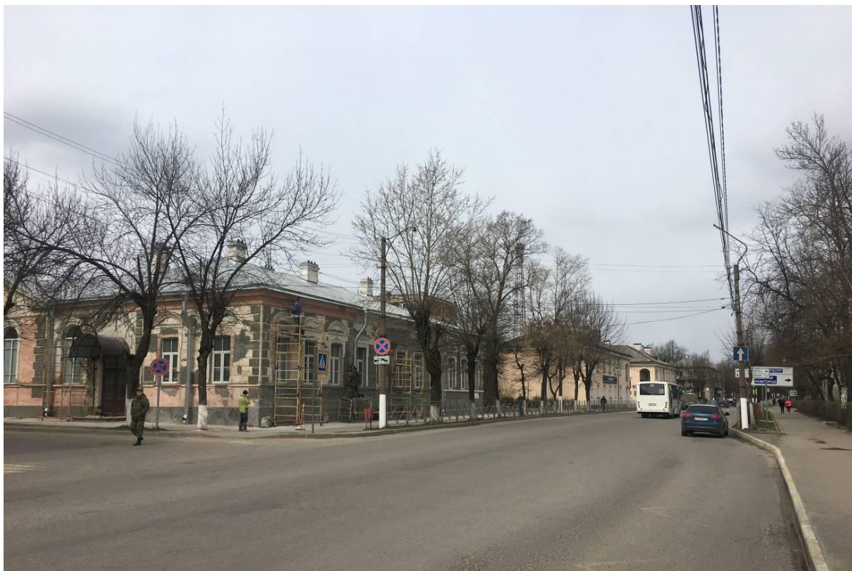
32. Вид на пр. Кирова, направление съемки – северо-запад. Объект культурного наследия регионального значения «Здание бывшего городского управления и банка», расположенный по адресу: г. Луга, пр. Кирова, 69
