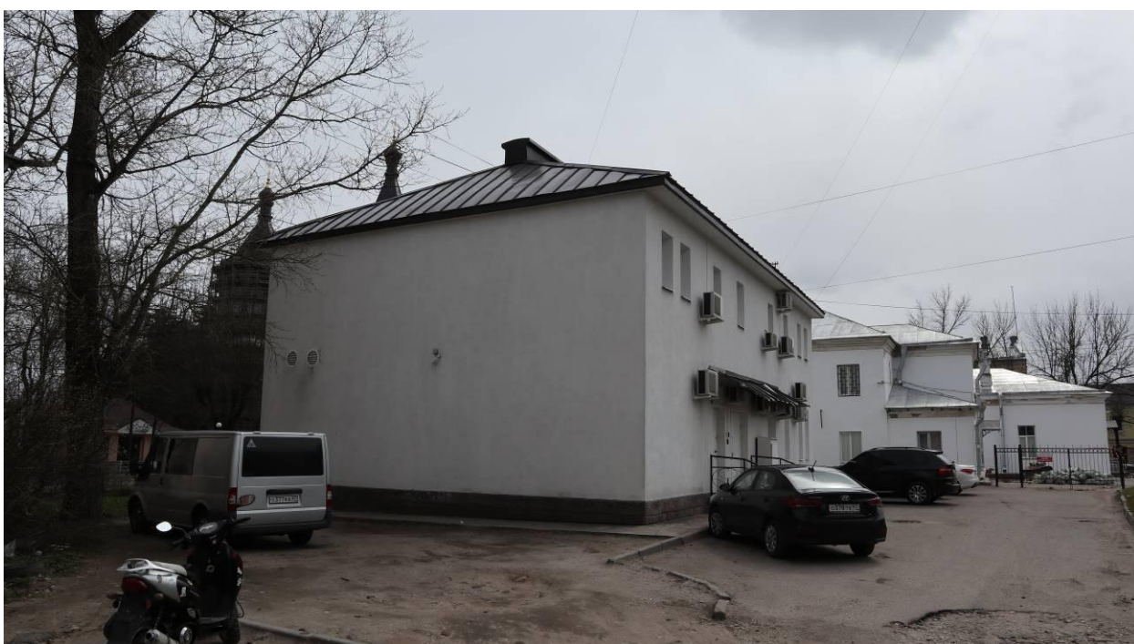
15. Общий вид здания, направление съемки – юго-восток. Объект культурного наследия регионального значения «Здание бывшего городского управления и банка», расположенный по адресу: г. Луга, пр. Кирова, 69
