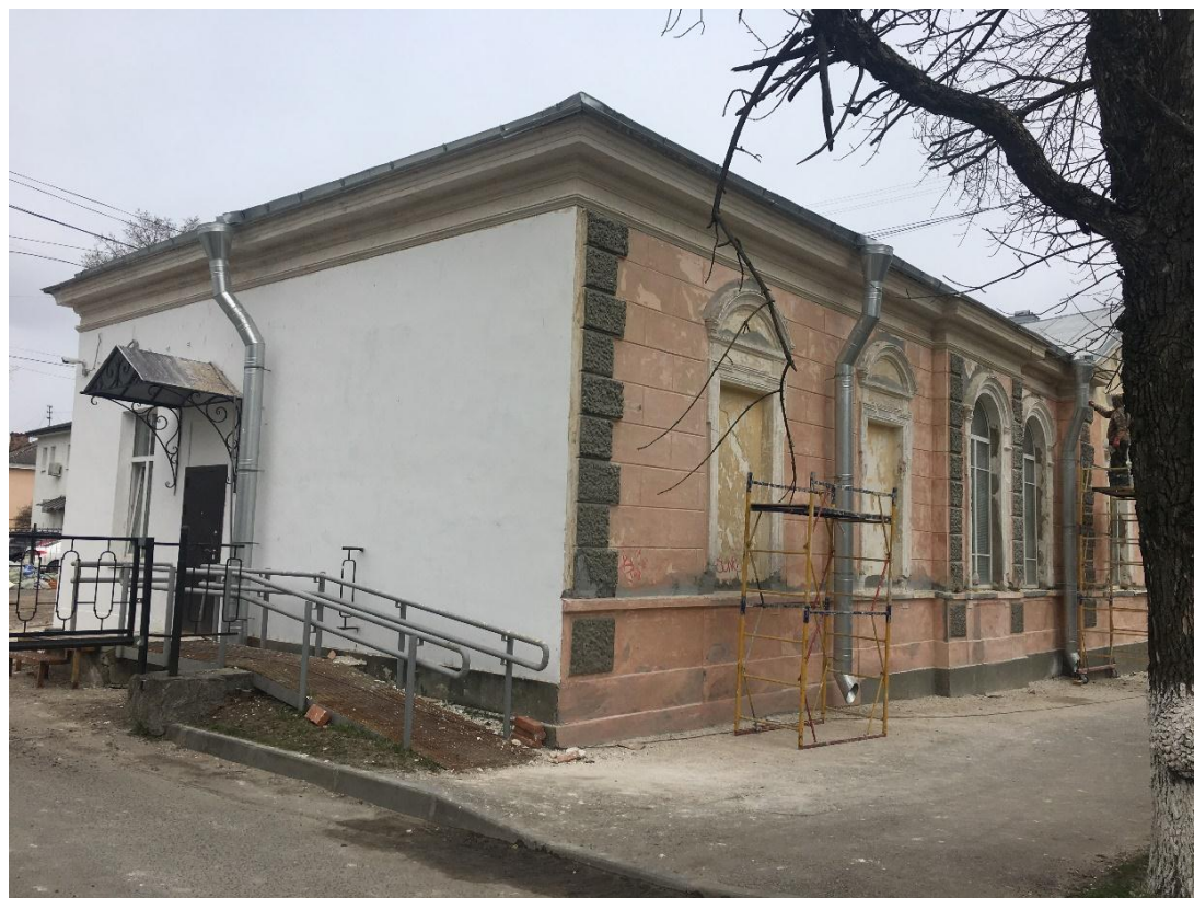
8. Вид лицевого и торцевого фасадов здания, направление съемки – северо-восток. Объект культурного наследия регионального значения «Здание бывшего городского управления и банка», расположенный по адресу: г. Луга, пр. Кирова, 69.
