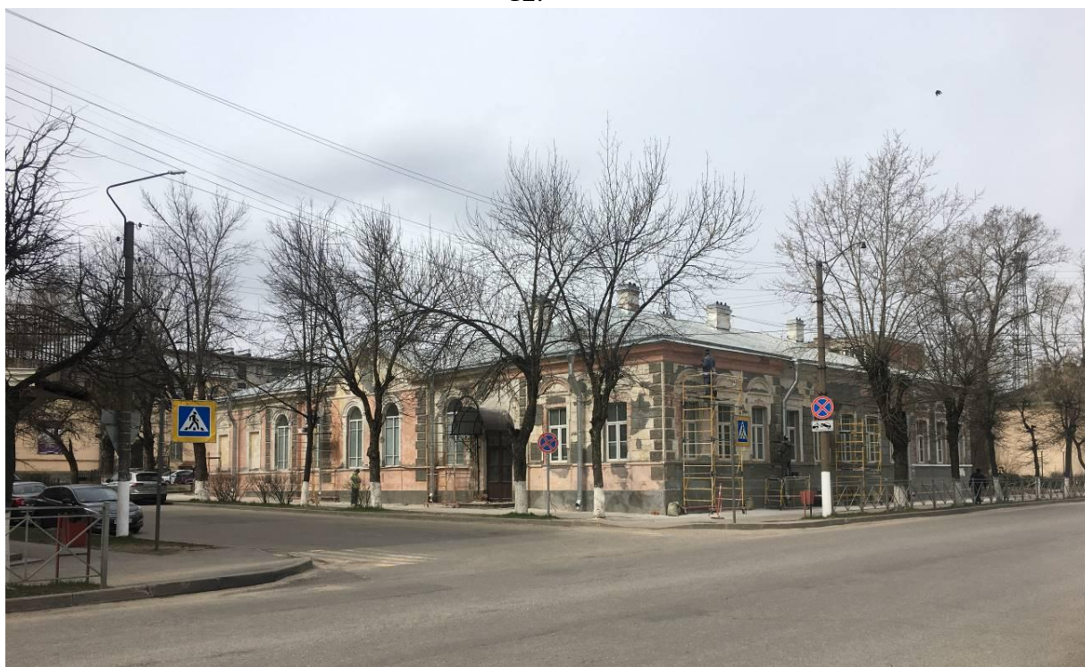
13. Общий вид здания, направление съемки – северо-запад. Объект культурного наследия регионального значения «Здание бывшего городского управления и банка», расположенный по адресу: г. Луга, пр. Кирова, 69
