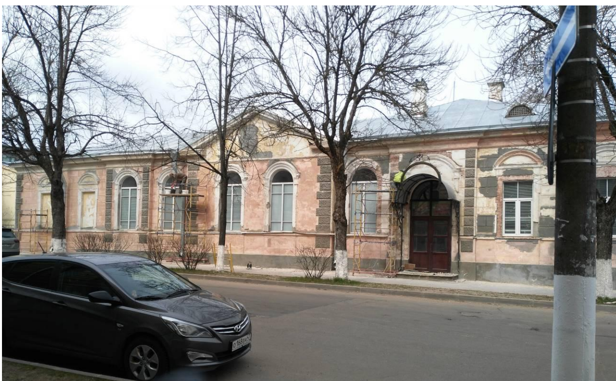
10. Вид лицевого фасада здания, направление съемки - север. Объект культурного наследия регионального значения «Здание бывшего городского управления и банка», расположенный по адресу: г. Луга, пр. Кирова, 69.
