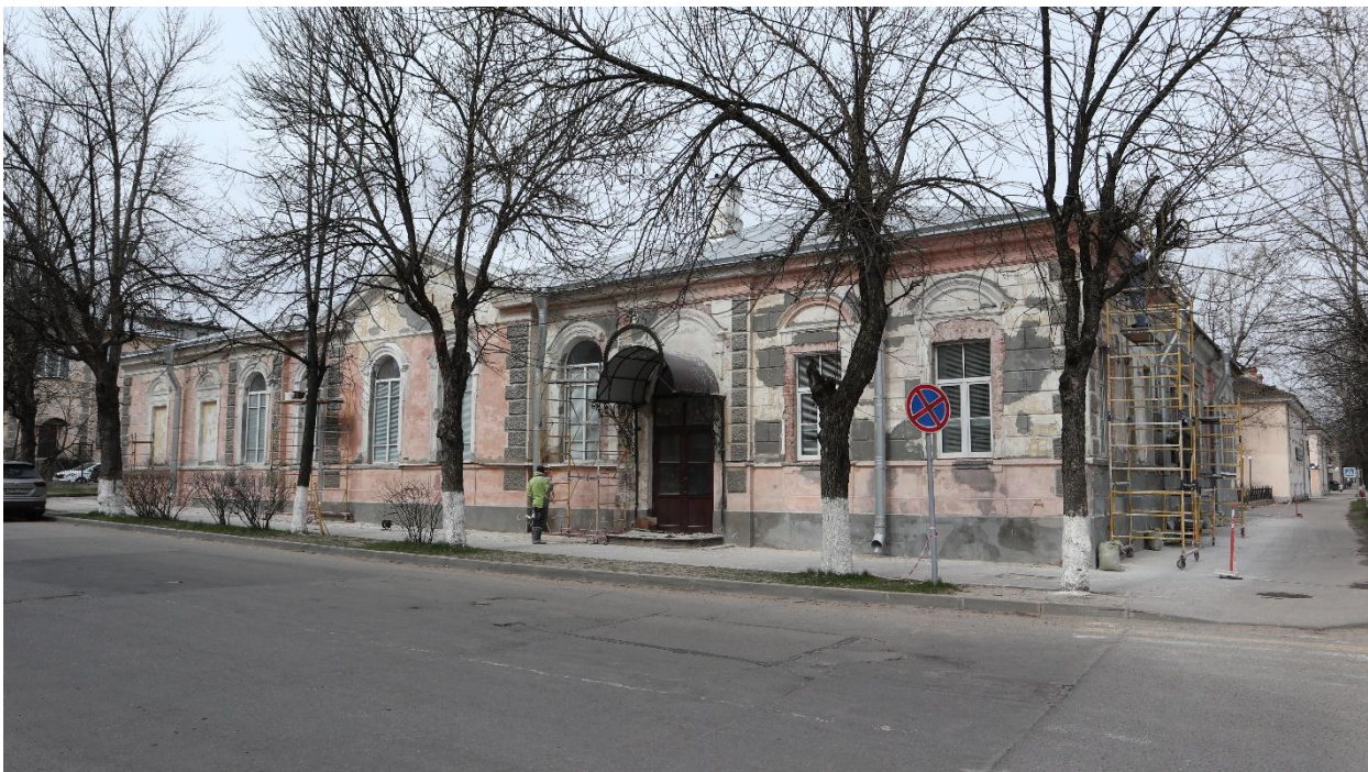
1. Вид лицевого фасада здания, направление съемки - север. Объект культурного наследия регионального значения «Здание бывшего городского управления и банка», расположенный по адресу: г. Луга, пр. Кирова, 69.
