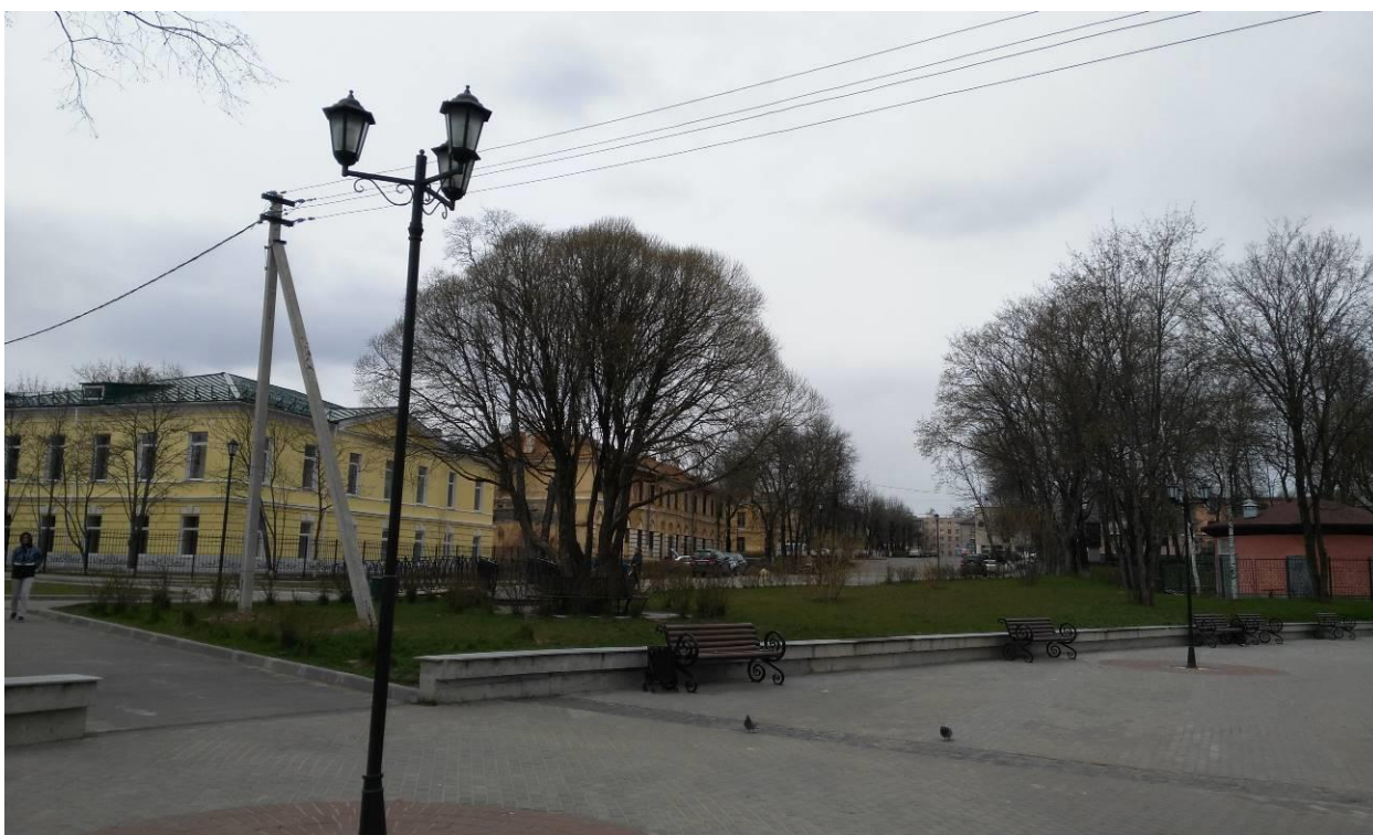
9. Объект культурного наследия регионального значения «Здание бывших присутственных мест», расположенный по адресу: г. Луга, пр. Володарского, 2. Общий вид на Городской сад и пер. Связи, направление запад.
