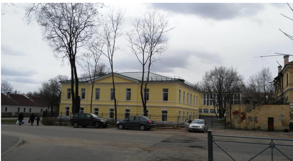
3. Объект культурного наследия регионального значения «Здание бывших присутственных мест», расположенный по адресу: г. Луга, пр. Володарского, 2. Вид на «Здание б. городского училища» лицевой фасад здания, направление юг.
