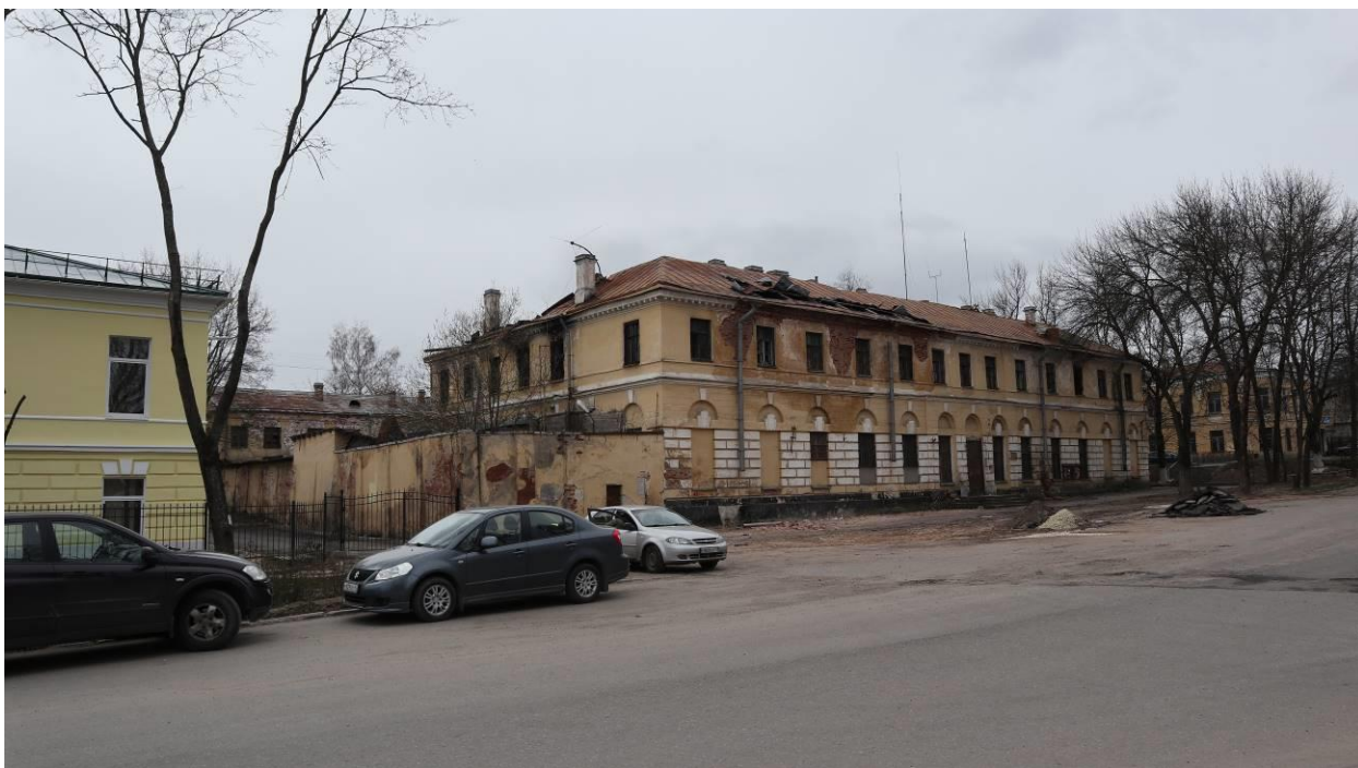
2. Объект культурного наследия регионального значения «Здание бывших присутственных мест», расположенный по адресу: г. Луга, пр. Володарского, 2. Вид на лицевой фасад здания, направление юго-запад.
