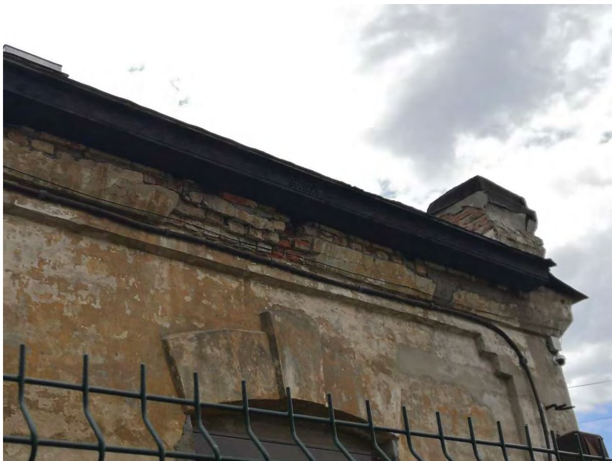
Фото.22. Вид на карниз Дома Спиридонова.
