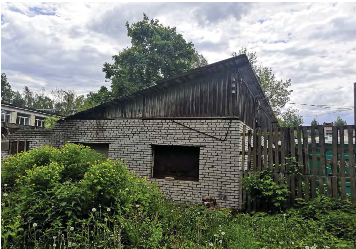
Фото.20. Вид на соседнее здание, расположенное на рассматриваемом участке.
