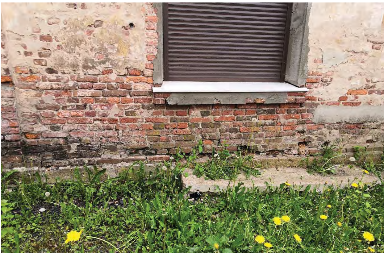
Фото.14. Вид на цоколь с северо-востока..
