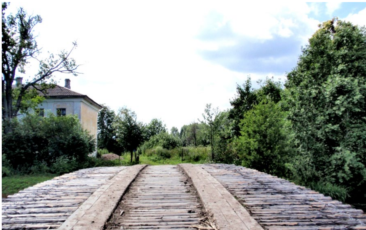
ФОТО 5. Вид в южном направлении на деревянный мост и здание караулки.
