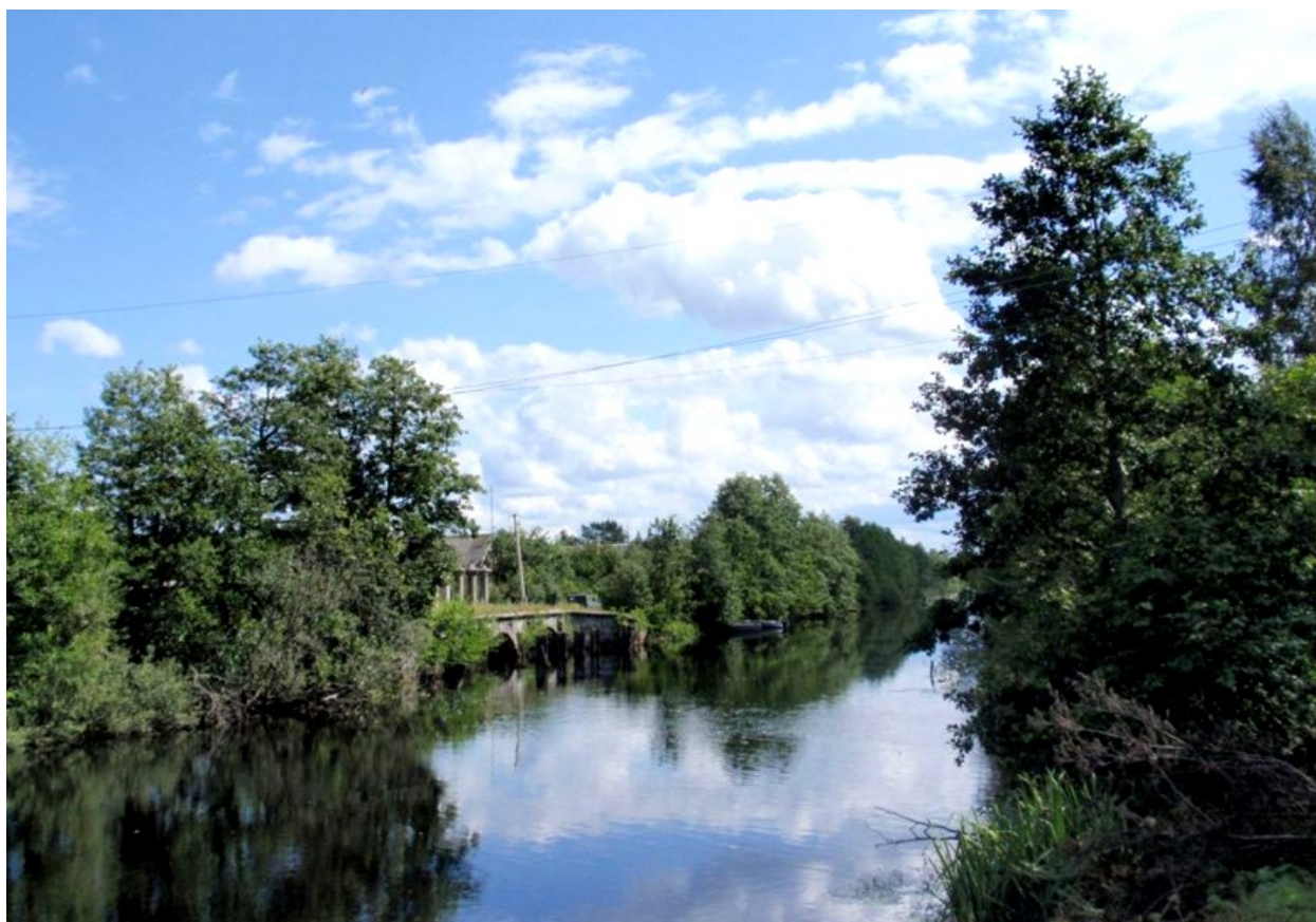
ФОТО 6. Вид с южной части деревянного моста через Староладожский канал на шандорный мост и Староладожский канал в восточном направлении.
