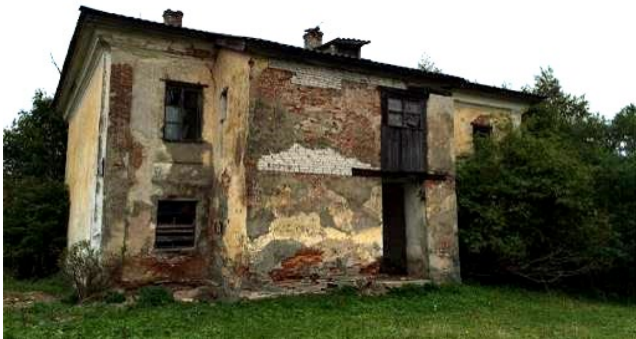
ФОТО 7. Вид южного фасада здания караулки.
