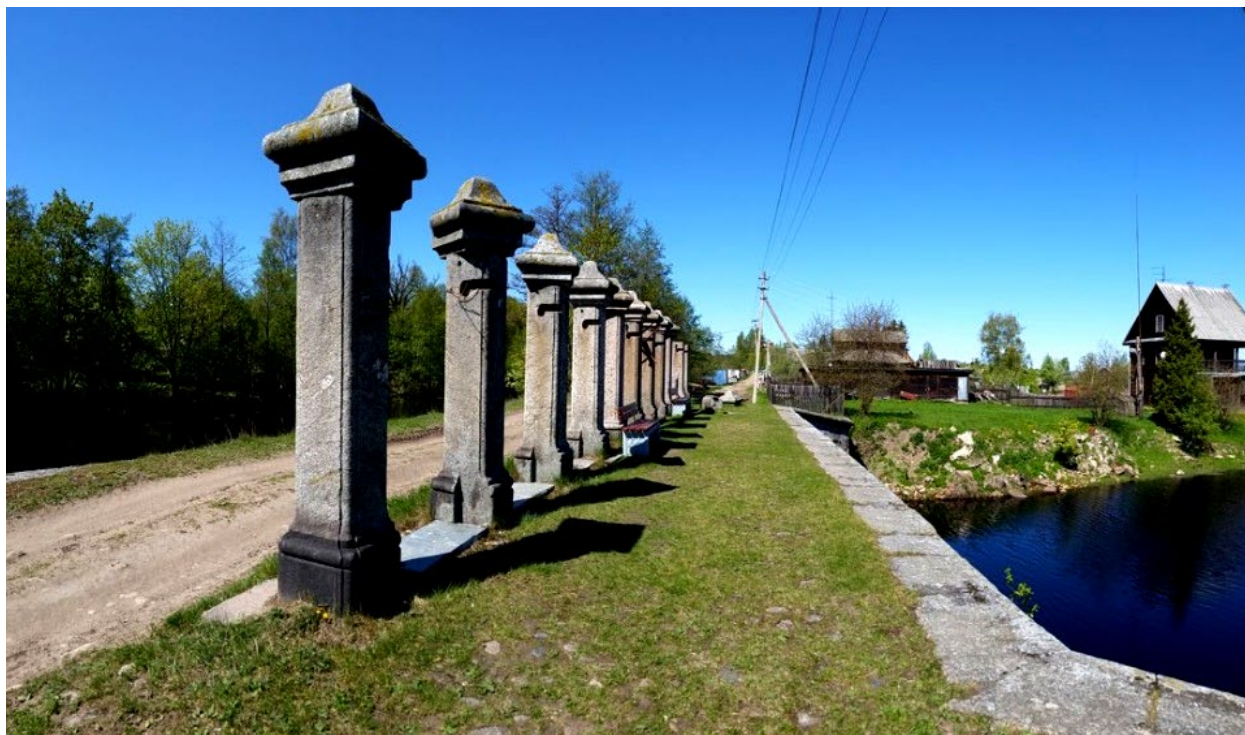
ФОТО 3. Вид в западном направлении на стойки шандорного моста.
