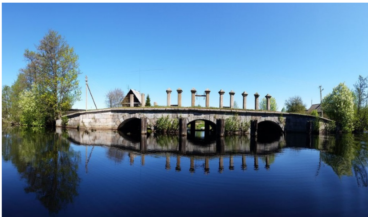
ФОТО 8. Вид в северном направлении на шандорный мост.
