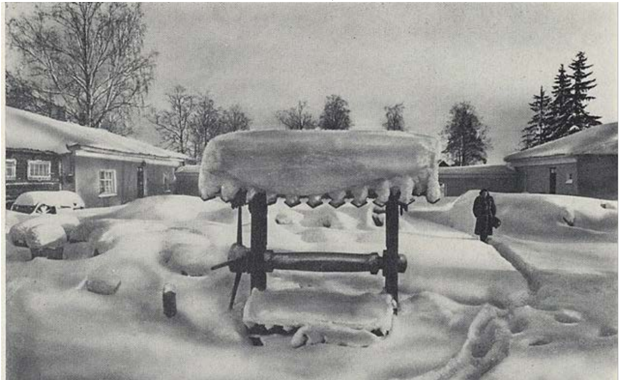
11. Двор почтовой станции в Выре. 1980 – 1986 // А. Дроздов, В. Савик Источник:Ю. Гоголицин, Т. Гоголицина, Памятники архитектуры Ленинградской области, Стройиздат, 1987.
