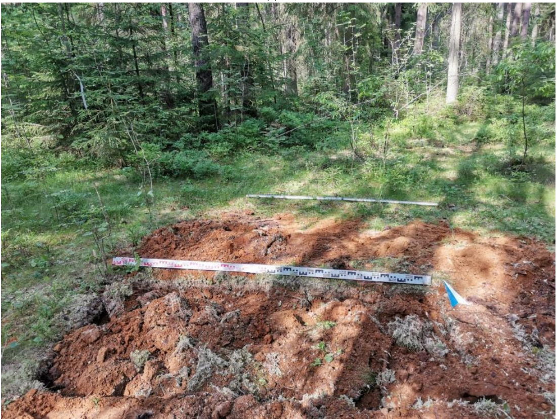
Рис. 348. ЛО-2021. Всеволожский район. Токсово. Шурф 28. Общий вид. Рекультивация. Вид с Ю
