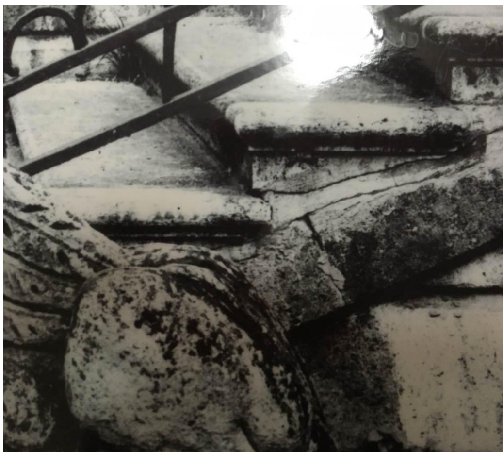
Илл. 100 Фото 1938-1940 г. Фрагмент правого марша. Растрескивание заделки зазора между тетивой и ступенями, выветривание швов в облицовке из гранитных плит, ремонтные домастиковки швов. ГМЗ «Гатчина», Б-6416. Негатив. [1.4.39]
