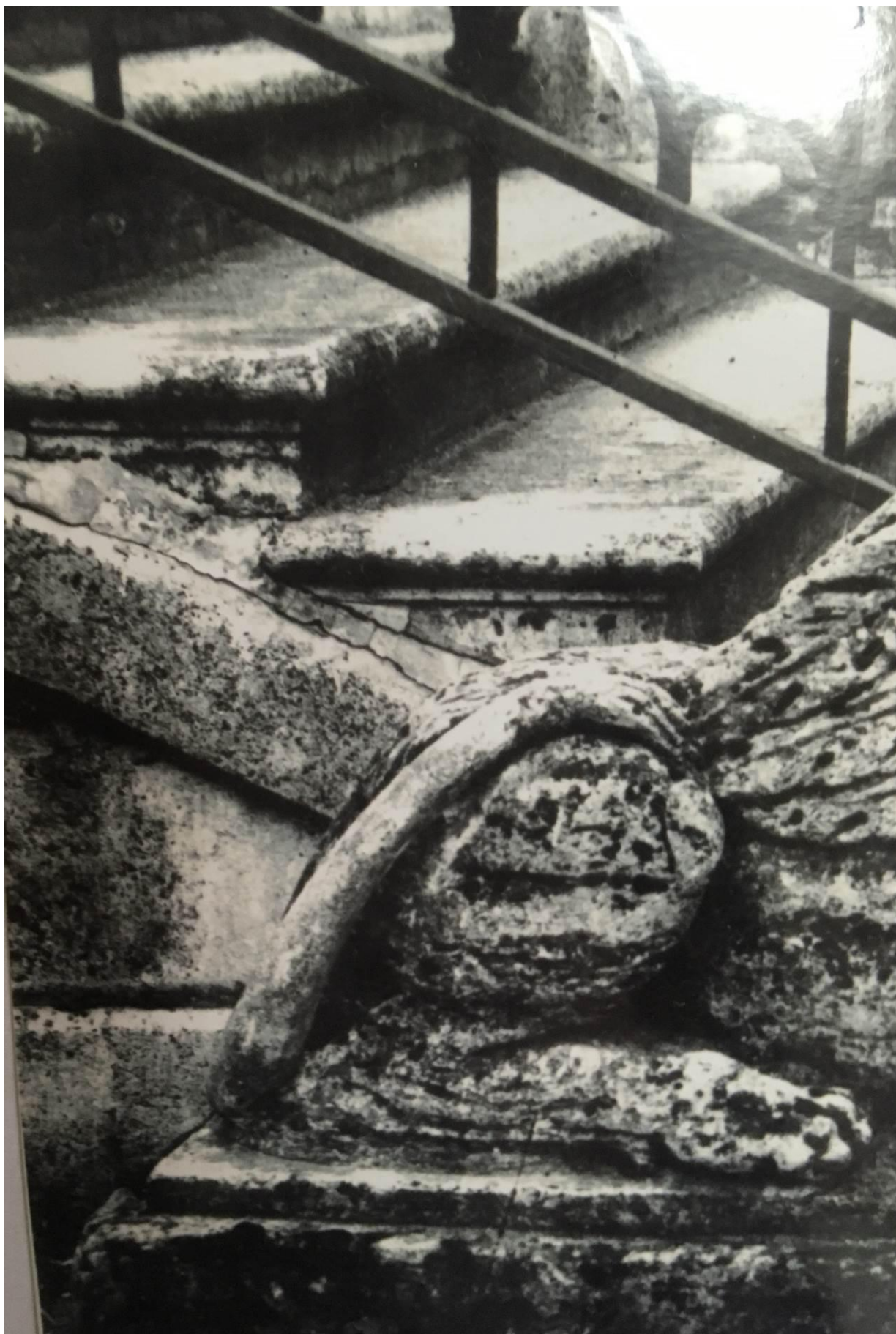
Илл. 98 Фото 1938-1940 г. Фрагмент левого марша. Растрескивание заделки зазора между тетивой и ступенями. ГМЗ «Гатчина», Б-6417. Негатив. [1.4.39]
