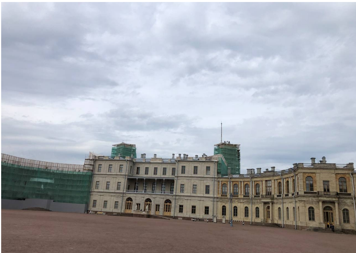
Фото 4. Фрагмент фасада объекта культурного наследия федерального значения «Гатчинский дворец (с Арсенальным и Кухонным каре)».
