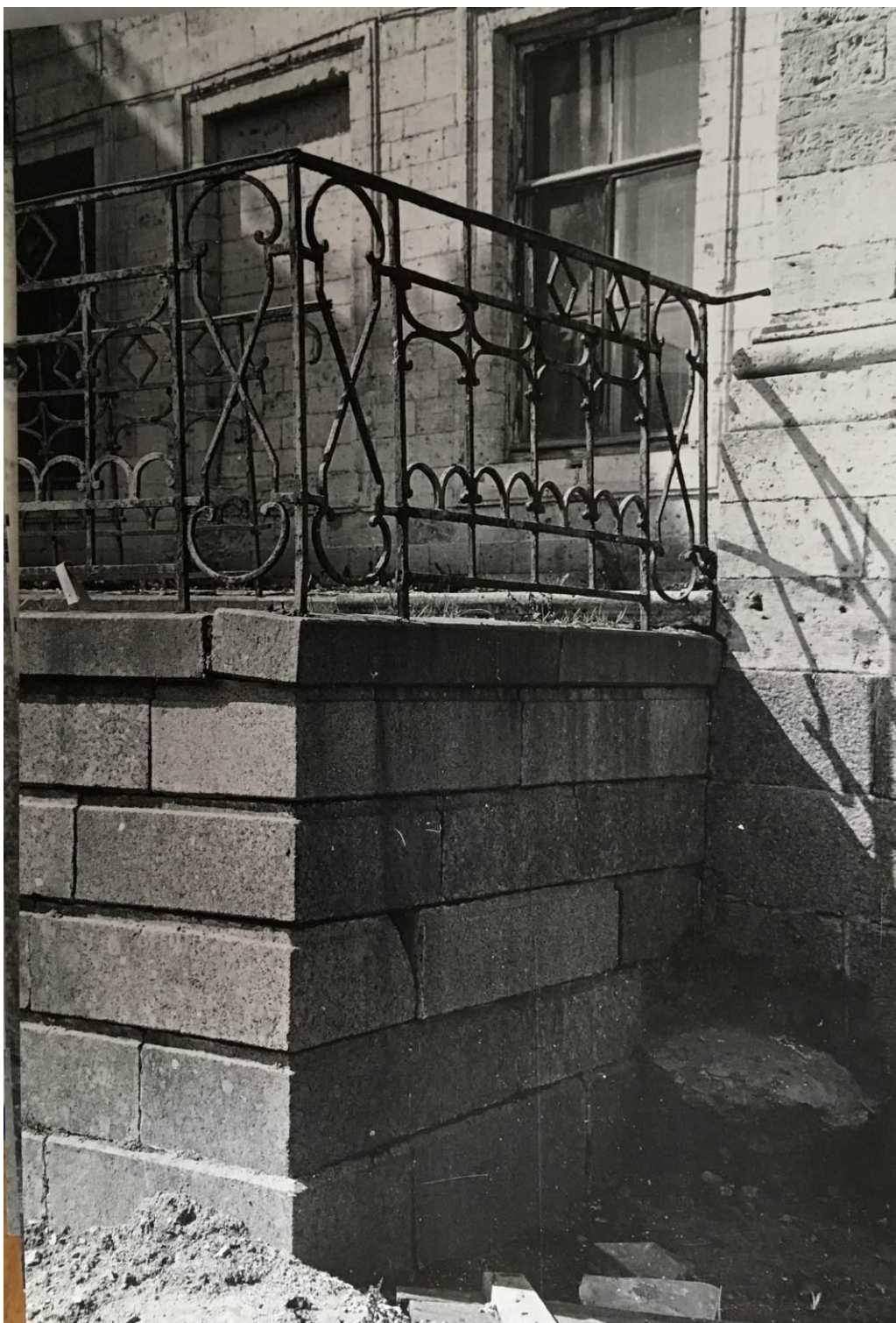
Илл. 115 Фото 1992 г. Сколы, частичные утраты, выветривание швов облицовки террасы из гранитных блоков. Изменение проектного положения гранитных блоков. ГМЗ «Гатчина». Фототека. Папка с фотографиями «Собственный сад» [1.4.39]
