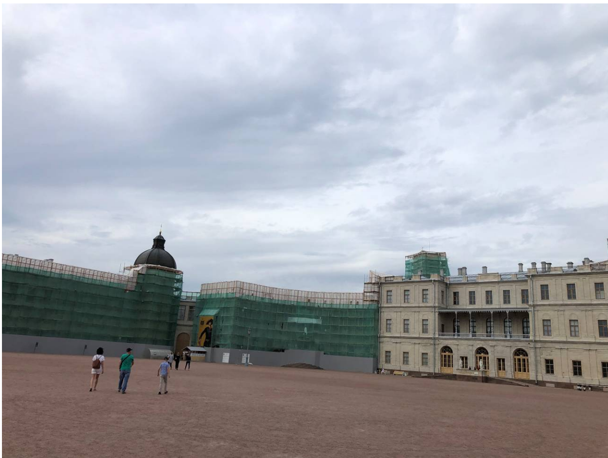
Фото 5. Фрагмент фасада объекта культурного наследия федерального значения «Гатчинский дворец (с Арсенальным и Кухонным каре)».
