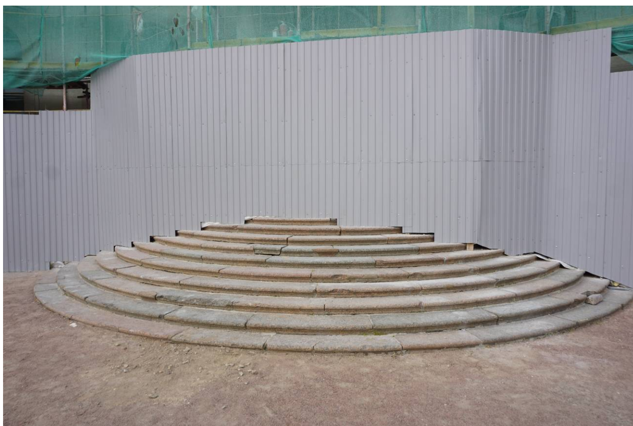
Фото 18. Крыльцо подлежащее реставрации.
