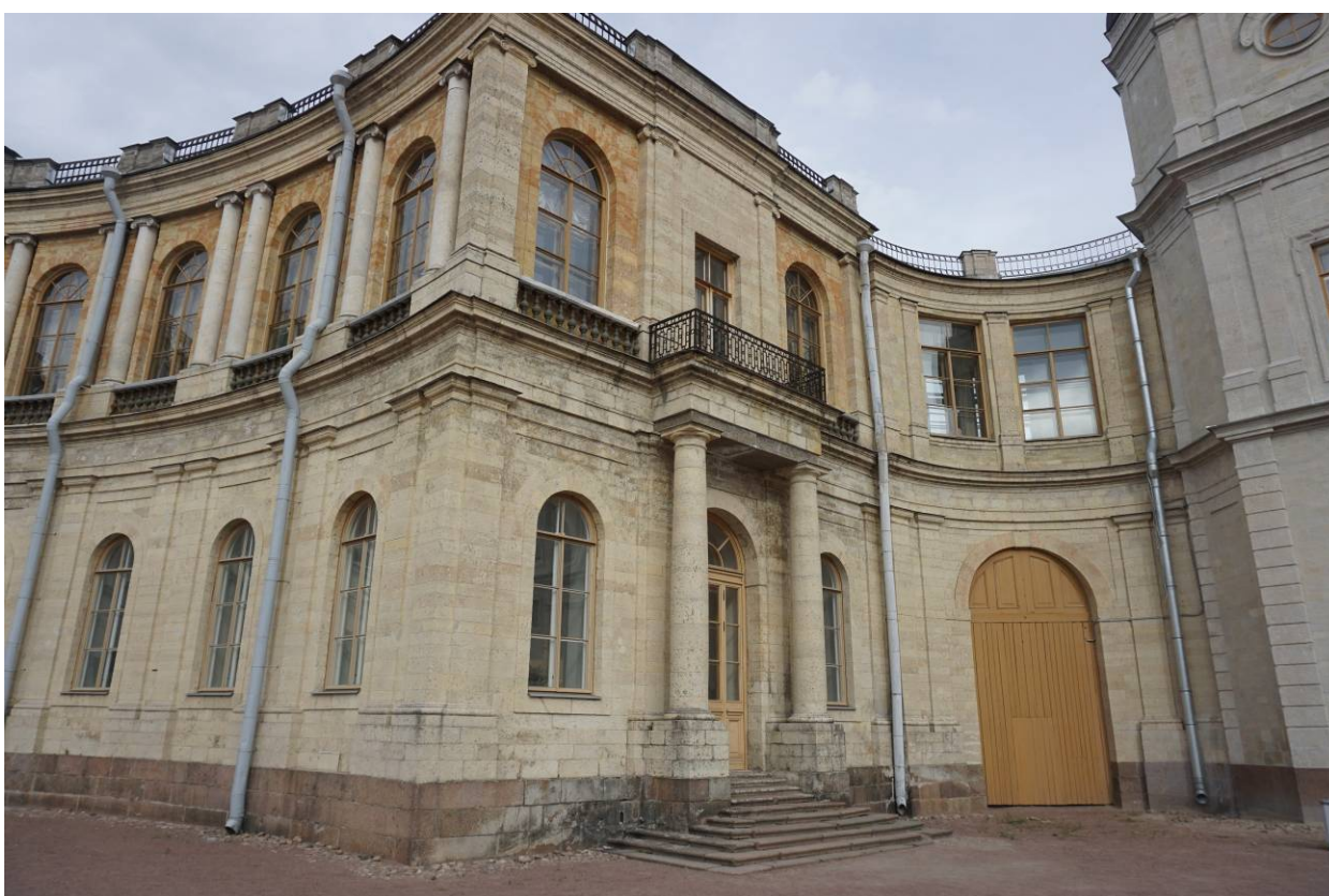
Фото 16. Крыльцо подлежащее реставрации.
