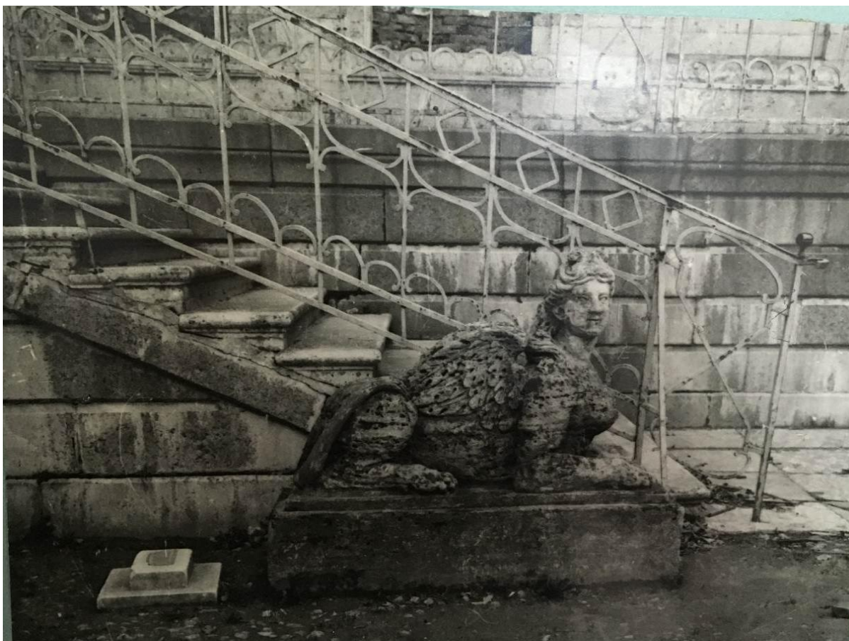
Илл. 105 Фото 1945 г. Левый марш. Голова скульптуры и заделка зазора в ступенях присутствует. ГМЗ «Гатчина», А-315 [1.4.39]
