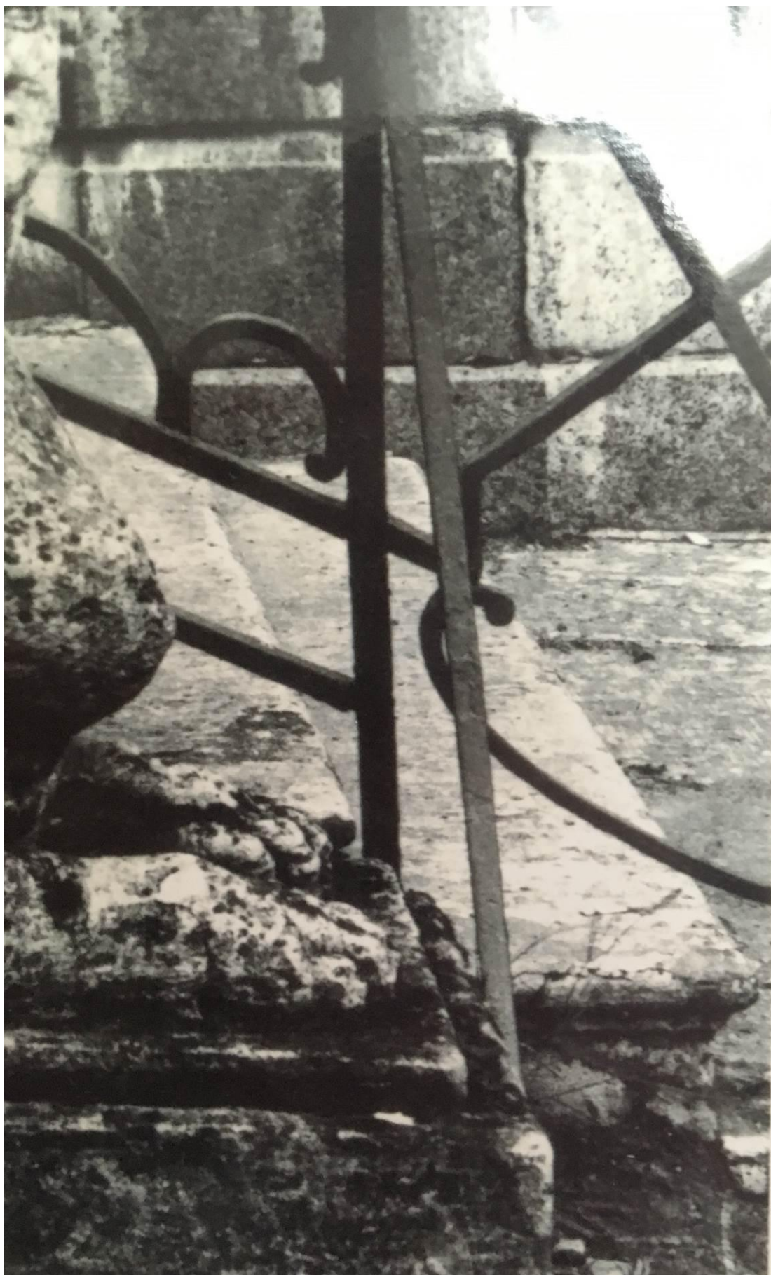
Илл. 97 Фото 1938-1940 г. Фрагмент левого марша. Подлинная подпорная стояка ограждения. ГМЗ «Гатчина», Б-6417. Негатив. [1.4.39]
