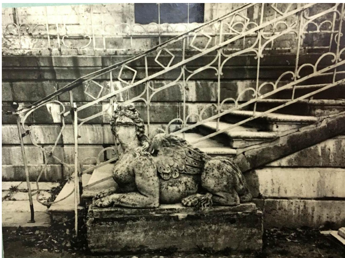
Илл. 106 Фото 1945 г. Левый марш. Утрата части лица скульптуры, деформация ограждения. ГМЗ «Гатчина». Нег. А-346 [1.4.39]
