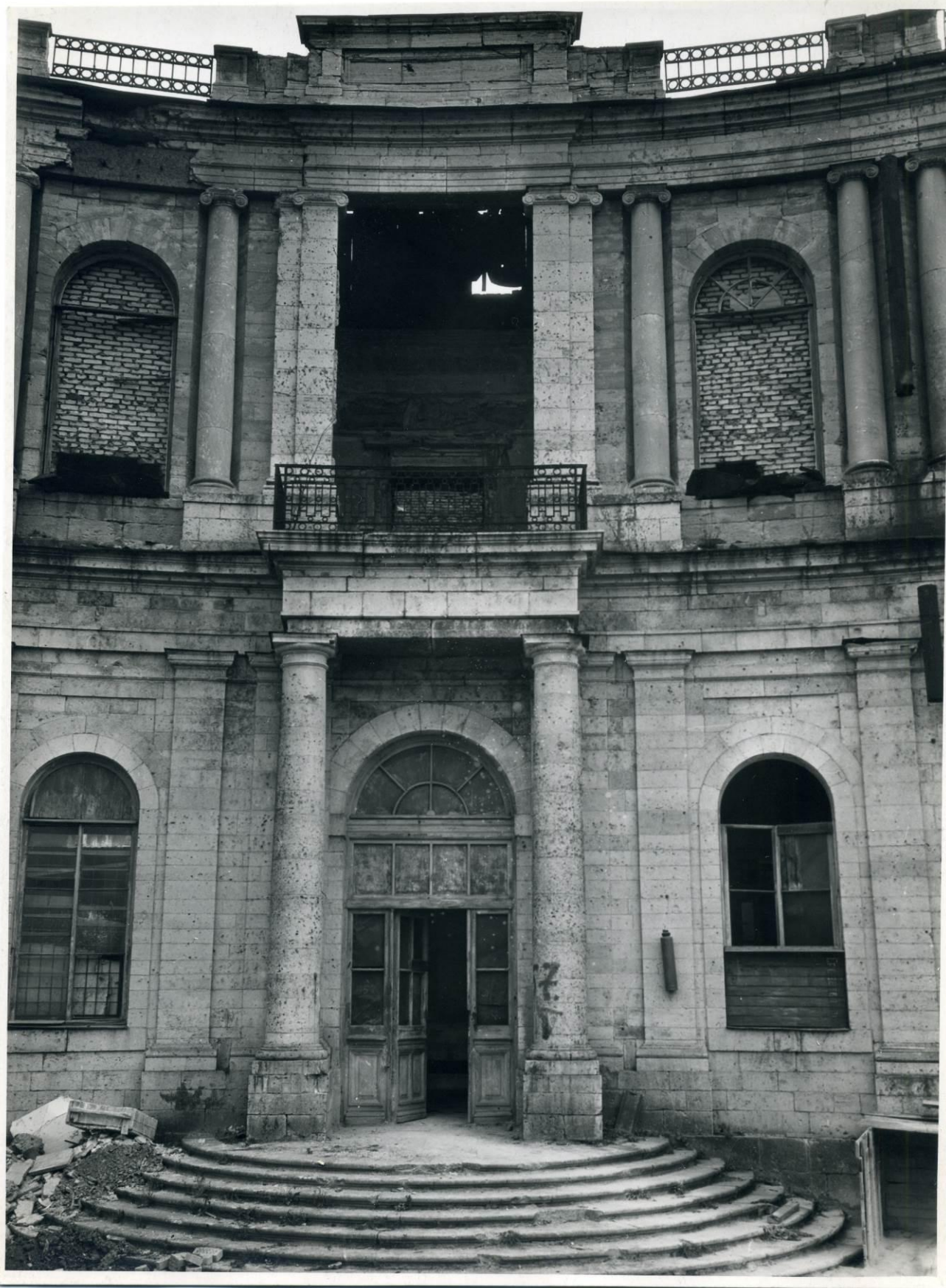
Илл. 134 Фото 1961 г. Отражены множественные деформации ступеней: утраты, сколы. СНРПМ. Из фонда ГМЗ «Гатчина». Фототека 1960-1990 гг. [1.4.8].
