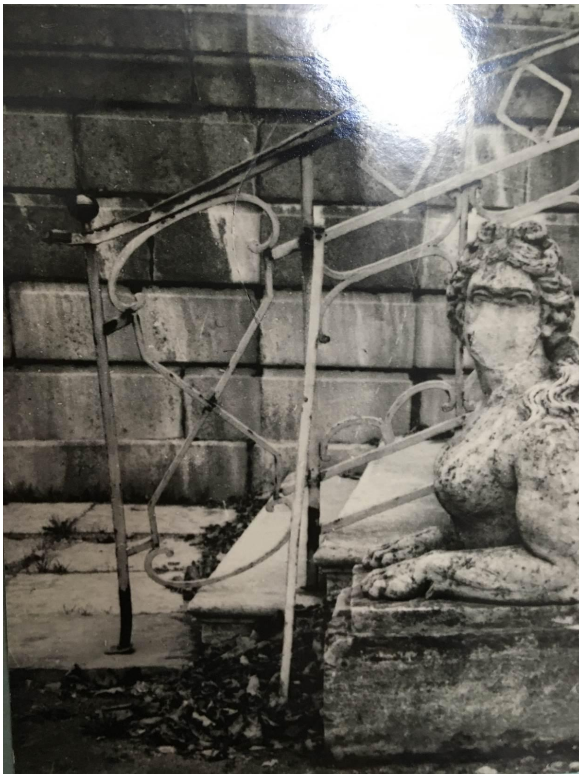
Илл. 108 Фото 1945 г. Фрагмент правого марша. Деформация ограждения, вспучивание плит покрытия площадки, прорастание травы в швах покрытия. ГМЗ «Гатчина». Нег. А-346 [1.4.39]
