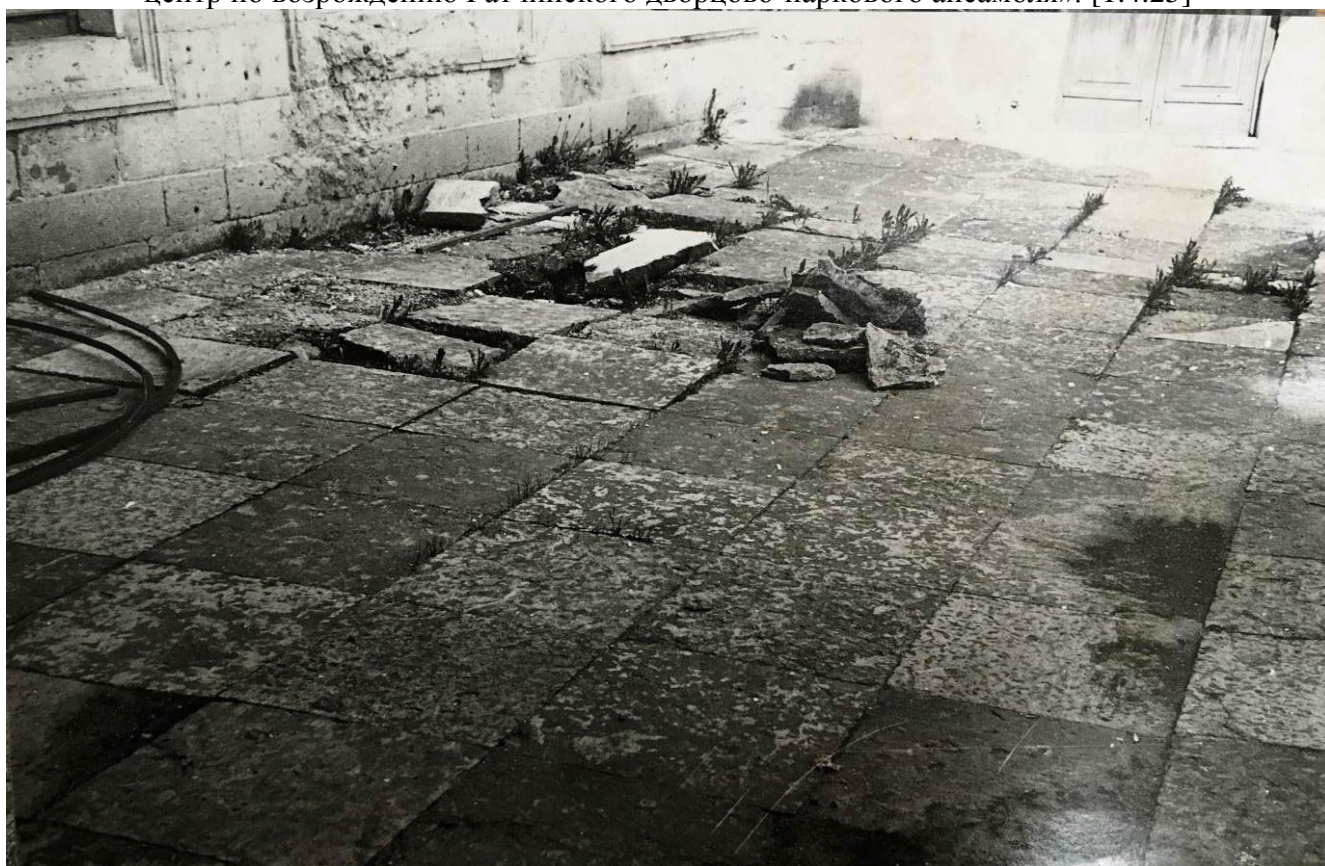
Илл. 122 Фото 1992 г. Провалы, вспучивания и деформации плит покрытия площадки, их утрата. Прорастание травы в швах. ГМЗ «Гатчина». № 1080. Собственный сад. Каменная терраса. Историческая справка. 1992. ТОО «Международный центр по возрождению Гатчинского дворцово-паркового ансамбля». [1.4.25]
