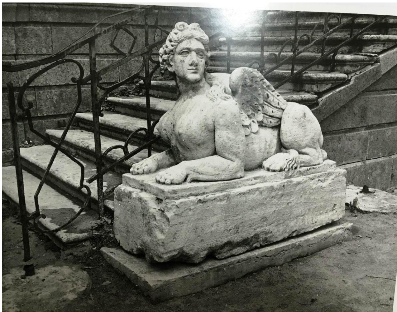
Илл. 109 Фото 1950 г. Правый марш. Состояние скульптуры после реставрационных работ с восполнением утрат головы. Отсутствует подпорная стойка ограждения и плиты покрытия площадки из известняка. ГМЗ «Гатчина». Нег. А-306 [1.4.39]
