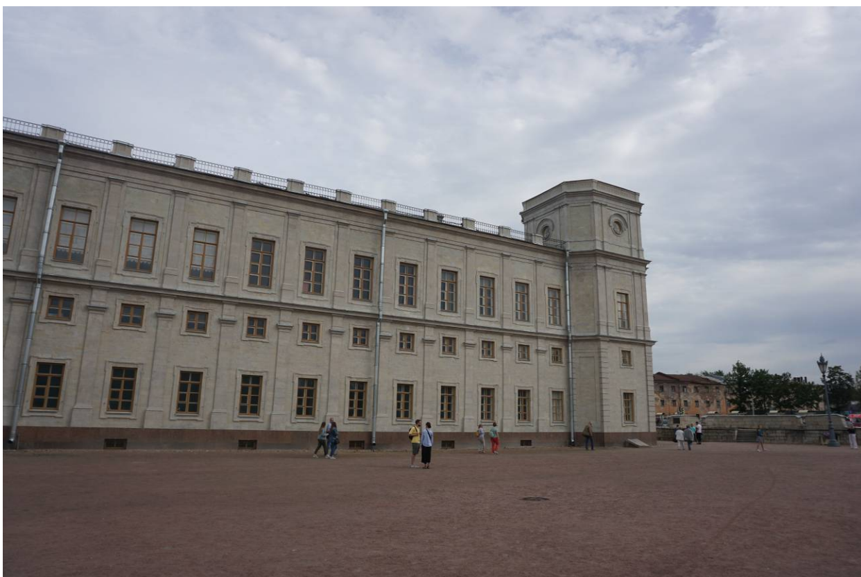
Фото 2. Фрагмент фасада объекта культурного наследия федерального значения «Гатчинский дворец (с Арсенальным и Кухонным каре)».
