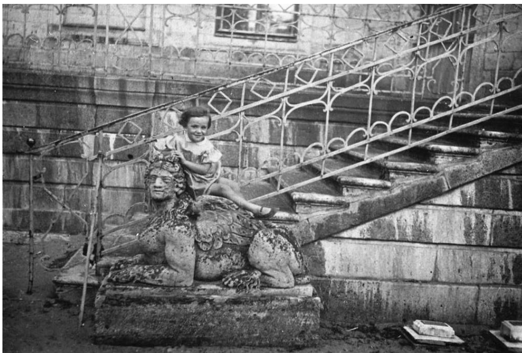
Илл. 95 Фото 1937 г. Выветривание камня скульптуры, частичная утрата красочного слоя ограждения. ГМЗ «Гатчина», Бр-1296. [1.4.39]
