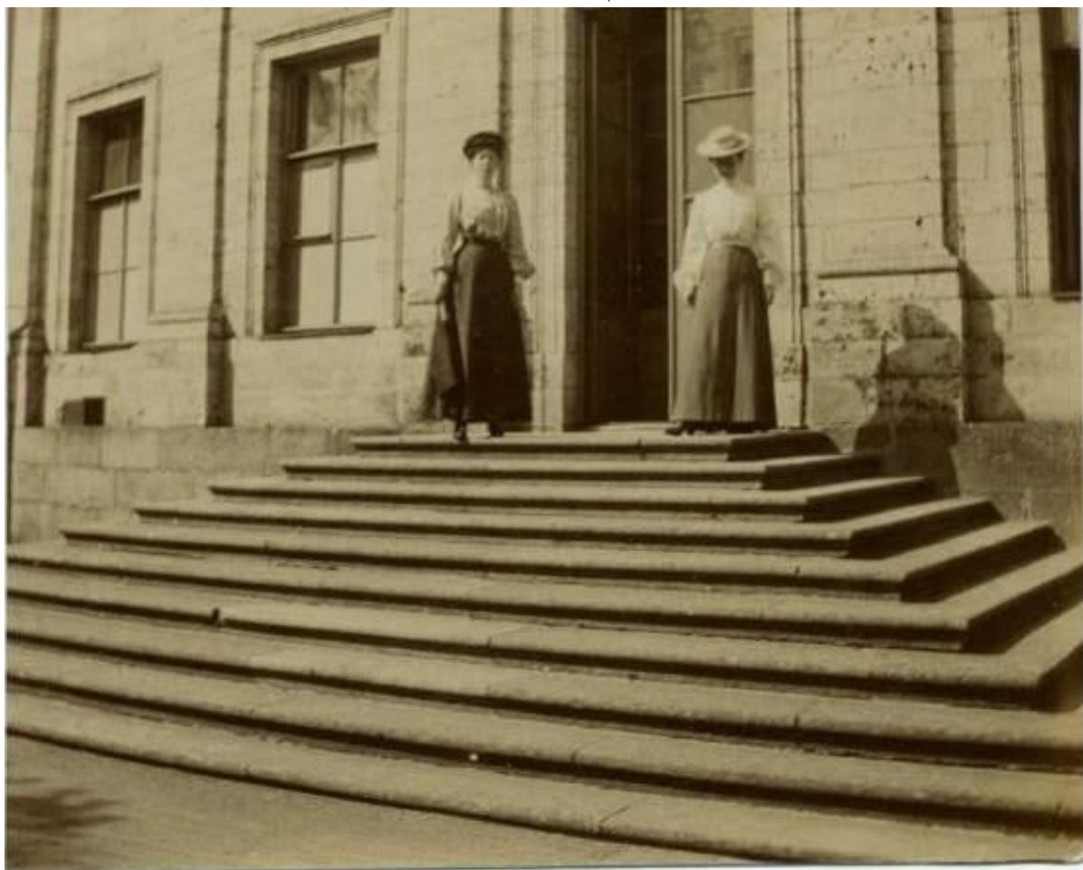
Илл. 143 Фото 1890-1900 гг. Наблюдаются сколы на ступенях, утраты в швах вдоль рядов ступеней. Отзыв.RU [Электронный ресурс] // сайт - URL: https://otzyv.ru/review/217932/ (дата обращения 01.11.2021) [3.8.]
