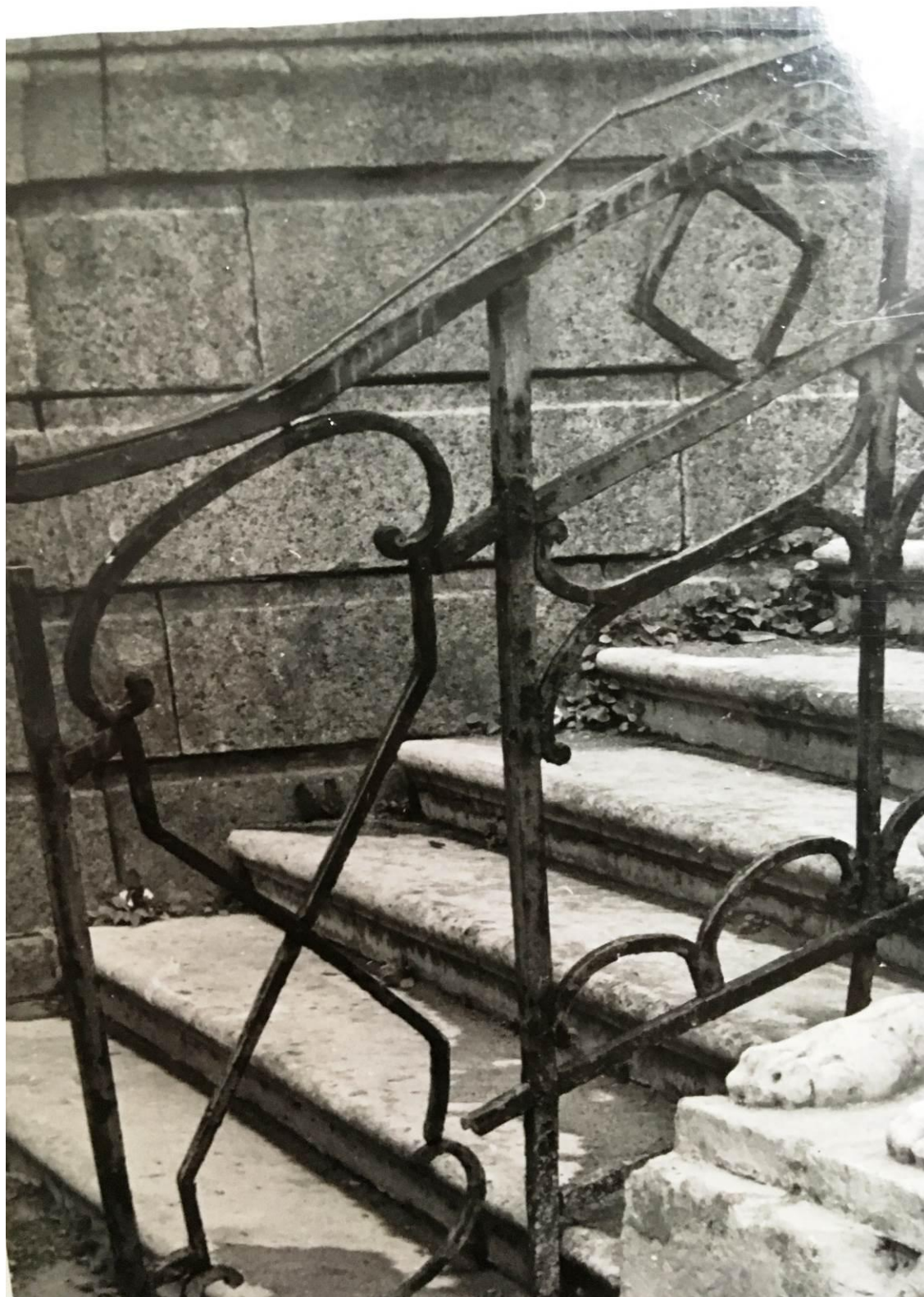
Илл. 110 Фото 1950 г. Правый марш. Фрагмент. Деформация ограждения. ГМЗ «Гатчина». Нег. А-306 [1.4.39]
