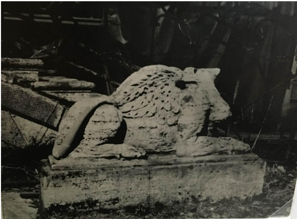
Илл. 103 Фото 1941-1943? гг. Фрагмент левого марша. Утрата головы скульптуры, утрата заделки зазора между тетивой и ступенями, выветривание швов облицовки марша. ГМЗ «Гатчина». Фототека. Папка с фотографиями «Собственный сад». [1.4.39]
