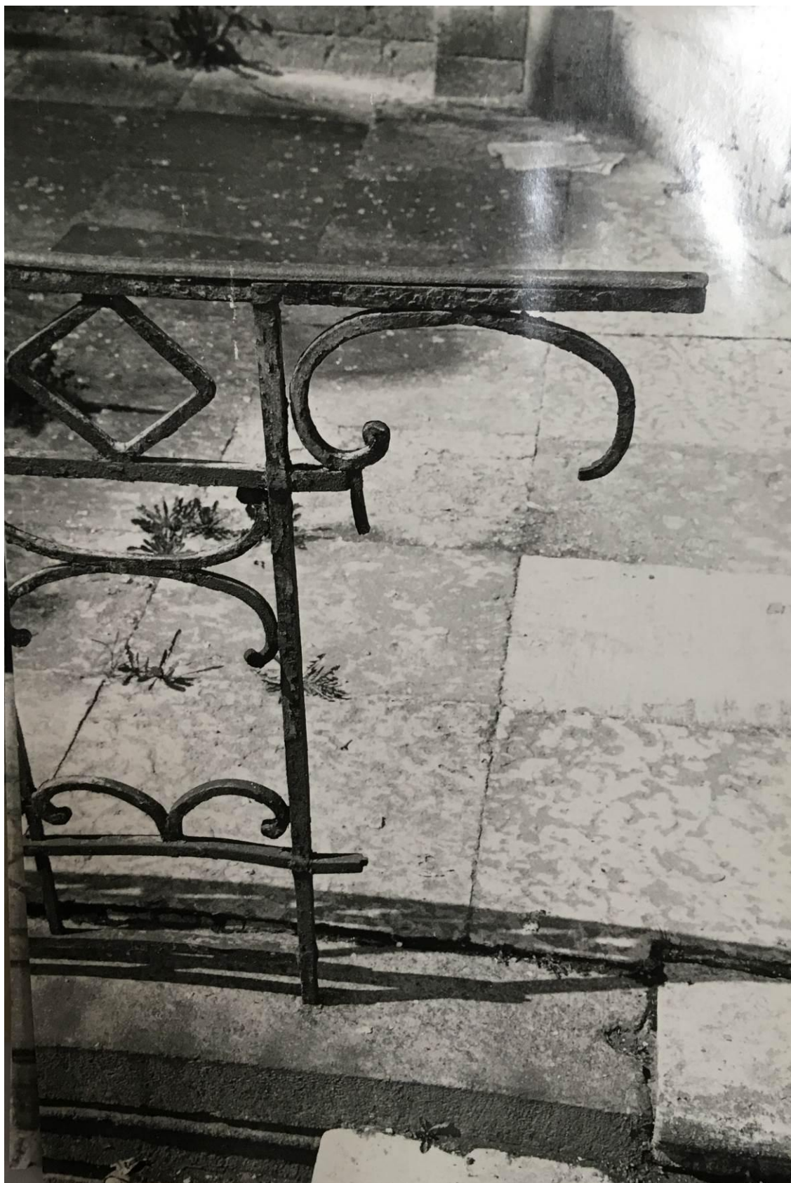
Илл. 125 Фото 1992 г. Утрата звена ограждения. Выветривание плит покрытия, прорастание травы в швах. ГМЗ «Гатчина». № 1080. Собственный сад. Каменная терраса. Историческая справка. 1992. ТОО «Международный центр по возрождению Гатчинского дворцово-паркового ансамбля». [1.4.25]
