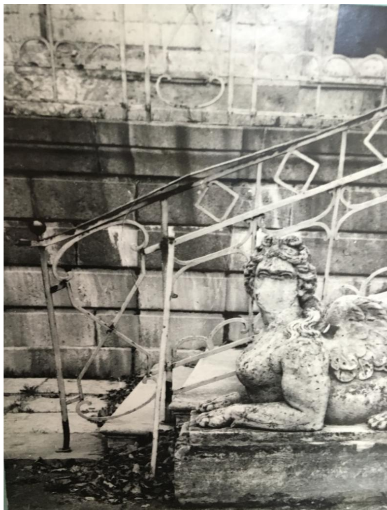
Илл. 102 Фото 1945 г. Фрагмент правого марша. Утрата части лица скульптуры, деформация ограждения. ГМЗ «Гатчина». Фототека. Папка с фотографиями «Собственный сад». [1.4.39]
