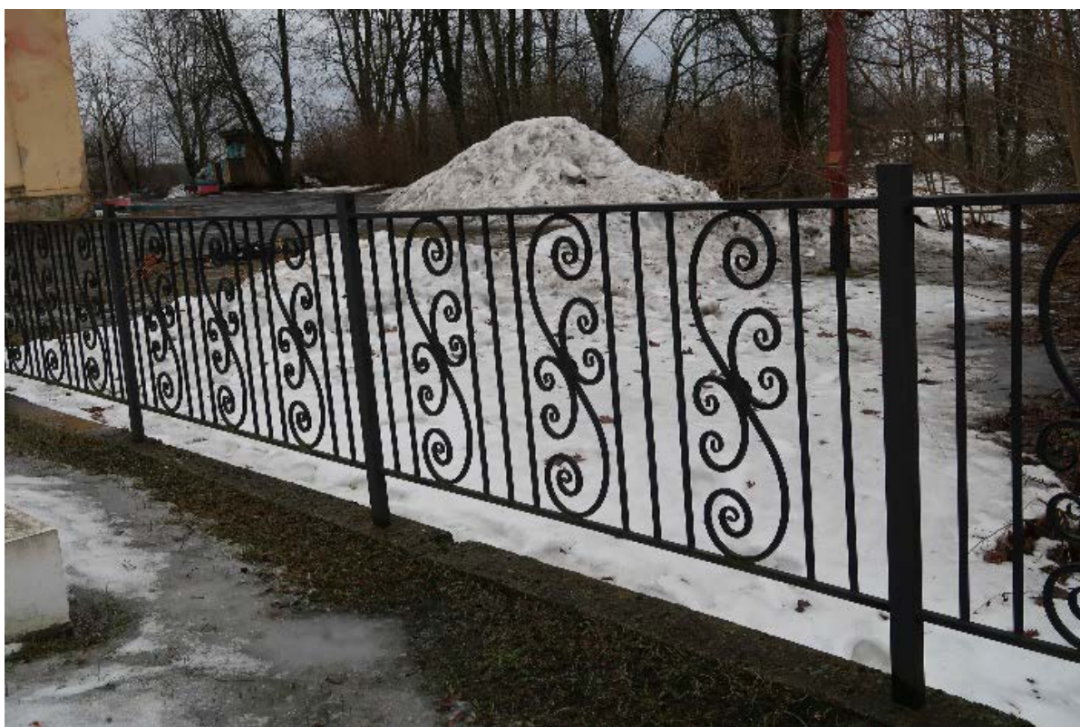
Илл. 8. Металлическое ограждение
