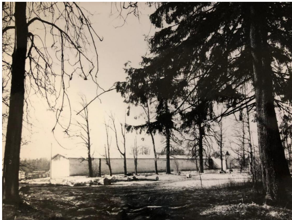
24. Парк усадьбы Рукавишникова. Строение на территории парка. Вид на северо-запад. 1990 г. Материалы фотофиксации проекта реставрации и приспособления усадебного дома, выполненного по заказу Дирекции объединения музеев Ленинградской области. 1990 г. Шифр 013-5/1-1.
