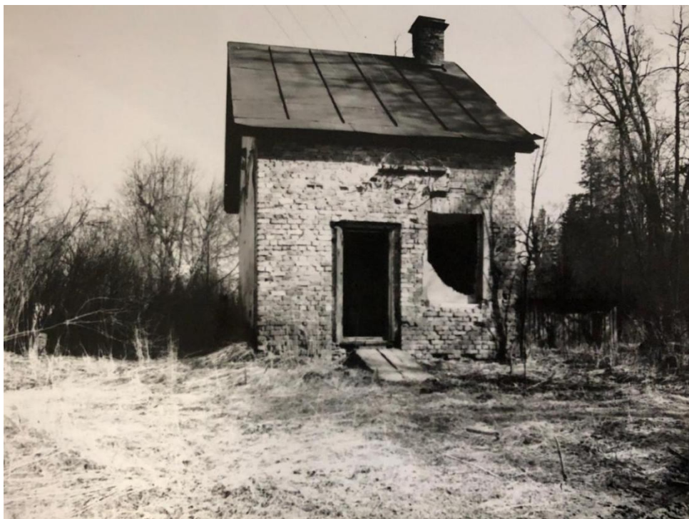
21. Парк усадьбы Рукавишникова. Строение на территории парка. Вид на северо-восток. 1990 г. Материалы фотофиксации проекта реставрации и приспособления усадебного дома, выполненного по заказу Дирекции объединения музеев Ленинградской области. 1990 г. Шифр 013-5/1-1.
