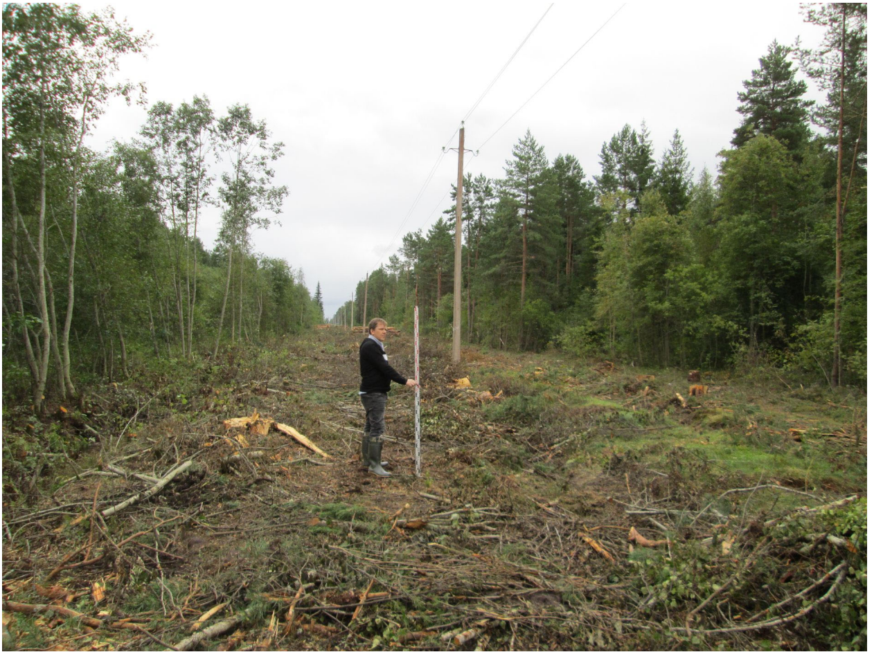
Илл. 57. Ленинградская обл., Волховский р-н, участок обследования. Точка фотофиксации 9. Вид с северо-запада. 25.08.2021 г. 25.08.2021.
