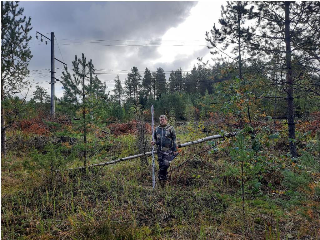
Рис. 44. Ленинградская обл., Лодейнопольский р-н, «Газопровод межпоселковый пос. Янега - дер. Харевщина - г.п. Свирьстрой Лодейнопольского района Ленинградской области». Точка фотофиксации 10. Вид с СЗ.
