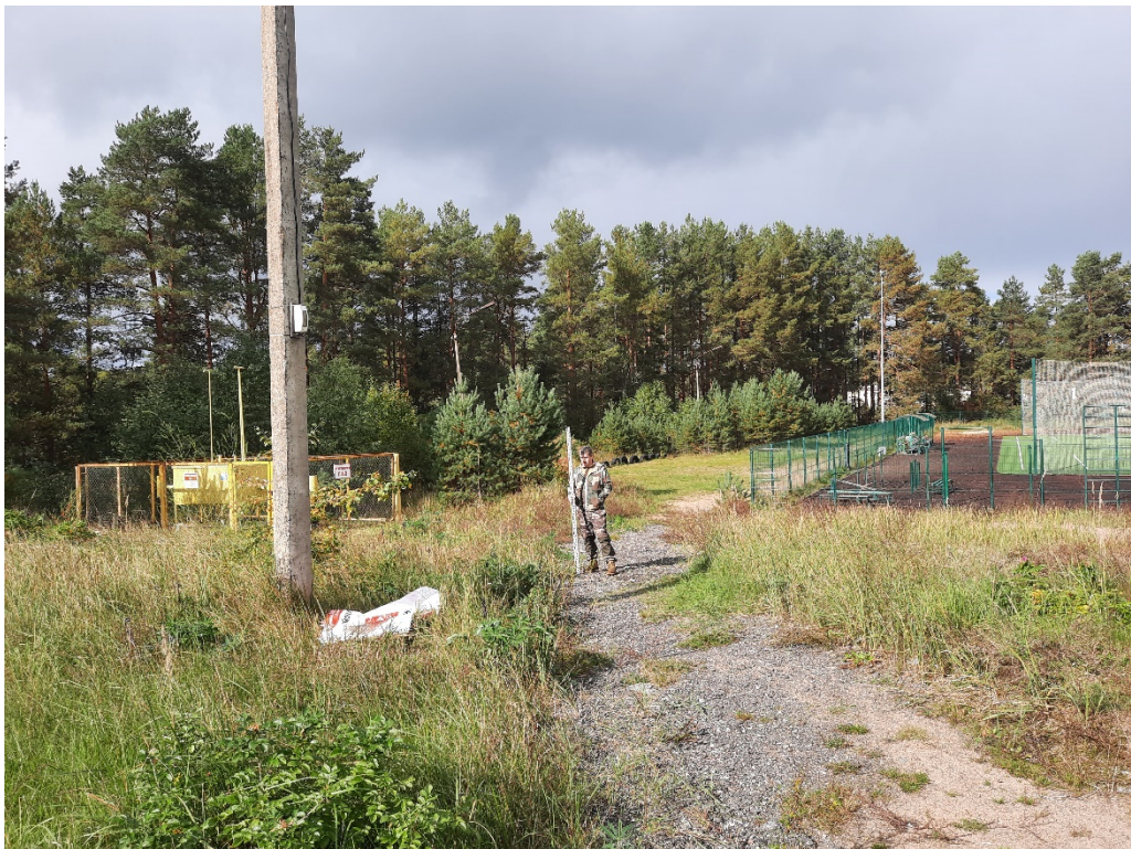
Рис. 53. Ленинградская обл., Лодейнопольский р-н, «Газопровод межпоселковый пос. Янега - дер. Харевщина - г.п. Свирьстрой Лодейнопольского района Ленинградской области». Точка фотофиксации 14_1. Вид с ЮВ.
