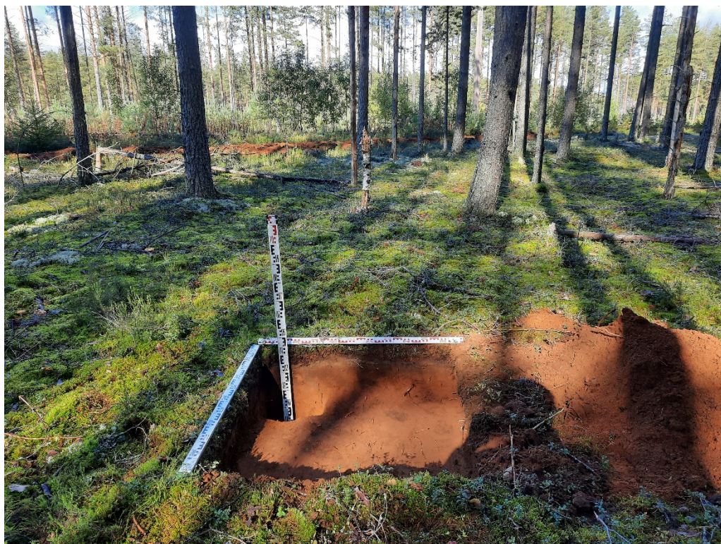
Рис. 58. Ленинградская обл., Лодейнополюский р-н, «Газопровод межпоселковый пос. Янега - дер. Харевщина - г.п. Свирьстрой Лодейнополюского района Ленинградской области». Шурф 3. Зачистка по материке. Вид с Ю.
