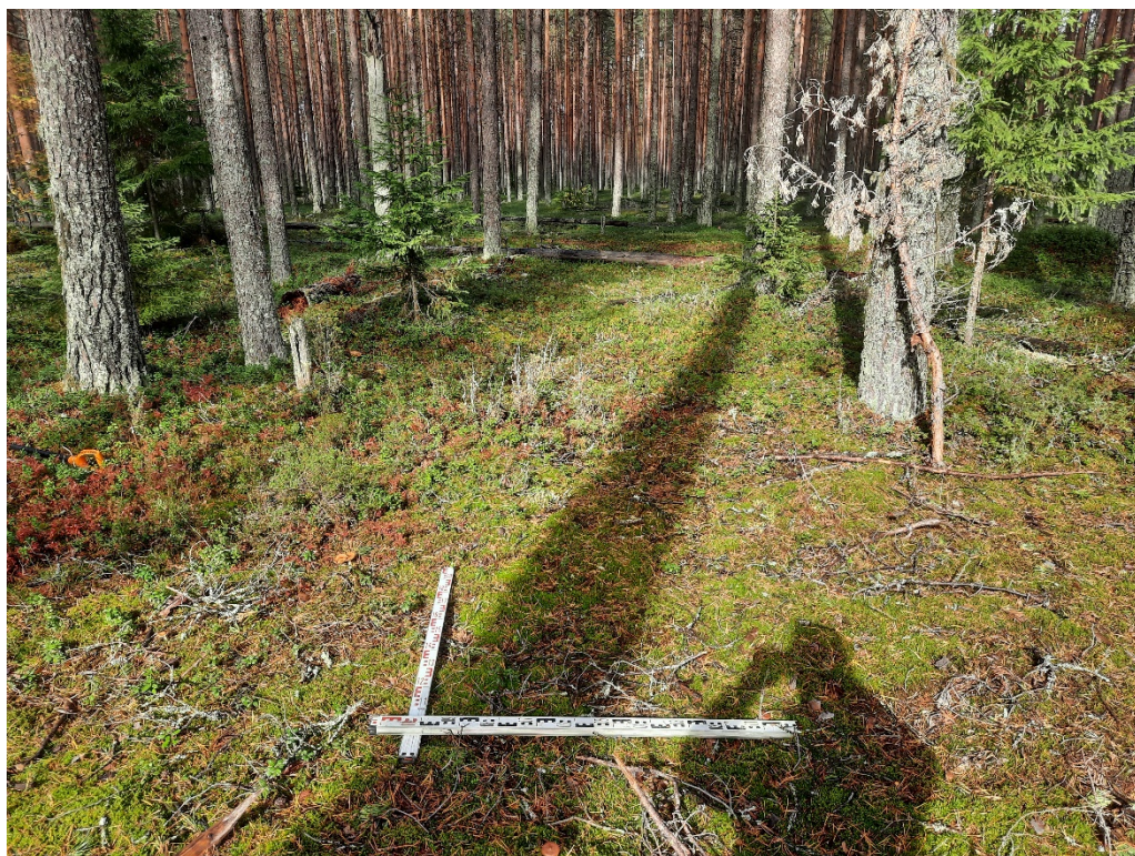
Рис. 38. Ленинградская обл., Лодейнопольский р-н, «Газопровод межпоселковый пос. Янега - дер. Харевщина - г.п. Свирьстрой Лодейнопольского района Ленинградской области». Шурф 2. До начала земляных работ. Вид с Ю.
