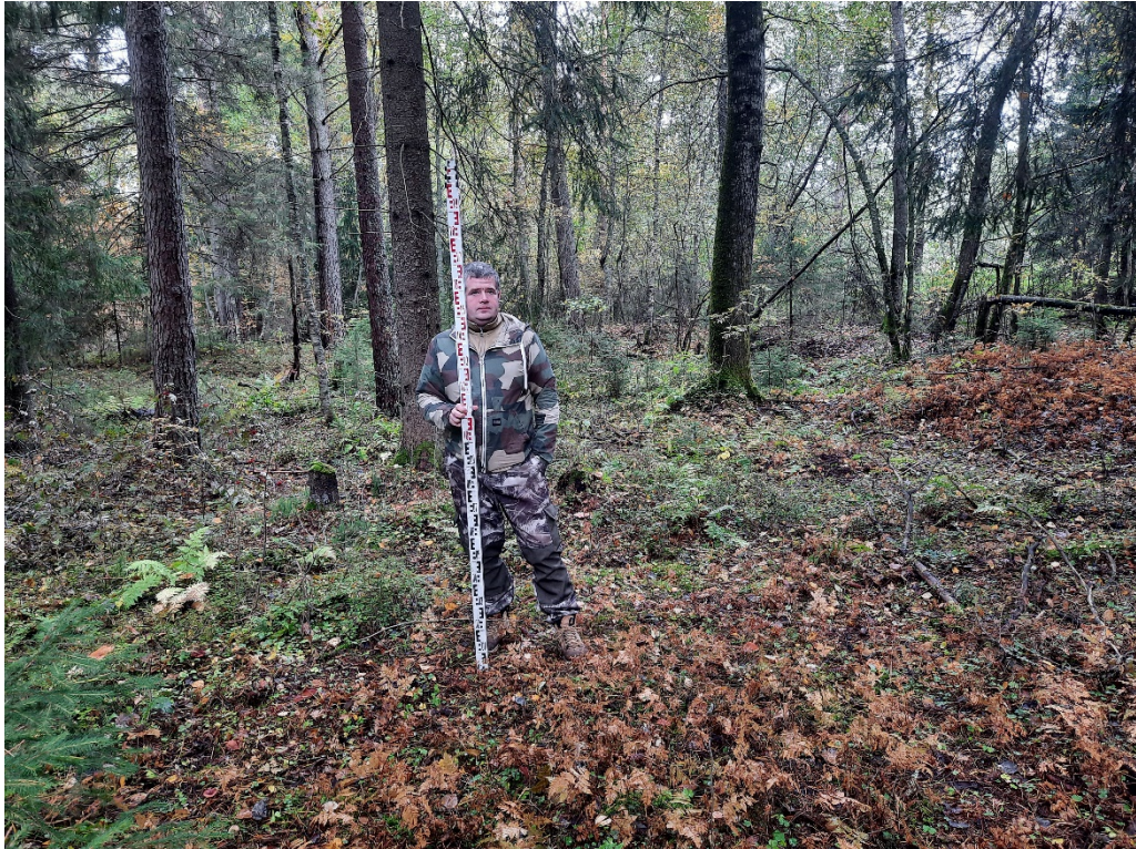
Рис. 20. Ленинградская обл., Лодейнопольский р-н, «Газопровод межпоселковый пос. Янега - дер. Харевщина - г.п. Свирьстрой Лодейнопольского района Ленинградской области». Шурф 1. Местоположение. Вид с Ю.
