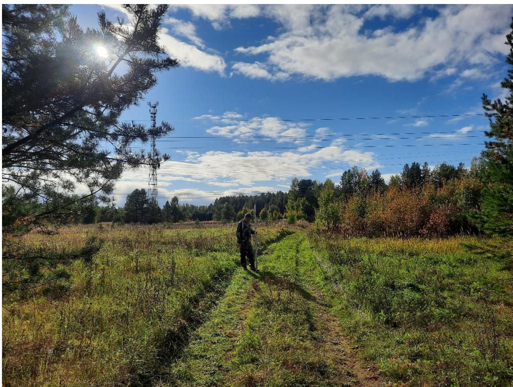
Рис. 87. Ленинградская обл., Лодейнопольский р-н, «Газопровод межпоселковый пос. Янега - дер. Харевщина - г.п. Свирьстрой Лодейнопольского района Ленинградской области». Точка фотофиксации 24. Вид с В.
