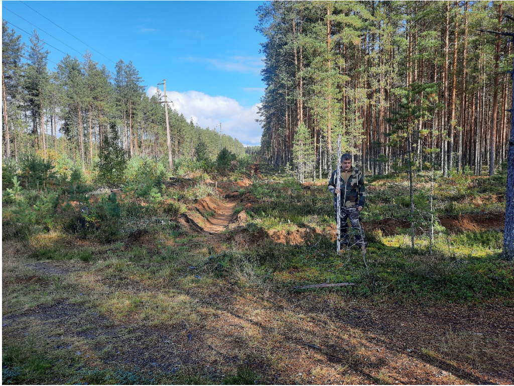
Рис. 54. Ленинградская обл., Лодейнопольский р-н, «Газопровод межпоселковый пос. Янега - дер. Харевщина - г.п. Свирьстрой Лодейнопольского района Ленинградской области». Точка фотофиксации 15. Вид с ЮЗ.
