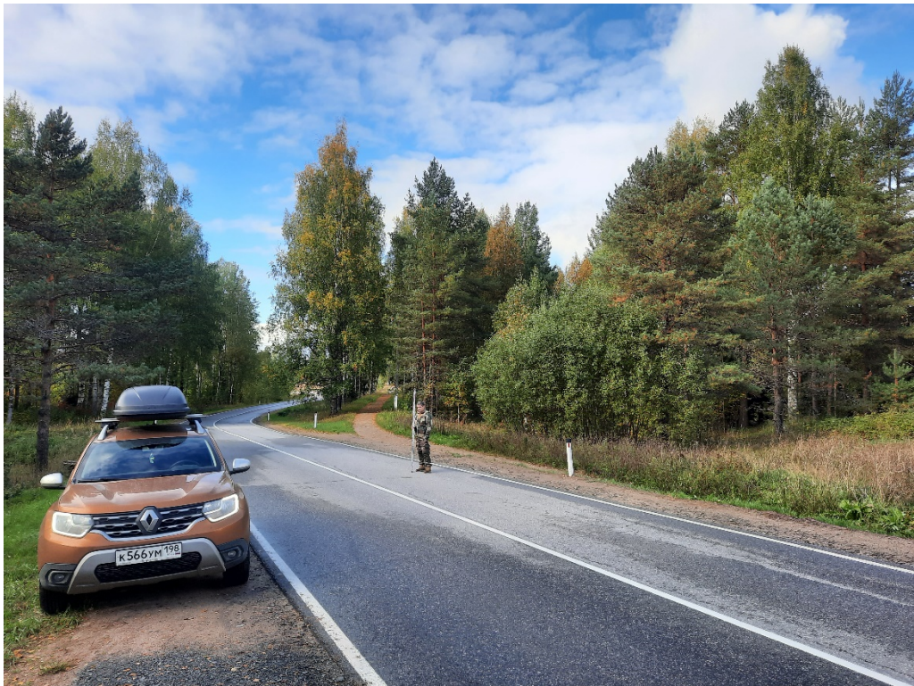
Рис. 98. Ленинградская обл., Лодейнопольский р-н, «Газопровод межпоселковый пос. Янега - дер. Харевщина - г.п. Свирьстрой Лодейнопольского района Ленинградской области». Точка фотофиксации 30. Вид с С.
