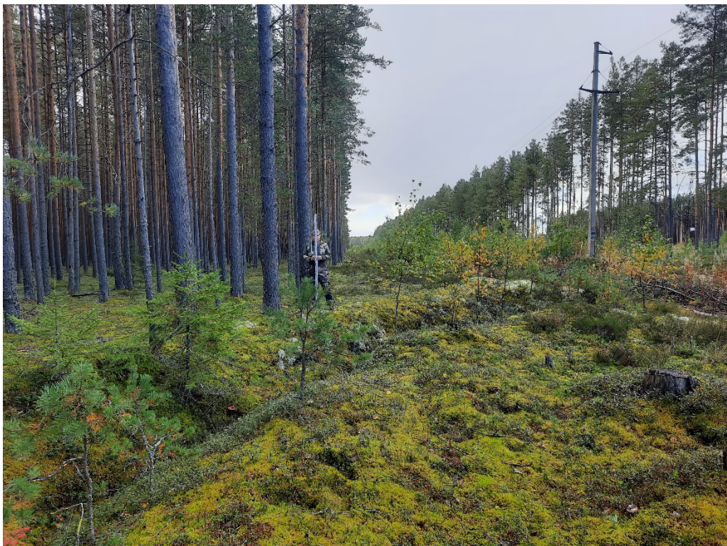
Рис. 29. Ленинградская обл., Лодейнополюский р-н, «Газопровод межпоселковый пос. Янега - дер. Харевщина - г.п. Свирьстрой Лодейнополюского района Ленинградской области». Точка фотофиксации 5. Вид с СВ.
