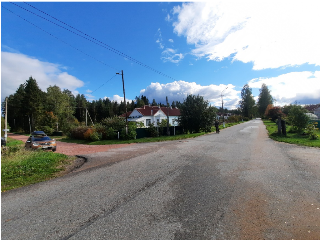
Рис. 109. Ленинградская обл., Лодейнопольский р-н, «Газопровод межпоселковый пос. Янега - дер. Харевщина - г.п. Свирьстрой Лодейнопольского района Ленинградской области». Точка фотофиксации 33. Вид с ССЗ.
