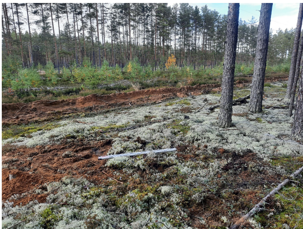
Рис. 67. Ленинградская обл., Лодейнопольский р-н, «Газопровод межпоселковый пос. Янега - дер. Харевщина - г.п. Свирьстрой Лодейнопольского района Ленинградской области». Шурф 4. Рекультивация. Вид с Ю.
