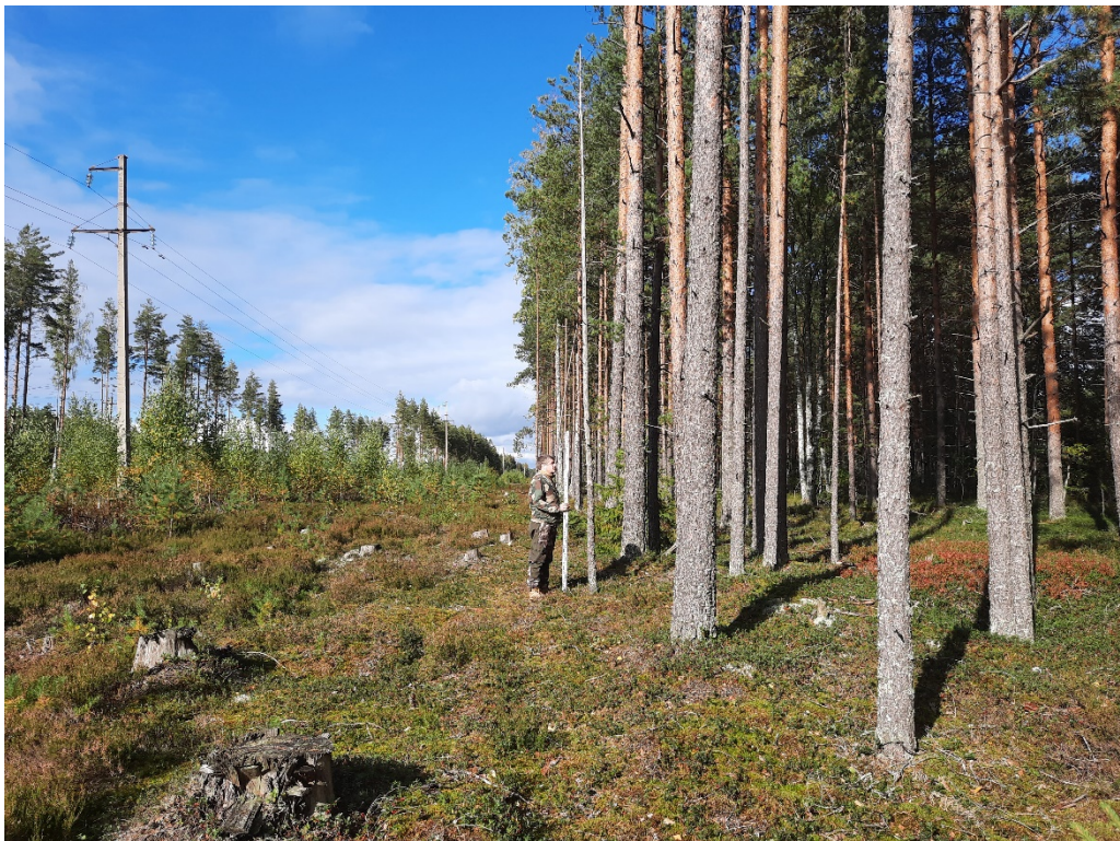
Рис. 75. Ленинградская обл., Лодейнопольский р-н, «Газопровод межпоселковый пос. Янега - дер. Харевщина - г.п. Свирьстрой Лодейнопольского района Ленинградской области». Точка фотофиксации 20. Вид с Ю.
