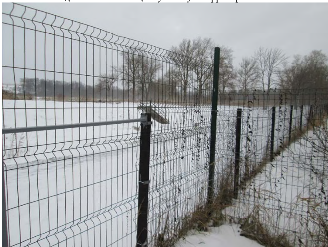
Илл. 28. Г. Санкт-Петербург, Петергоф (граница Лен. обл. и СПб у п. Санино). Точка фотофиксации Ф4. Вид с юга на территорию ОКН – Старопетергофский канал, ограда Лугового парка.
