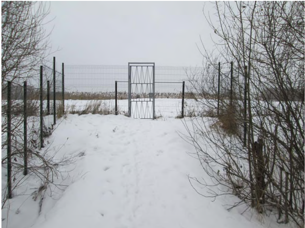
Илл.31. Г. Санкт-Петербург, Петергоф (граница Лен. обл. и СПб у п. Санино). Точка фотофиксации Ф4. Вид с юго-востока на территорию ОКН – Старопетергофский канал, ограда Лугового парка.
