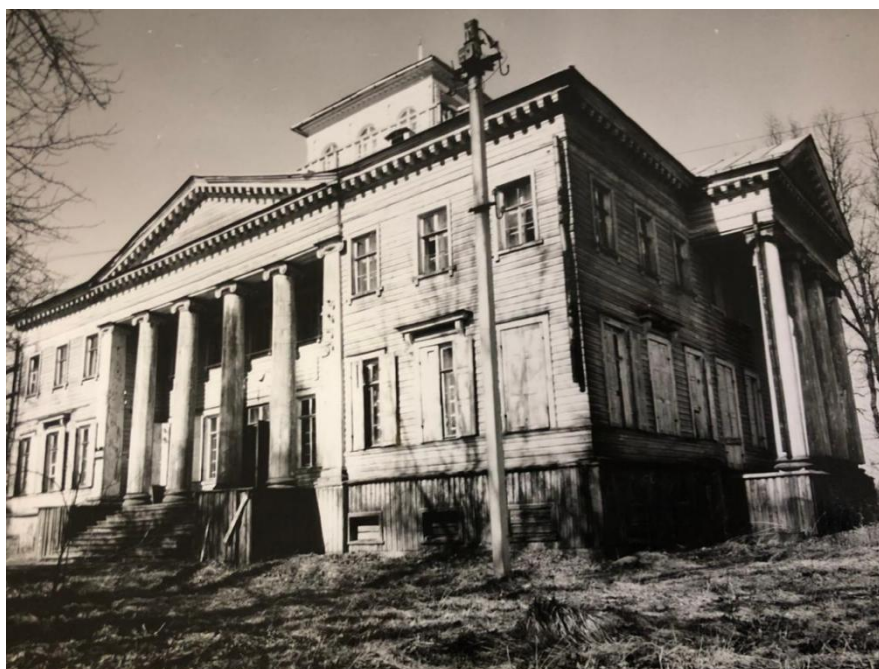
14. Усадебный дом Рукавишникова. Вид на северо-запад. 1990 г. Материалы фотофиксации проекта реставрации и приспособления усадебного дома, выполненного по заказу Дирекции объединения музеев Ленинградской области. 1990 г. Шифр 013-5/1-1.
