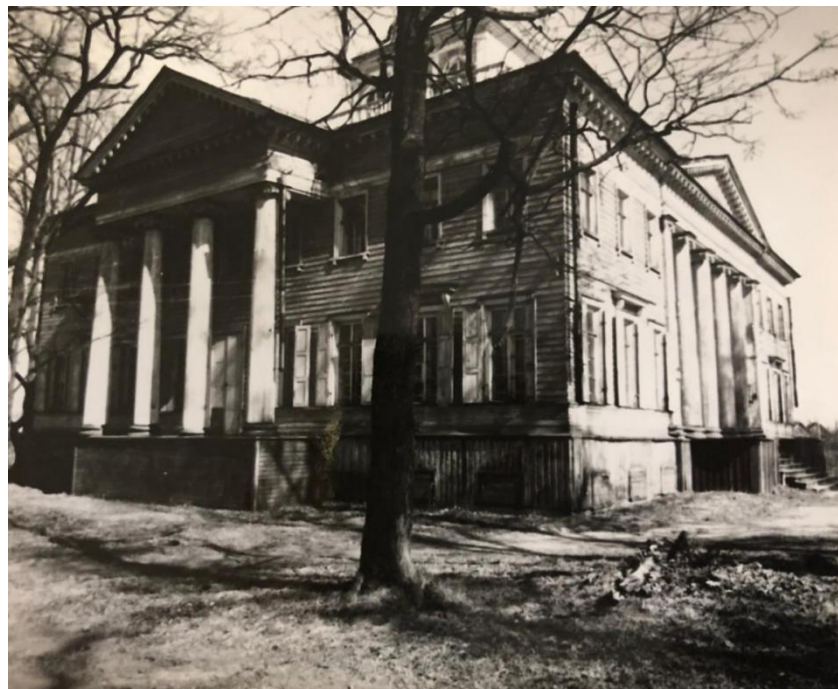
12. Усадебный дом Рукавишников. Вид на северо-восток. 1990 г. Материалы фотофиксации проекта реставрации и приспособления усадебного дома, выполненного по заказу Дирекции объединения музеев Ленинградской области. 1990 г. Шифр 013-5/1-1.
