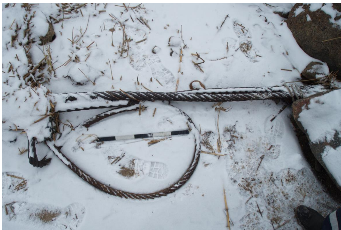
Илл. 32. Морской отгрузочный терминал. Участок МОТ. Стальной трос.
