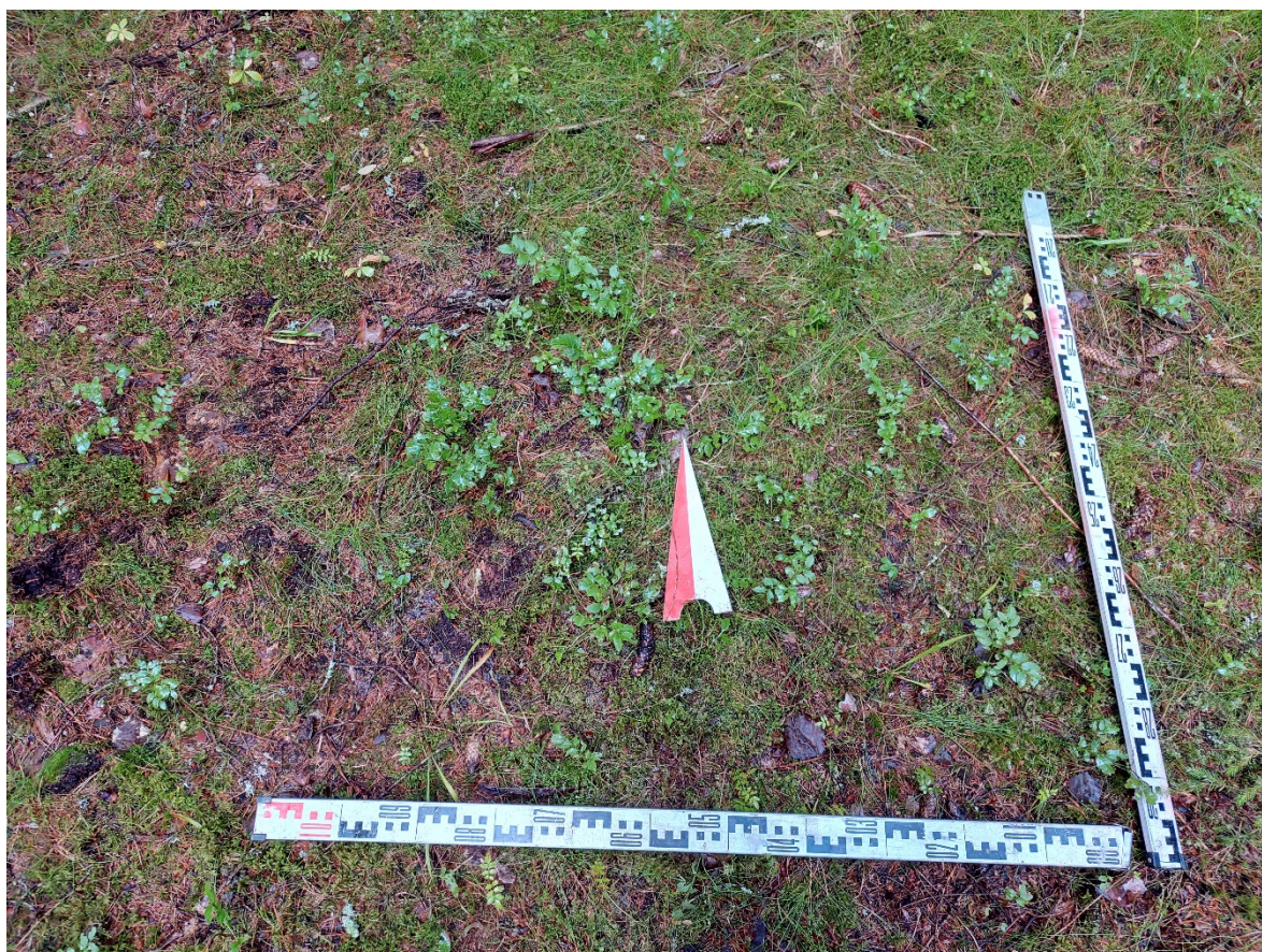
Рис. 67. Ленинградская обл., Всеволожский район – 2021 г. Шурф №5. До начала работ. Вид с Ю.
