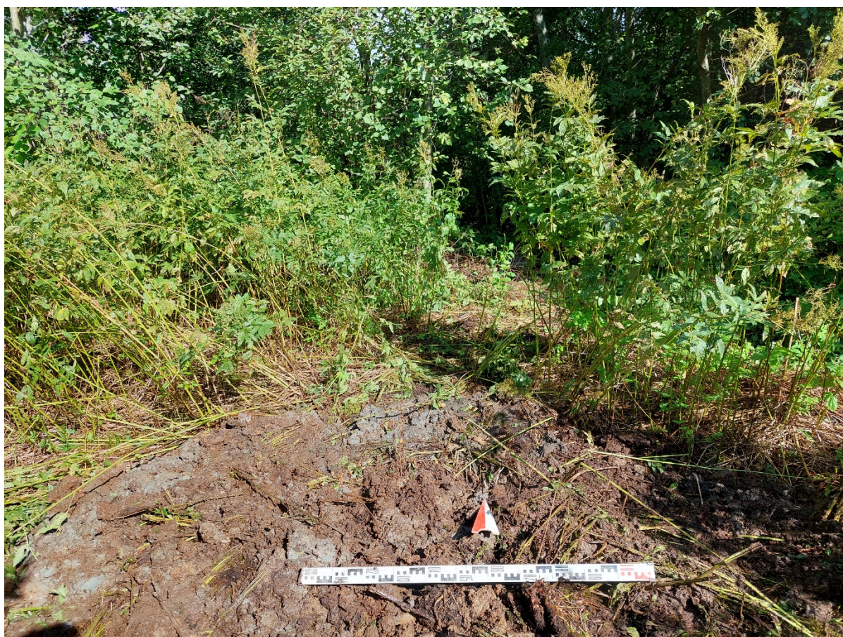
Рис. 47. Ленинградская обл., Всеволожский район – 2021 г. Шурф №1. Засыпка. Вид с Ю.
