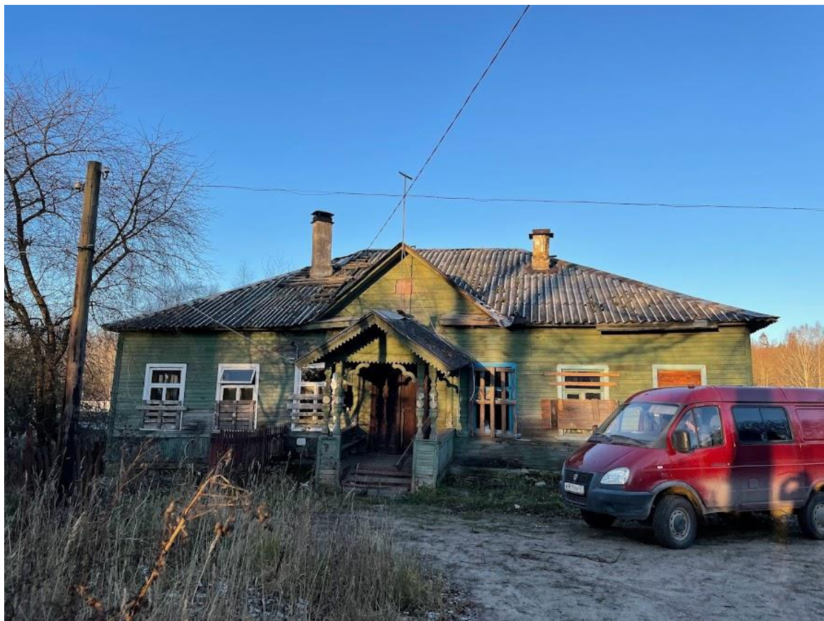
1. Южный фасад здания, выходящий на Колтушское шоссе
