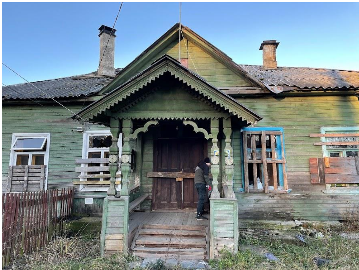
9. Крыльцо на южном фасаде
