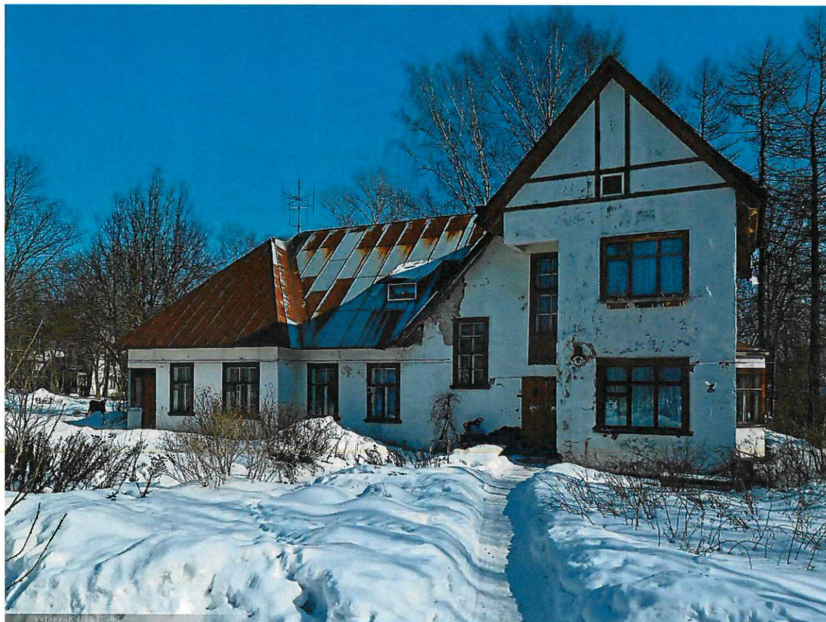
«Коттедж сотрудников научного городка» по адресу: Ленинградская область, Всеволожский район, с. Павлово, ул. Быкова, д.16
