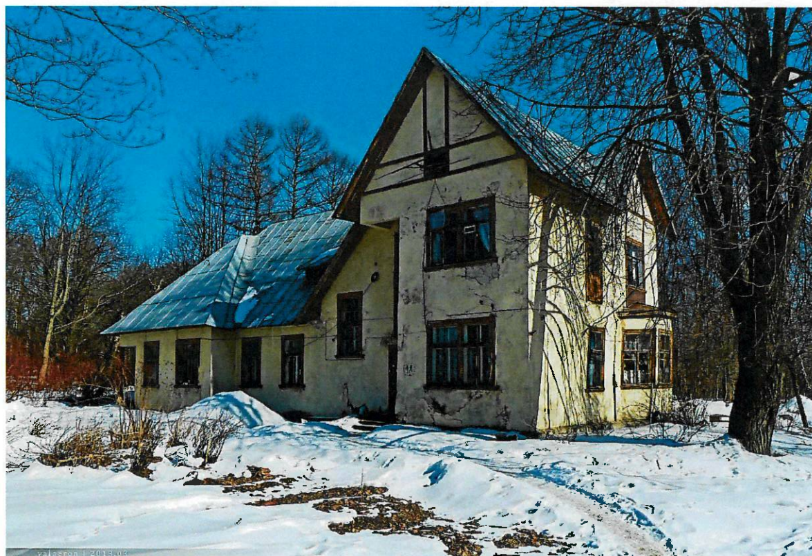
«Коттедж сотрудников научного городка» по адресу: Ленинградская область, Всеволожский район, с. Павлово, ул. Быкова, д.18
