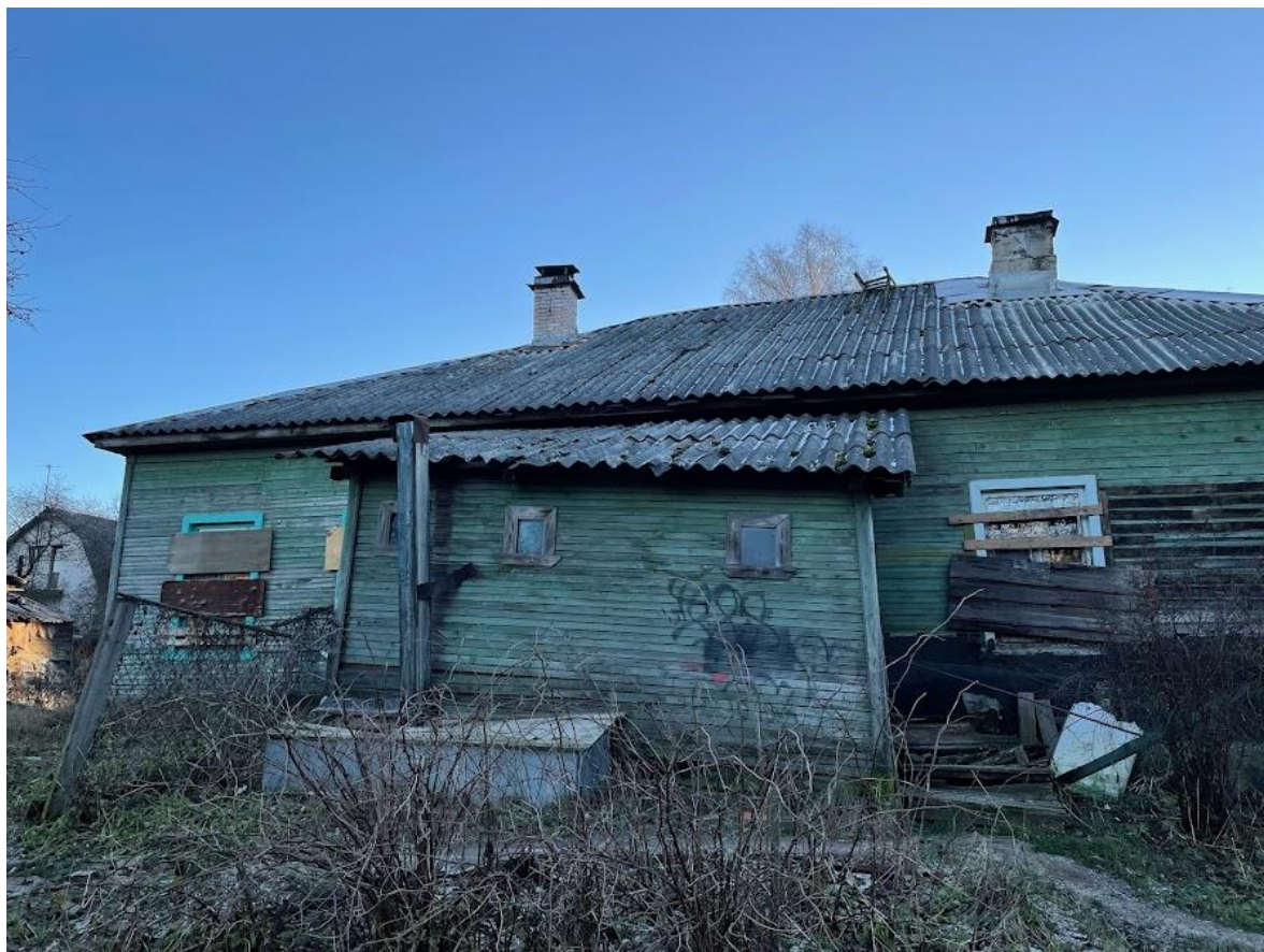
3. Фрагмент северного фасада
