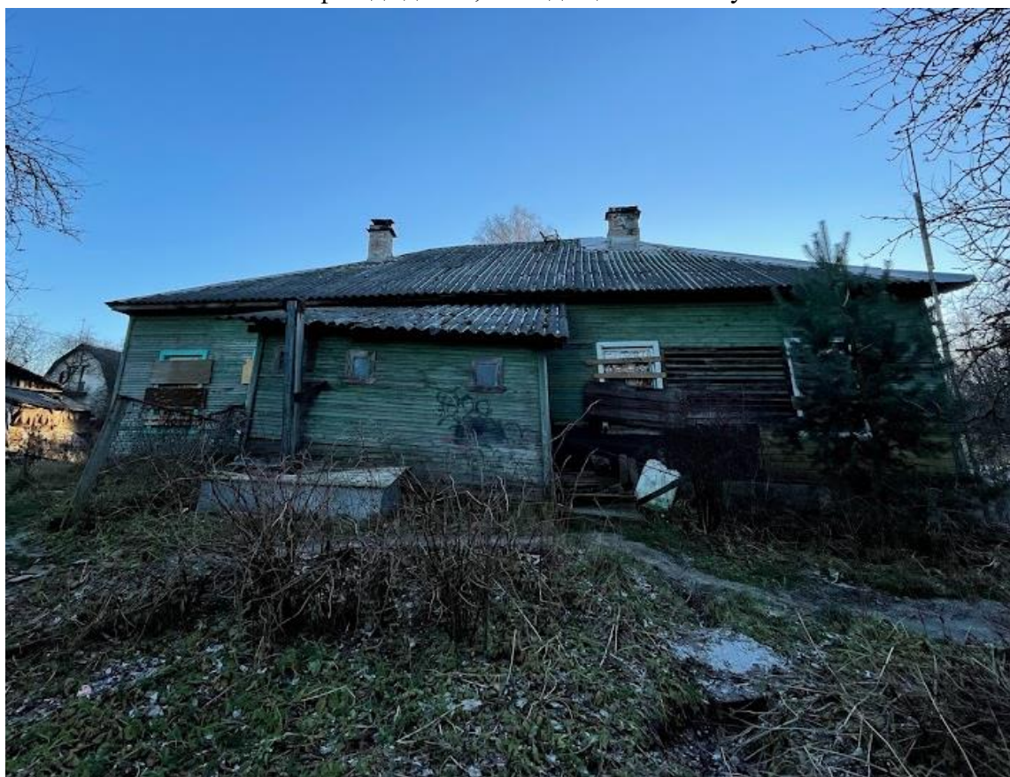
2. Северный фасад здания
