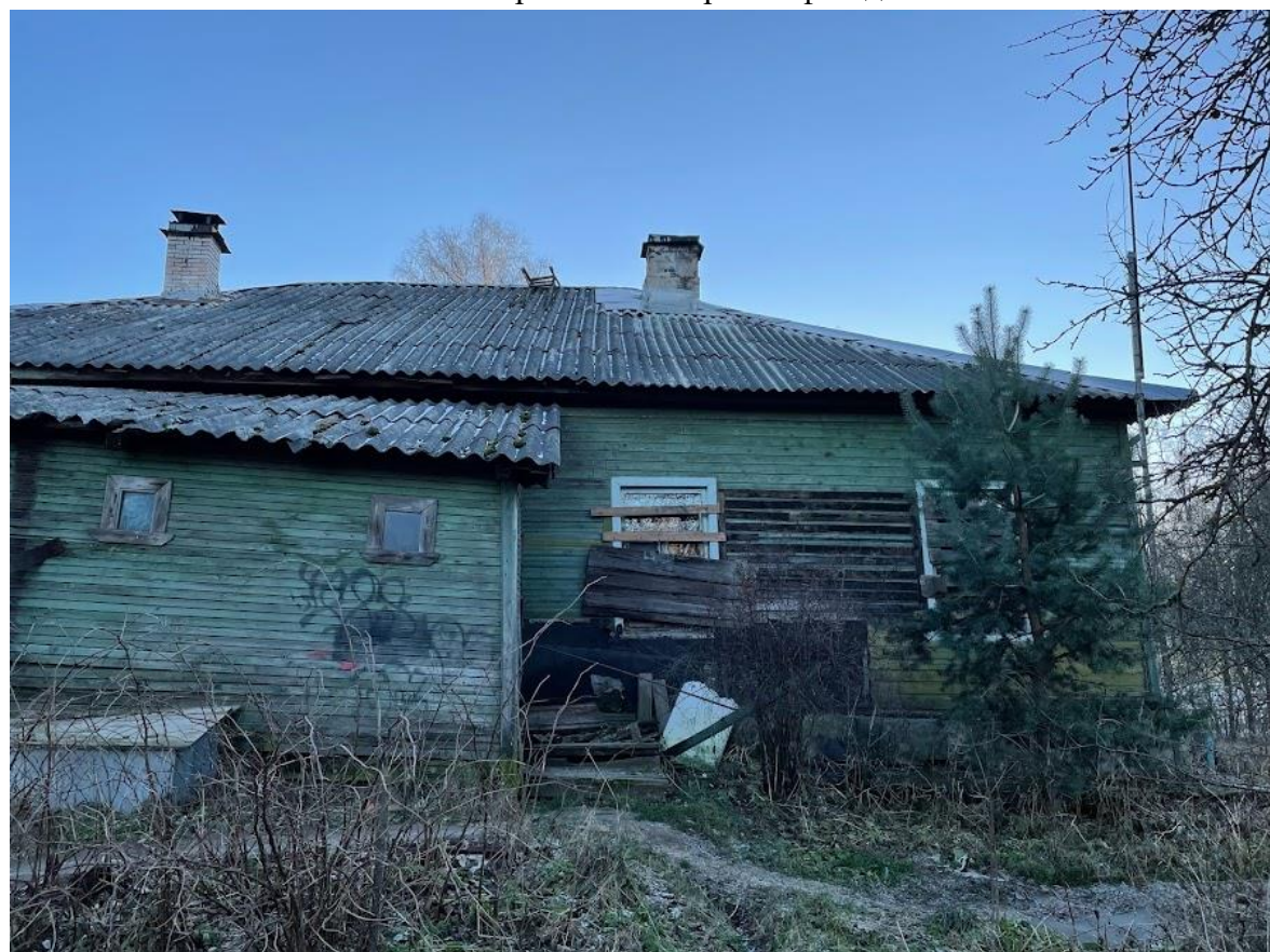
4. Фрагмент северного фасада
