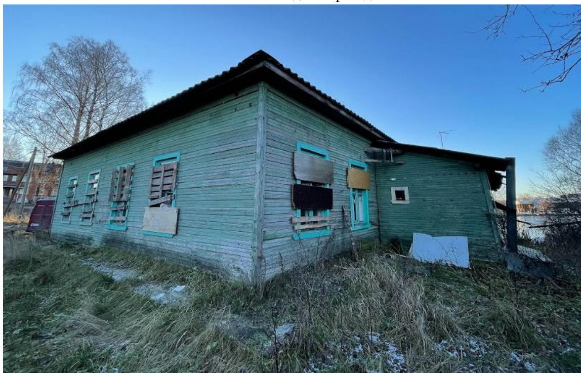
6. Северо-восточный угол здания
