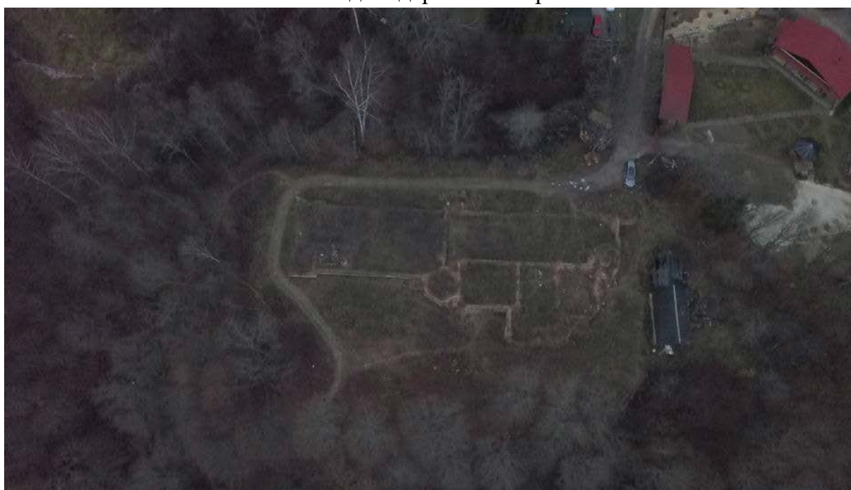
4. Вид фундамента дворца сверху
