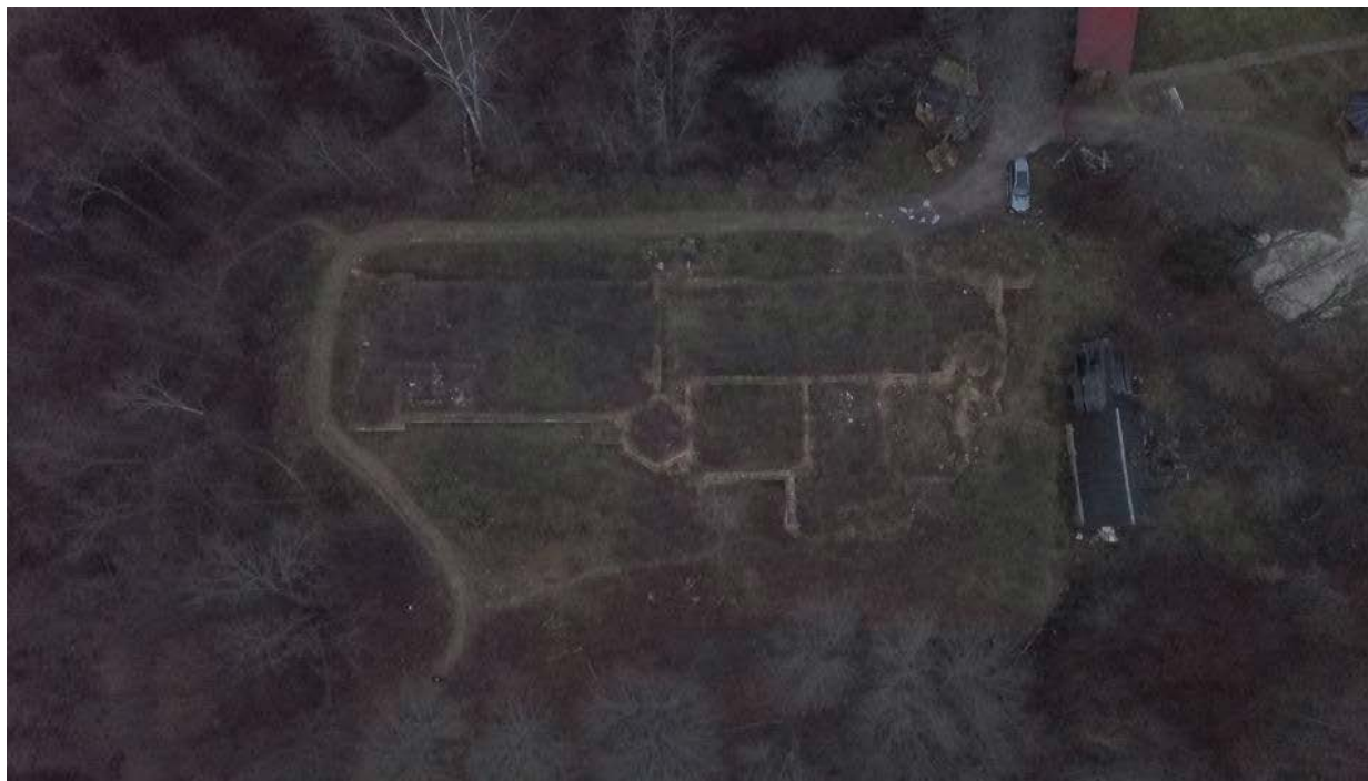
5. Вид фундамента дворца сверху
