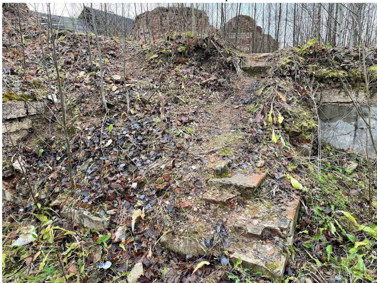
28. Ступени с северо-восточной стороны
