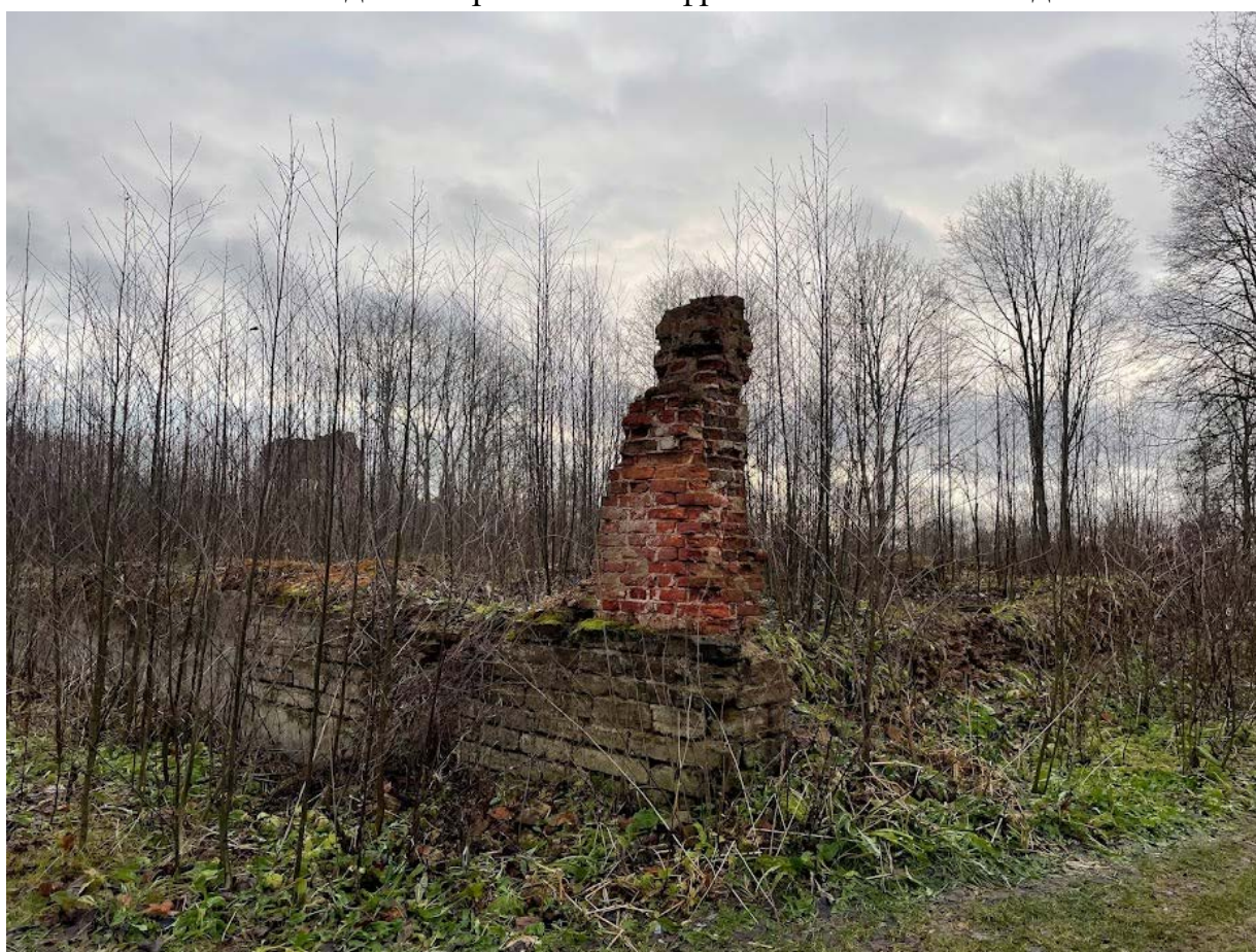
10. Вид на руины дворца с северо-запада
