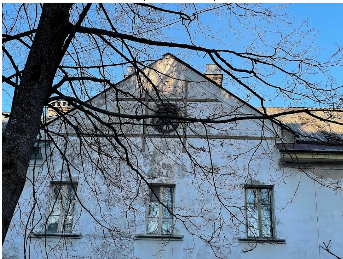
4. Щипец в левой части южного фасада
