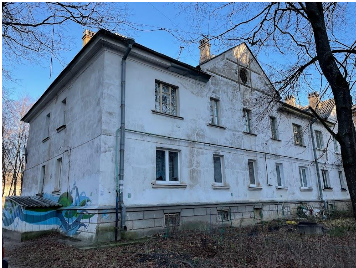
5. Вид с юго-запада
