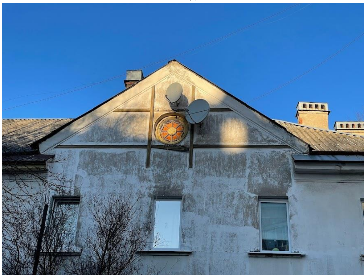
2. Шипец в правой части южного фасада
