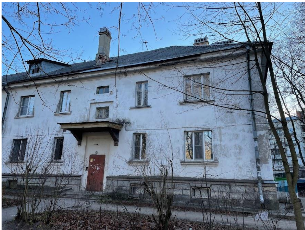
7. Фрагмент северного фасада
