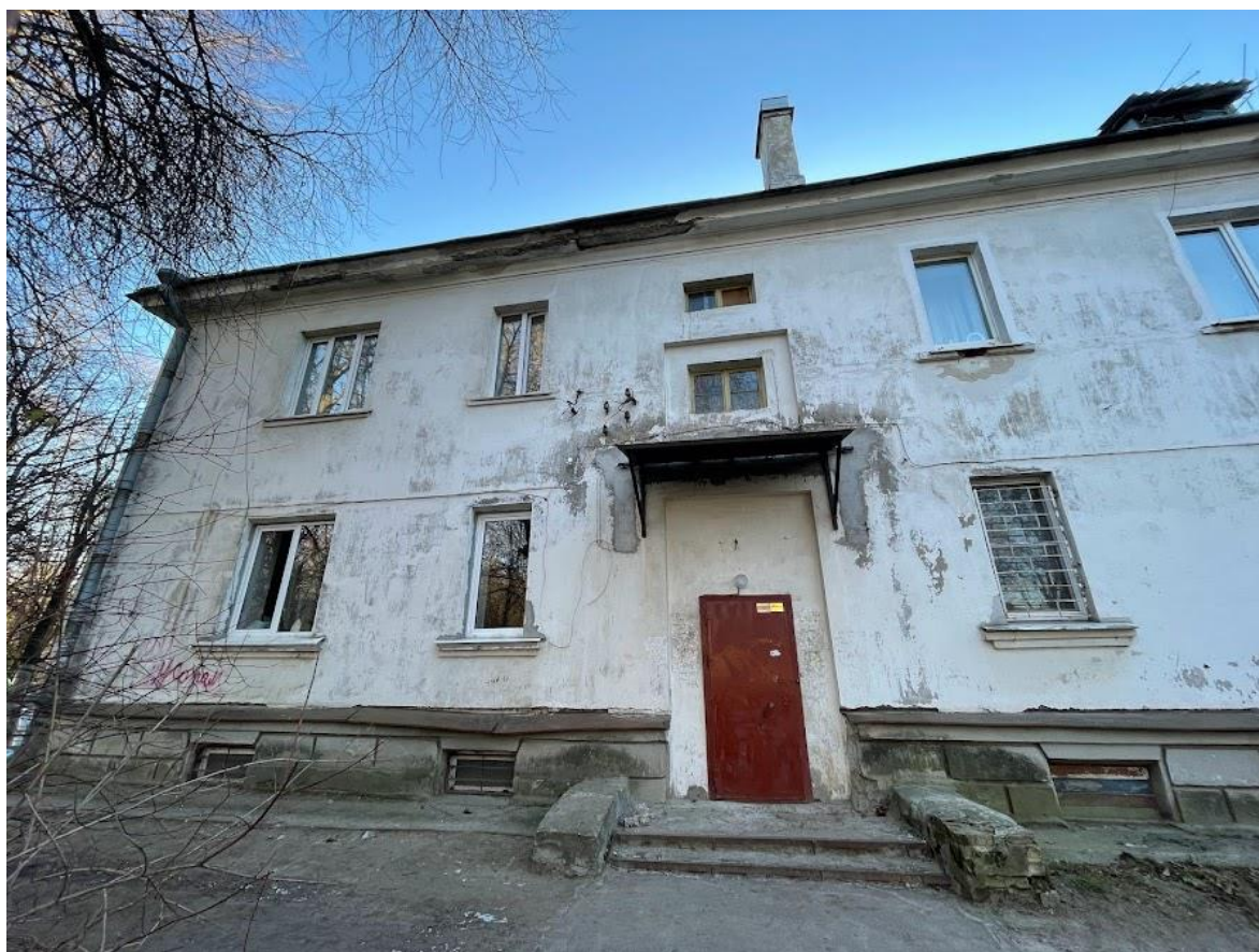
11. Фрагмент северного фасада
