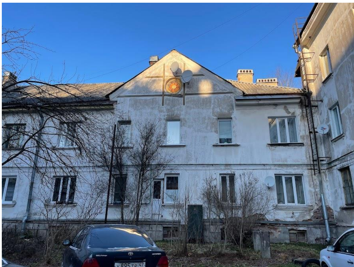
3. Фрагмент южного фасада
