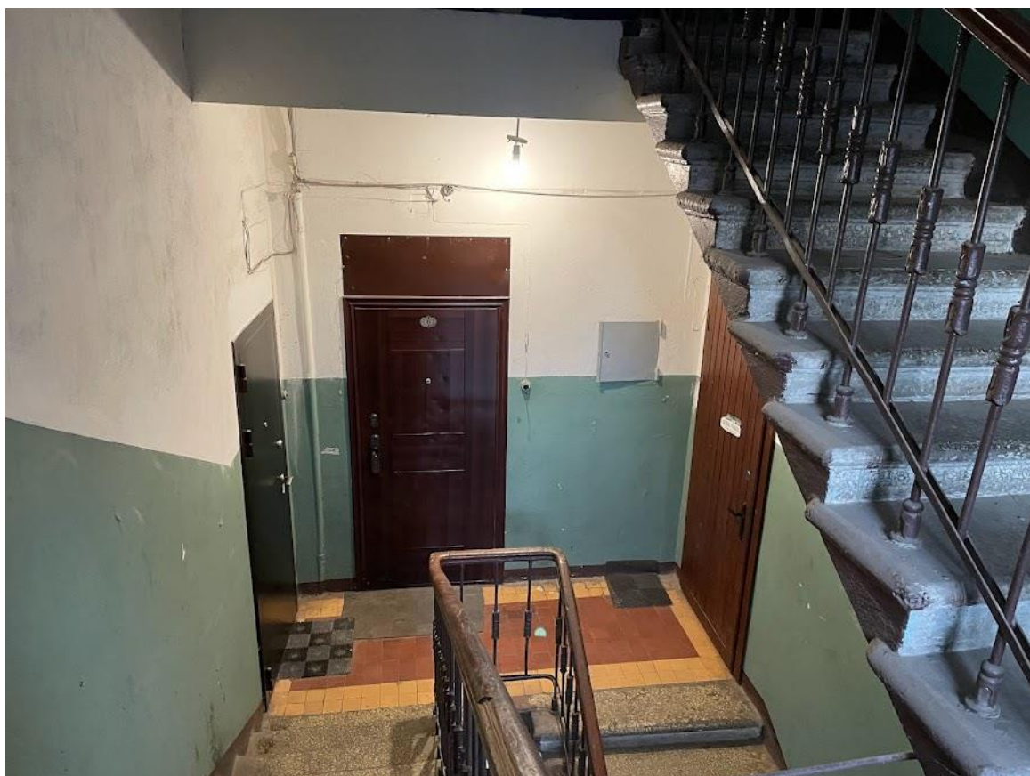
9. Лестничная клетка в уровне третьего этажа
