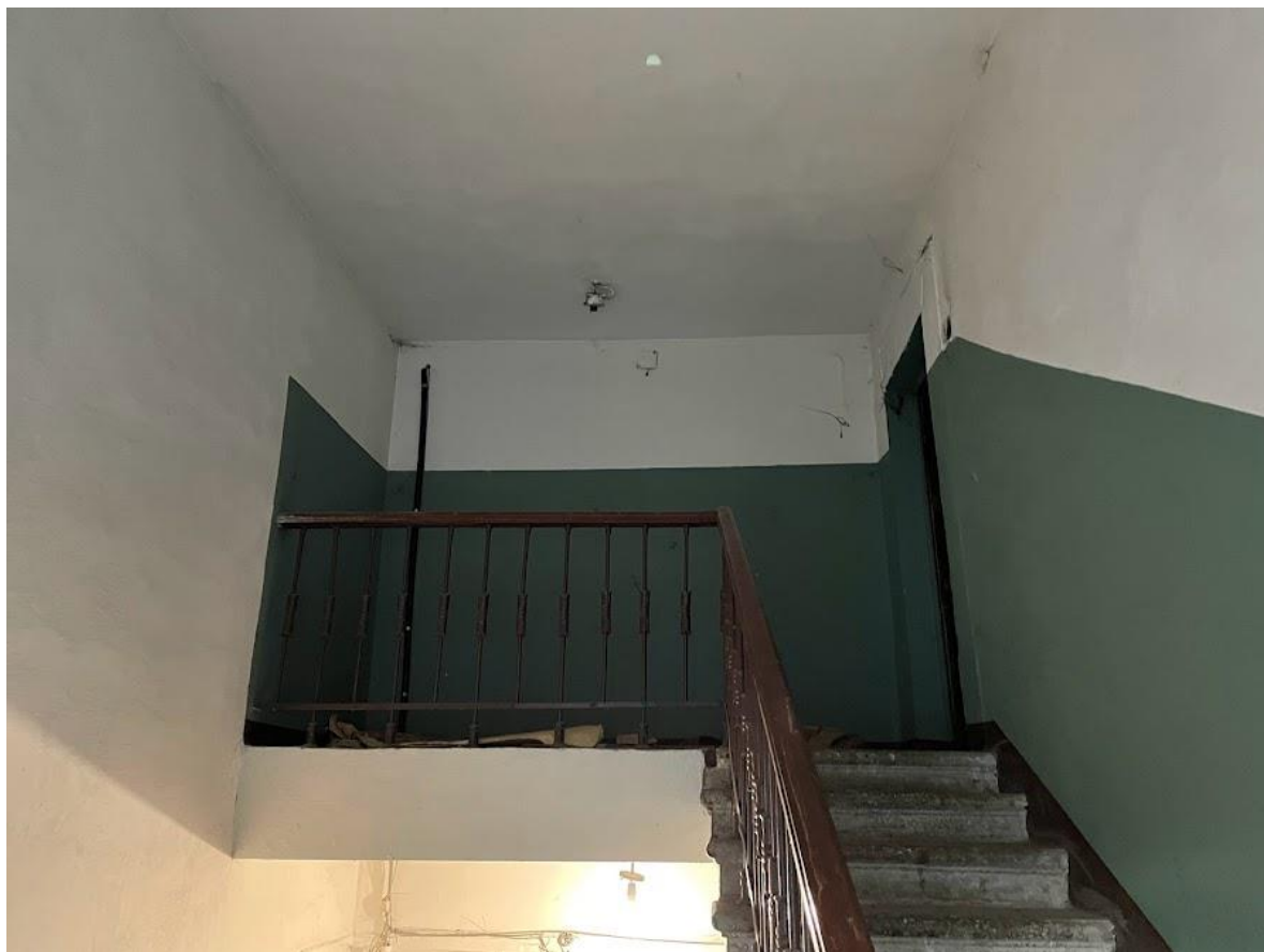
7. Лестничная клетка в уровне чердака
