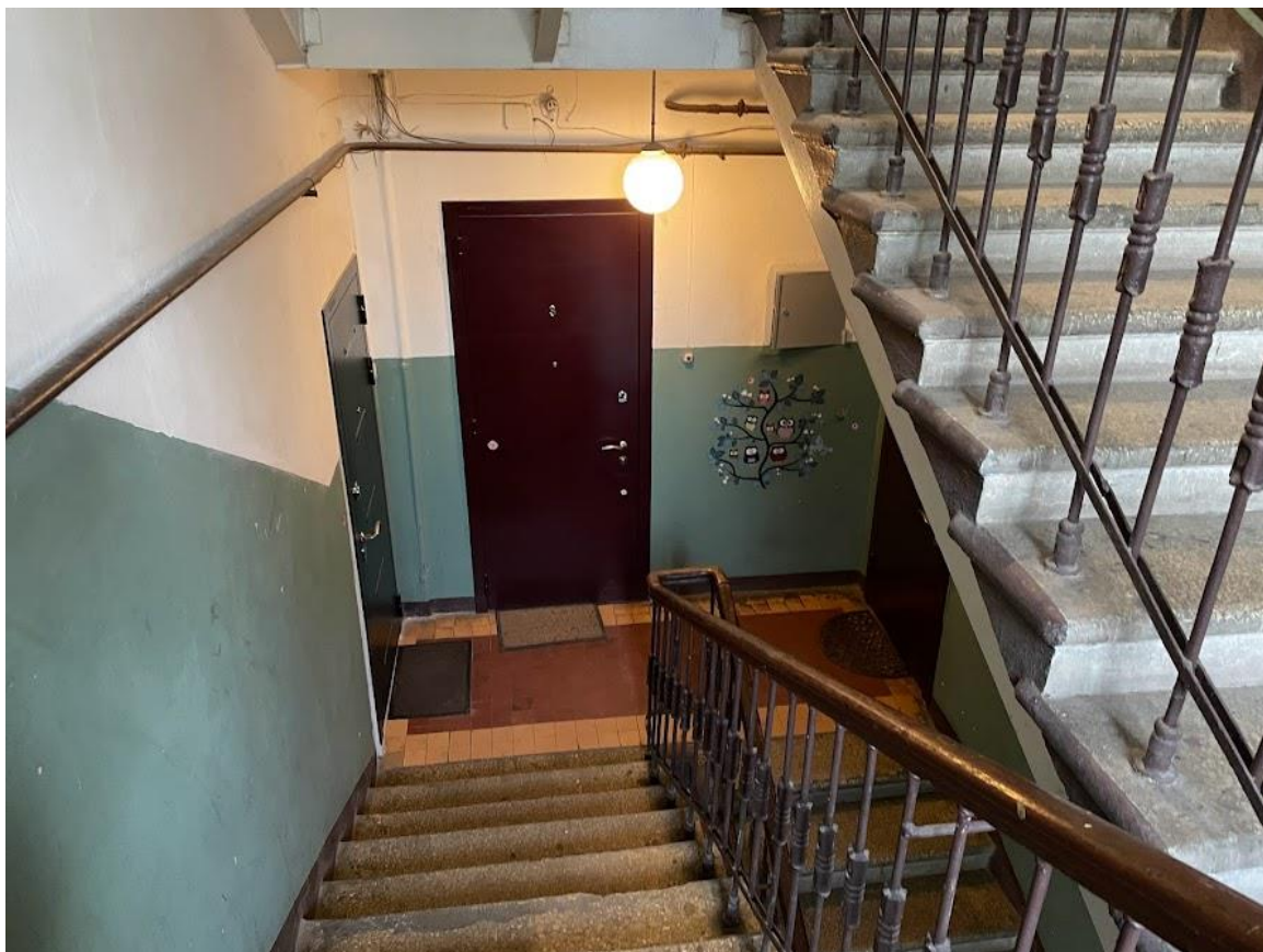
13. Лестничная клетка в уровне второго этажа
