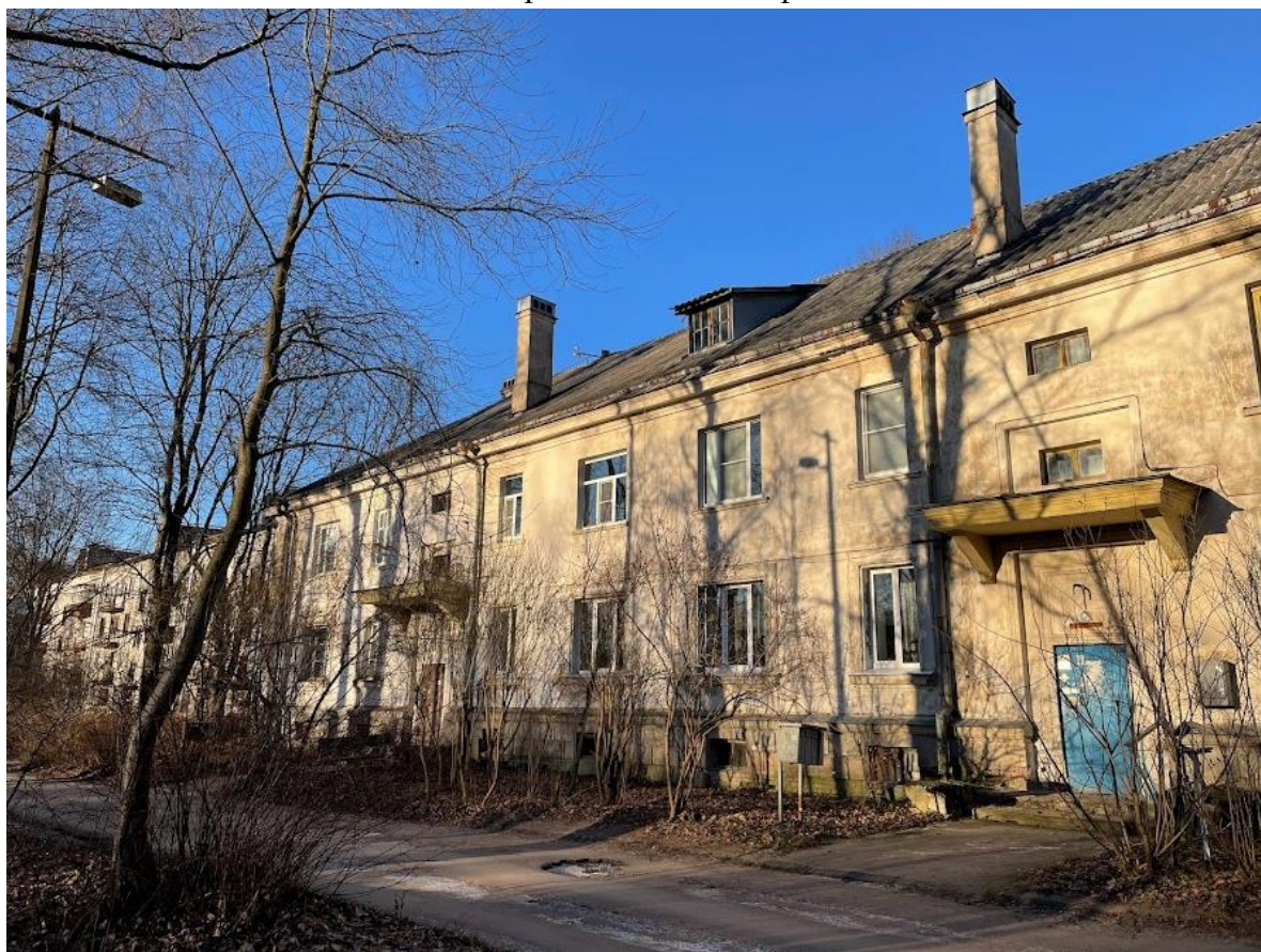
4. Фрагмент южного фасада
