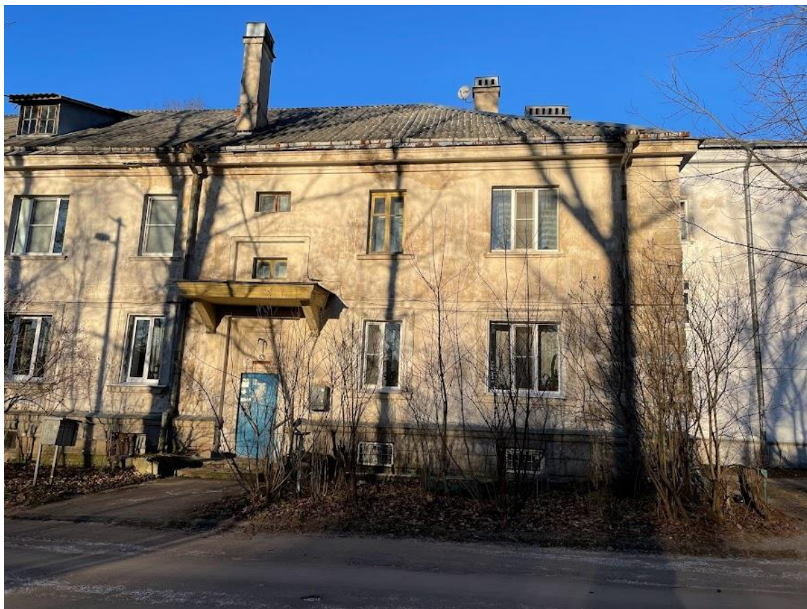
3. Фрагмент южного фасада
