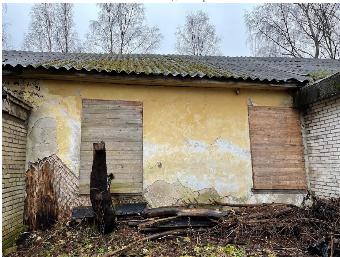
6. Фрагмент северной стены
