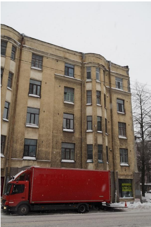
8. «Жилой дом с магазинами б. Горышина», Ленинградская область, Выборгский район, г. Выборг, Ленинградское шоссе, д.3. Северо-западный фасад. Фрагмент. Фото 14.01.2022г.
