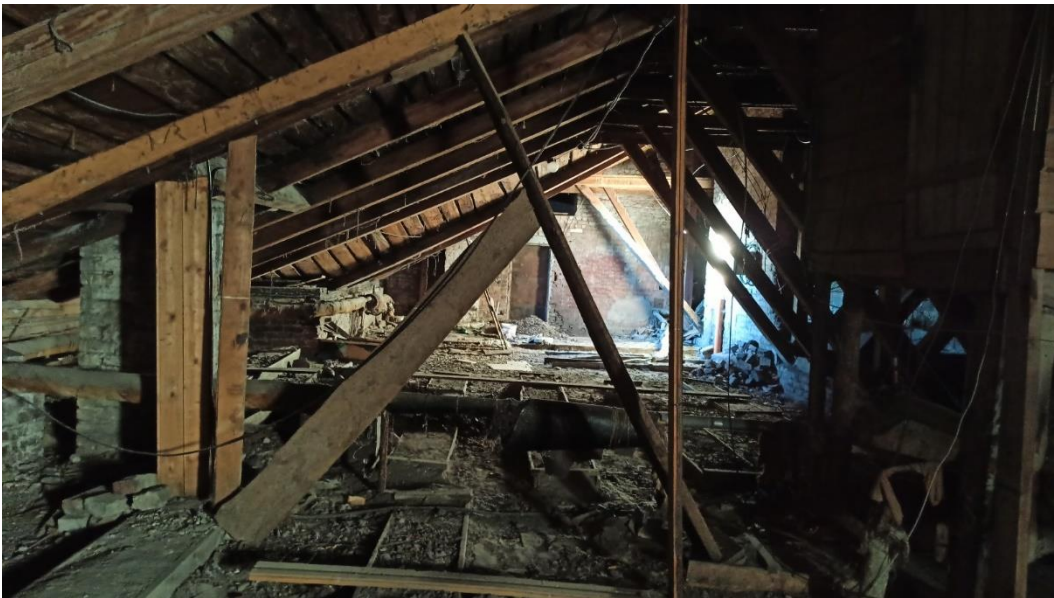
25. «Жилой дом с магазинами б. Горышина», Ленинградская область, Выборгский район, г. Выборг, Ленинградское шоссе, д.3. Чердак. Общий вид. Фото 14.01.2022г.
