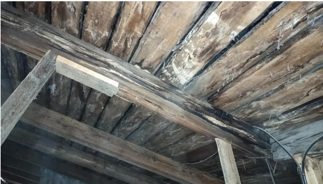
31. «Жилой дом с магазинами б. Горышина», Ленинградская область, Выборгский район, г. Выборг, Ленинградское шоссе, д.3. Чердак. Фрагмент. Фото 14.01.2022г.
