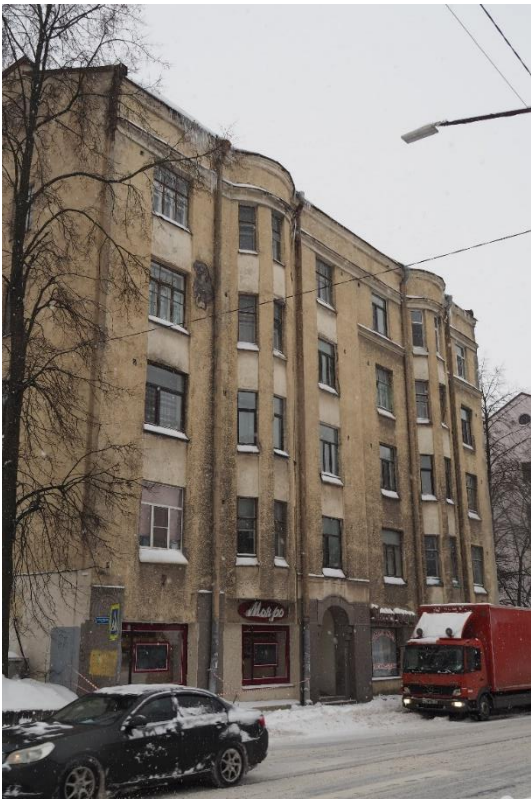
3. «Жилой дом с магазинами б. Горышина», Ленинградская область, Выборгский район, г. Выборг, Ленинградское шоссе, д.3. Северо-западный фасад. Общий вид. Фото 14.01.2022г.
