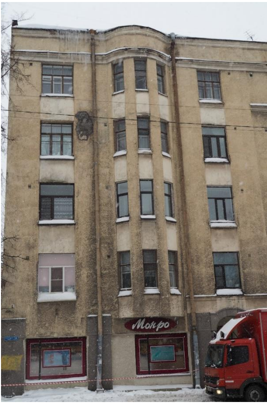
7. «Жилой дом с магазинами б. Горышина», Ленинградская область, Выборгский район, г. Выборг, Ленинградское шоссе, д.3. Северо-западный фасад. Фрагмент. Фото 14.01.2022г.
