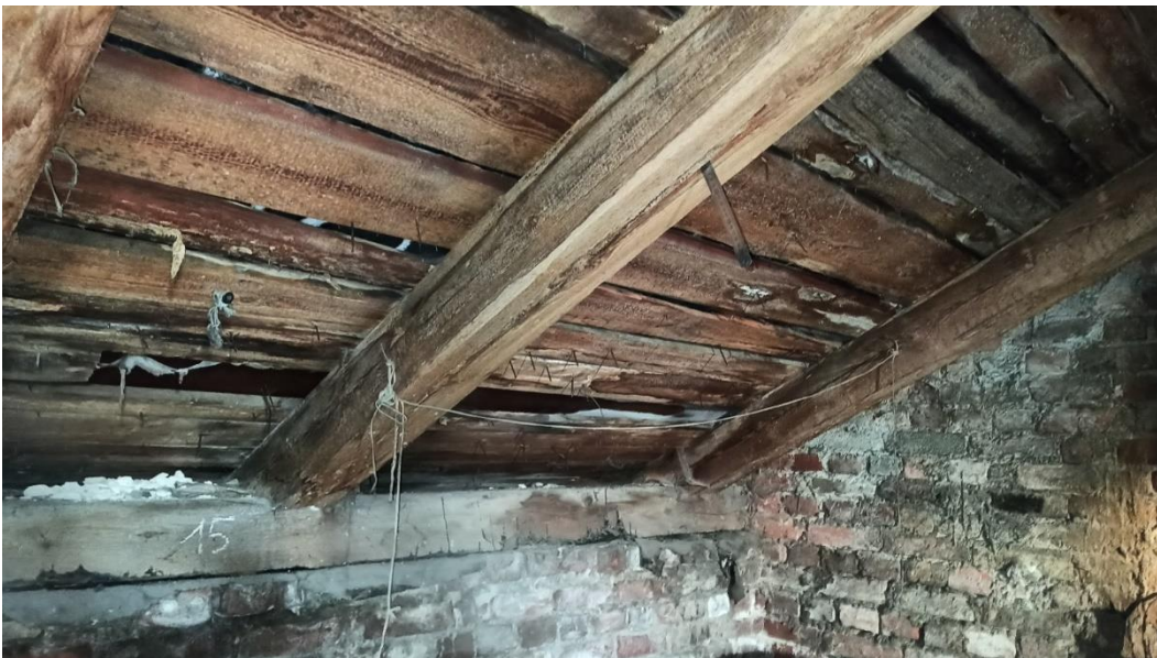
32. «Жилой дом с магазинами б. Горышина», Ленинградская область, Выборгский район, г. Выборг, Ленинградское шоссе, д.3. Чердак. Фрагмент. Фото 14.01.2022г.
