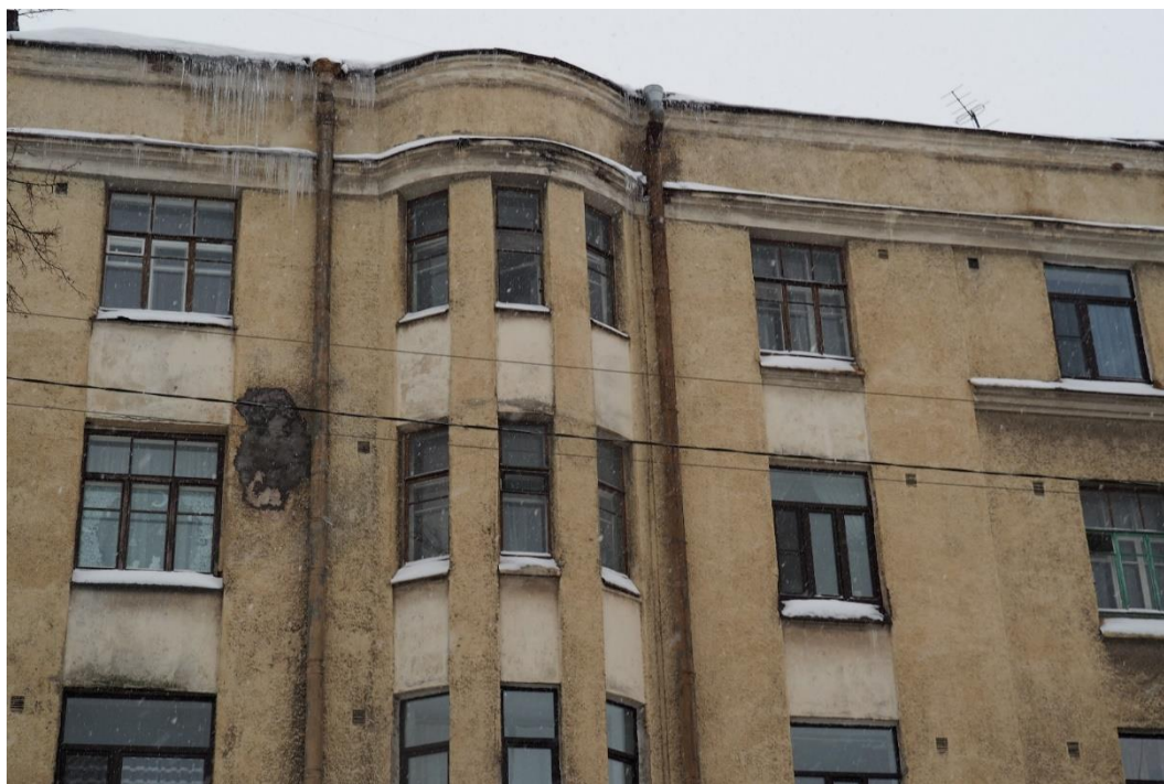
9. «Жилой дом с магазинами б. Горышина», Ленинградская область, Выборгский район, г. Выборг, Ленинградское шоссе, д.3. Северо-западный фасад. Фрагмент. Фото 14.01.2022г.
