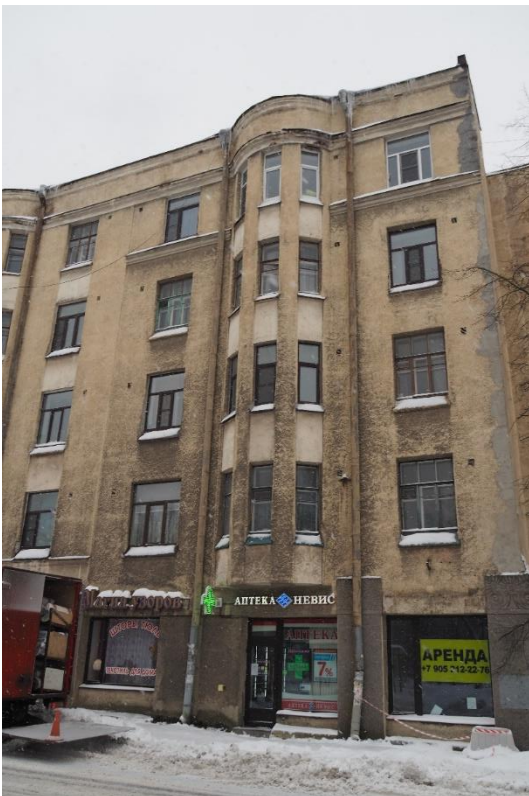
12. «Жилой дом с магазинами б. Горышина», Ленинградская область, Выборгский район, г. Выборг, Ленинградское шоссе, д.3. Северо-западный фасад. Фрагмент. Фото 14.01.2022г.
