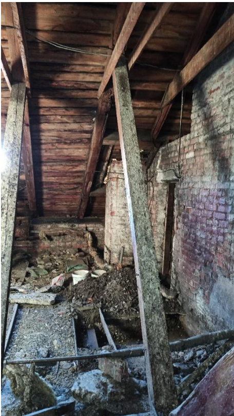
29. «Жилой дом с магазинами б. Горышина», Ленинградская область, Выборгский район, г. Выборг, Ленинградское шоссе, д.3. Чердак. Фрагмент. Фото 14.01.2022г.
