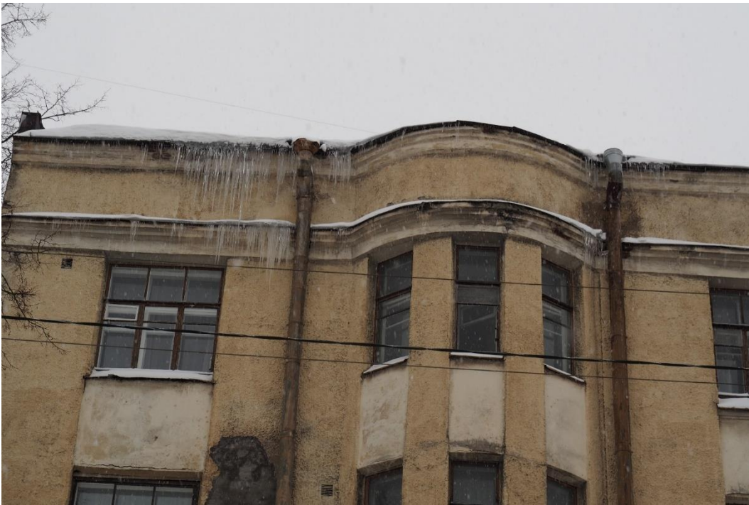
11. «Жилой дом с магазинами б. Горышина», Ленинградская область, Выборгский район, г. Выборг, Ленинградское шоссе, д.3. Северо-западный фасад. Фрагмент. Фото 14.01.2022г.
