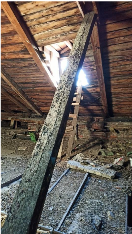
28. «Жилой дом с магазинами б. Горышина», Ленинградская область, Выборгский район, г. Выборг, Ленинградское шоссе, д.3. Чердак. Фрагмент. Фото 14.01.2022г.
