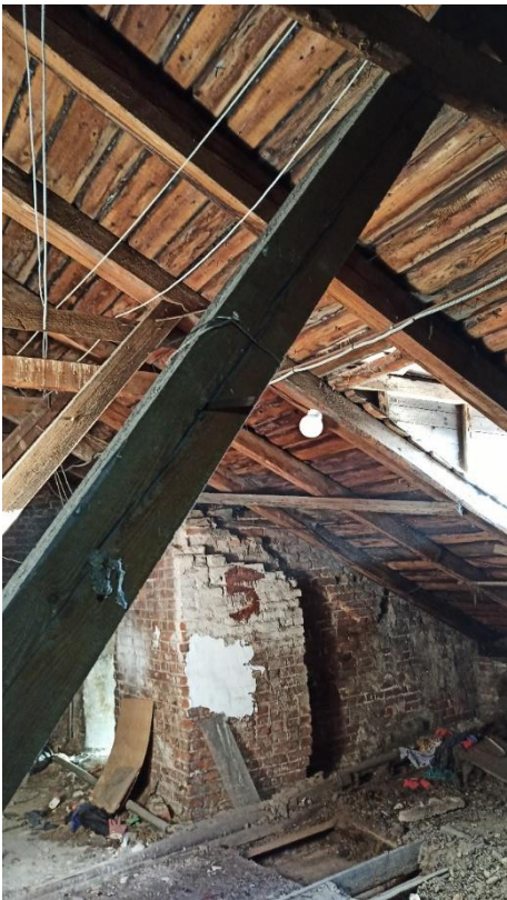
27. «Жилой дом с магазинами б. Горышина», Ленинградская область, Выборгский район, г. Выборг, Ленинградское шоссе, д.3. Чердак. Фрагмент. Фото 14.01.2022г.
