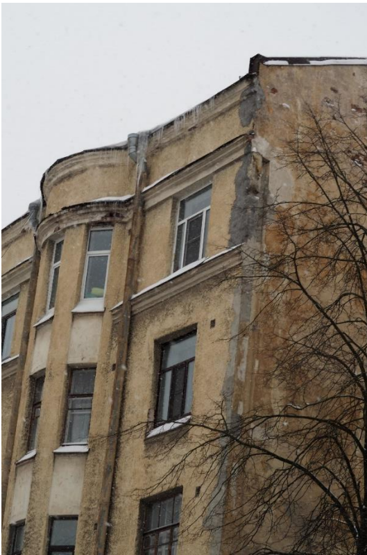
13. «Жилой дом с магазинами б. Горышина», Ленинградская область, Выборгский район, г. Выборг, Ленинградское шоссе, д.3. Северо-западный фасад. Фрагмент. Фото 14.01.2022г.
