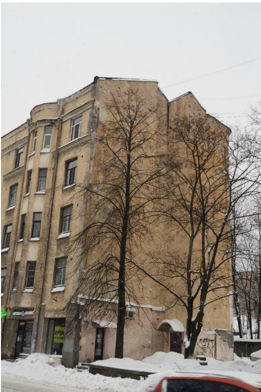
4. «Жилой дом с магазинами б. Горышина», Ленинградская область, Выборгский район, г. Выборг, Ленинградское шоссе, д.3. Юго-западный фасад. Общий вид. Фото 14.01.2022г.
