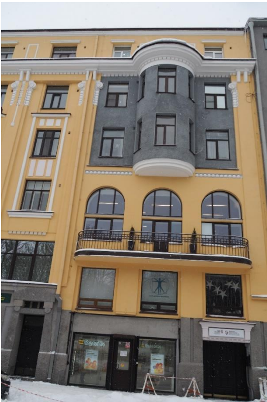
5. «Жилой дом», Ленинградская область, Выборгский район, г. Выборг, пр. Ленина, д. 18. Юго-западный фасад. Фрагмент. Фото 14.01.2022г.
