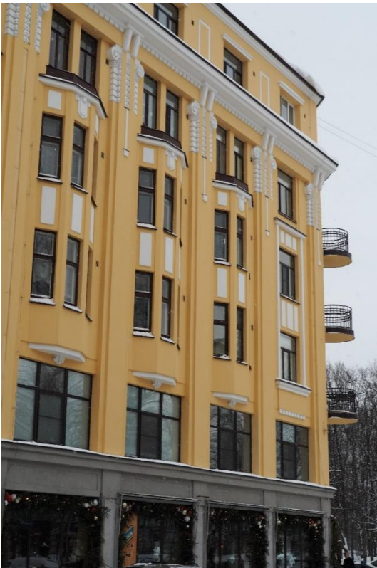
14. «Жилой дом», Ленинградская область, Выборгский район, г. Выборг, пр. Ленина, д. 18. Северо-западный фасад. Фрагмент. Фото 14.01.2022г.
