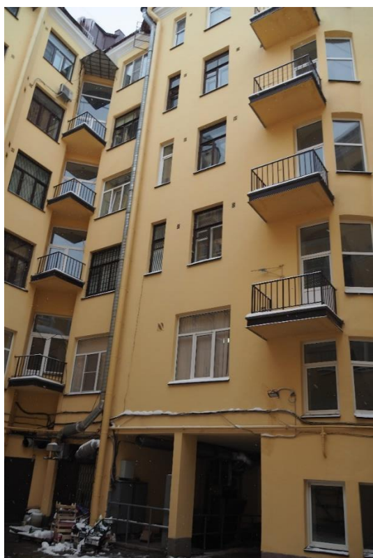
22. «Жилой дом», Ленинградская область, Выборгский район, г. Выборг, пр. Ленина, д. 18. Дворовый фасад. Фрагмент. Фото 14.01.2022г.
