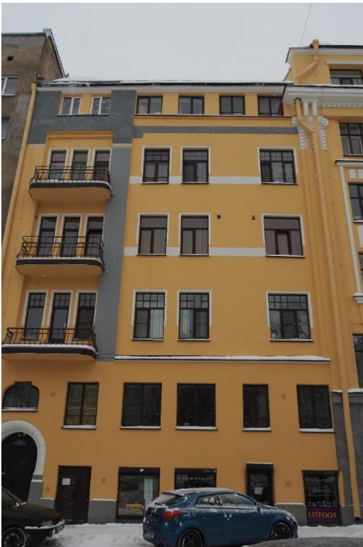
15. «Жилой дом», Ленинградская область, Выборгский район, г. Выборг, пр. Ленина, д. 18. Северо-западный фасад. Фрагмент. Фото 14.01.2022г.
