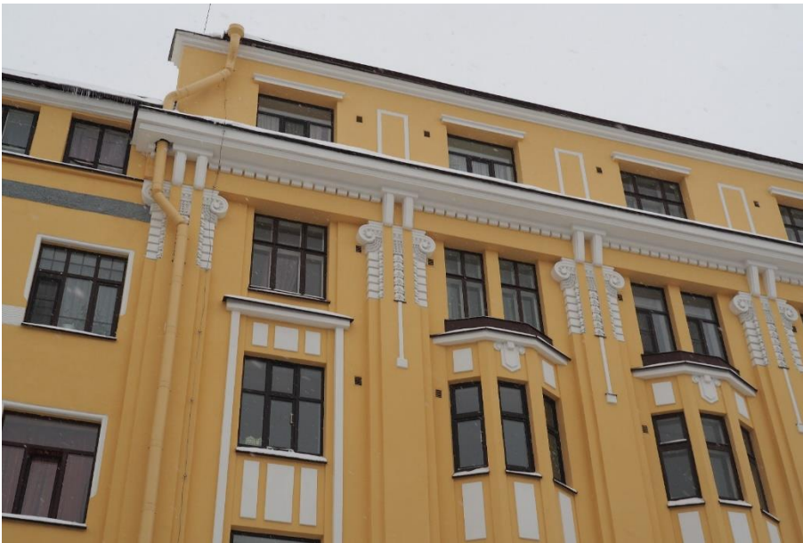
13. «Жилой дом», Ленинградская область, Выборгский район, г. Выборг, пр. Ленина, д. 18. Северо-западный фасад. Фрагмент. Фото 14.01.2022г.
