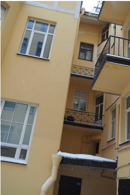
23. «Жилой дом», Ленинградская область, Выборгский район, г. Выборг, пр. Ленина, д. 18. Дворовый фасад. Фрагмент. Фото 14.01.2022г.
