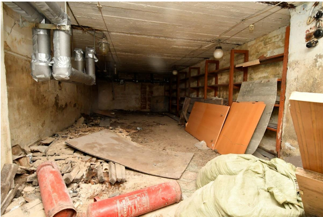
36. «Жилой дом», Ленинградская область, Выборгский район, г. Выборг, пр. Ленина, д. 18. Подвал. Общий вид. Фото 14.01.2022г.
