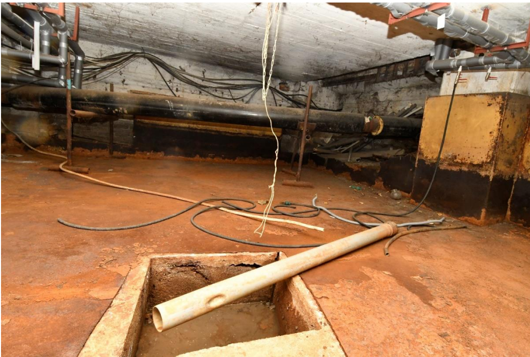
32. «Жилой дом», Ленинградская область, Выборгский район, г. Выборг, пр. Ленина, д. 18. Подвал. Общий вид. Фото 14.01.2022г.
