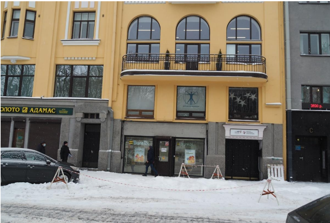
7. «Жилой дом», Ленинградская область, Выборгский район, г. Выборг, пр. Ленина, д. 18. Юго-западный фасад. Фрагмент. Фото 14.01.2022г.
