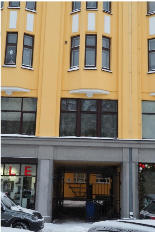
16. «Жилой дом», Ленинградская область, Выборгский район, г. Выборг, пр. Ленина, д. 18. Северо-западный фасад. Фрагмент. Фото 14.01.2022г.
