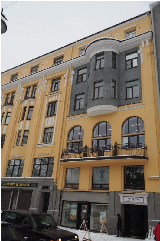
4. «Жилой дом», Ленинградская область, Выборгский район, г. Выборг, пр. Ленина, д. 18. Юго-западный фасад. Фрагмент. Фото 14.01.2022г.
