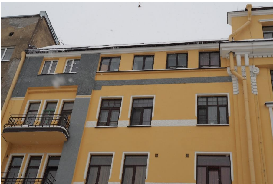
12. «Жилой дом», Ленинградская область, Выборгский район, г. Выборг, пр. Ленина, д. 18. Северо-западный фасад. Фрагмент. Фото 14.01.2022г.
