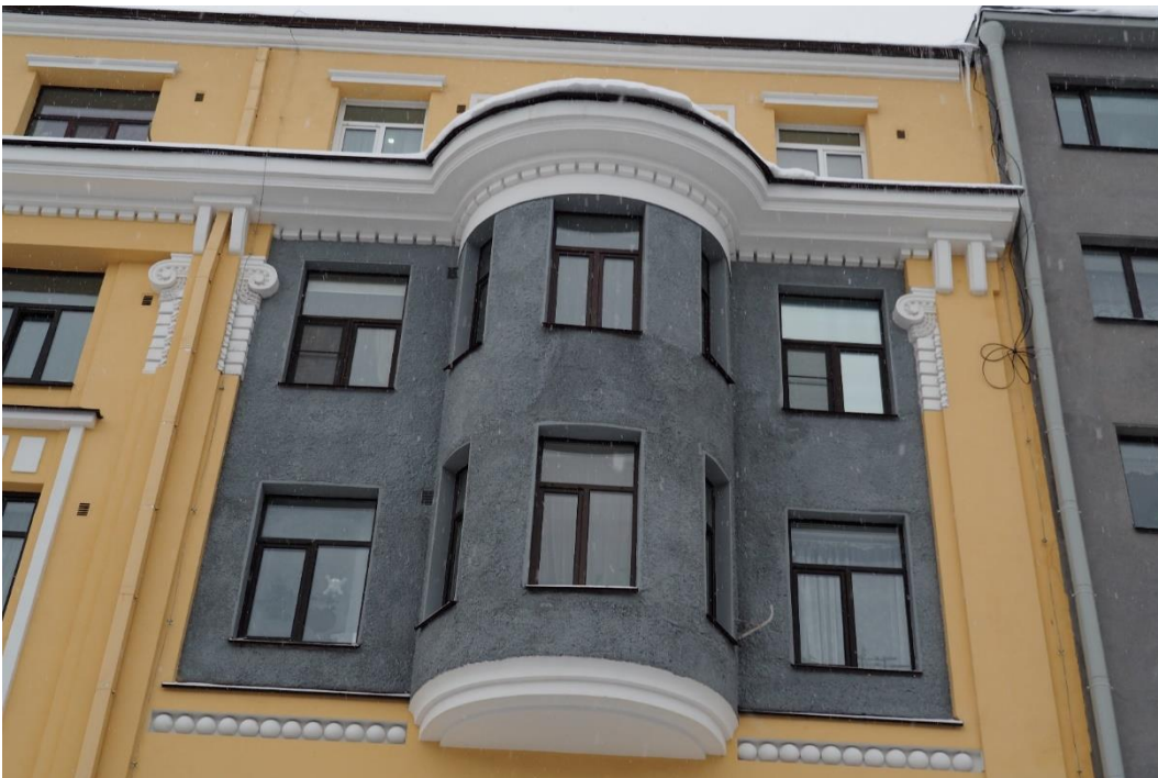
6. «Жилой дом», Ленинградская область, Выборгский район, г. Выборг, пр. Ленина, д. 18. Юго-западный фасад. Фрагмент. Фото 14.01.2022г.
