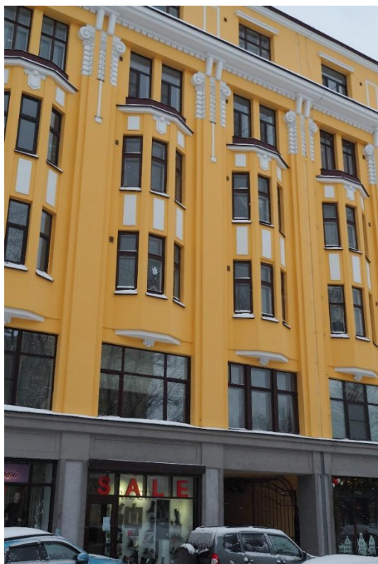
17. «Жилой дом», Ленинградская область, Выборгский район, г. Выборг, пр. Ленина, д. 18. Северо-западный фасад. Фрагмент. Фото 14.01.2022г.
