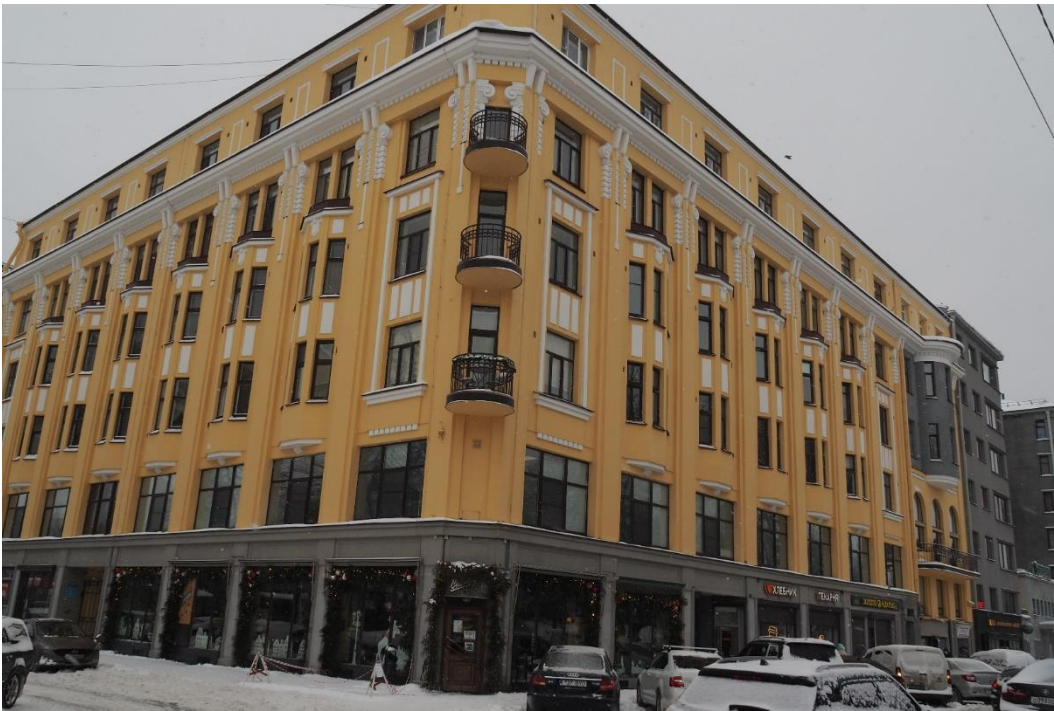
1. «Жилой дом», Ленинградская область, Выборгский район, г. Выборг, пр. Ленина, д. 18. Общий вид с запада. Фото 14.01.2022г.
