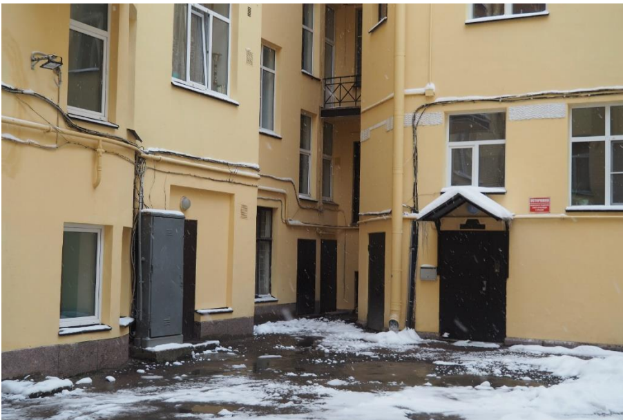
24. «Жилой дом», Ленинградская область, Выборгский район, г. Выборг, пр. Ленина, д. 18. Дворовый фасад. Фрагмент. Фото 14.01.2022г.
