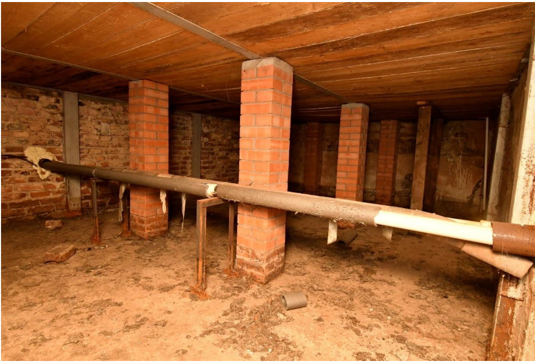
31. «Жилой дом», Ленинградская область, Выборгский район, г. Выборг, пр. Ленина, д. 18. Подвал. Общий вид. Фото 14.01.2022г.
