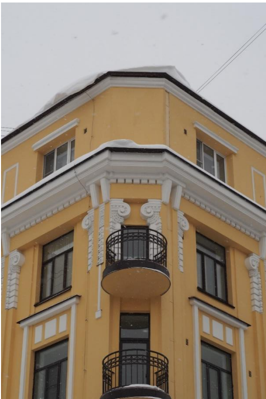
10. «Жилой дом», Ленинградская область, Выборгский район, г. Выборг, пр. Ленина, д. 18. Юго-западный фасад. Фрагмент. Фото 14.01.2022г.
