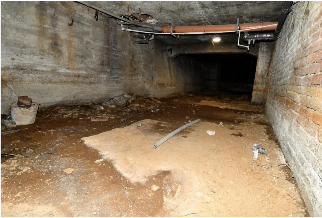
35. «Жилой дом», Ленинградская область, Выборгский район, г. Выборг, пр. Ленина, д. 18. Подвал. Общий вид. Фото 14.01.2022г.
