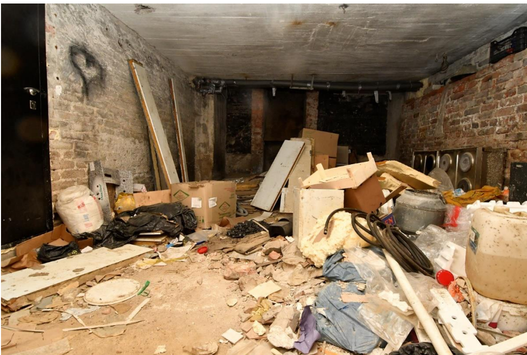
34. «Жилой дом», Ленинградская область, Выборгский район, г. Выборг, пр. Ленина, д. 18. Подвал. Общий вид. Фото 14.01.2022г.
