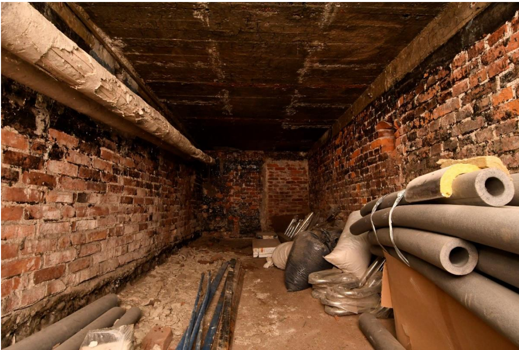
29. «Жилой дом», Ленинградская область, Выборгский район, г. Выборг, пр. Ленина, д. 18. Подвал. Общий вид. Фото 14.01.2022г.
