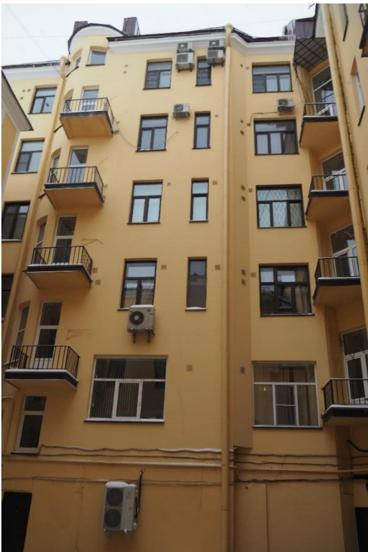
20. «Жилой дом», Ленинградская область, Выборгский район, г. Выборг, пр. Ленина, д. 18. Дворовый фасад. Фрагмент. Фото 14.01.2022г.
