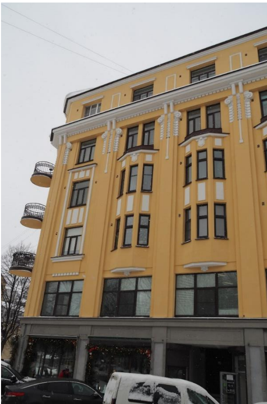
8. «Жилой дом», Ленинградская область, Выборгский район, г. Выборг, пр. Ленина, д. 18. Юго-западный фасад. Фрагмент. Фото 14.01.2022г.
