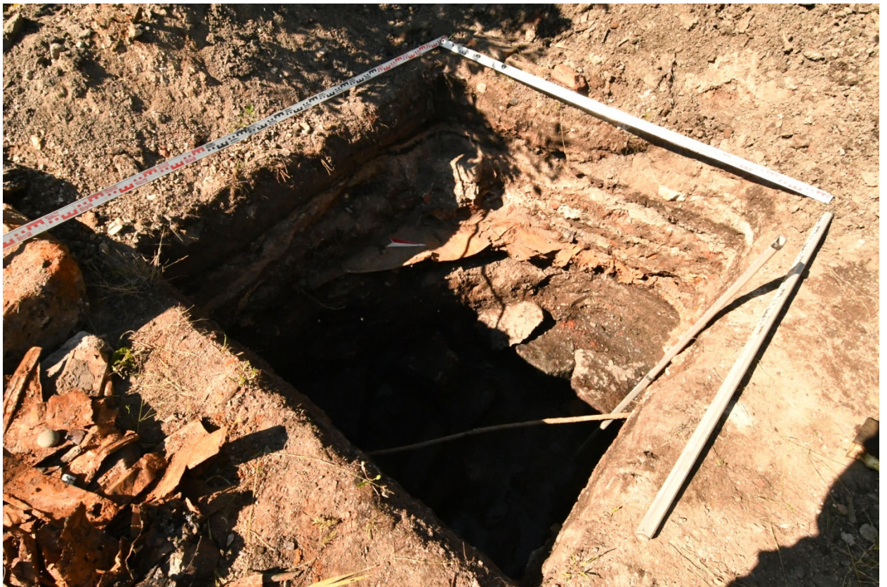
Рис. 50. Выборг, уч. КН: 47:01:0107004:1602. Шурф 2, фиксация по уровню окончания работ, вид на запад.
