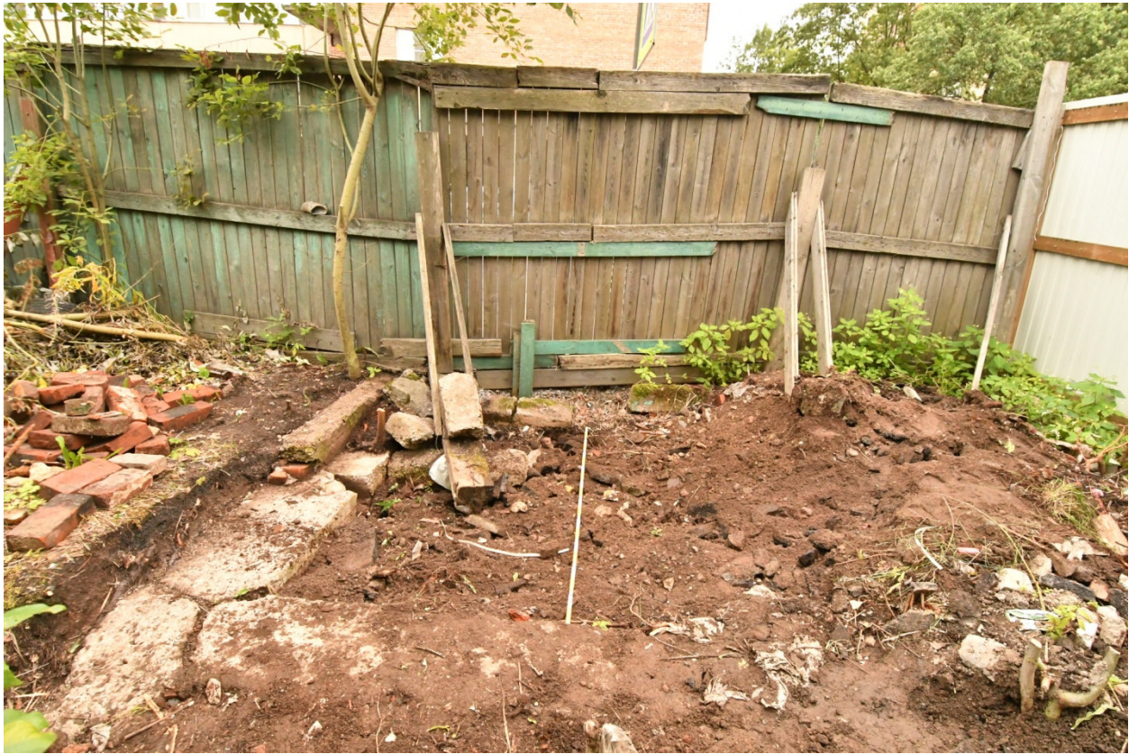
Рис. 46. Выборг, уч. КН: 47:01:0107004:1602. Шурф 1, после рекультивации, вид на юго-запад.
