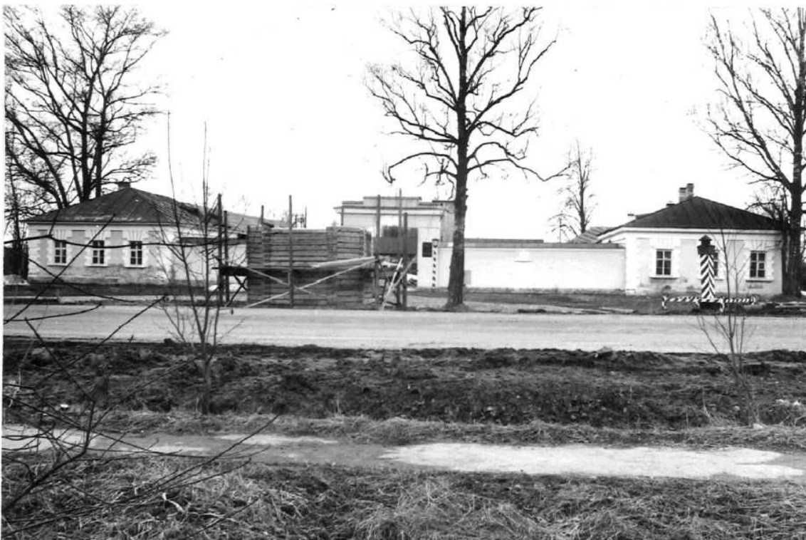
27. Общий вид главного фасада почтовой станции в Выре. После реставрации 1986 г. Фото А. Плошко
