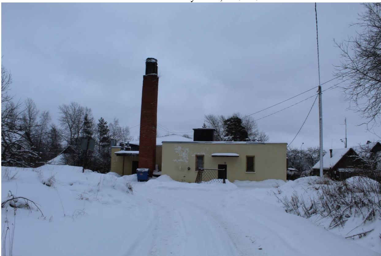
12. «Здание почтовой станции», «Дом для проезжающих» в д. Выра (Гатчинский район, Ленинградская область). Вид на окружающую застройку на юге от «Дома для проезжающих». Вид на юго-восток. Фото Н. М. Петуховой, 12.01.2021.
