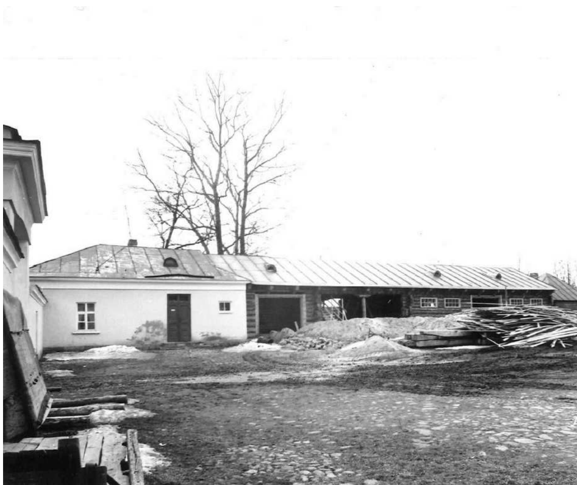
31. Дворовые фасады южного почтового корпуса и конюшен в процессе завершения работ. 1986 г. Фото А. Плешко.
