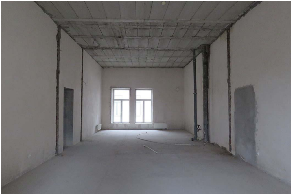
Фото 12. Квартира № 4. Пом. 7. Общий вид помещения с юго-запада. Дата съемки: 14.04.2022 г. Автор: Глинская Н.Б.
