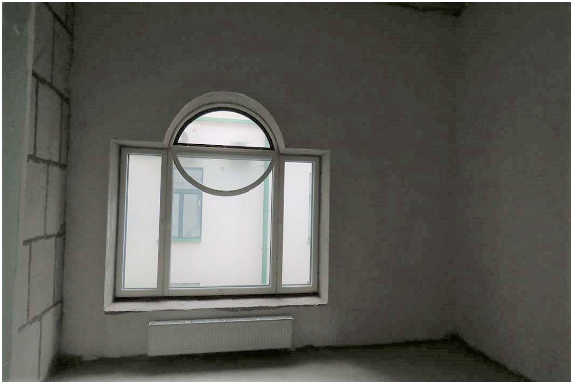
Фото 11. Квартира № 4. Пом. 6. Вид на северо-восточную часть помещения. Дата съемки: 14.04.2022 г. Автор: Глинская Н.Б.
