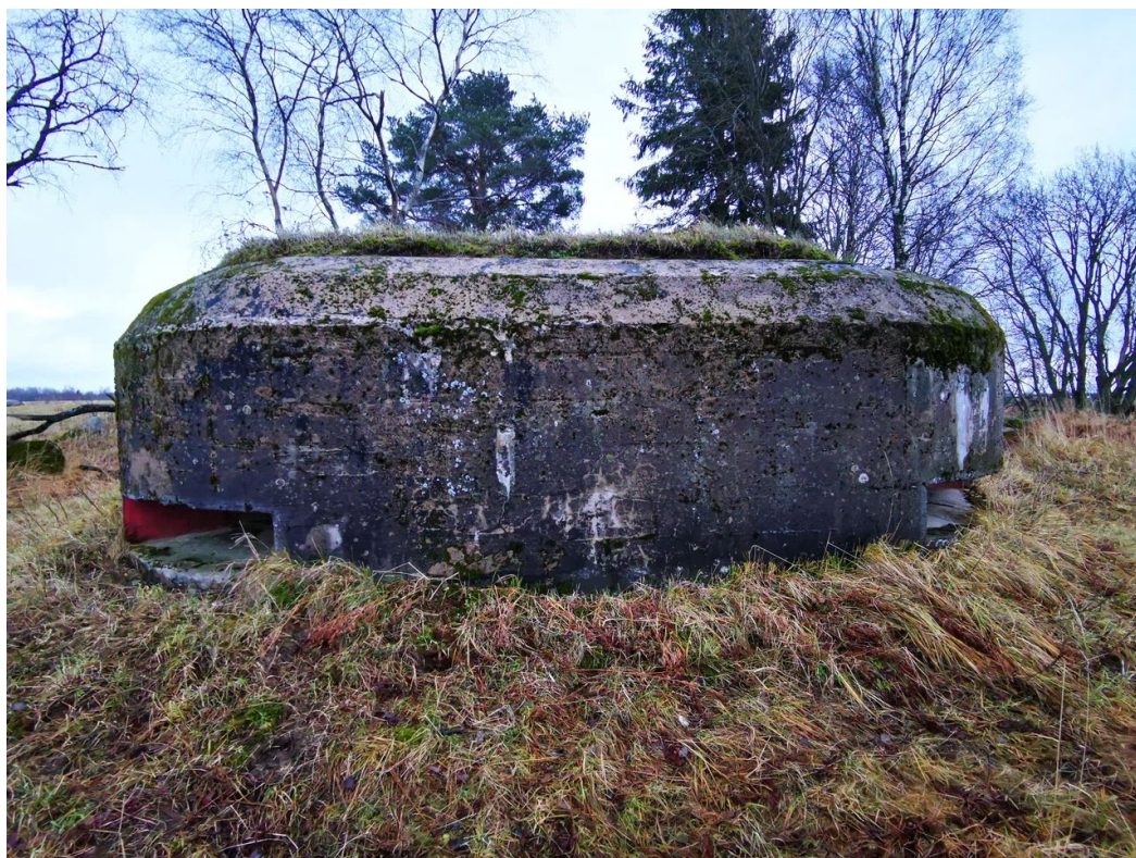
1. Вид на сооружение с фронта. ДОТ №447
