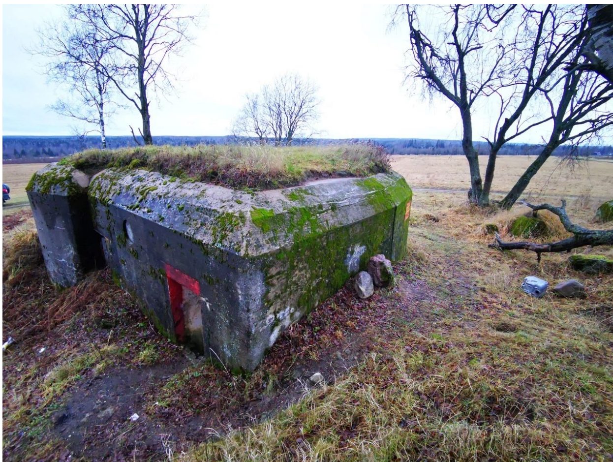
5. Вид на сооружение справа сзади. ДОТ №447
