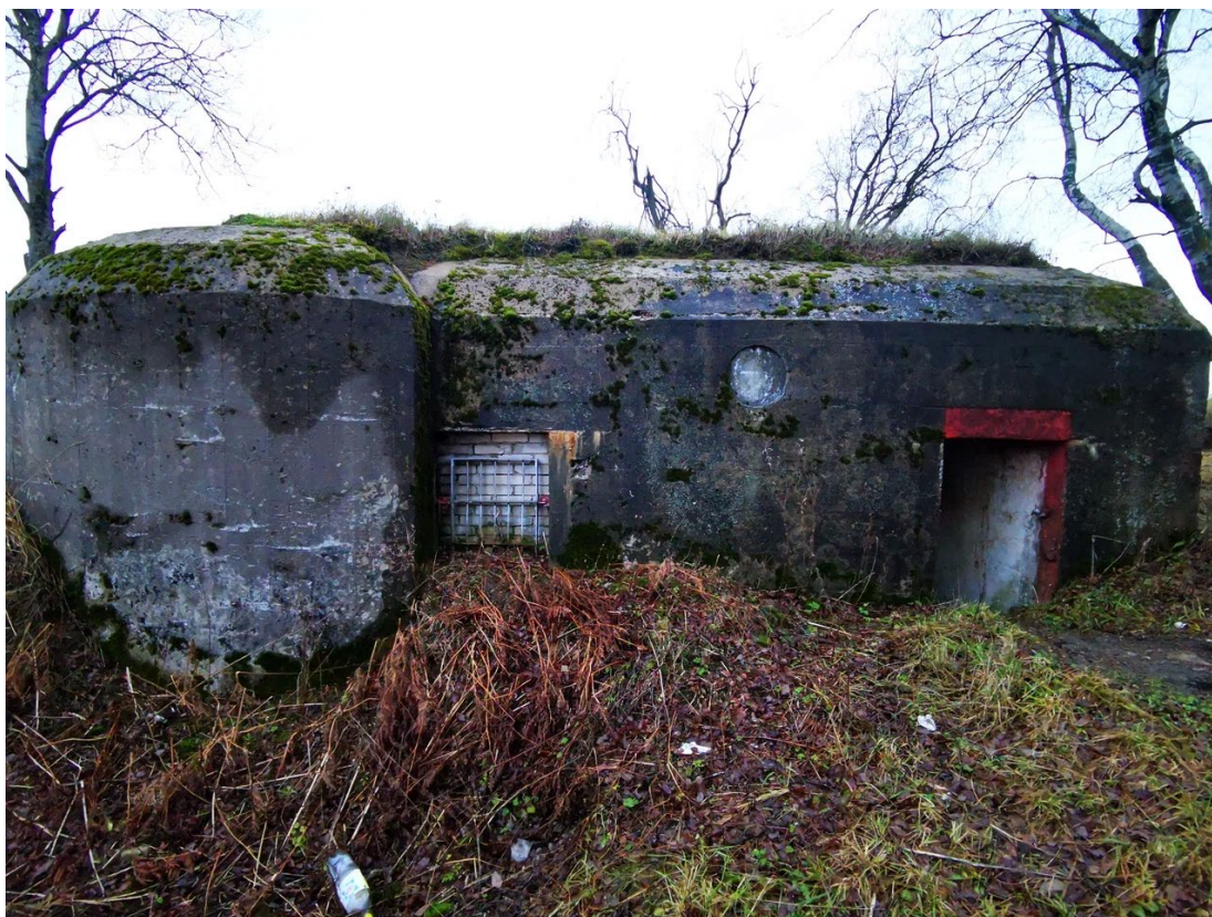
3. Вид на сооружение с тыла. ДОТ №447
