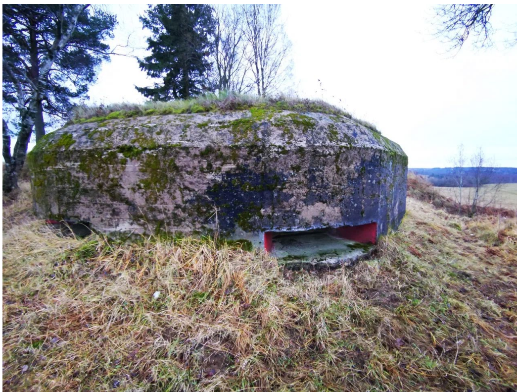
2. Вид на сооружение справа от входа. ДОТ №447
