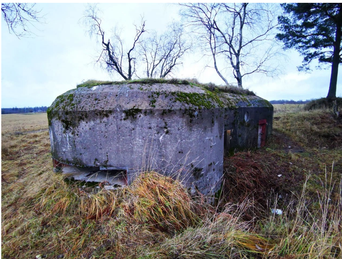
4. Вид на сооружение слева от входа. ДОТ №447
