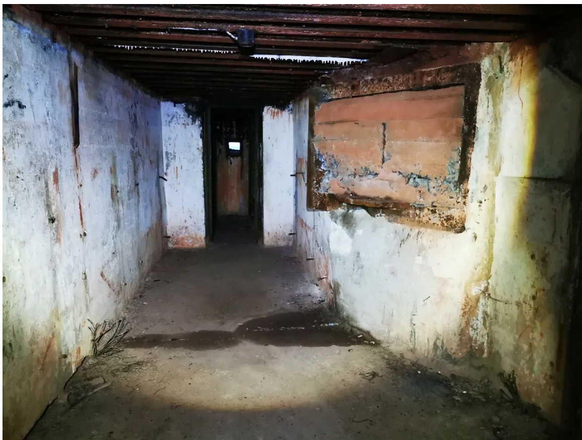
6. Общий вид на внутренние помещения КНП. Командно-наблюдательный пункт ДОТ № 458
