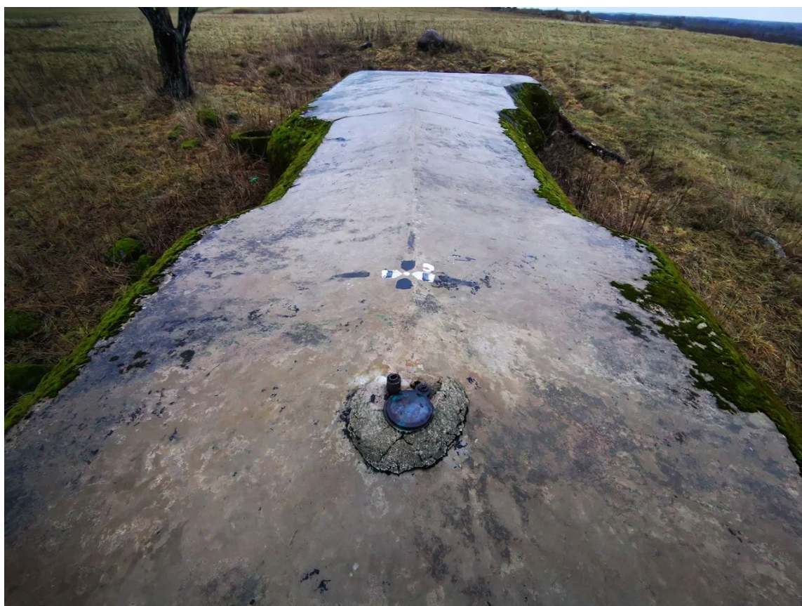
1. Вид на крышу КНП и бронировку вывода перископа.
