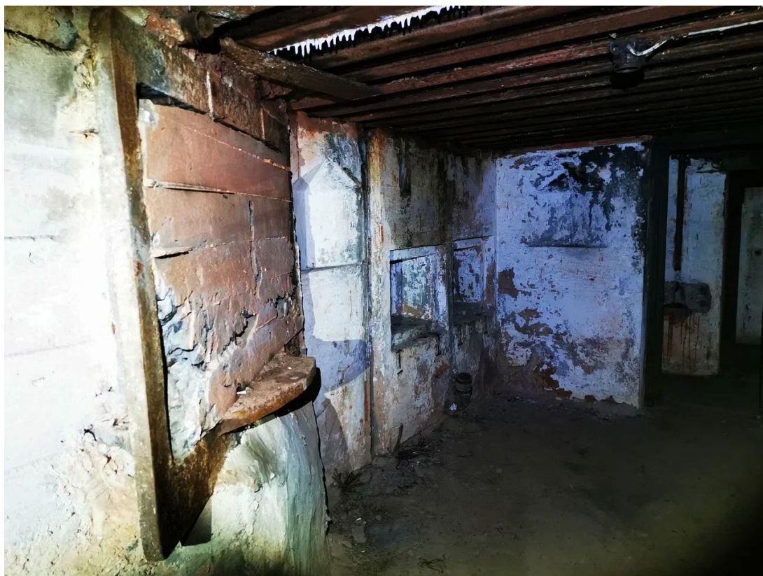
4. Вид на забетонированную установку ДОТ-4. Командно-наблюдательный пункт ДОТ № 458
