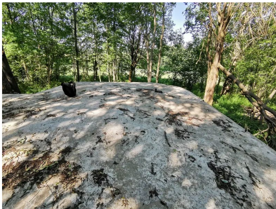
5. Вид на ДОТ сверху. ДОТ № 441. Фото: 26.05.22
