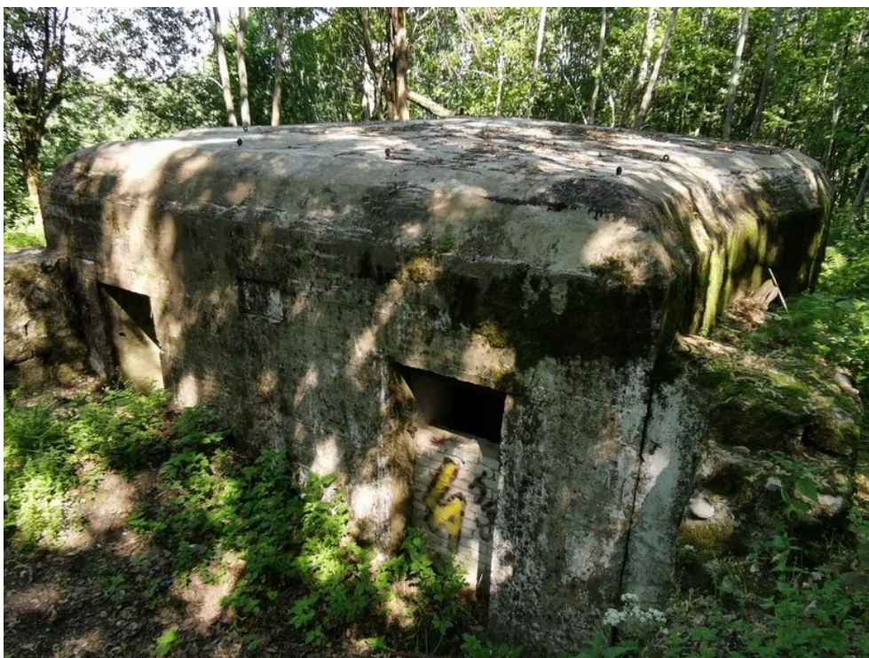
2. Общий вид на ДОТ со стороны сквозника. ДОТ № 441. Фото: 26.05.22
