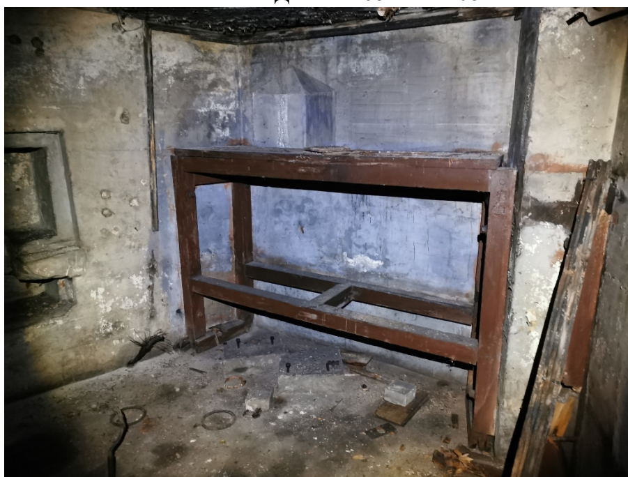
8. Интерьер нижнего яруса, двухъярусные нары, ниша для установки фонаря аварийного освещения. КНП совмещенный с огневой точкой ДОТ № 468. Фото: 08.11.21
