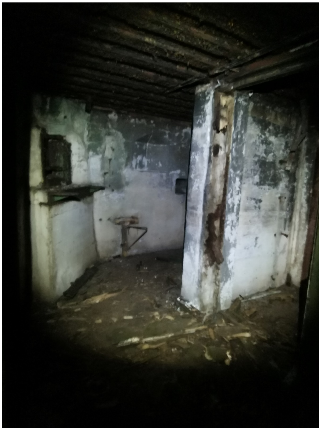
2. Интерьер верхнего яруса, боевого каземата, угловая амбразура с броневой плитой (заслоном), консоль, ниши для установки фонаря аварийного освещения. КНП совмещенный с огневой точкой ДОТ № 468. Фото: 08.11.21
