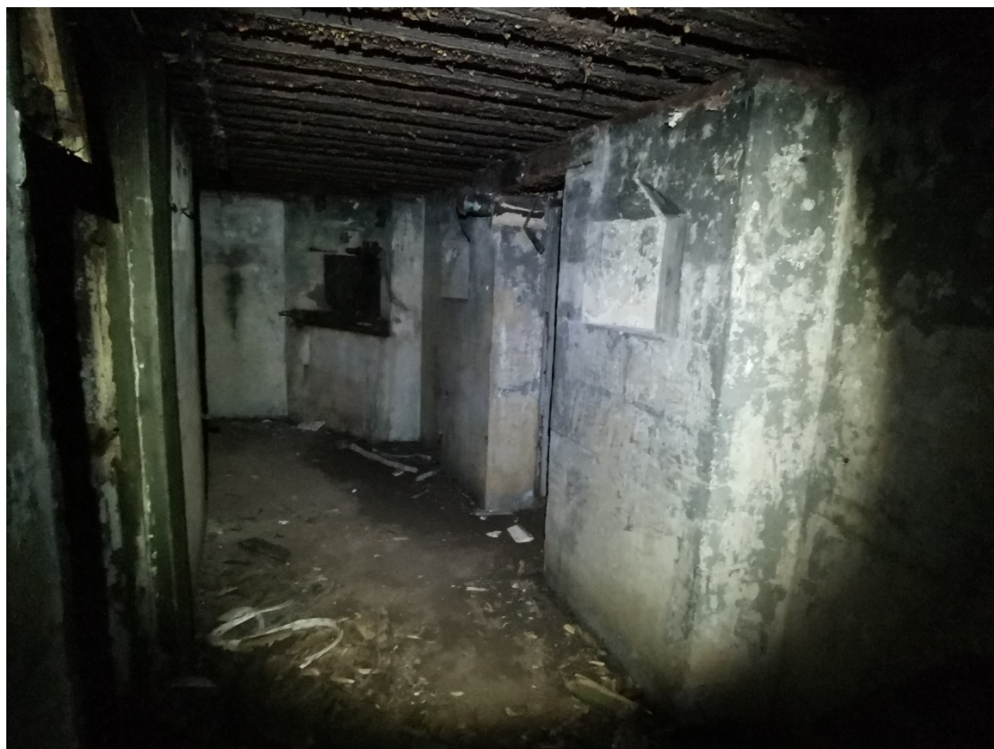
3. Интерьер верхнего яруса, боевого каземата, угловая амбразура с броневой плитой (заслоном), ниши для установки фонаря аварийного освещения. КНП совмещенный с огневой точкой ДОТ № 468. Фото: 08.11.21
