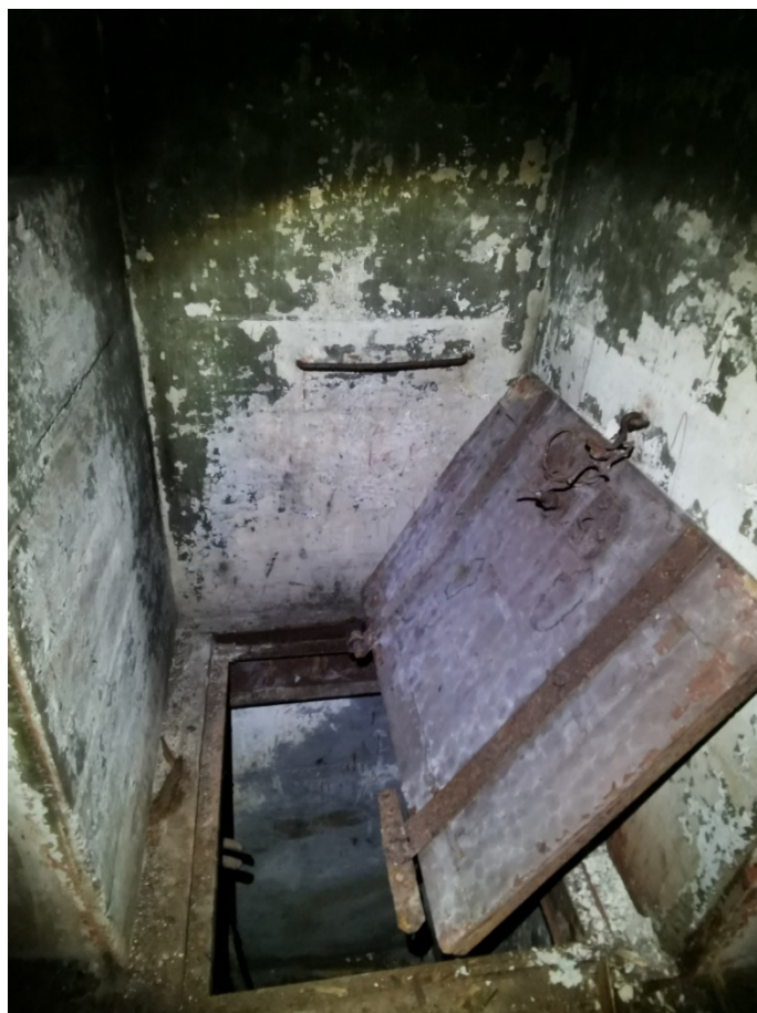
5. Интерьер верхнего яруса, бронированный люк в нижний ярус. КНП совмещенный с огневой точкой ДОТ № 468. Фото: 08.11.21
