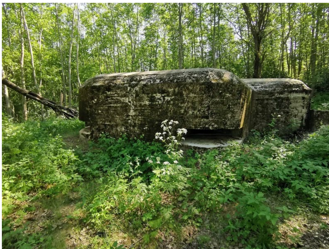
3. Общий вид на ДОТ со стороны амбразур. ДОТ № 441. Фото: 26.05.22
