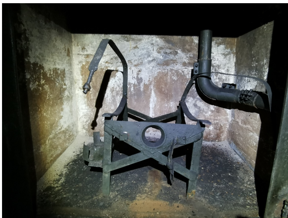
6. Интерьер нижнего яруса, металлический шкаф и оборудование. КНП совмещенный с огневой точкой ДОТ № 468. Фото: 08.11.21
