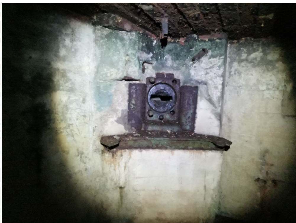
4. Интерьер верхнего яруса, боевого каземата, угловая амбразура с броневой плитой (заслоном). КНП совмещенный с огневой точкой ДОТ № 468. Фото: 08.11.21
