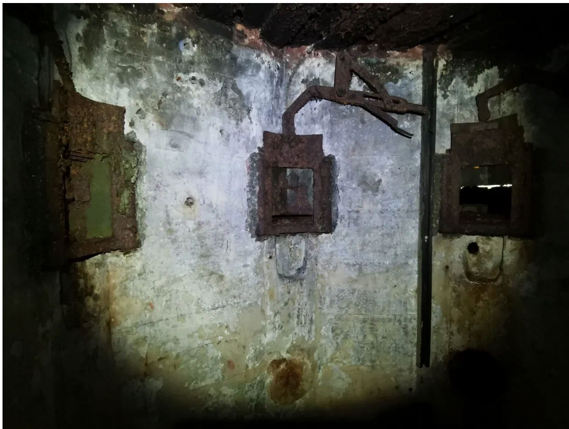
1. Интерьер верхнего яруса, каземат командира. Амбразуры для наблюдения с частично сохранившимися бронезаслонками. КНП совмещенный с огневой точкой ДОТ № 468. Фото: 08.11.21
