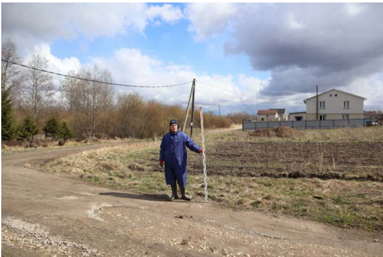
Рис.24. Ленинградская область. Гатчинский район. д.Вайя. Объект "Распределительный газопровод для газоснабжения жилых домов д. Вайя Гатчинского района Ленинградской области (1 этап, в том числе проектно-изыскательские работы)". Точка фотофиксации 9, вид с северо-востока.
