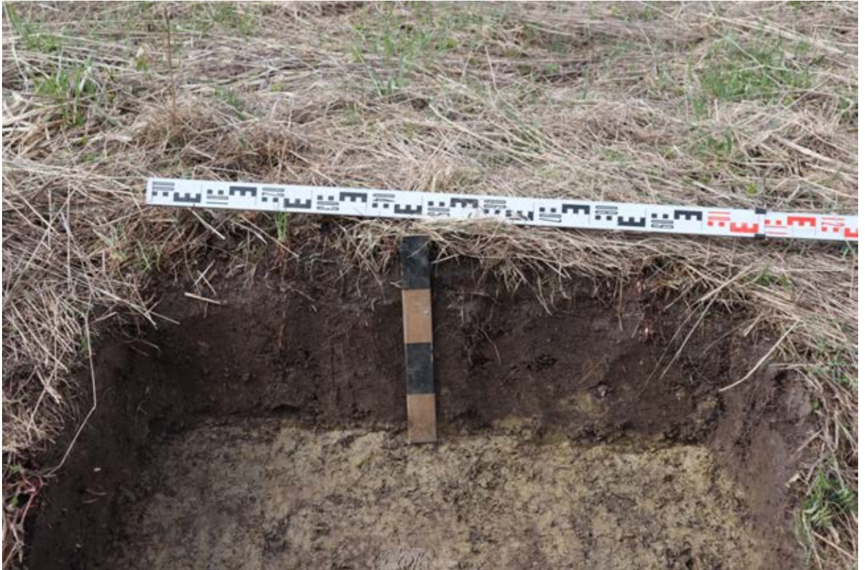
Рис.44. Ленинградская область. Гатчинский район. д.Вайя. Объект "Распределительный газопровод для газоснабжения жилых домов д. Вайя Гатчинского района Ленинградской области (1 этап, в том числе проектно-изыскательские работы)". Зачистка 4, вид с востока.
