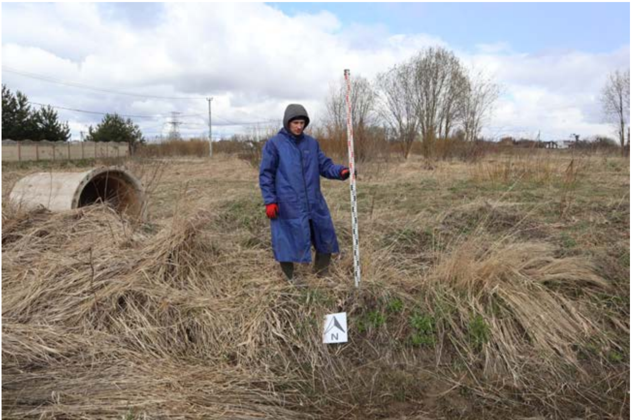
Рис.38. Ленинградская область. Гатчинский район. д.Вайя. Объект "Распределительный газопровод для газоснабжения жилых домов д. Вайя Гатчинского района Ленинградской области (1 этап, в том числе проектно-изыскательские работы)". Зачистка 3, вид на место закладки с юга.
