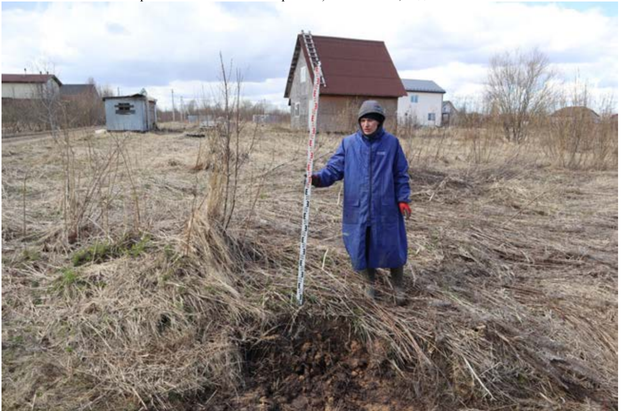
Рис.49. Ленинградская область. Гатчинский район. д.Вайя. Объект "Распределительный газопровод для газоснабжения жилых домов д. Вайя Гатчинского района Ленинградской области (1 этап, в том числе проектно-изыскательские работы)". Зачистка 5, вид с востока после рекультивации.
