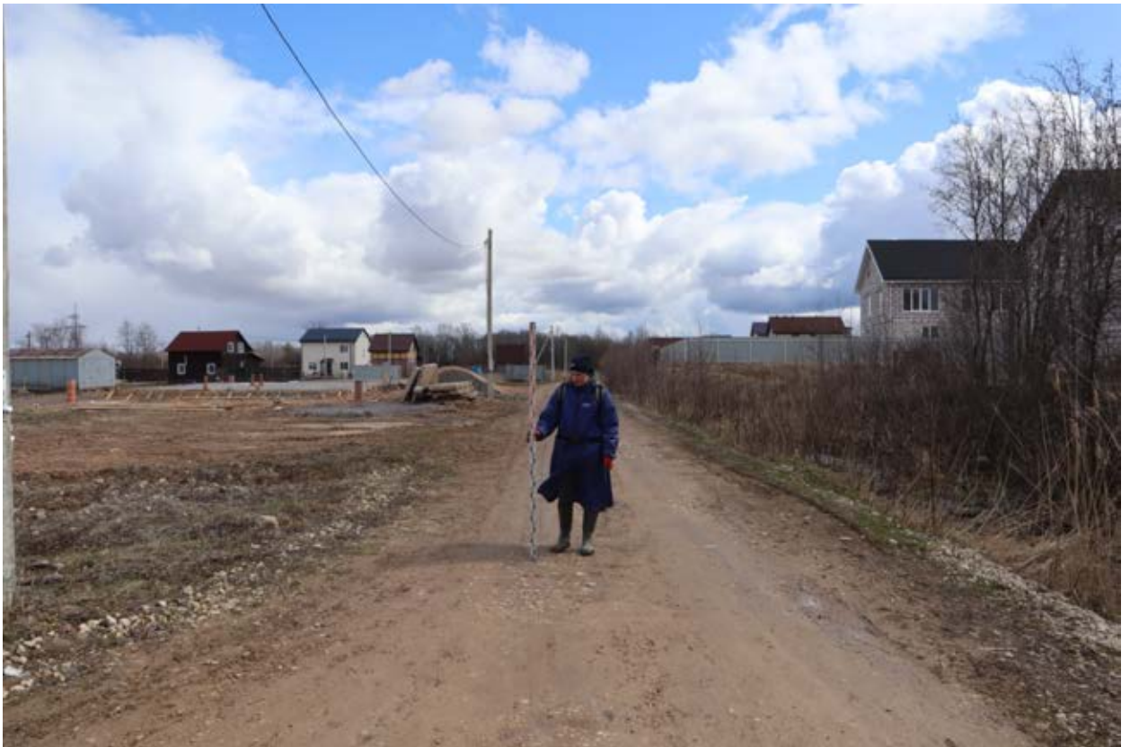
Рис.22. Ленинградская область. Гатчинский район. д.Вайя. Объект "Распределительный газопровод для газоснабжения жилых домов д. Вайя Гатчинского района Ленинградской области (1 этап, в том числе проектно-изыскательские работы)". Точка фотофиксации 7, вид с северо-востока.
