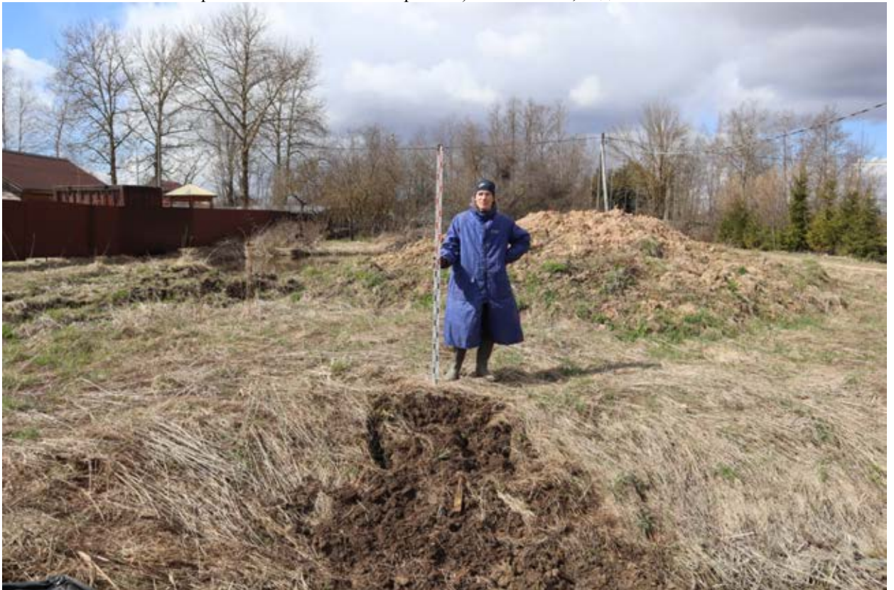
Рис.45. Ленинградская область. Гатчинский район. д.Вайя. Объект "Распределительный газопровод для газоснабжения жилых домов д. Вайя Гатчинского района Ленинградской области (1 этап, в том числе проектно-изыскательские работы)". Зачистка 4, вид с востока после рекультивации.
