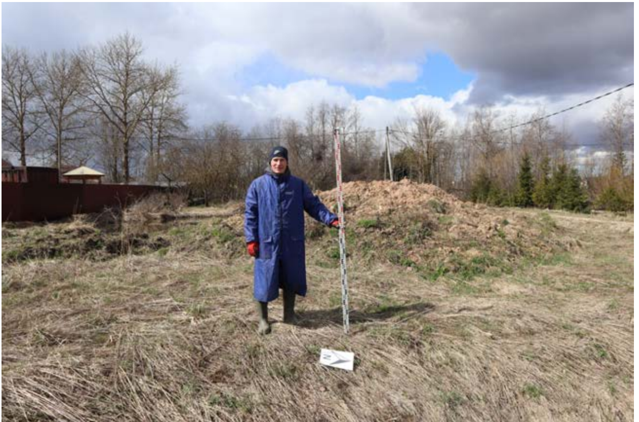
Рис.42. Ленинградская область. Гатчинский район. д.Вайя. Объект "Распределительный газопровод для газоснабжения жилых домов д. Вайя Гатчинского района Ленинградской области (1 этап, в том числе проектно-изыскательские работы)". Зачистка 4, вид на место закладки с востока.
