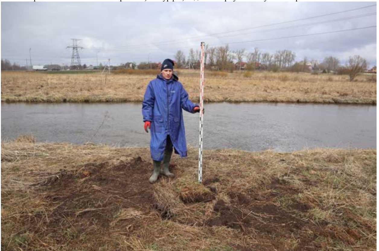
Рис.37. Ленинградская область. Гатчинский район. д.Вайя. Объект "Распределительный газопровод для газоснабжения жилых домов д. Вайя Гатчинского района Ленинградской области (1 этап, в том числе проектно-изыскательские работы)". Шурф 2, вид с юга после рекультивации.
