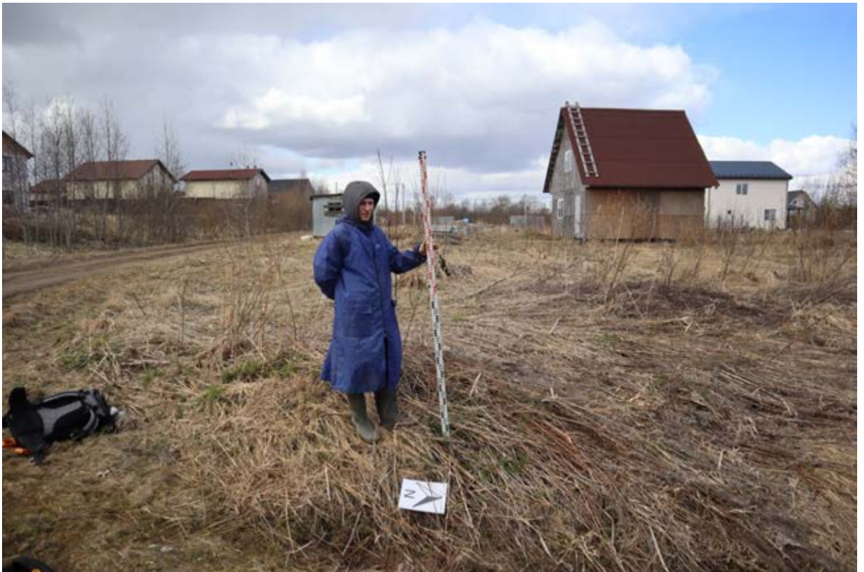
Рис.46. Ленинградская область. Гатчинский район. д.Вайя. Объект "Распределительный газопровод для газоснабжения жилых домов д. Вайя Гатчинского района Ленинградской области (1 этап, в том числе проектно-изыскательские работы)". Зачистка 5, вид на место закладки с востока.
