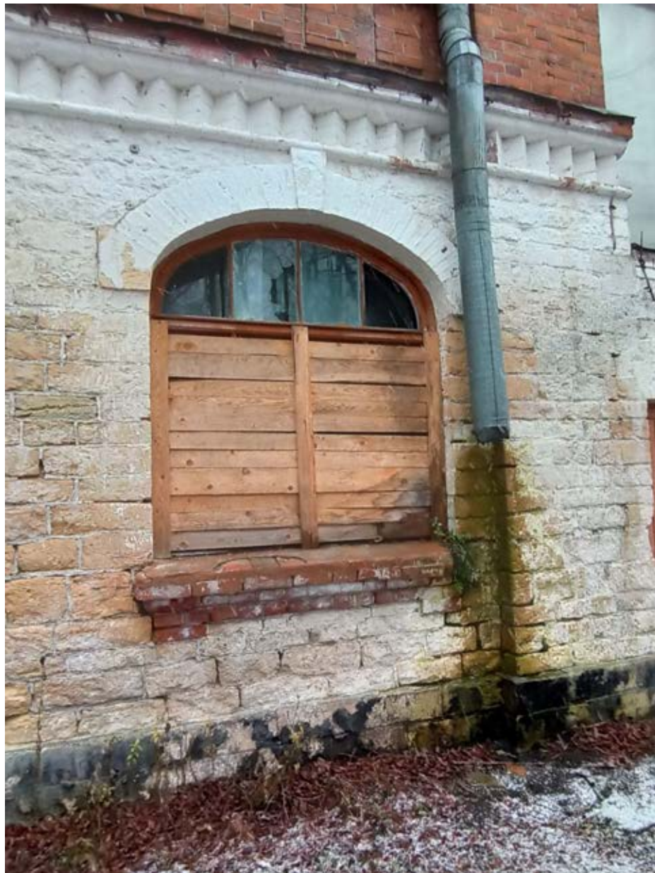
18. Фрагмент фасада здания сельскохозяйственного (земского) училища. Оформление оконного проема первого этажа. Вид с юго-запада
