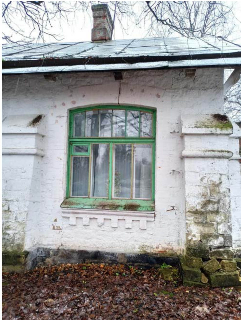
43. Фрагмент фасада здания каменной дачи (административное здание). Оформление оконного проема. Вид с северо-востока
