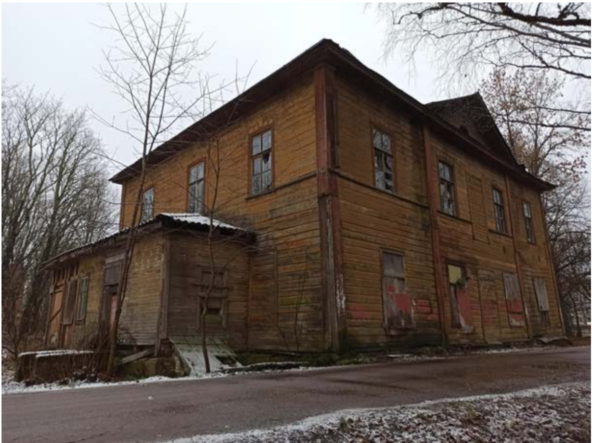
28. Вид здания жилого дома (деревянного) с севера
