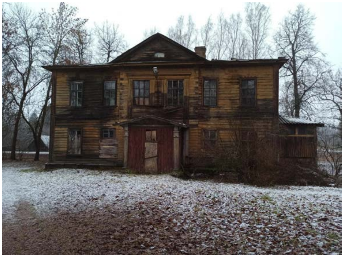
24. Фасад здания жилого дома (деревянного). Вид с юго-востока
