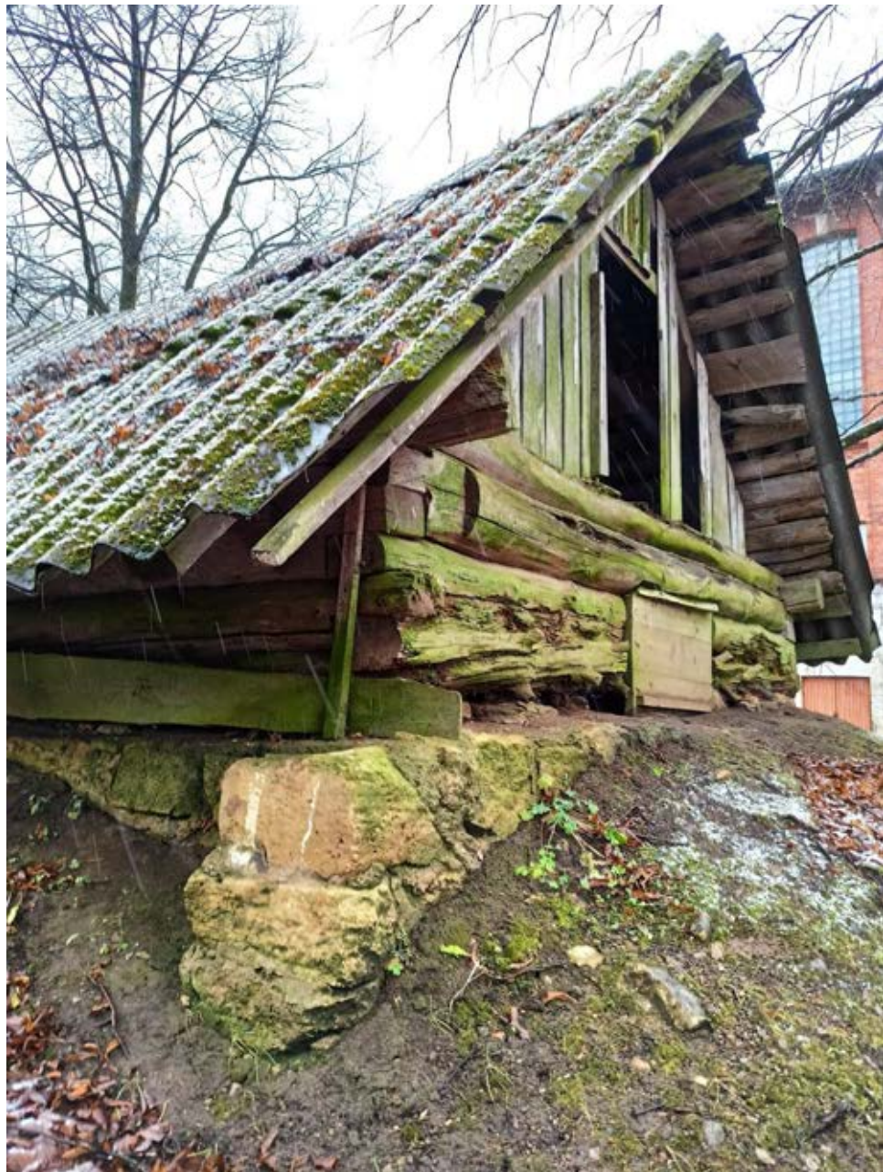
36. Вид хозяйственной постройки (погреба-ледника) (в составе парка) с востока
