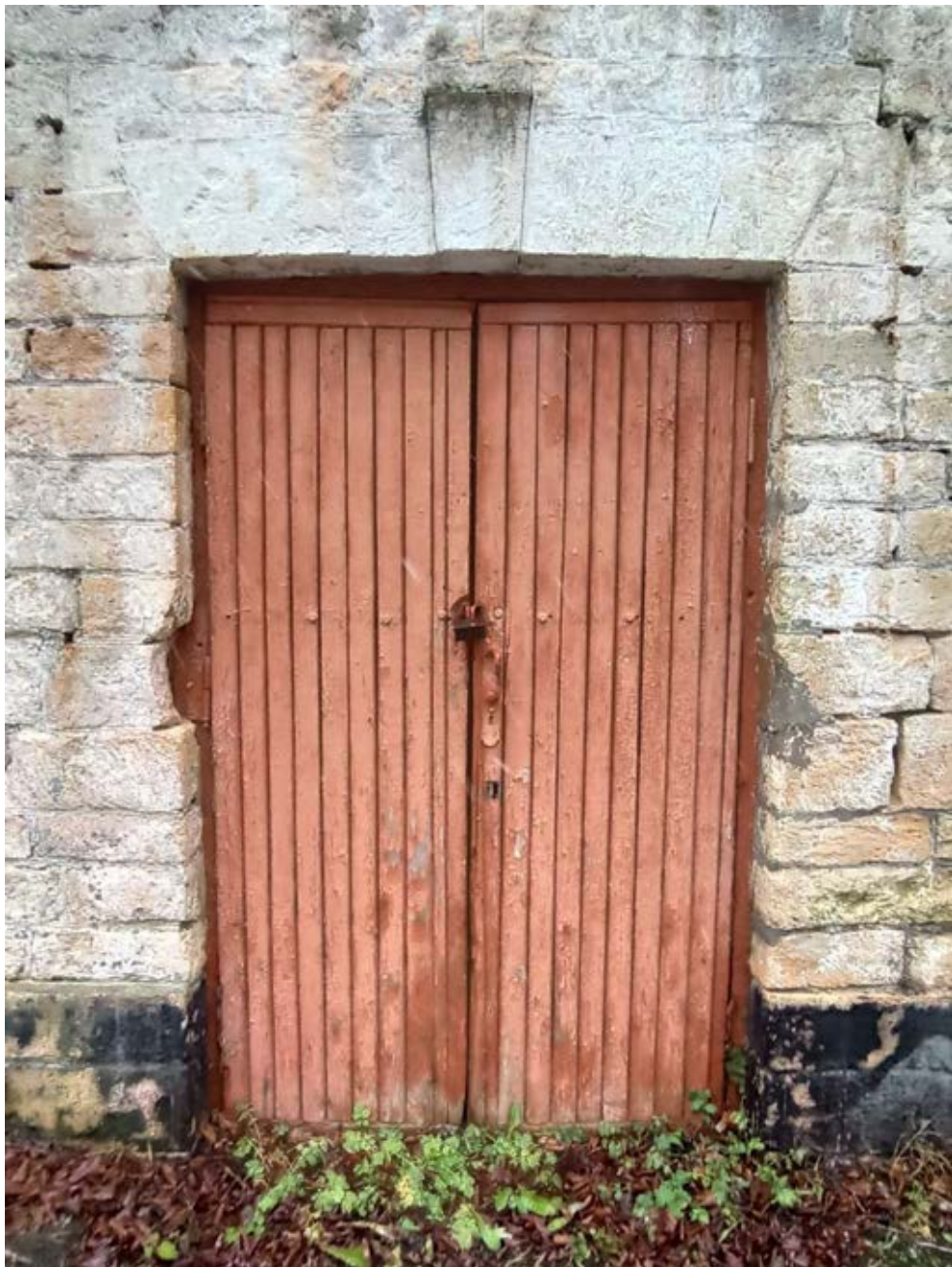
20. Фрагмент фасада здания сельскохозяйственного (земского) училища. Дверь входа. Вид с юго-востока
