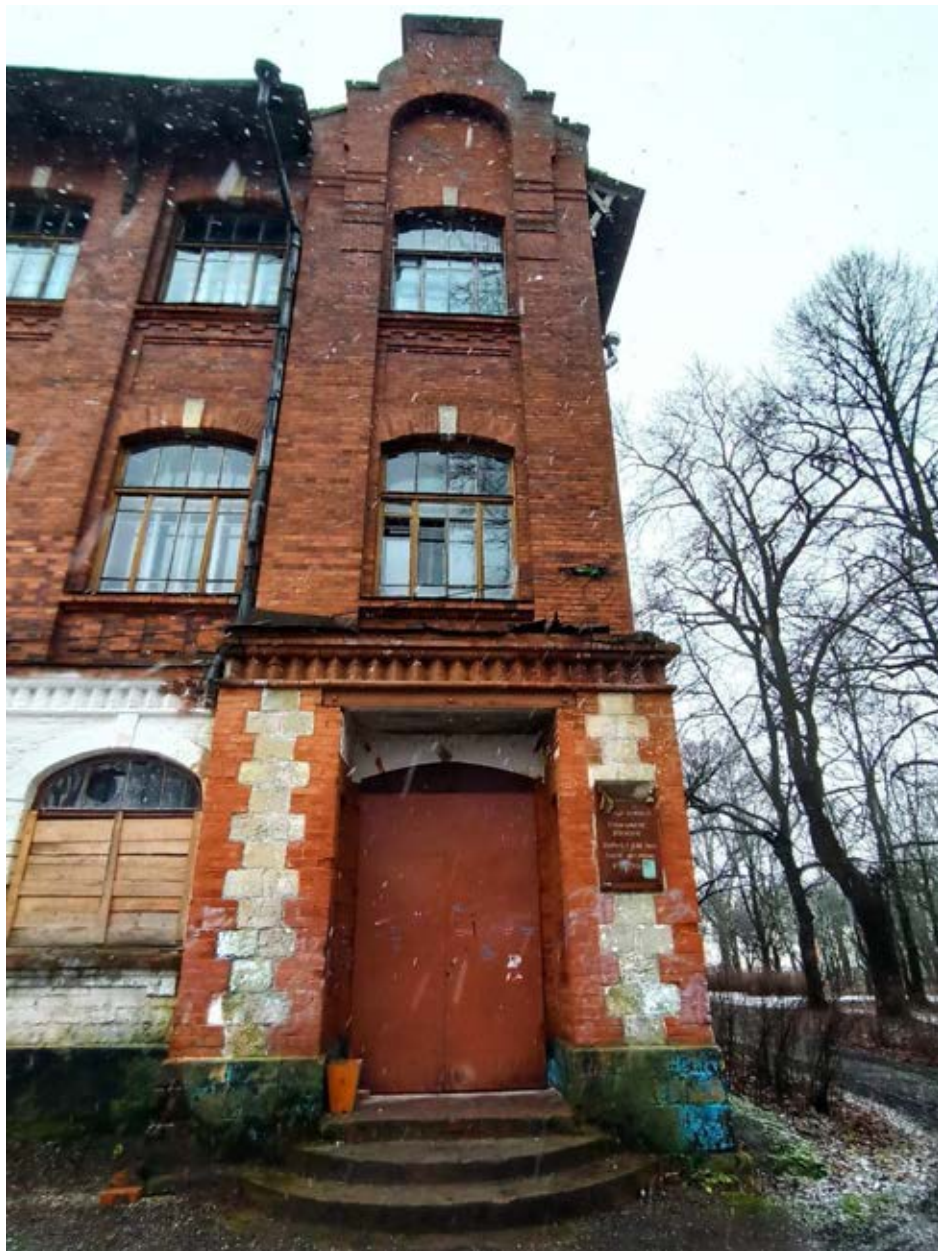
6. Фрагмент фасада здания сельскохозяйственного (земского) училища. Портал входа, оформление оконных проемов
