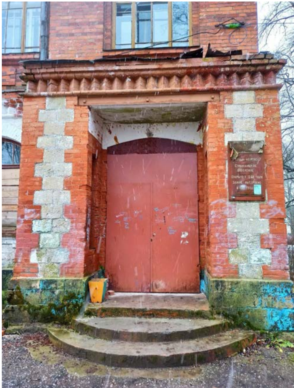
7. Фрагмент фасада здания сельскохозяйственного (земского) училища. Портал входа
