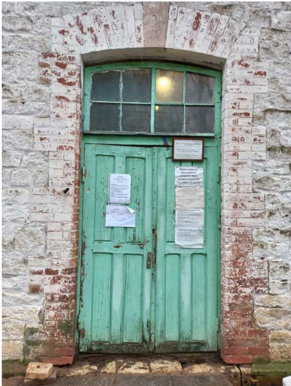
52. Фрагмент фасада здания каменной дачи (административное здание) . Дверь входа. Вид с юго-запада
