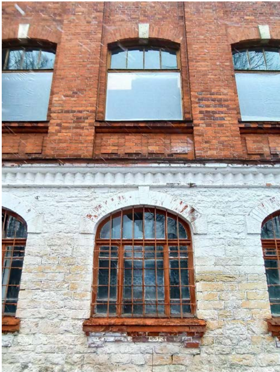
16. Фрагмент фасада здания сельскохозяйственного (земского) училища. Оформление оконных проемов первого и второго этажа. Вид с юго-востока
