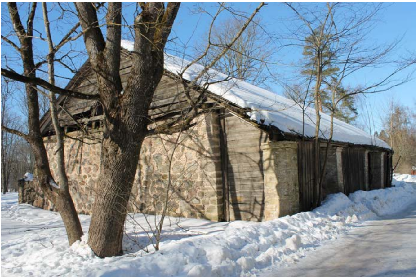
55. Служебная постройка (каретный сарай). Вид с востока
