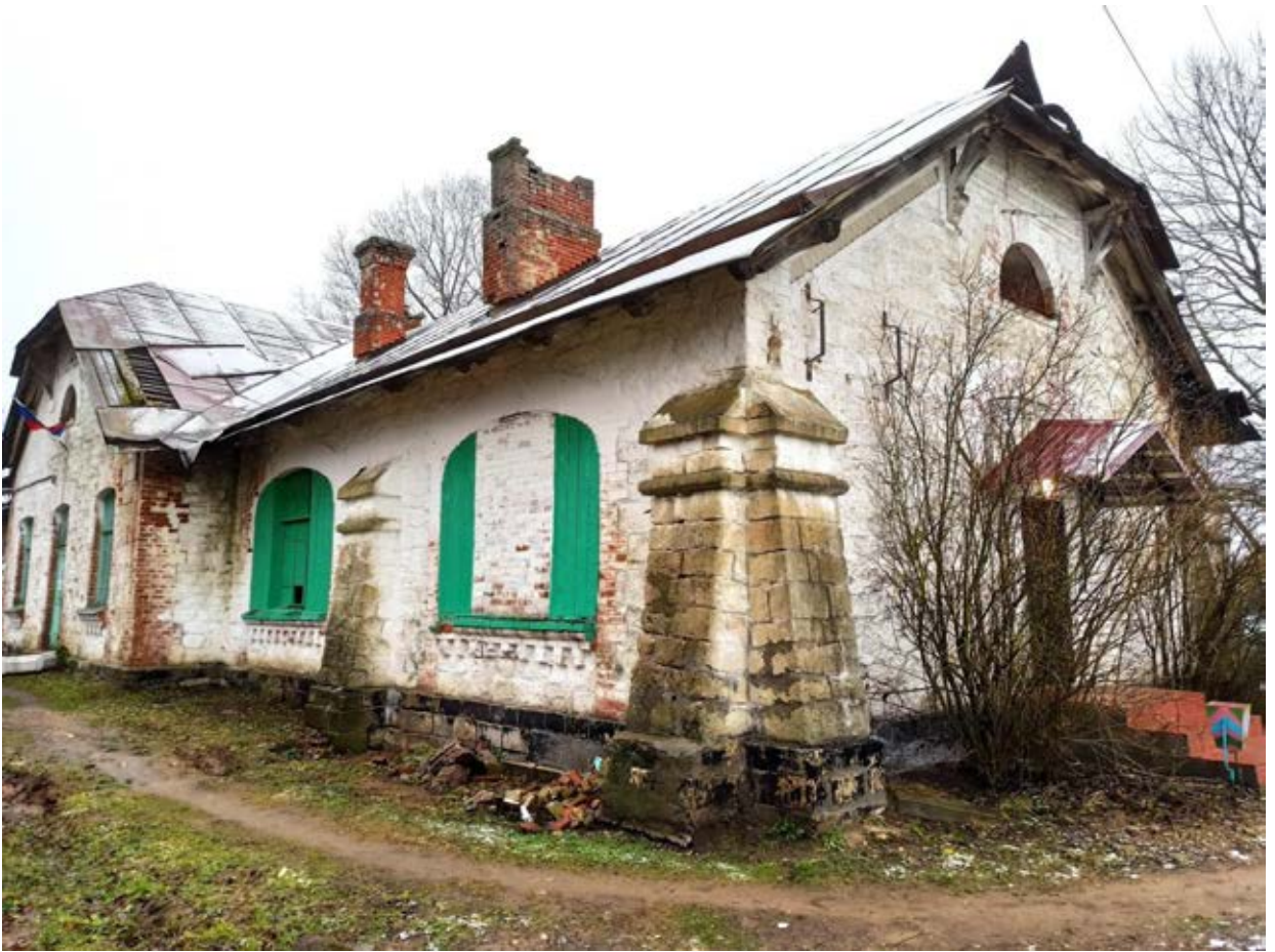
49. Вид здания каменной дачи (административное здание) с юга
