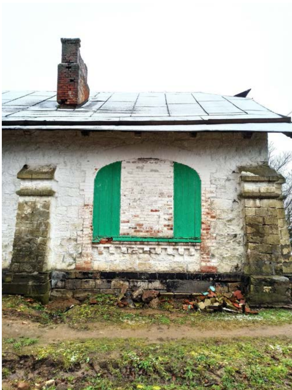
50. Фрагмент фасада здания каменной дачи (административное здание). Оформление оконного проема. Вид с юго-запада
