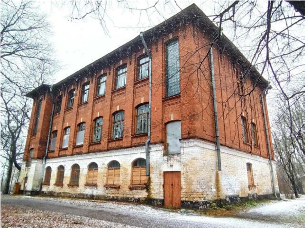
19. Вид здания сельскохозяйственного (земского) училища с востока
