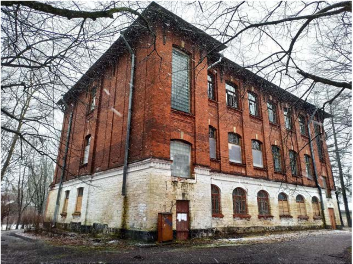
13. Вид здания сельскохозяйственного (земского) училища с юго-запада
