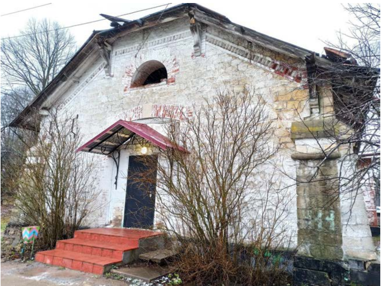
47. Фрагмент фасада здания каменной дачи (административное здание). Вид с юго-востока
