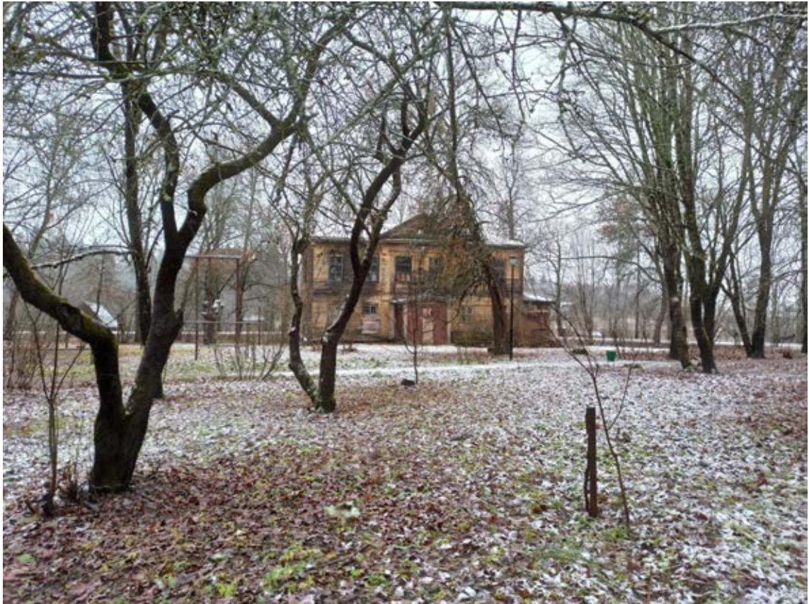
23. Общий вид жилого дома (деревянного). Вид с юго-востока
