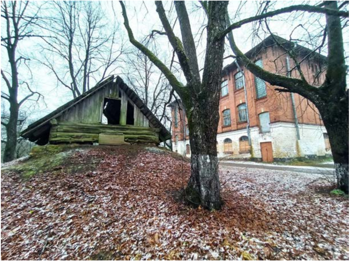
39. Общий вид хозяйственной постройки (погребаледника) (в составе парка) и здания сельскохозяйственного (земского) училища с востока
