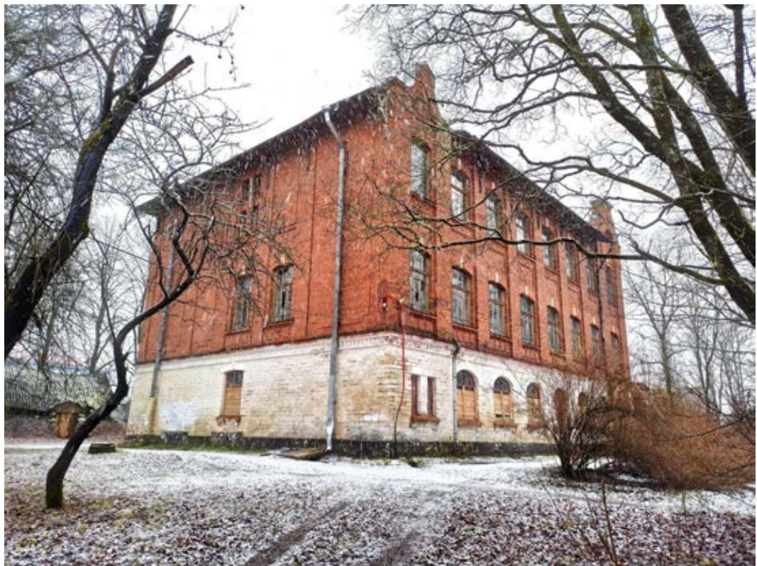
2. Вид здания сельскохозяйственного (земского) училища с северо-востока
