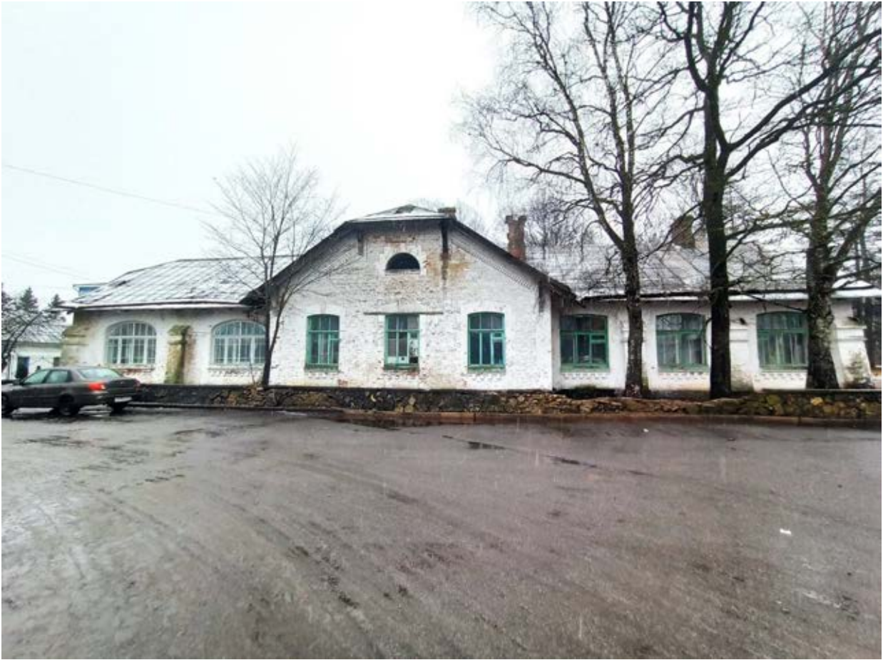
44. Вид здания каменной дачи (административное здание) с северо-востока
