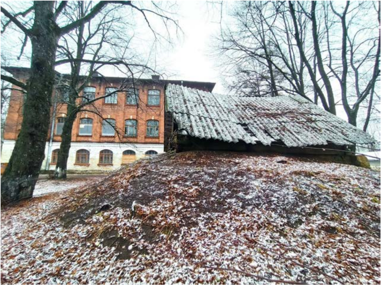
35. Общий вид хозяйственной постройки (погреба-ледника) (в составе парка) и здания сельскохозяйственного (земского) училища с юго-востока
