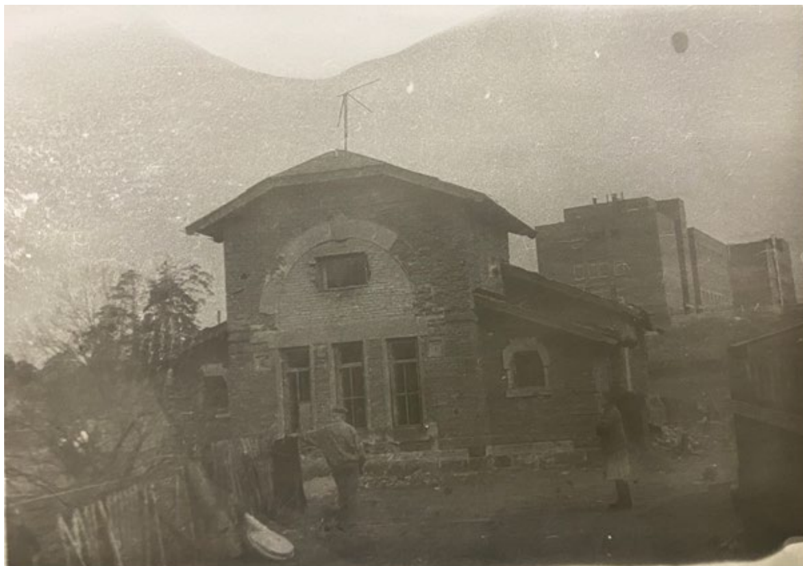
19. г. Сосновый Бор. Насосная станция. 1992 г. // Источник: Материалы архива Комитета Ленинградской области (инв. № 1730-5)
