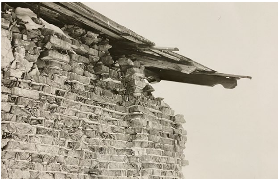
23. г. Сосновый Бор. Насосная станция. // Источник: Материалы архива Комитета Ленинградской области (инв. № 1730-9)
