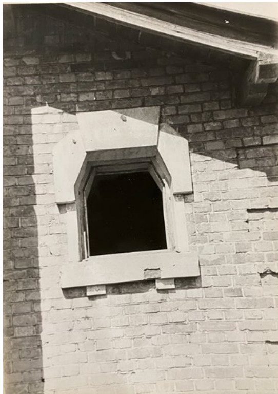
16. Ленинградская обл., Ломоносовский р-н, г. Сосновый Бор, ул. Речная. Насосная станция Калищенской ж/д. 1970-1980-е гг. // Источник: Материалы архива Комитета Ленинградской области (инв. № 6293)
