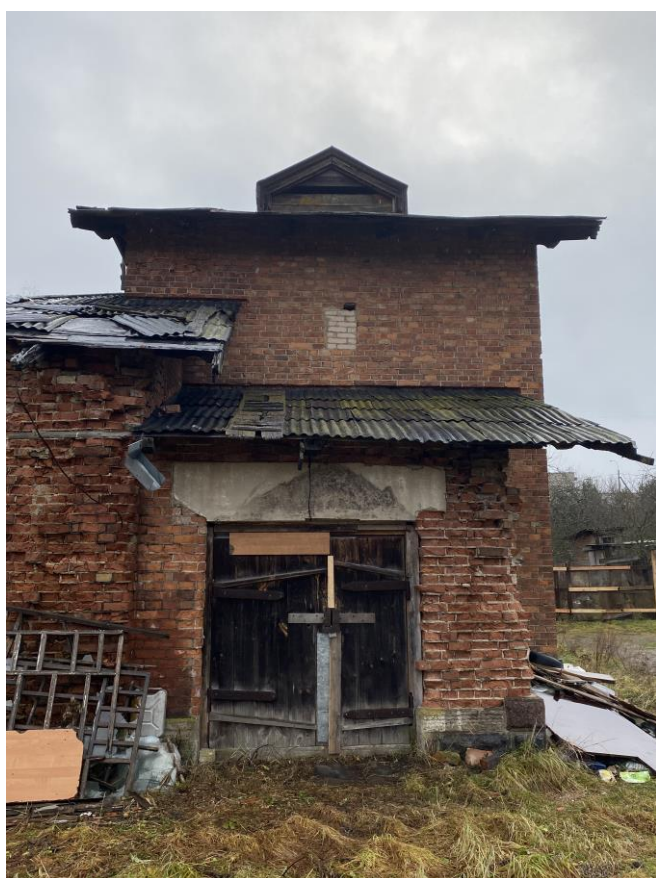
Фото 10. Фрагмент западного фасада. Дверной проем тамбура с деревянным двусторвчатым заполнением с металлическим накладками на петли.
