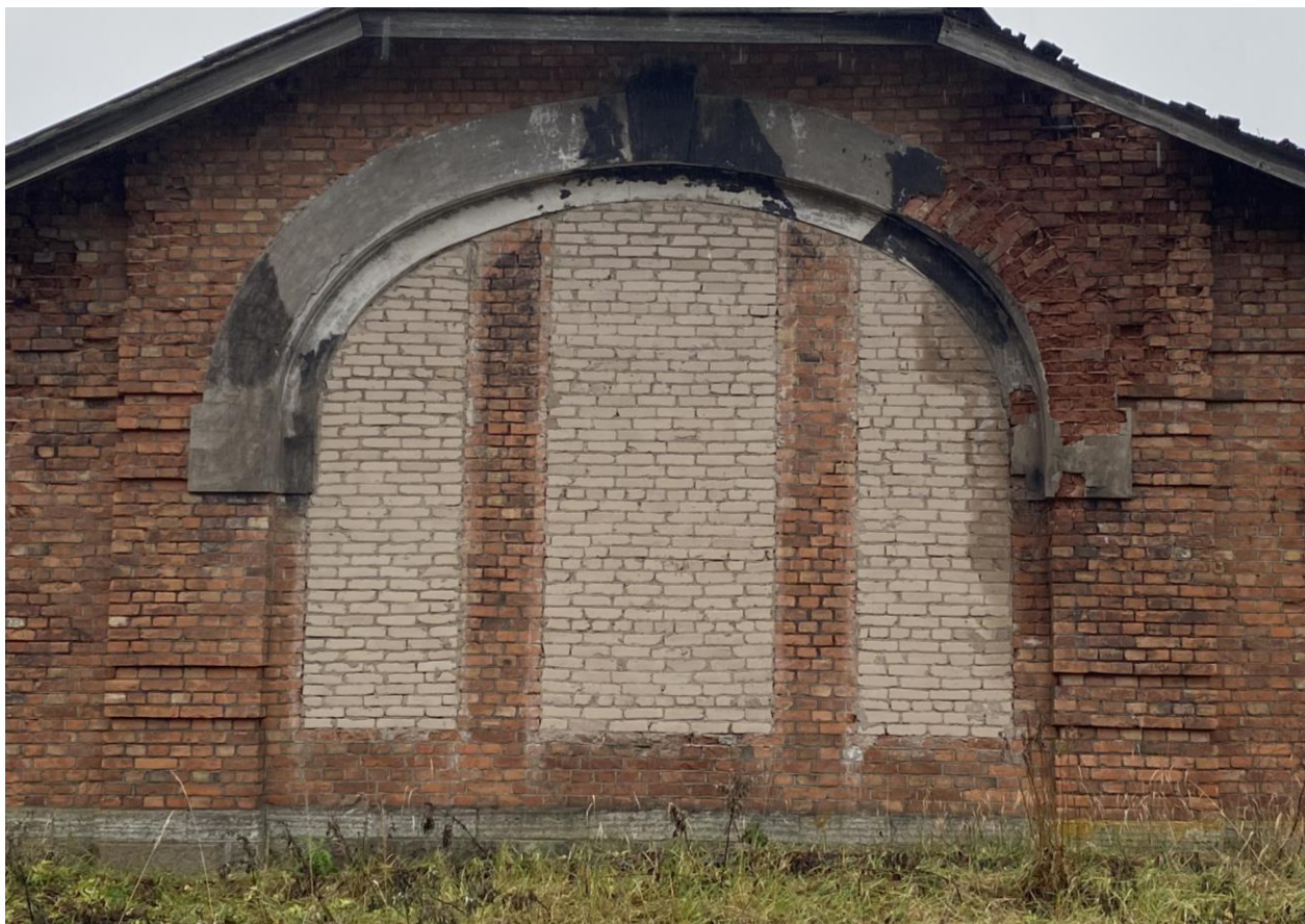
Фото 17. Раскреповка центральной части северного фасада; оформление оконного проема штукатурным наличником на импостах с замковым камнем.
