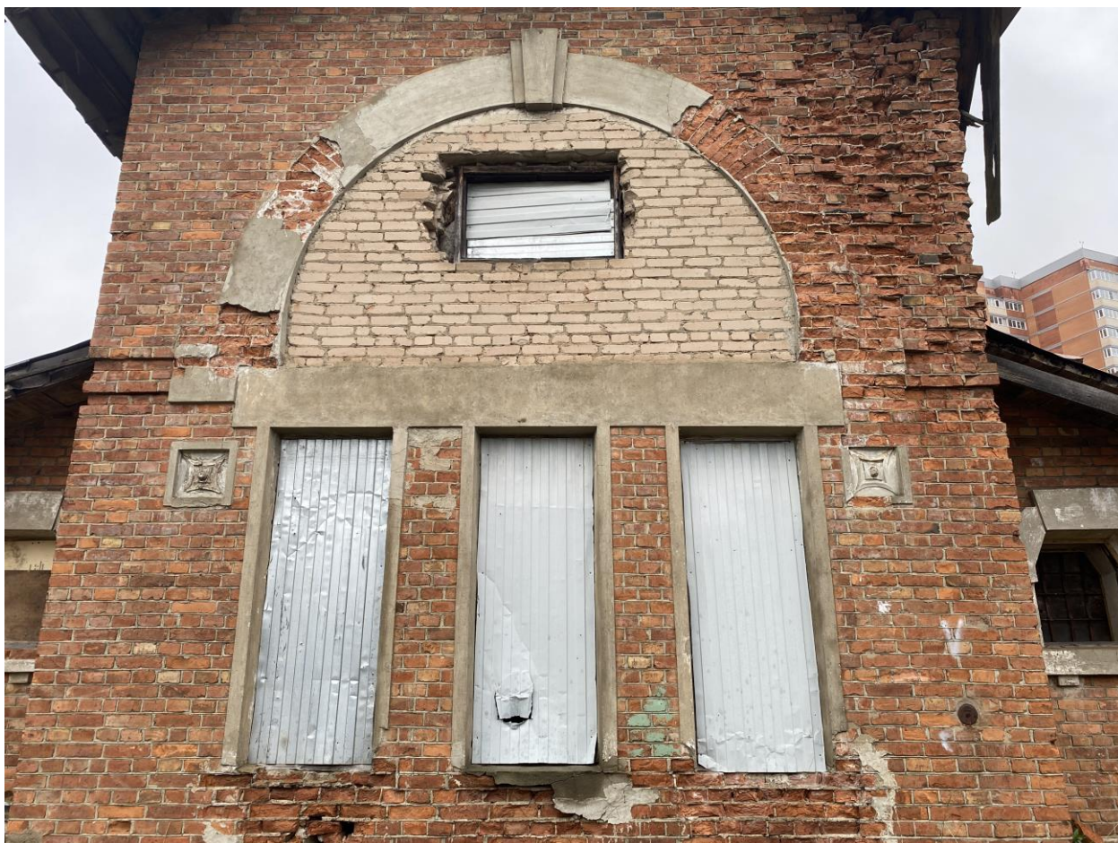
Фото 14. Оформление оконных проемов южного фасада.
