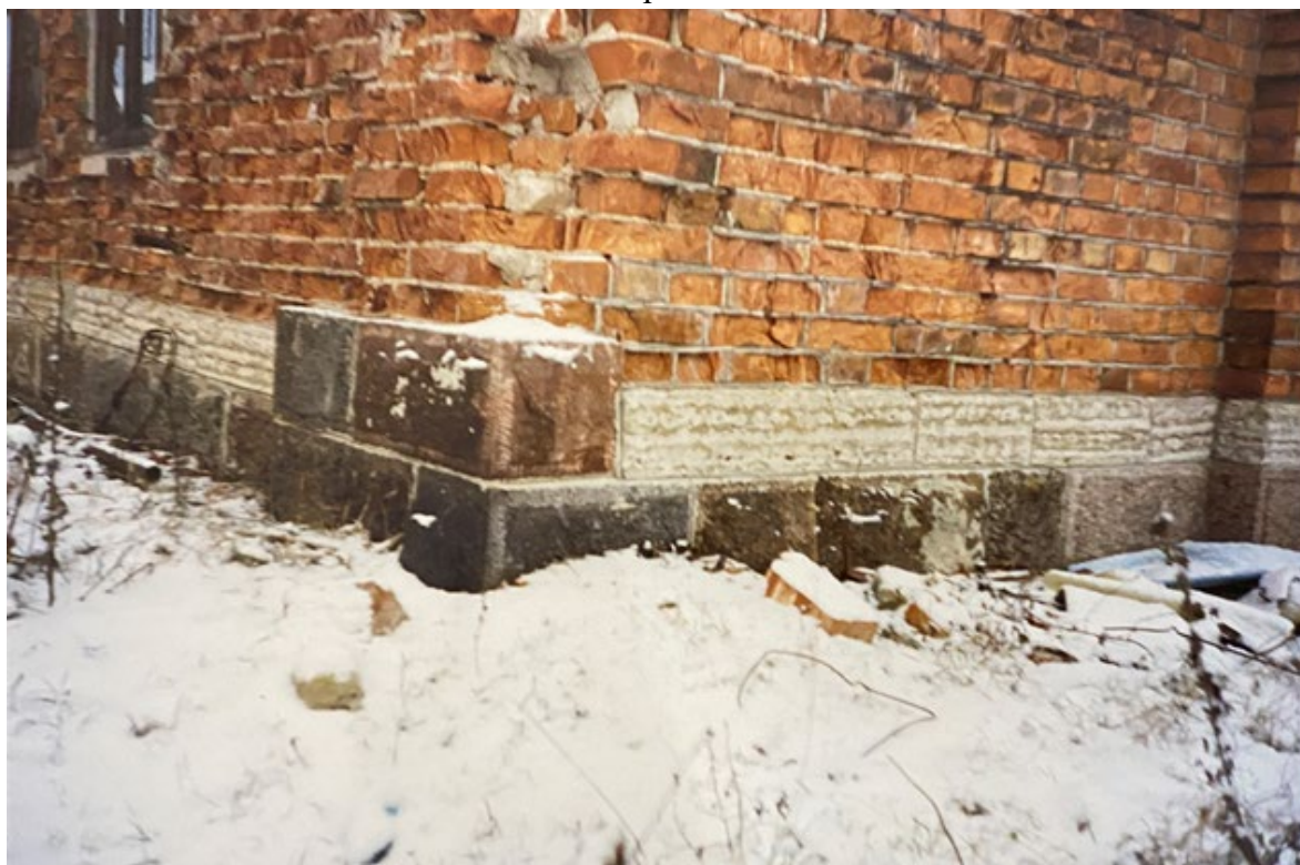
32. г. Сосновый Бор. Насосная станция. // Источник: Материалы архива Комитета Ленинградской области
