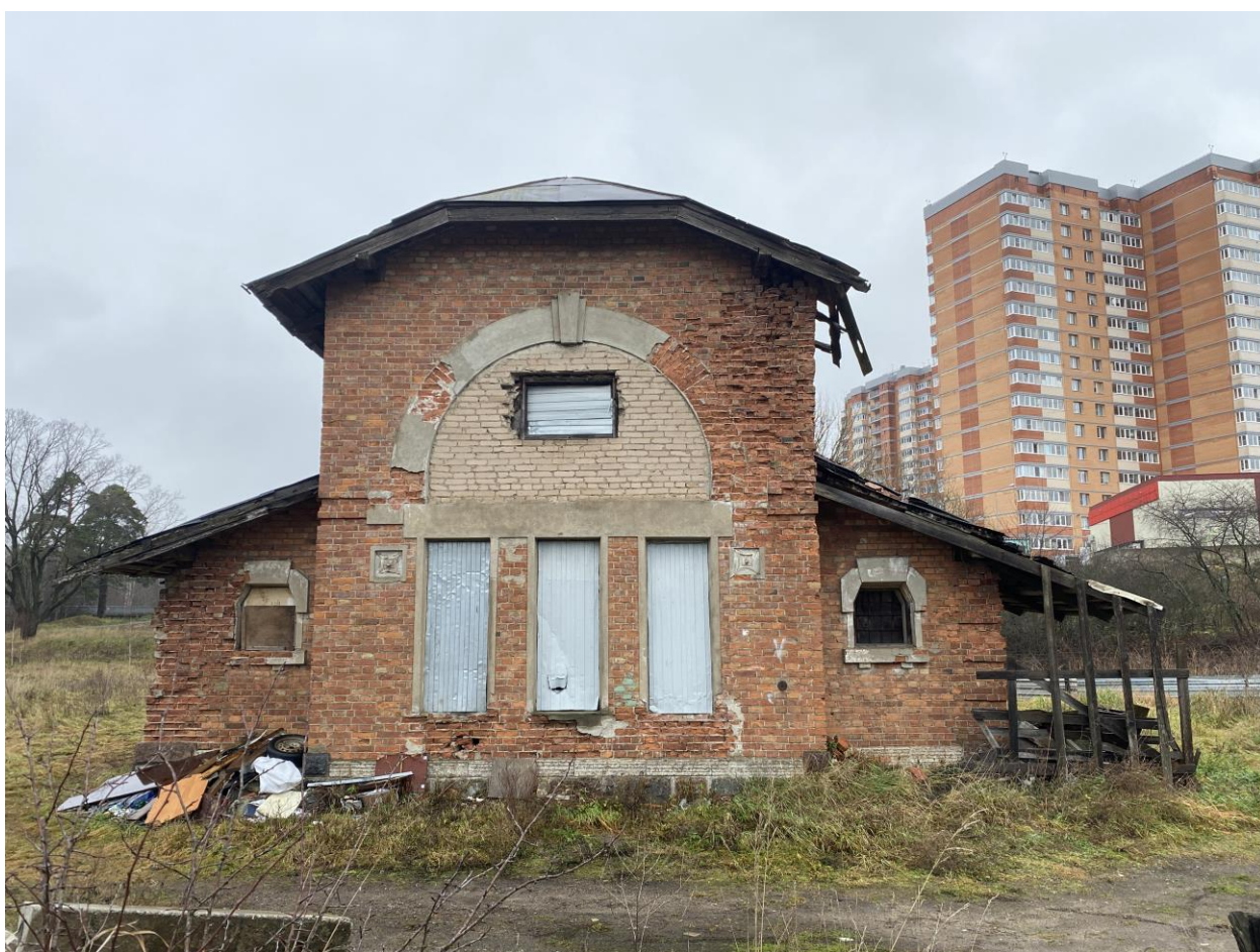
Фото 6. Южный фасад здания.
