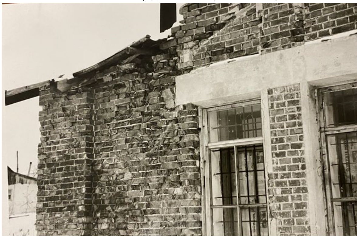
22. г. Сосновый Бор. Насосная станция. // Источник: Материалы архива Комитета Ленинградской области (инв. № 1730-8)
