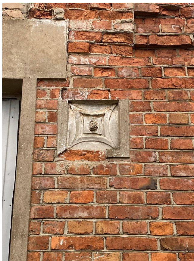
Фото 16. Декоративная штукатурная розетка.
