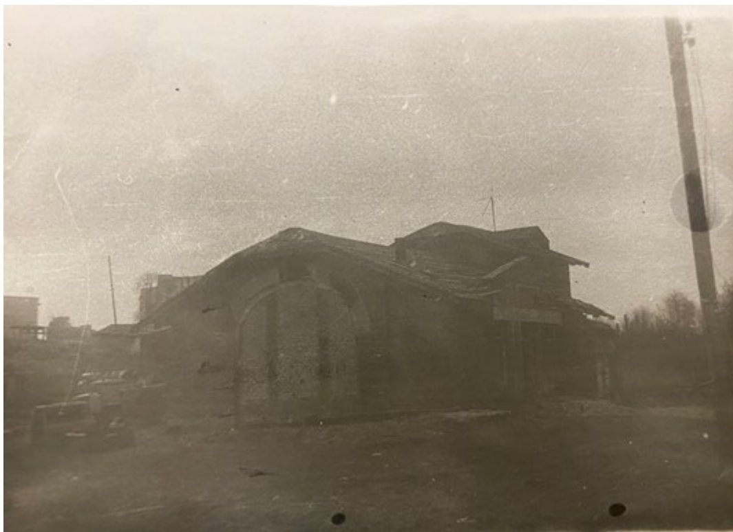
17. г. Сосновый Бор. Насосная станция. 1992 г. // Источник: Материалы архива Комитета Ленинградской области (инв. № 1730-3)
