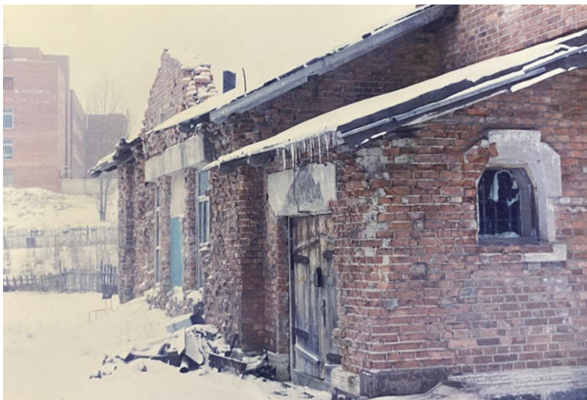
27. г. Сосновый Бор. Насосная станция. // Источник: Материалы архива Комитета Ленинградской области
