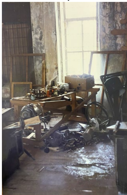
36. г. Сосновый Бор. Насосная станция. // Источник: Материалы архива Комитета Ленинградской области
