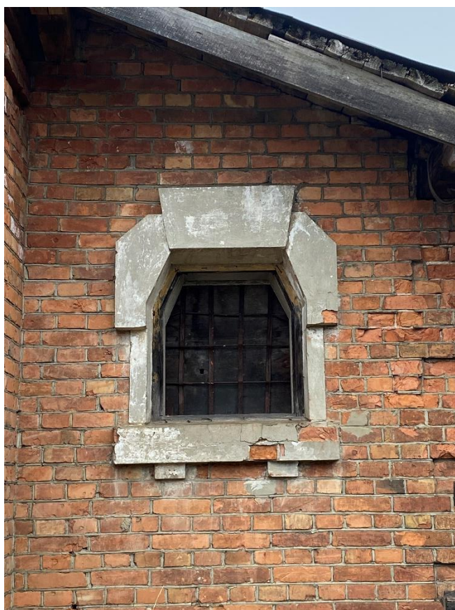
Фото 15. Оконный проем восточного тамбура, оформленный фигурным штукатурным наличником.
