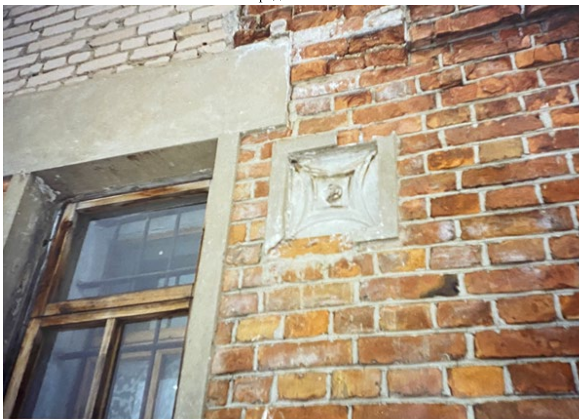
40. г. Сосновый Бор. Насосная станция. // Источник: Материалы архива Комитета Ленинградской области
