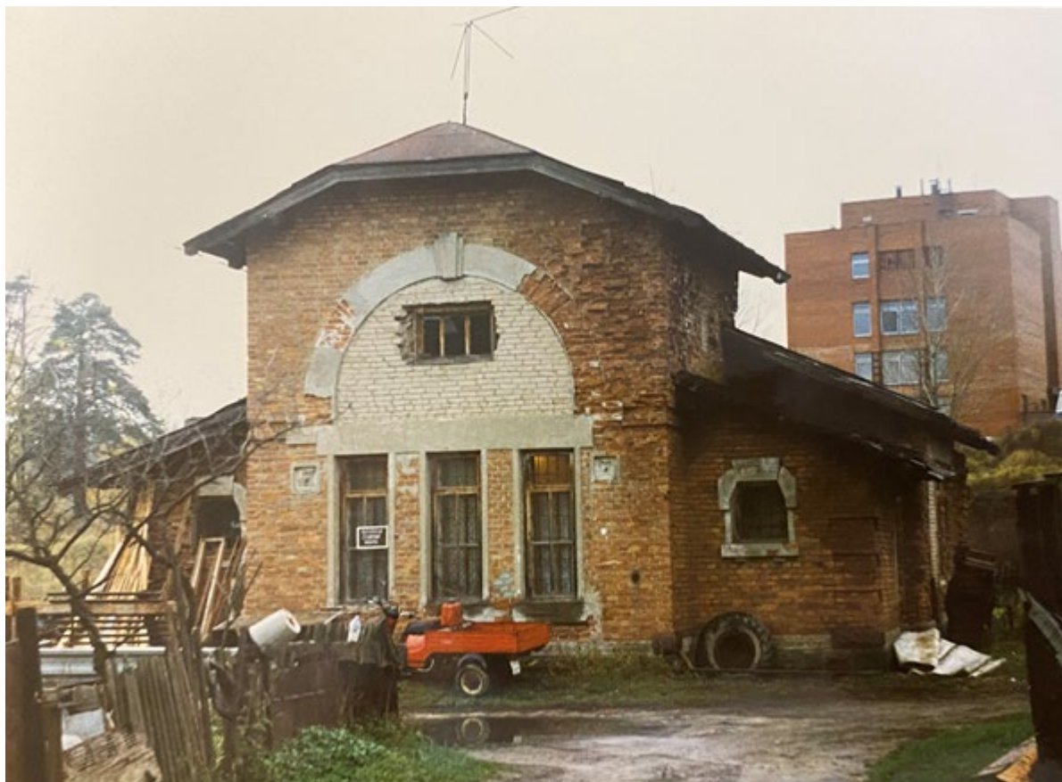
45. г. Сосновый Бор. Насосная станция. // Источник: Материалы архива Комитета Ленинградской области
