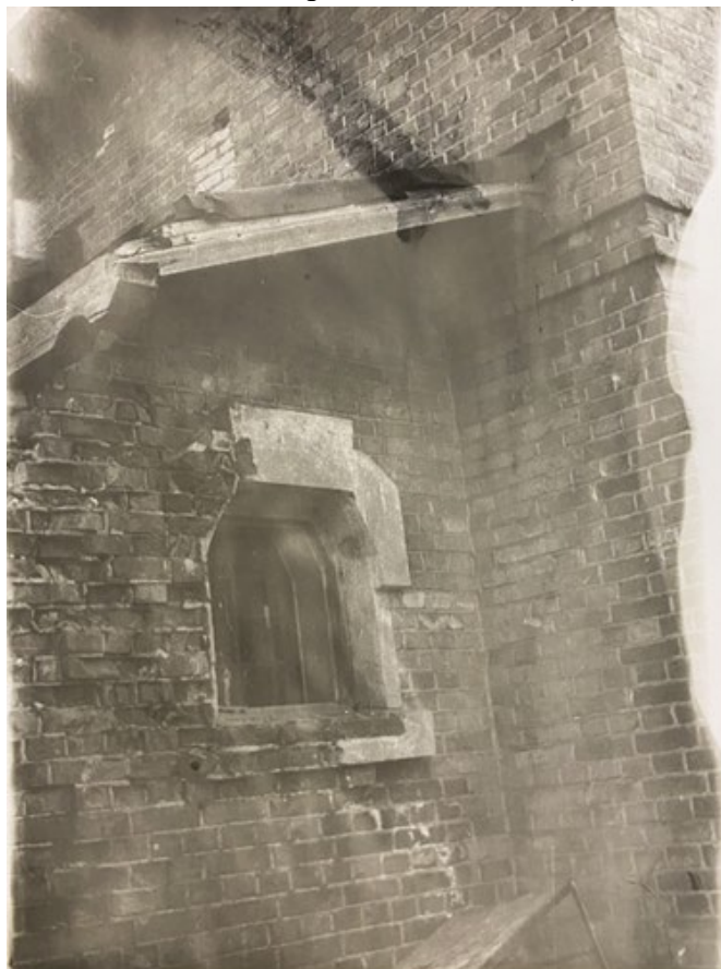
18. г. Сосновый Бор. Насосная станция. 1992 г. // Источник: Материалы архива Комитета Ленинградской области (инв. № 1730-4)
