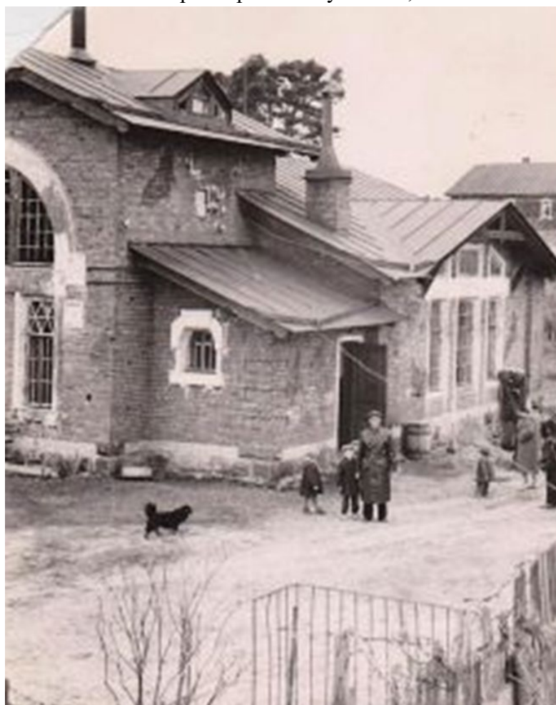
14. Здание водокачки. 60-е годы XX века // Источник: http://wikimapia.org/
