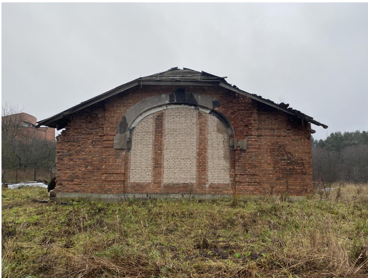
Фото 2. Северный фасад здания.
