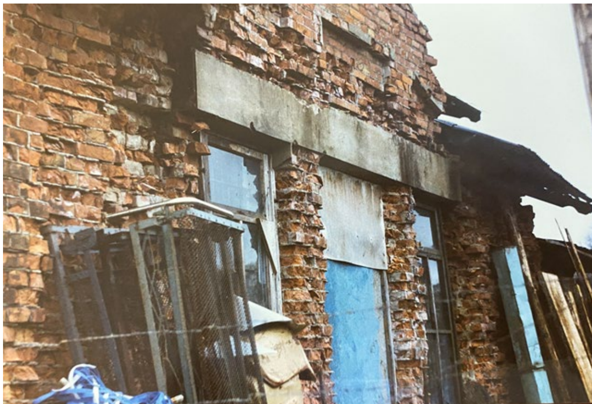
43. г. Сосновый Бор. Насосная станция. // Источник: Материалы архива Комитета Ленинградской области
