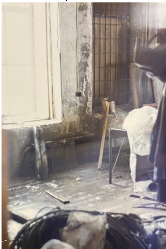
35. г. Сосновый Бор. Насосная станция. // Источник: Материалы архива Комитета Ленинградской области
