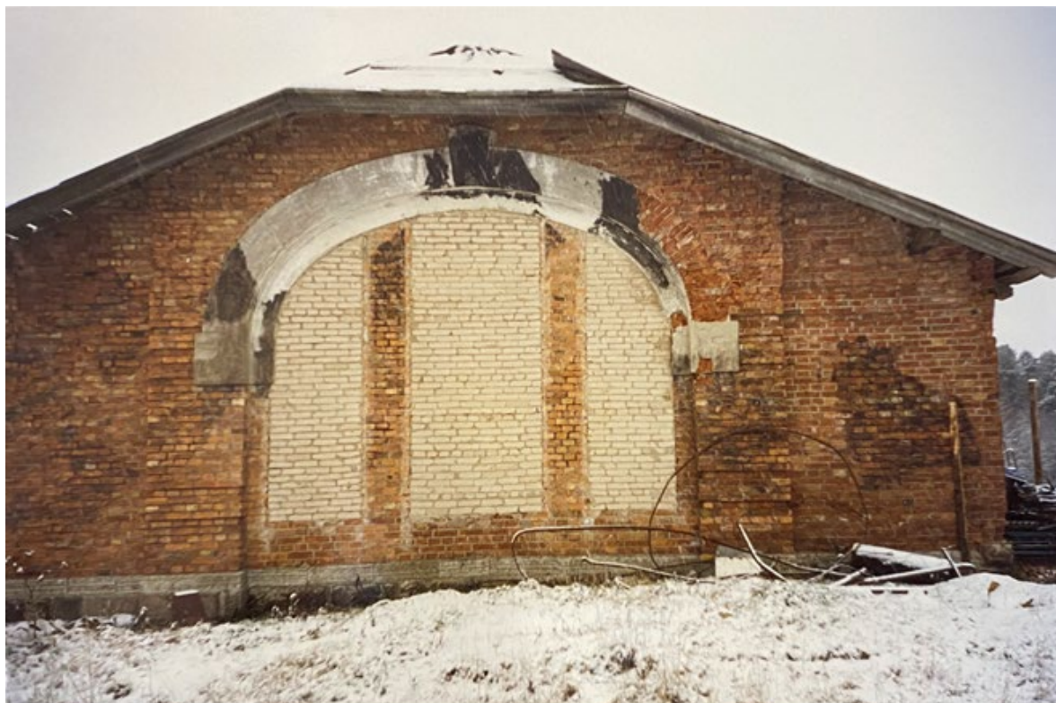
29. г. Сосновый Бор. Насосная станция. // Источник: Материалы архива Комитета Ленинградской области
