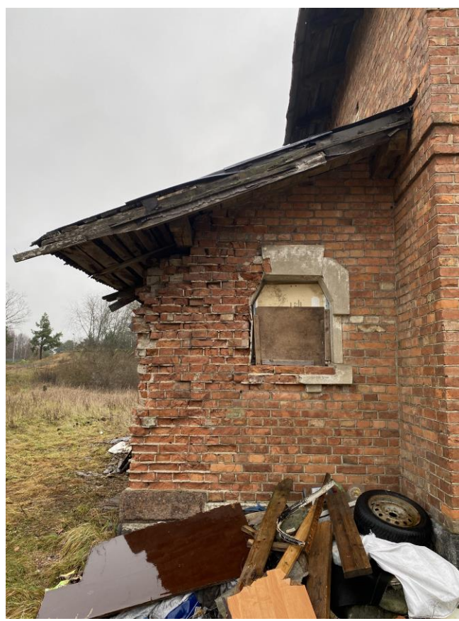
Фото 11. Оконный проем западного тамбура, оформленный фигурным штукатурным наличником.
