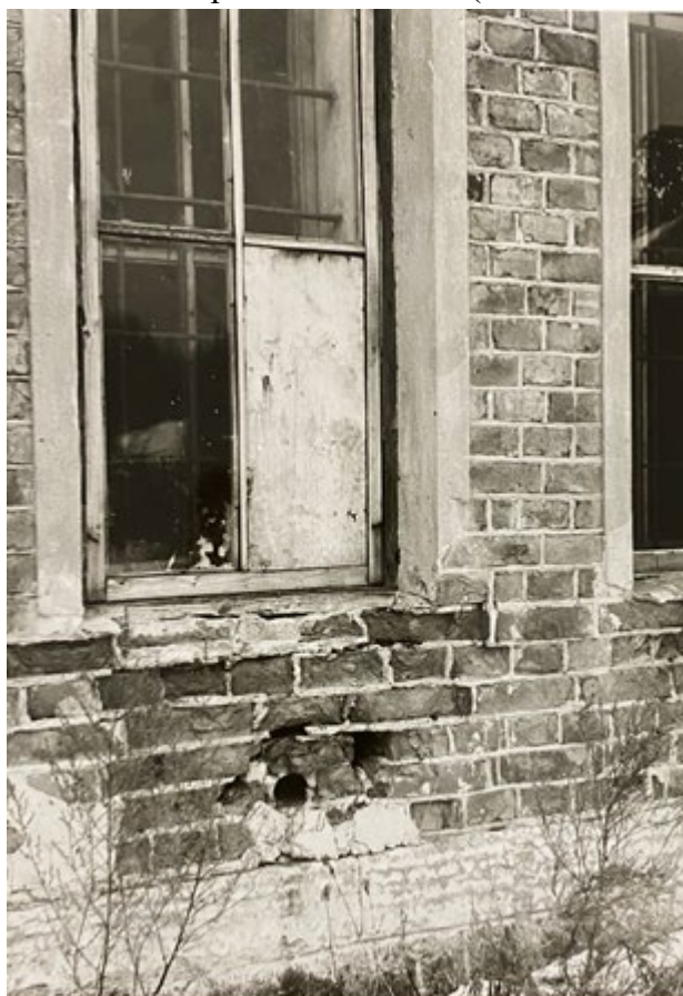
24. г. Сосновый Бор. Насосная станция. // Источник: Материалы архива Комитета Ленинградской области (инв. № 1730-10)
