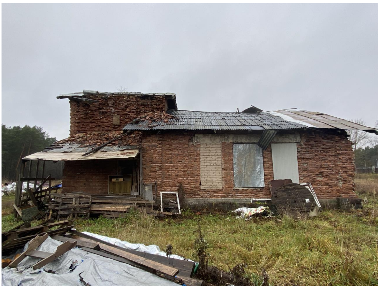
Фото 4. Восточный фасад здания.
