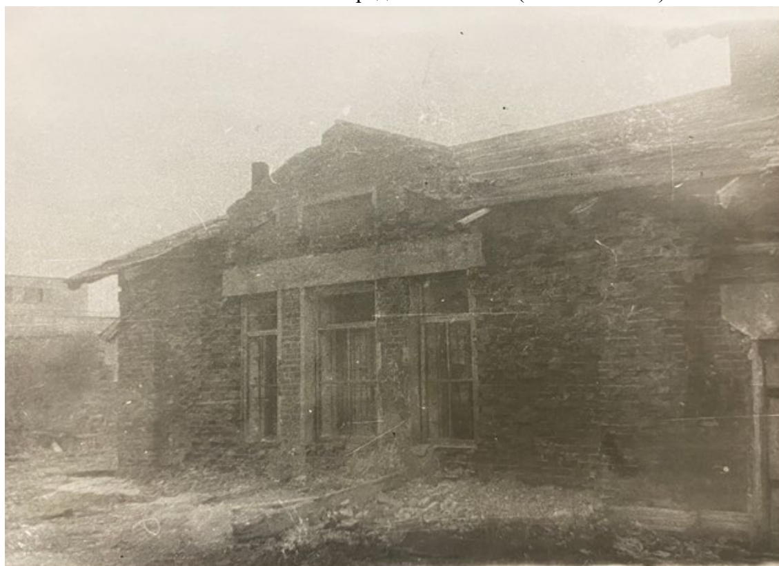
20. г. Сосновый Бор. Насосная станция. 1992 г. // Источник: Материалы архива Комитета Ленинградской области (инв. № 1730-6)
