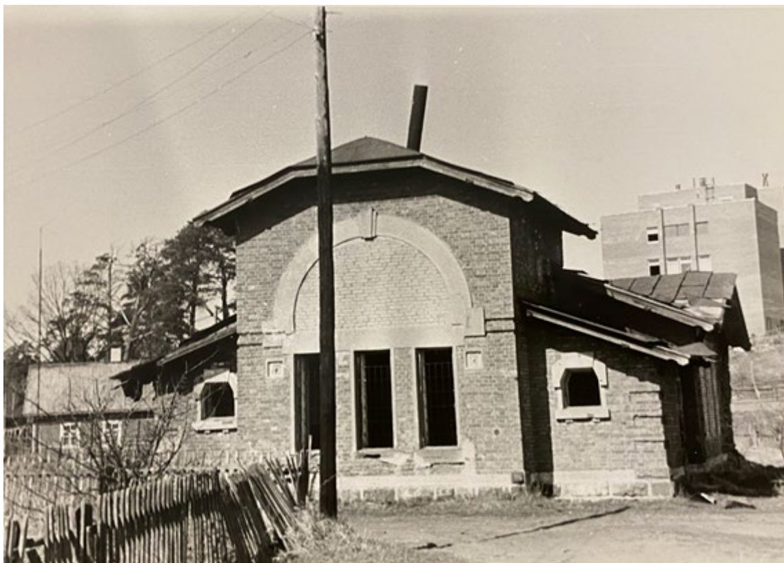
15. Ленинградская обл., Ломоносовский р-н, г. Сосновый Бор, ул. Речная. Насосная станция Калищенской ж/д. 1970-1980-е гг. // Источник: Материалы архива Комитета Ленинградской области (инв. № 6292).
