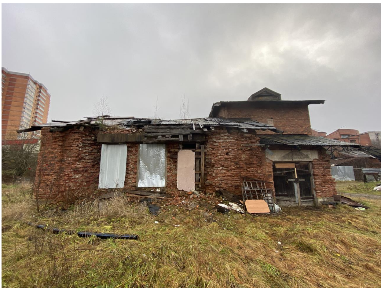
Фото 8. Западный фасад здания.
