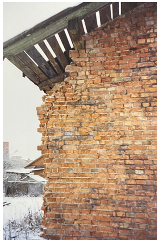
34. г. Сосновый Бор. Насосная станция. // Источник: Материалы архива Комитета Ленинградской области
