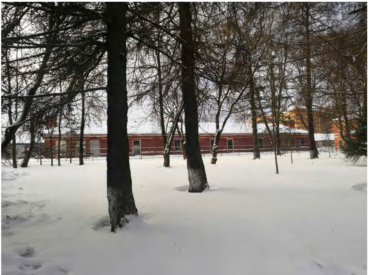
Фото.148. Здание мастерской (западное). Вид на северо-восточный фасад.
