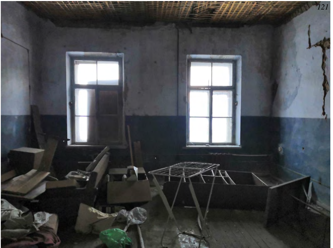
Фото.53. Казарма (г.Гатчина, проспект 25 Октября, 44). Западная часть. Вид на помещение. Второй этаж.
