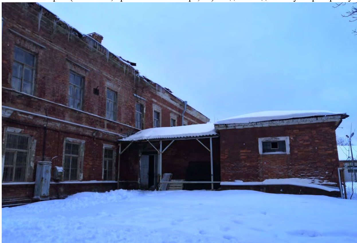
Фото.40. Казарма (г.Гатчина, проспект 25 Октября, 44). Вид на северо-западный фасад. Фрагмент.
