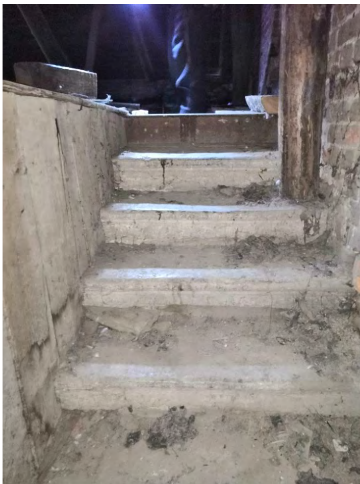
Фото.69. Казарма (г.Гатчина, проспект 25 Октября, 44). Вид на лестницу, ведущую на чердак.
