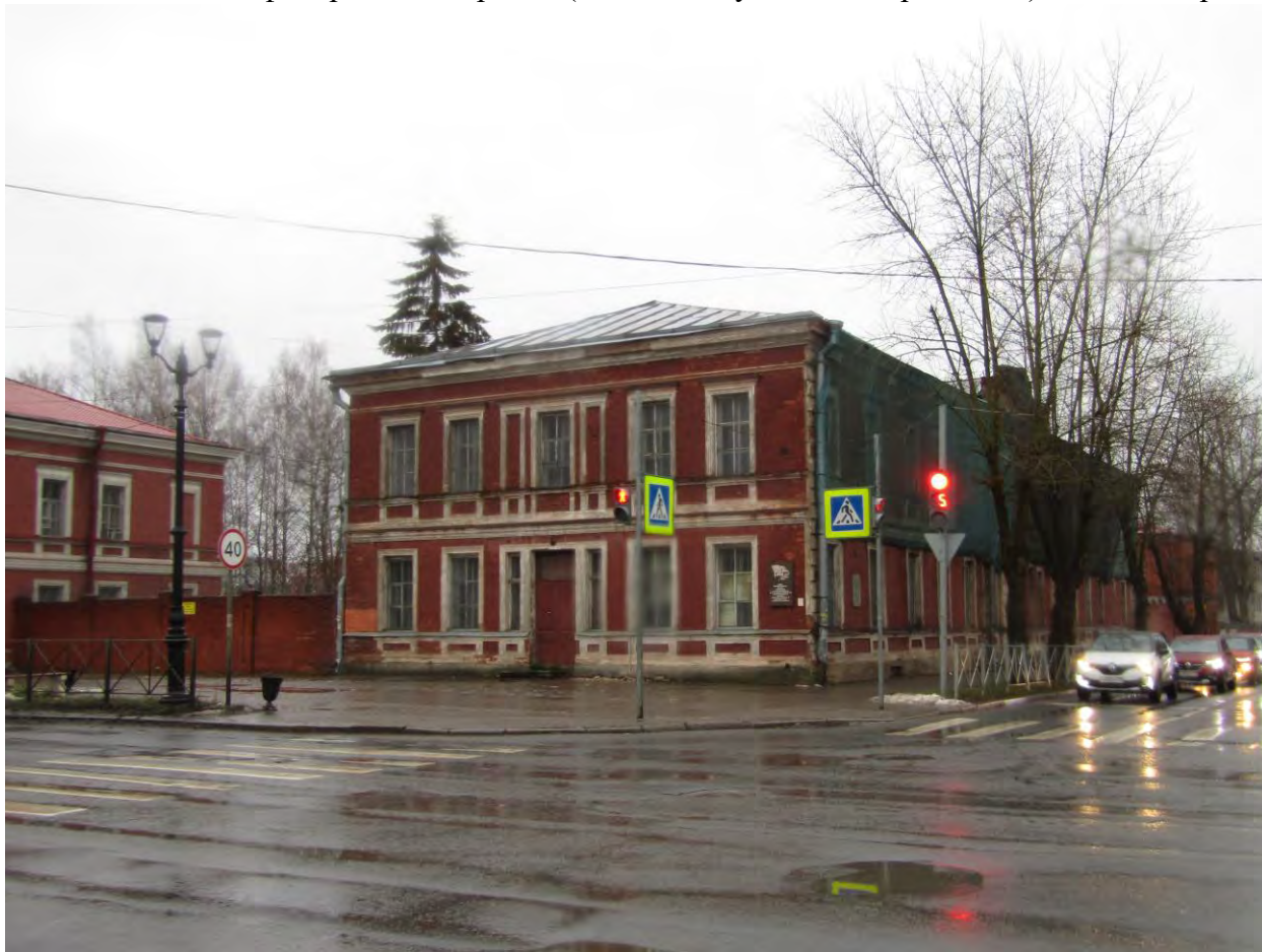
Фото.12. Здание офицерского собрания (г. Гатчина, улица 7-й Армии, 8А). Вид на торцевой северо-западный фасад.
