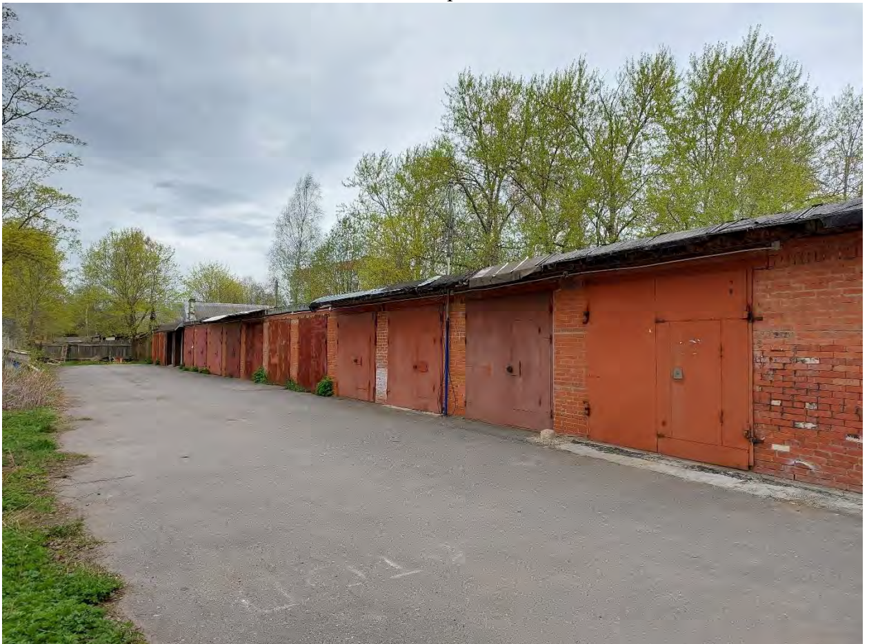
Фото.276. Вид на гаражи внутреннего двора здания по адресу: . Гатчина, ул. Рощинская, 4.
