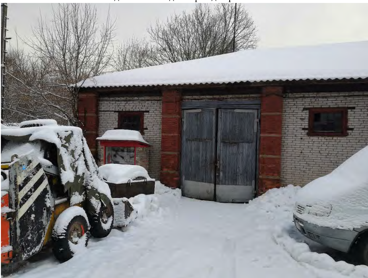
Фото.155. Артиллерийский сарай (расположено на внутренней территории военной части). Вид на юго-западный фасад. Фрагмент.
