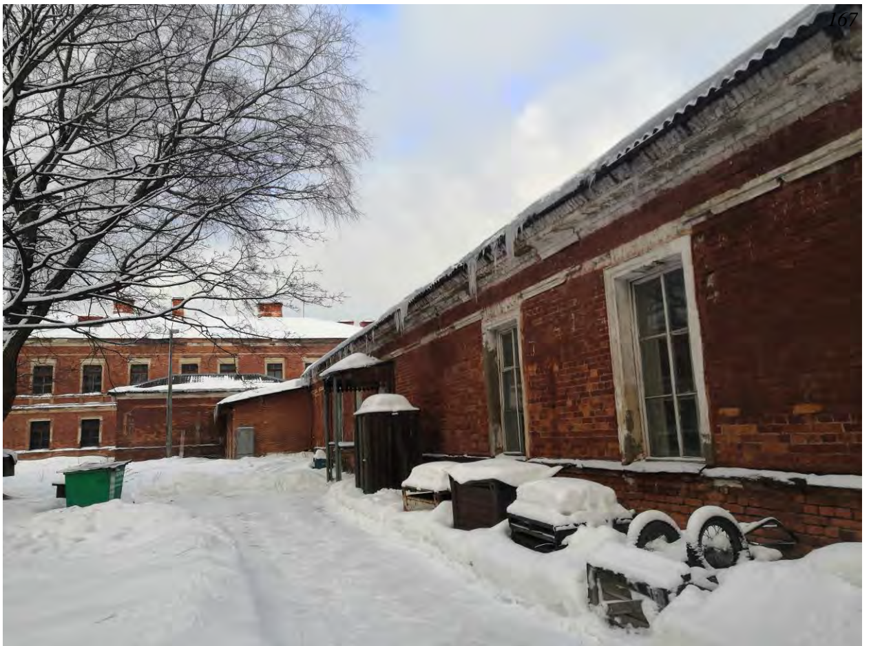
Фото.138. Здание мастерской (восточное). Вид на юго-западный фасад. Фрагмент.
