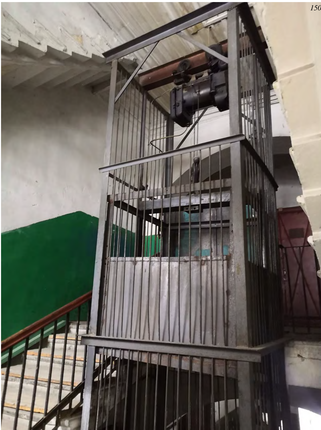
Фото.106. Казарма (расположена в центре территории военной части). Вид на центральную ЛК. Второй этаж.
