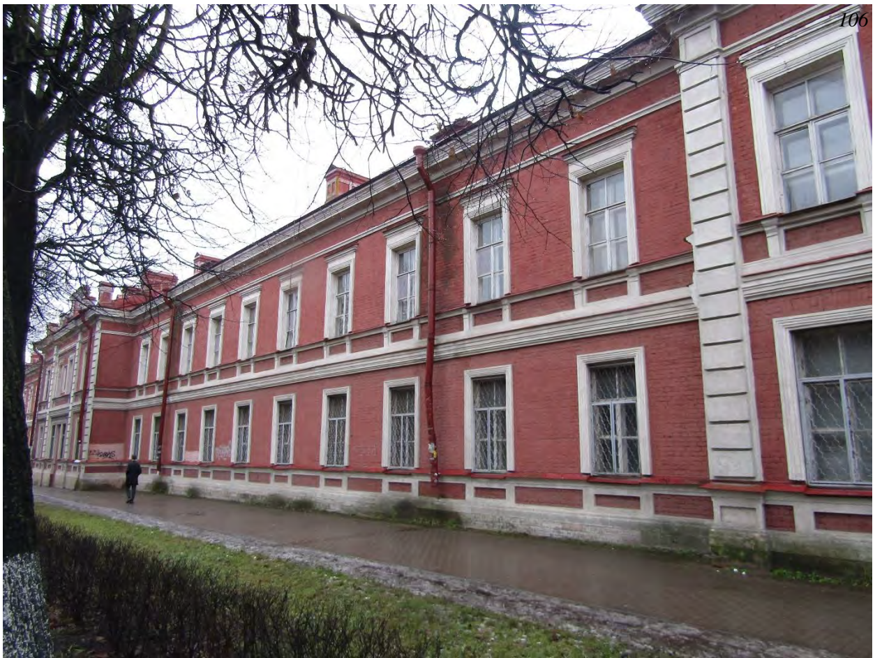
Фото.23. Казарма (г.Гатчина, проспект 25 Октября, 55). Вид на северо-западный фасад. Фрагмент.
