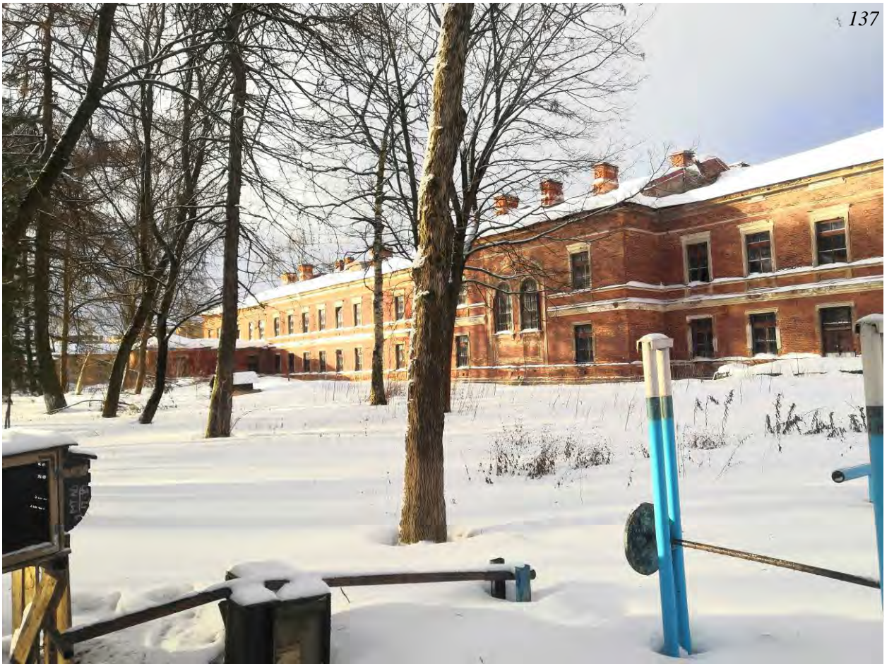
Фото.84. Казарма (расположена в центре территории военной части). Вид на юго-восточный фасад. Фрагмент.
