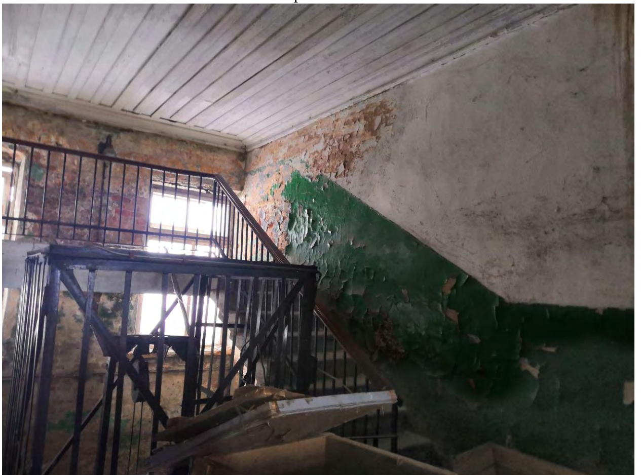
Фото.103. Казарма (расположена в центре территории военной части). Вид на западную ЛК. Второй этаж.
