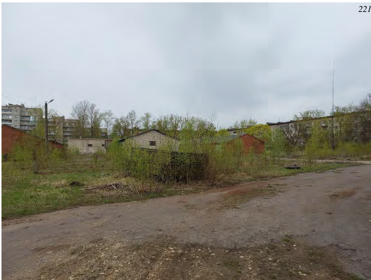
Фото.239. Территория в/ч 67651. Вид на объекты в складской зоне части.
