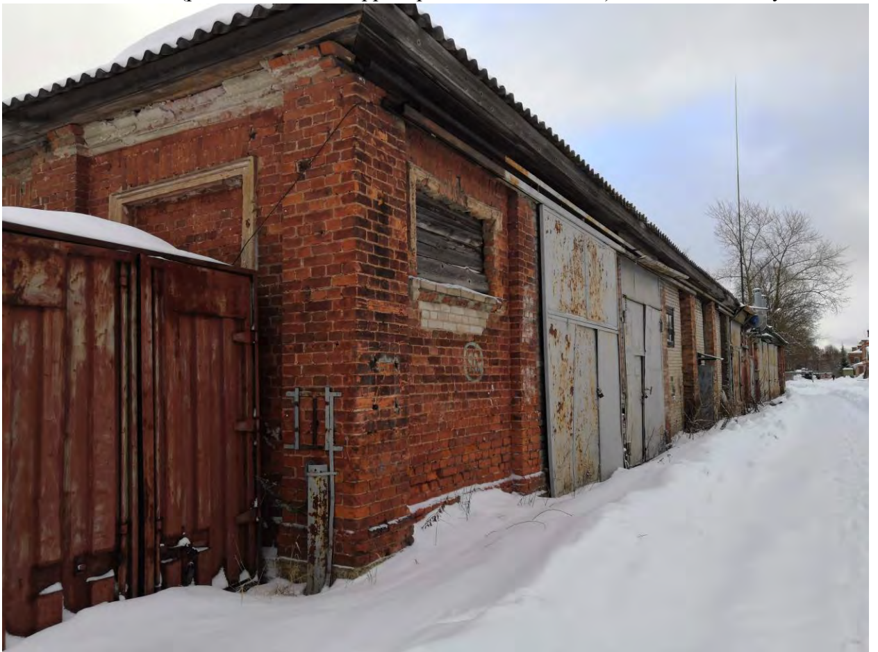
Фото.199. Конюшня (расположена на территории воинской части). Вид на западный фасад.
