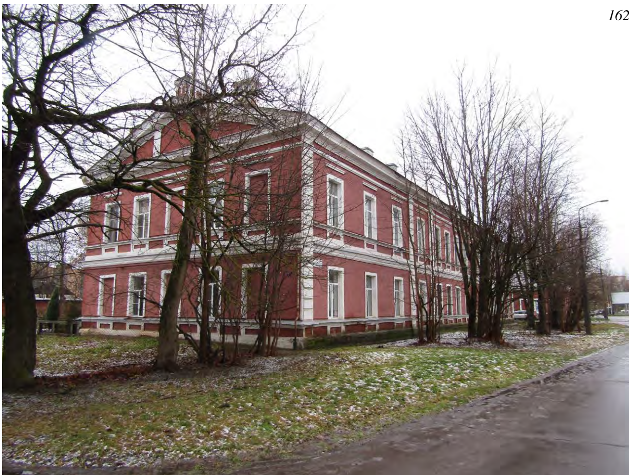
Фото.128. Службы (г.Гатчина, Роцинская улица, 4 ). Вид на юго-западный фасад.
