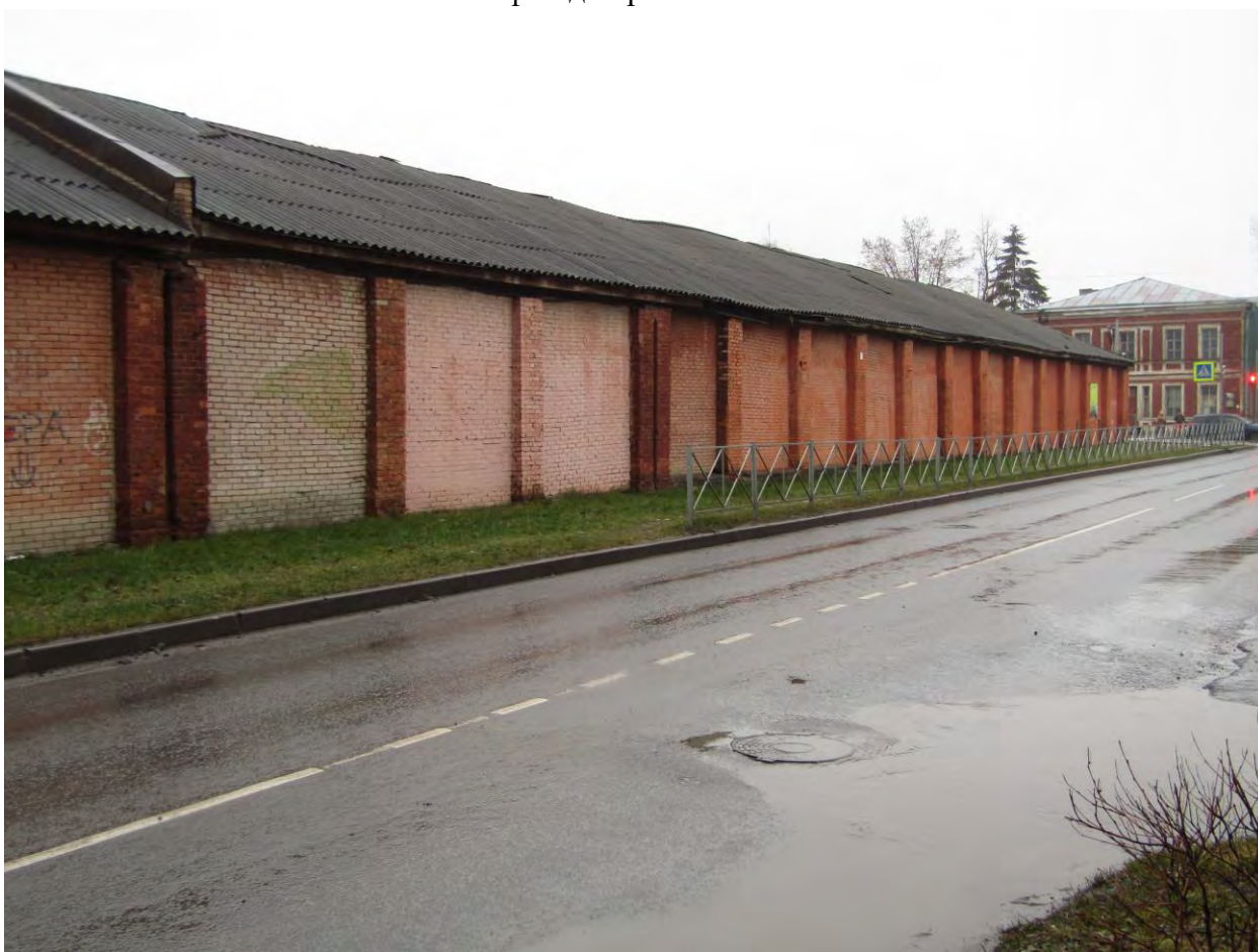
Фото.171. Западные сараи, два. (г.Гатчина, ул. 7-й Армии, 6 корпус 2). Вид на юго-западный фасад. Фрагмент.
