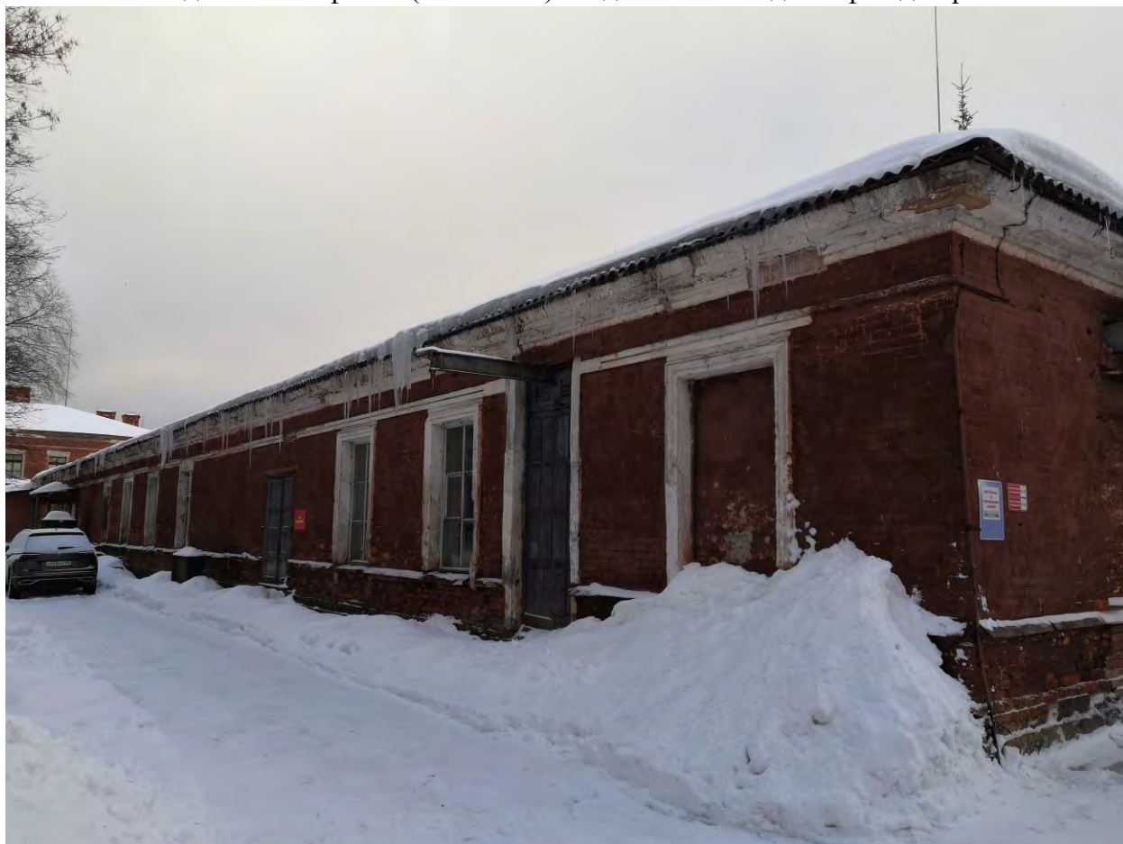
Фото.137. Здание мастерской (восточное). Вид на юго-западный фасад. Фрагмент.
