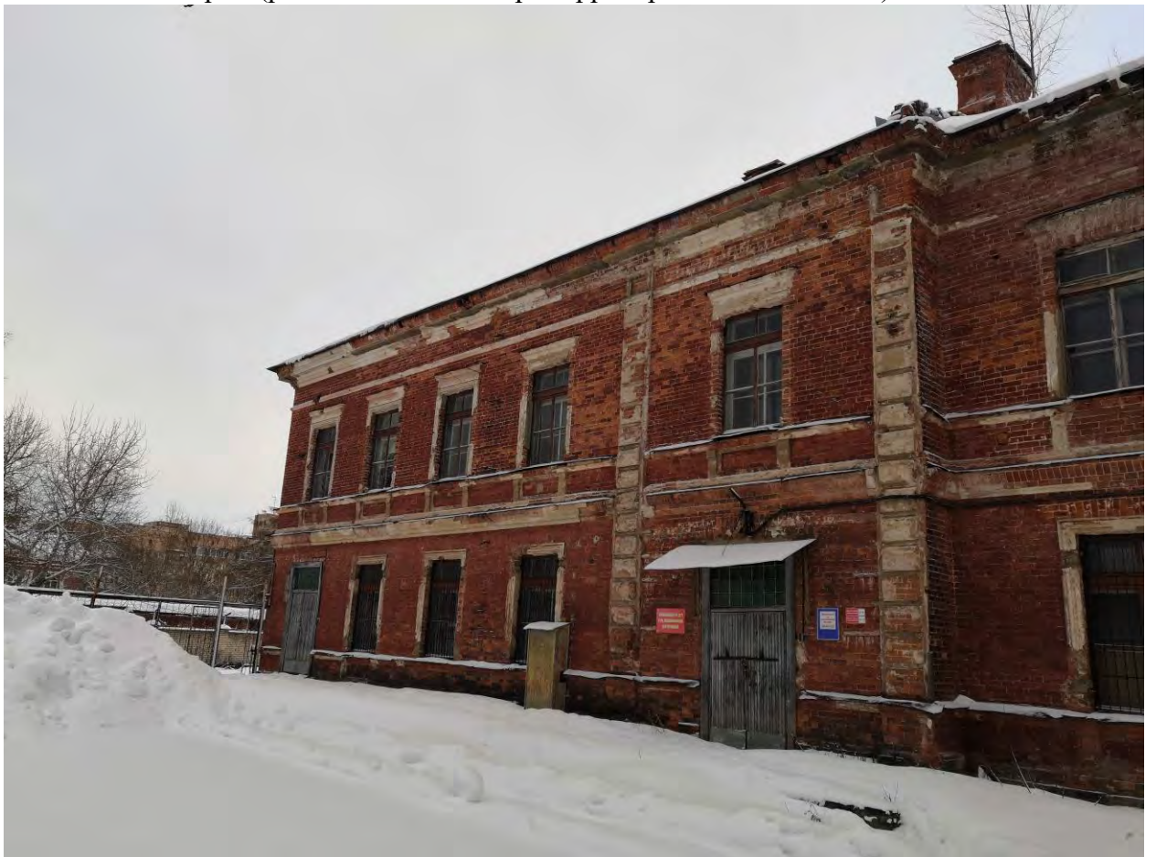
Фото.74. Казарма (расположена в центре территории военной части). Вид на северо-западный фасад. Фрагмент.
