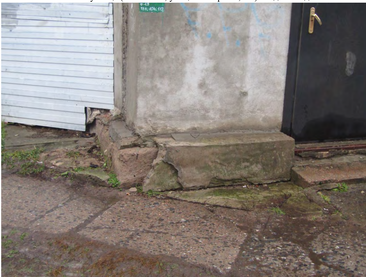
Фото.177. Кузница (г. Гатчина, улица 7-й Армии, 6А). Вид на цокольную часть.
