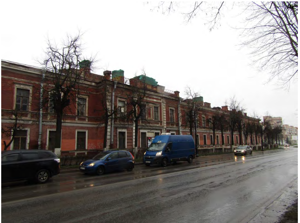
Фото.15. Казарма (г.Гатчина, проспект 25 Октября, 44). Вид на юго-восточный фасад. Фрагмент.
