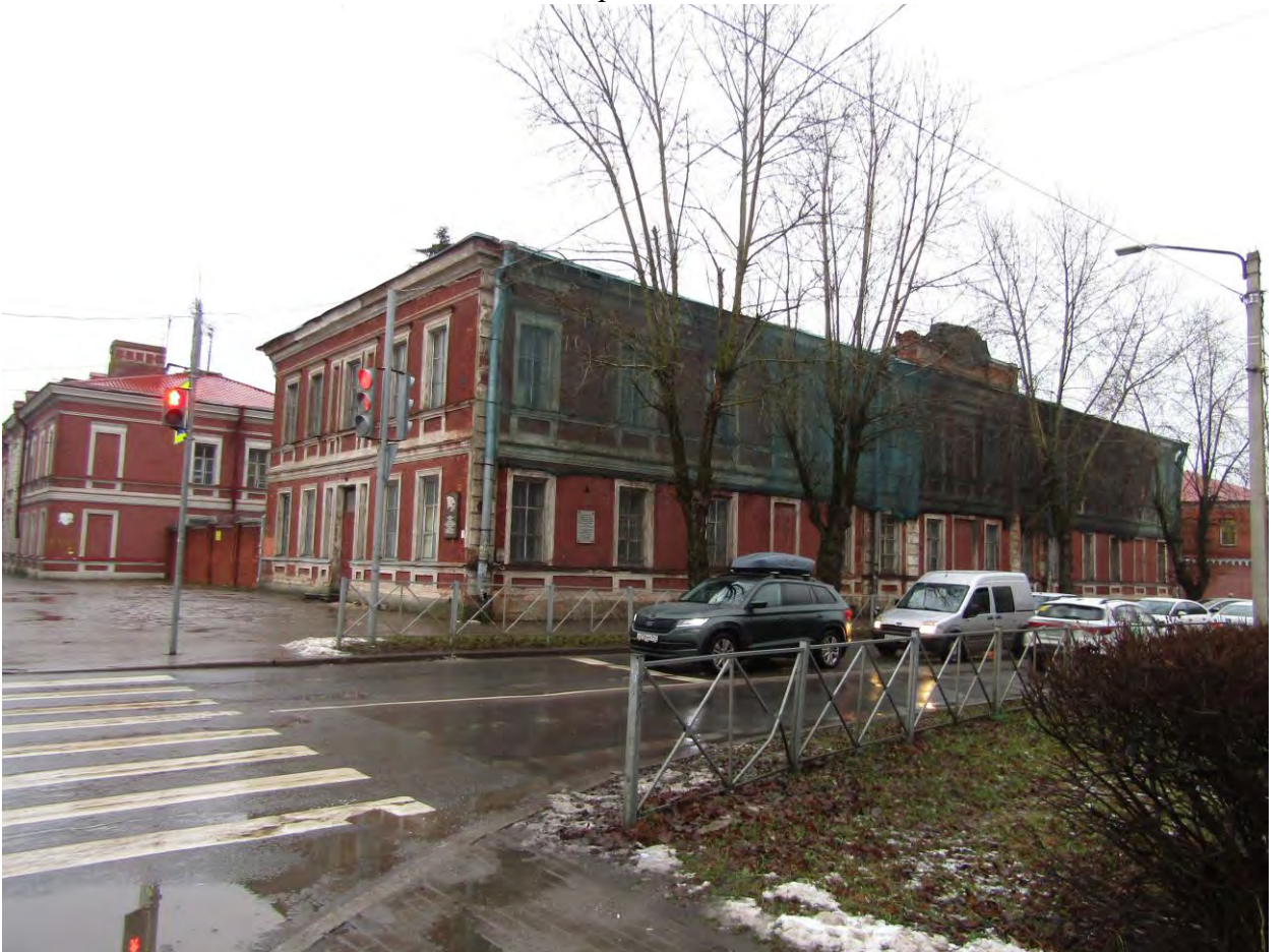
Фото.2. Здание офицерского собрания (г. Гатчина, улица 7-й Армии, 8А). Вид с перекрестка.
