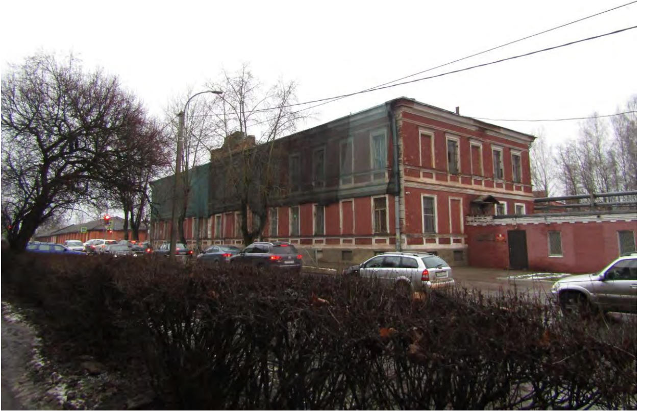
Фото.3. Здание офицерского собрания (г. Гатчина, улица 7-й Армии, 8А). Вид с юга.
