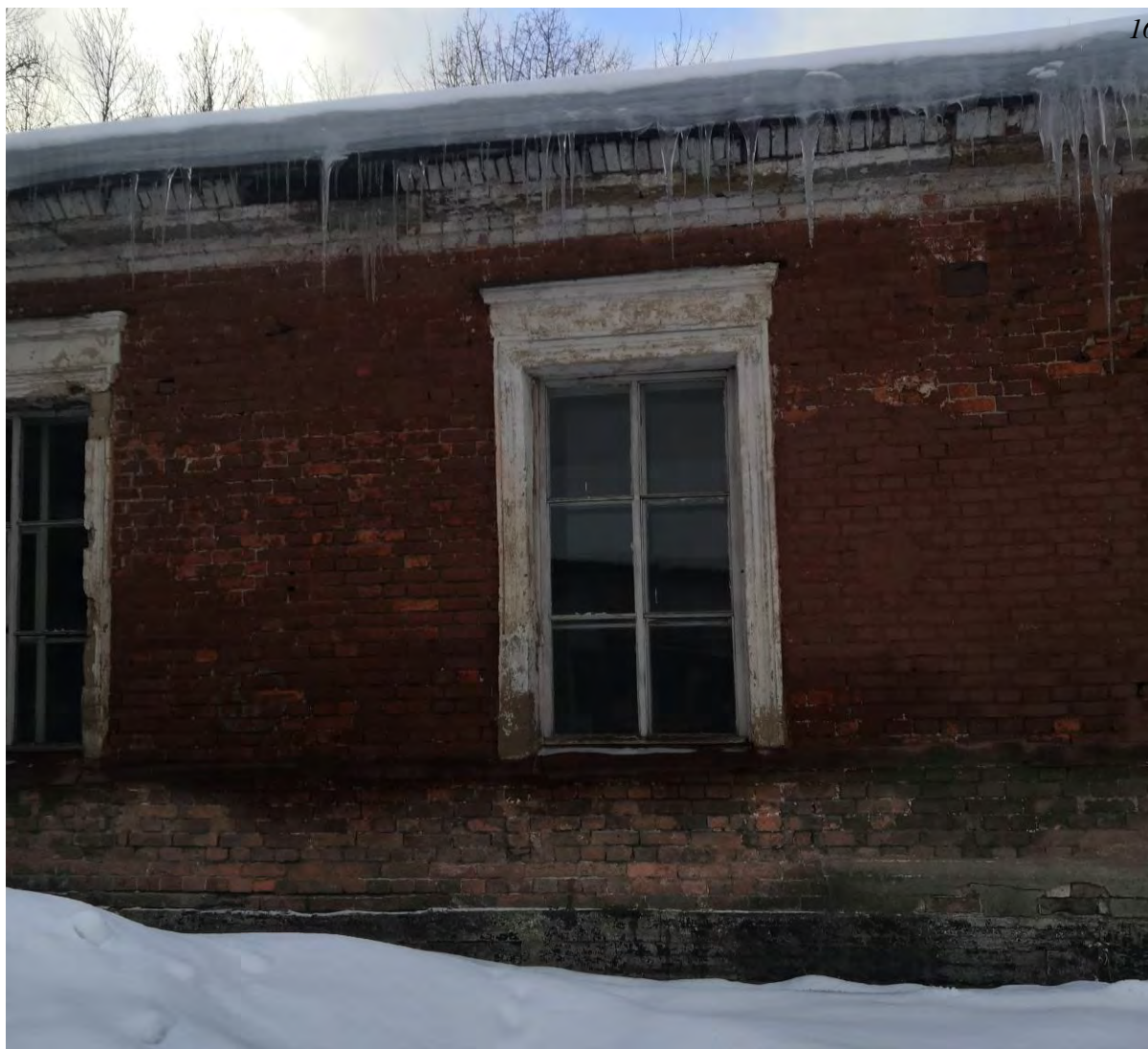
Фото.136. Здание мастерской (восточное). Вид на юго-западный фасад. Фрагмент.
