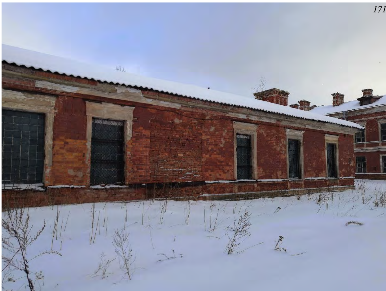
Фото.146. Здание мастерской (западное). Вид на юго-западный фасад. Фрагмент.
