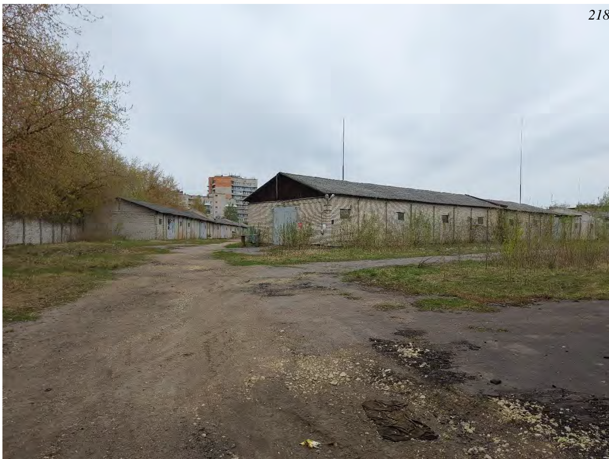
Фото.233. Территория в/ч 67651. Вид на объекты в складской зоне части.
