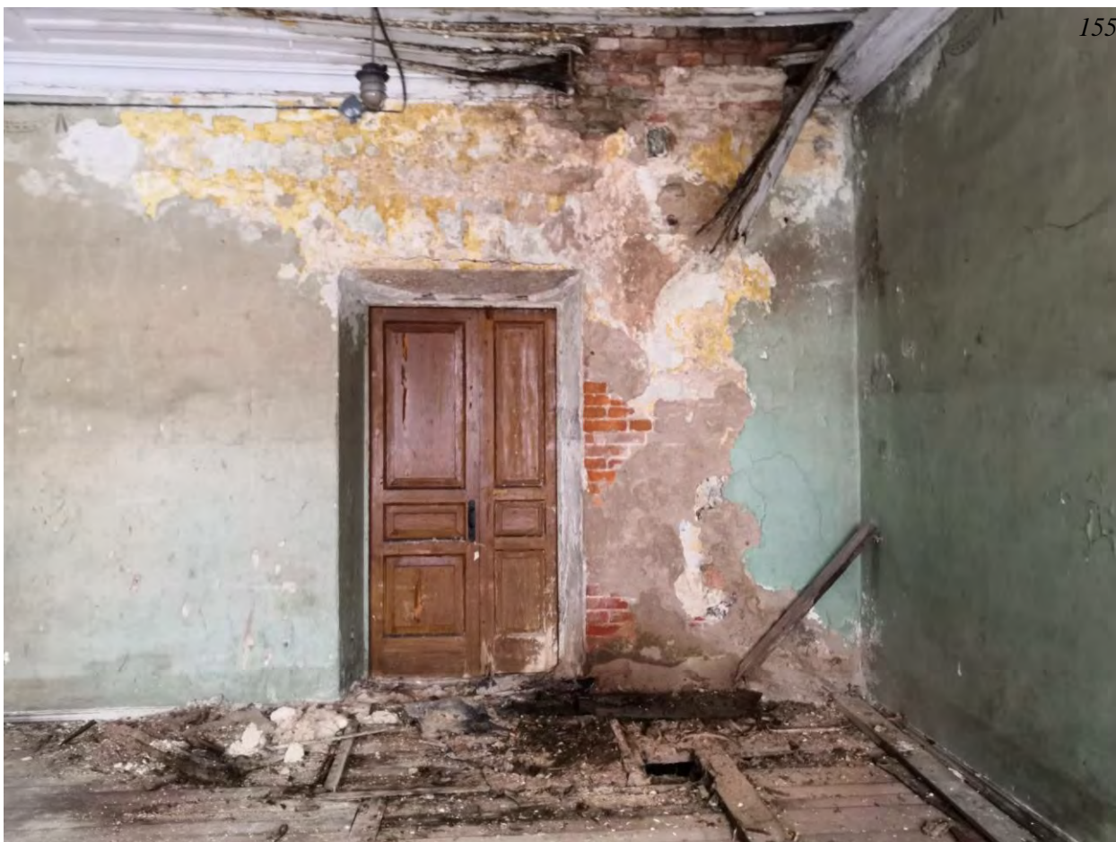
Фото.114. Казарма (расположена в центре территории военной части). Центральная часть. Ощий вид на помещение. Второй этаж.
