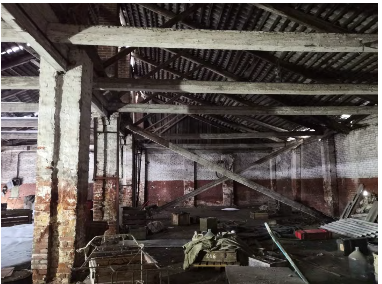
Фото.205. Конюшня (расположена на территории воинской части). Общий вид на помещение.
