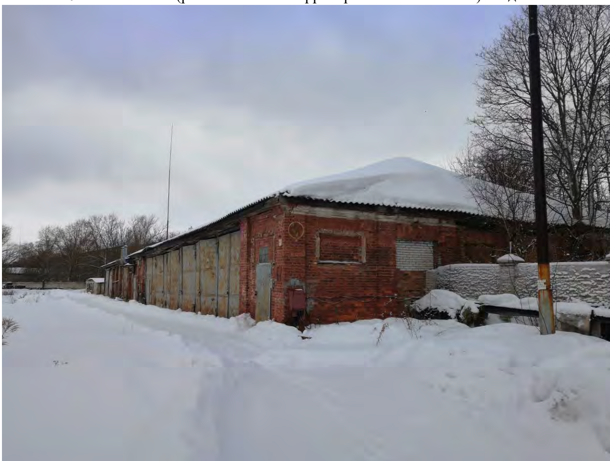
Фото.195. Конюшня (расположена на территории воинской части). Вид с юга.
