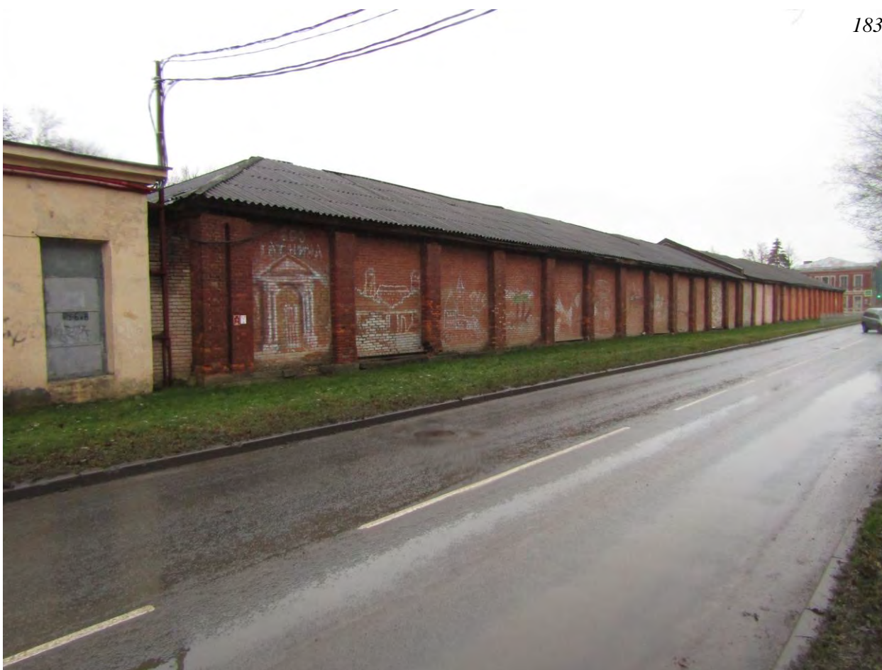
Фото.170. Западные сараи, два. (г.Гатчина, ул. 7-й Армии, 6 корпус 2). Вид на юго-западный фасад. Фрагмент.
