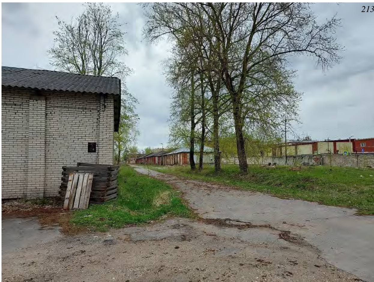
Фото.223. Территория в/ч 67651. Вид на советские и исторические склады в складской зоне внутреннего двора.
