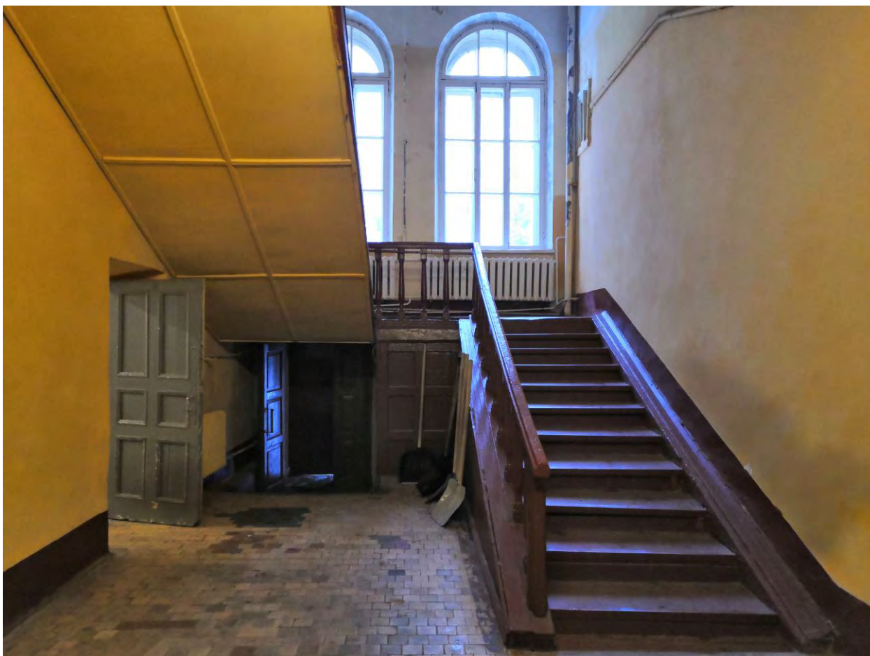
Фото.68. Казарма (г.Гатчина, проспект 25 Октября, 44). Вид на центральную ЛК. Первый этаж.
