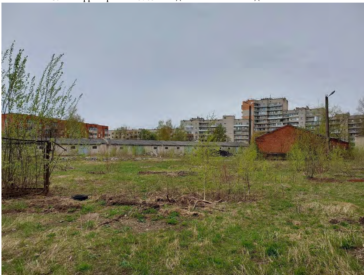
Фото.240. Территория в/ч 67651. Вид на объекты в складской зоне части.
