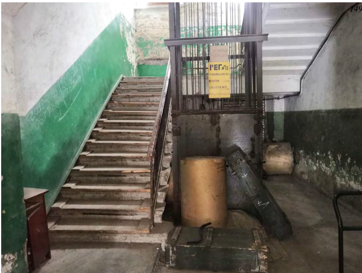
Фото.104. Казарма (расположена в центре территории военной части). Вид на центральную ЛК. Первый этаж.
