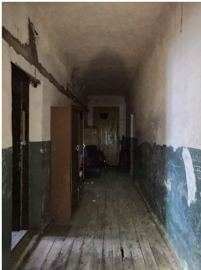
Фото.63. Казарма (г.Гатчина, проспект 25 Октября, 44). Западная часть. Вид на коридор. Первый этаж.
