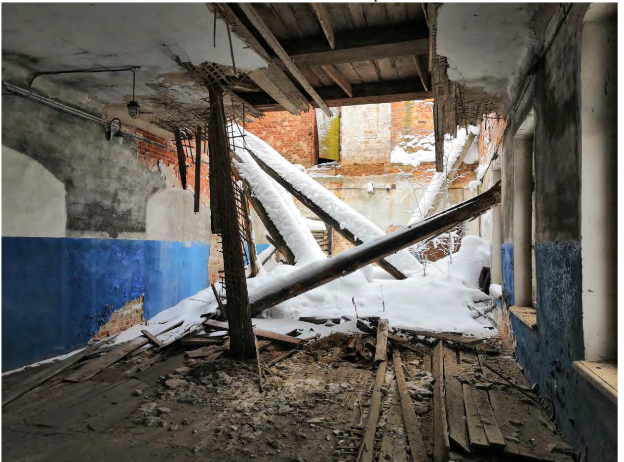
Фото.117. Казарма (расположена в центре территории военной части). Центральная часть. Ощий вид на помещение. Второй этаж.
