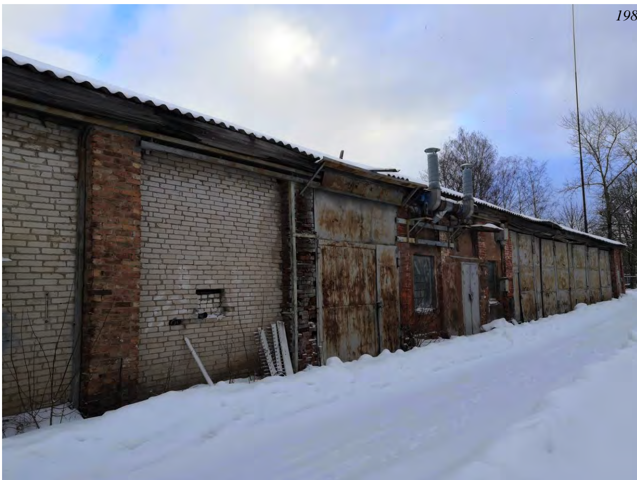
Фото.200. Конюшня (расположена на территории воинской части). Вид на западный фасад.
