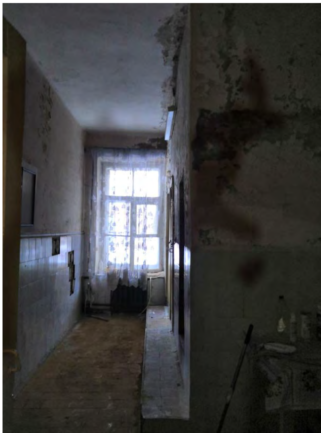
Фото.65. Казарма (г.Гатчина, проспект 25 Октября, 44). Западная часть. Вид на с/у. Первый этаж.
