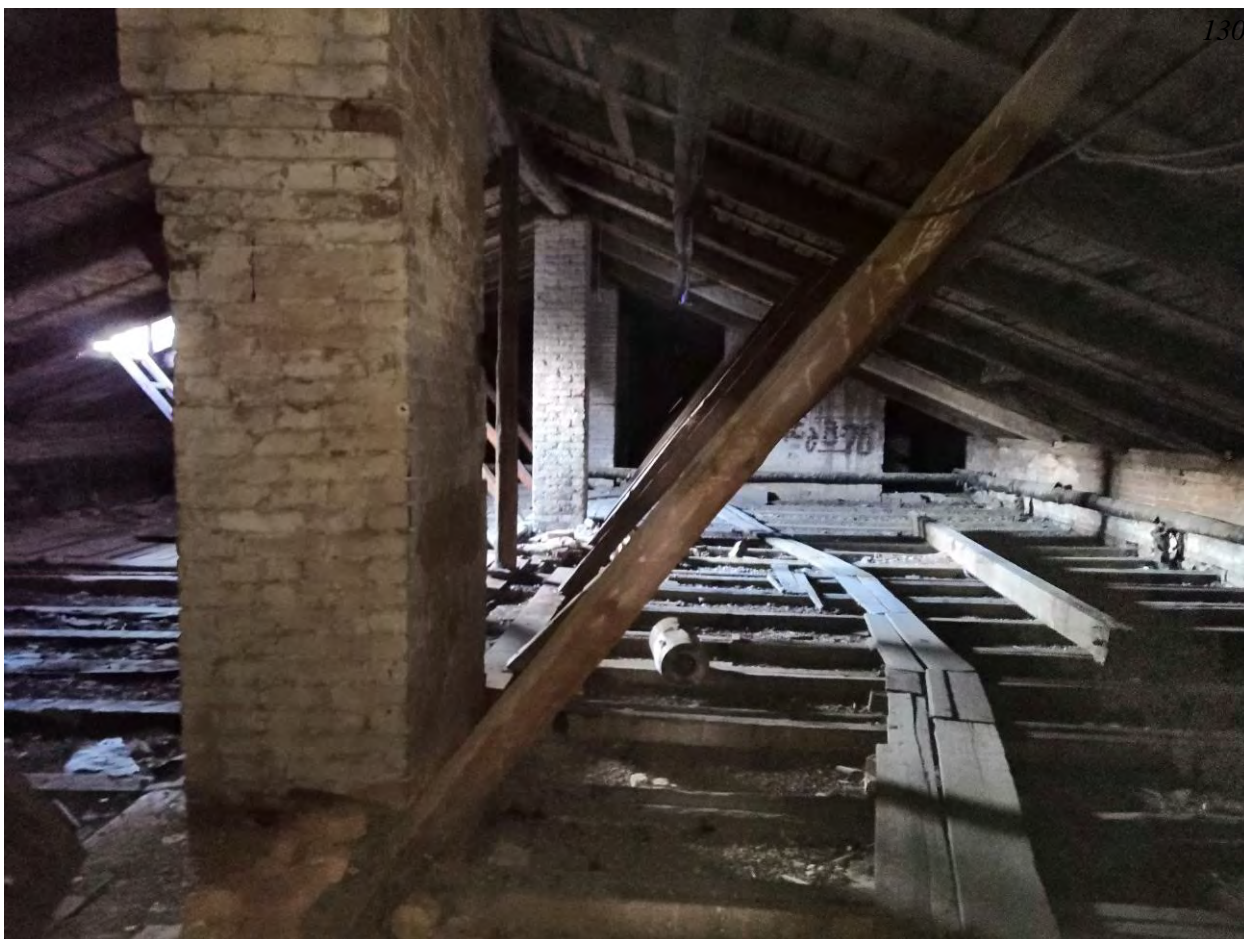
Фото.71. Казарма (г.Гатчина, проспект 25 Октября, 44). Вид на чердак.
