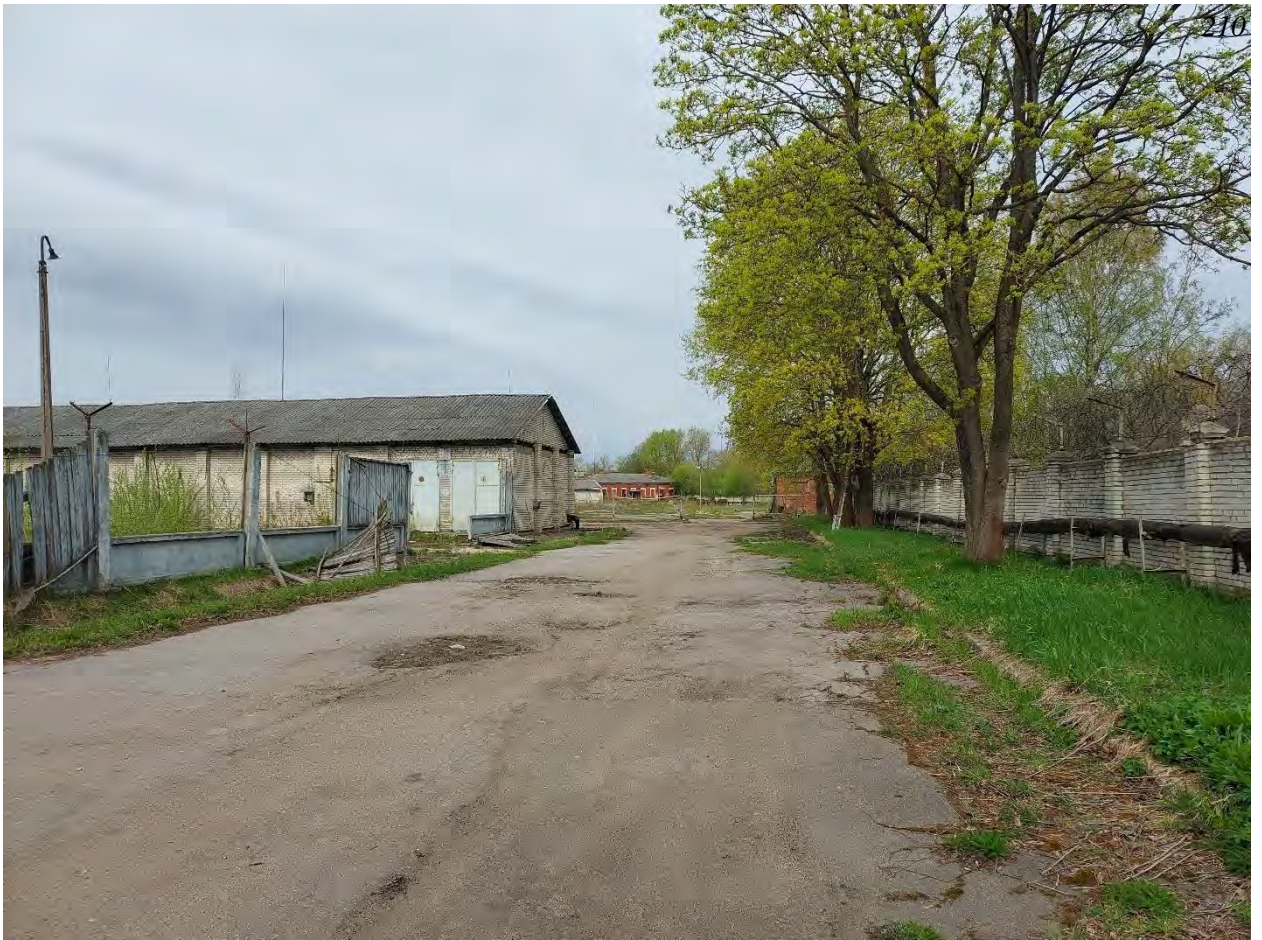
Фото.217. Территория в/ч 67651. Вид на проезд и склады.
