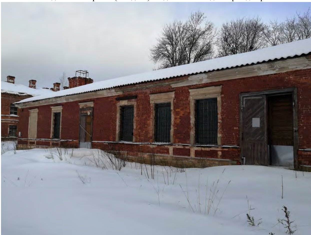
Фото.145. Здание мастерской (западное). Вид на юго-западный фасад. Фрагмент.
