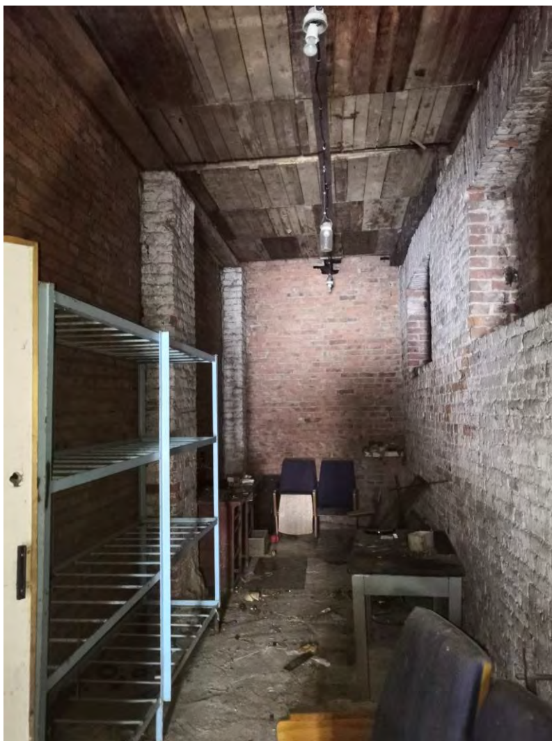
Фото.202. Конюшня (расположена на территории воинской части). Общий вид на помещение.
