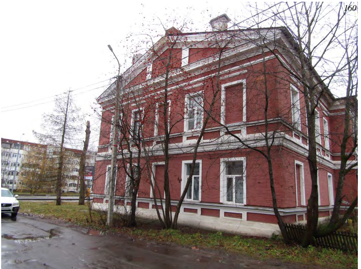
Фото.124. Службы (г.Гатчина, Рощинская улица, 4 ). Вид на северо-западный фасад.
