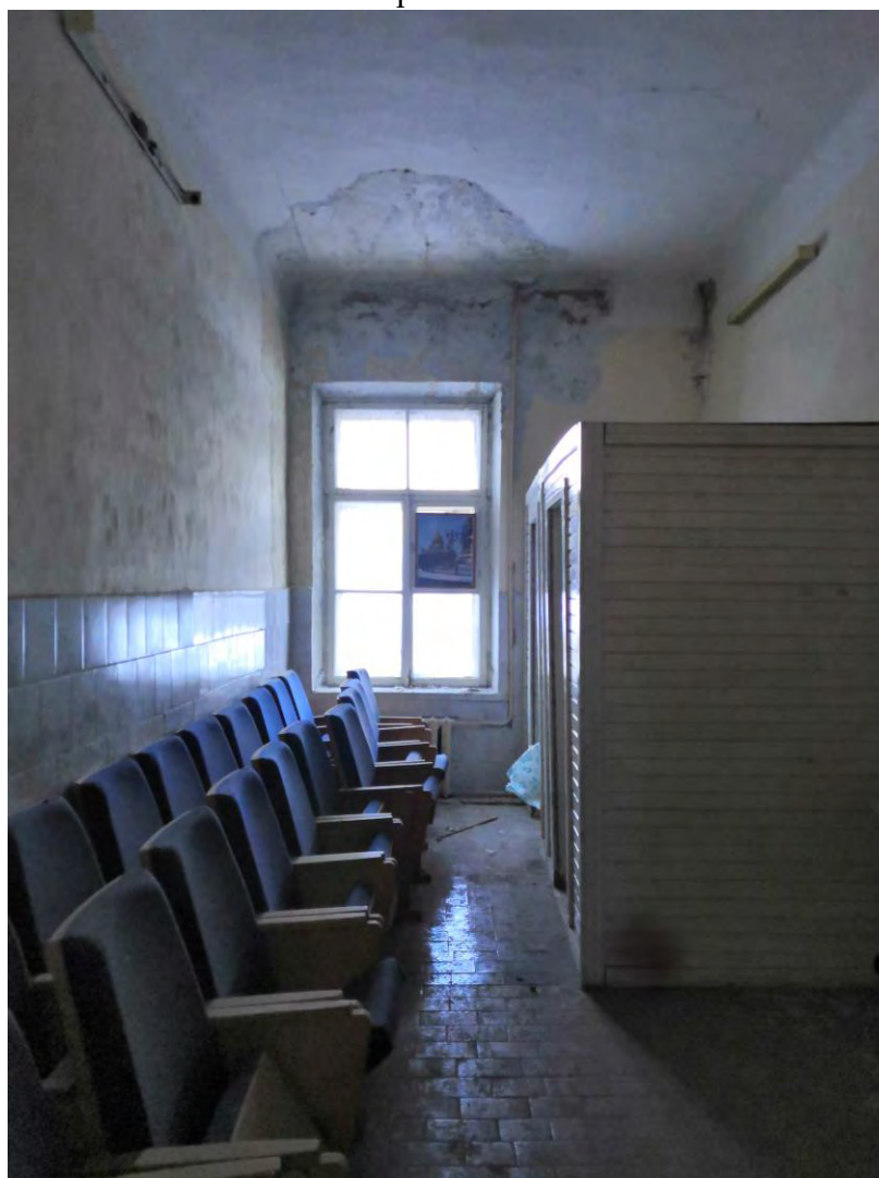
Фото.52. Казарма (г.Гатчина, проспект 25 Октября, 44). Западная часть. Вид на с/у. Второй этаж.
