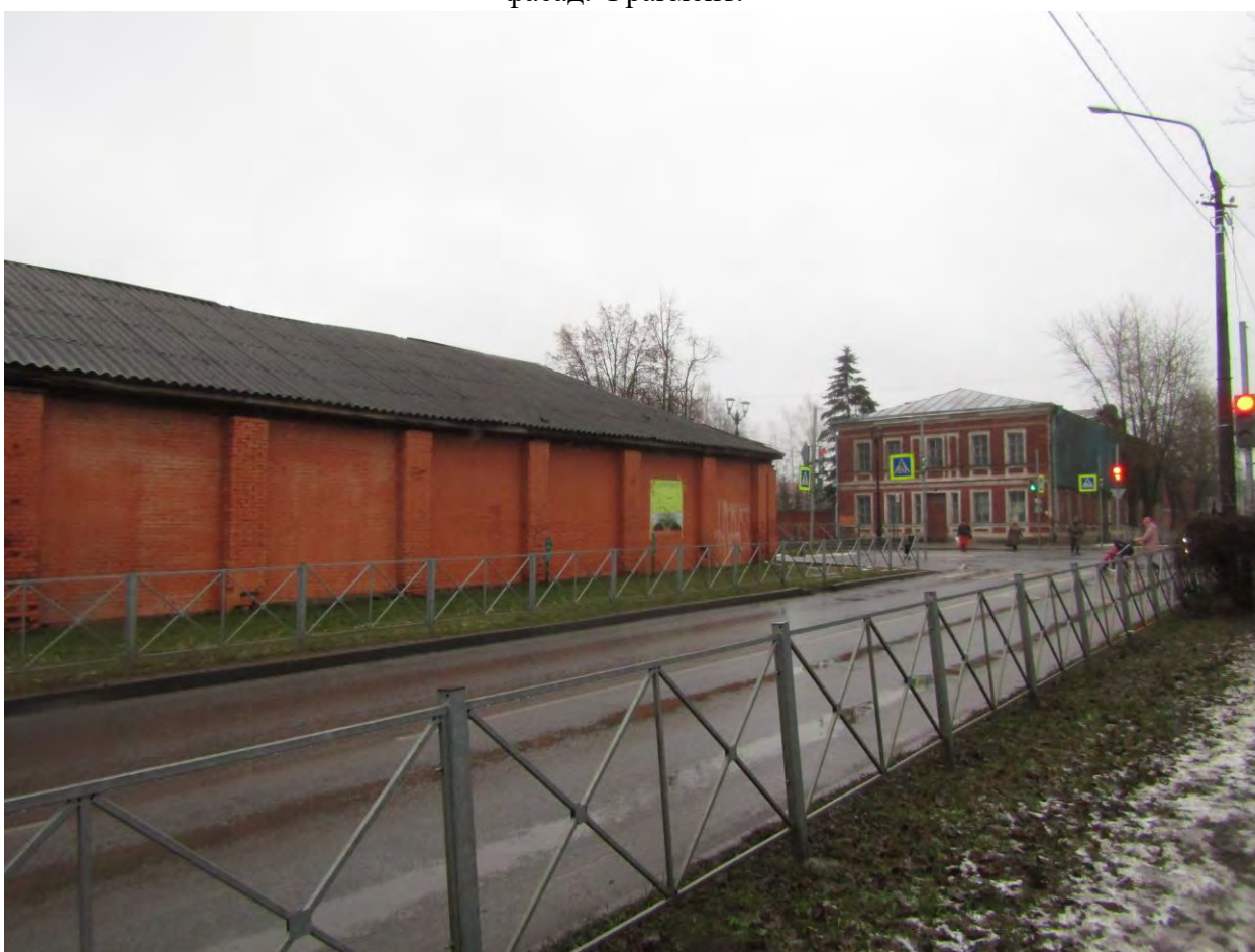
Фото.173. Западные сараи, два. (г.Гатчина, ул. 7-й Армии, 6 корпус 2). Вид на юго-западный фасад. Фрагмент.
