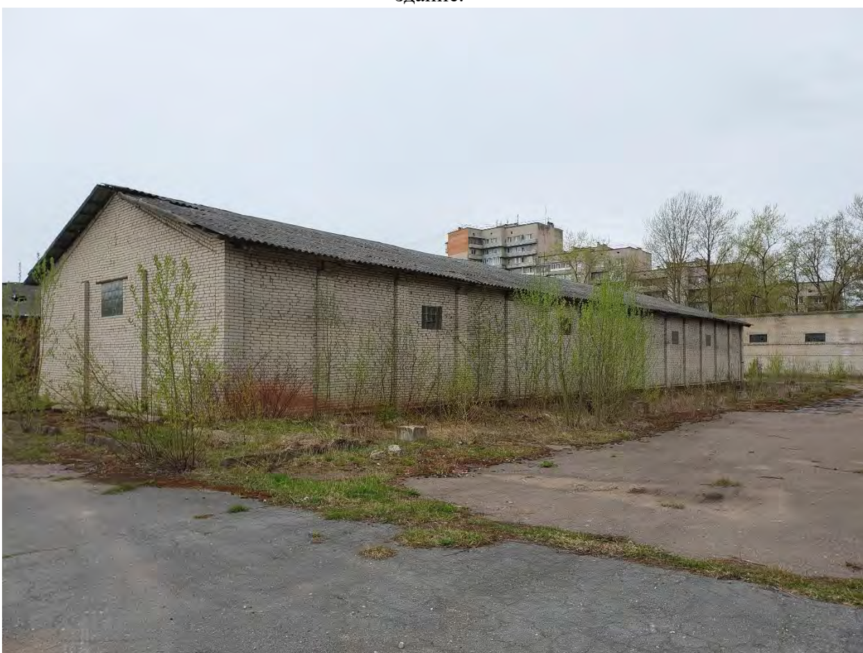
Фото.242. Территория в/ч 67651. Вид на объекты в складской зоне части.
