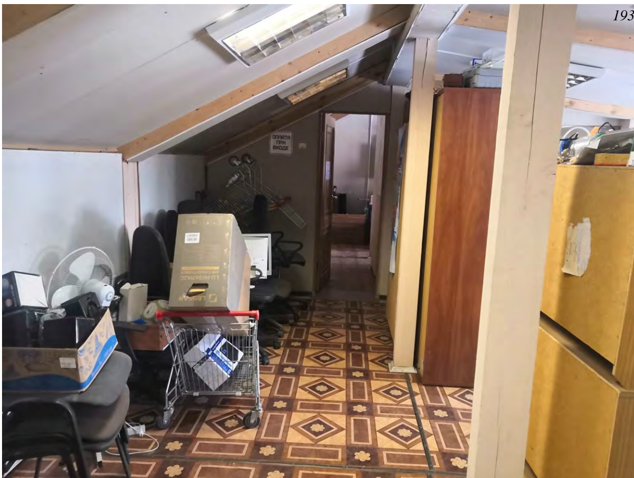
Фото.190. Кузница (г. Гатчина, улица 7-й Армии, 6А). Общий вид на помещение. Второй этаж.
