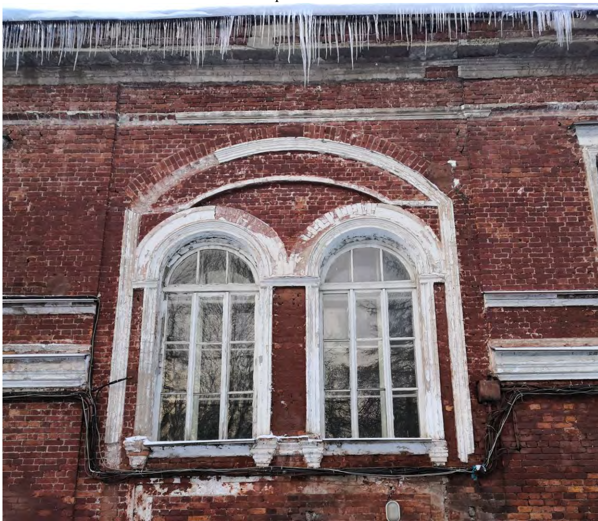
Фото.38. Казарма (г.Гатчина, проспект 25 Октября, 44). Вид на северо-западный фасад. Фрагмент.
