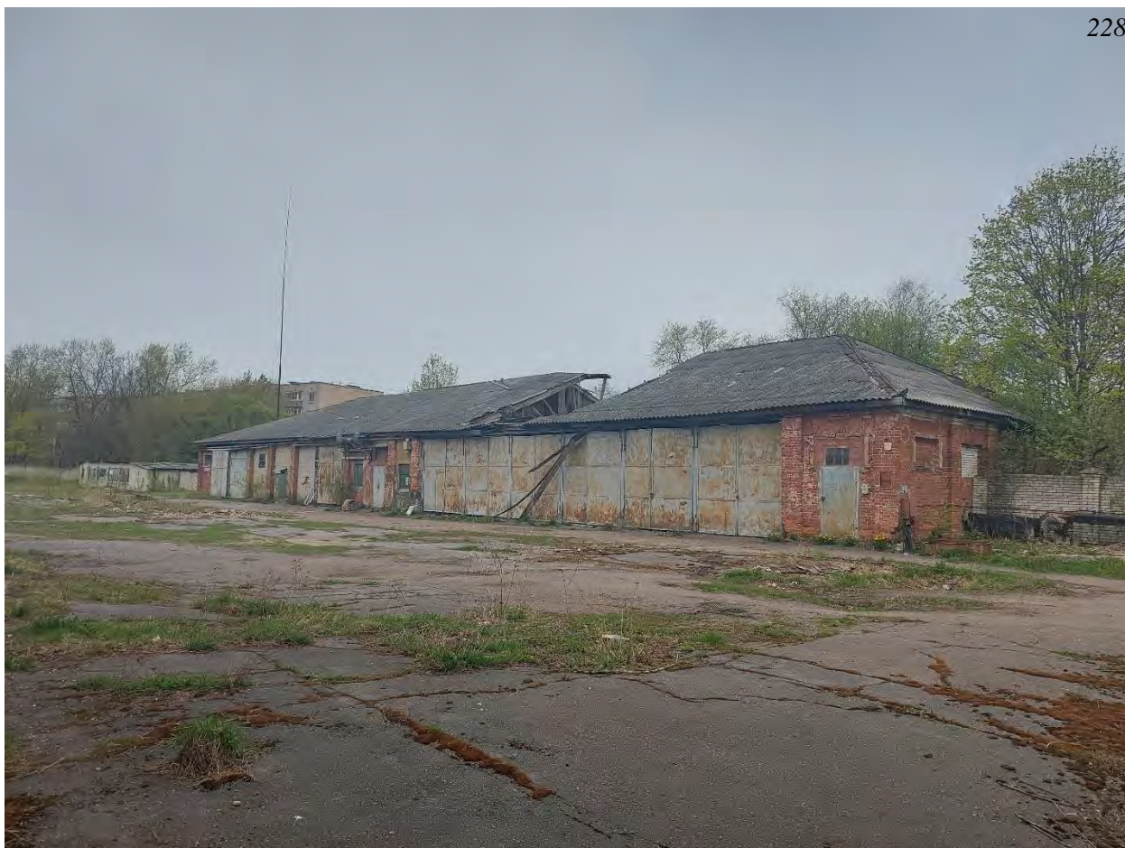
Фото.253. Территория в/ч 67651. Вид на объект «Конюшня».
