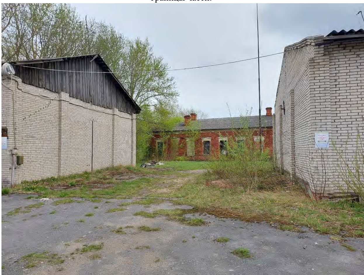
Фото.238. Территория в/ч 67651. Вид на объекты в складской зоне части.
