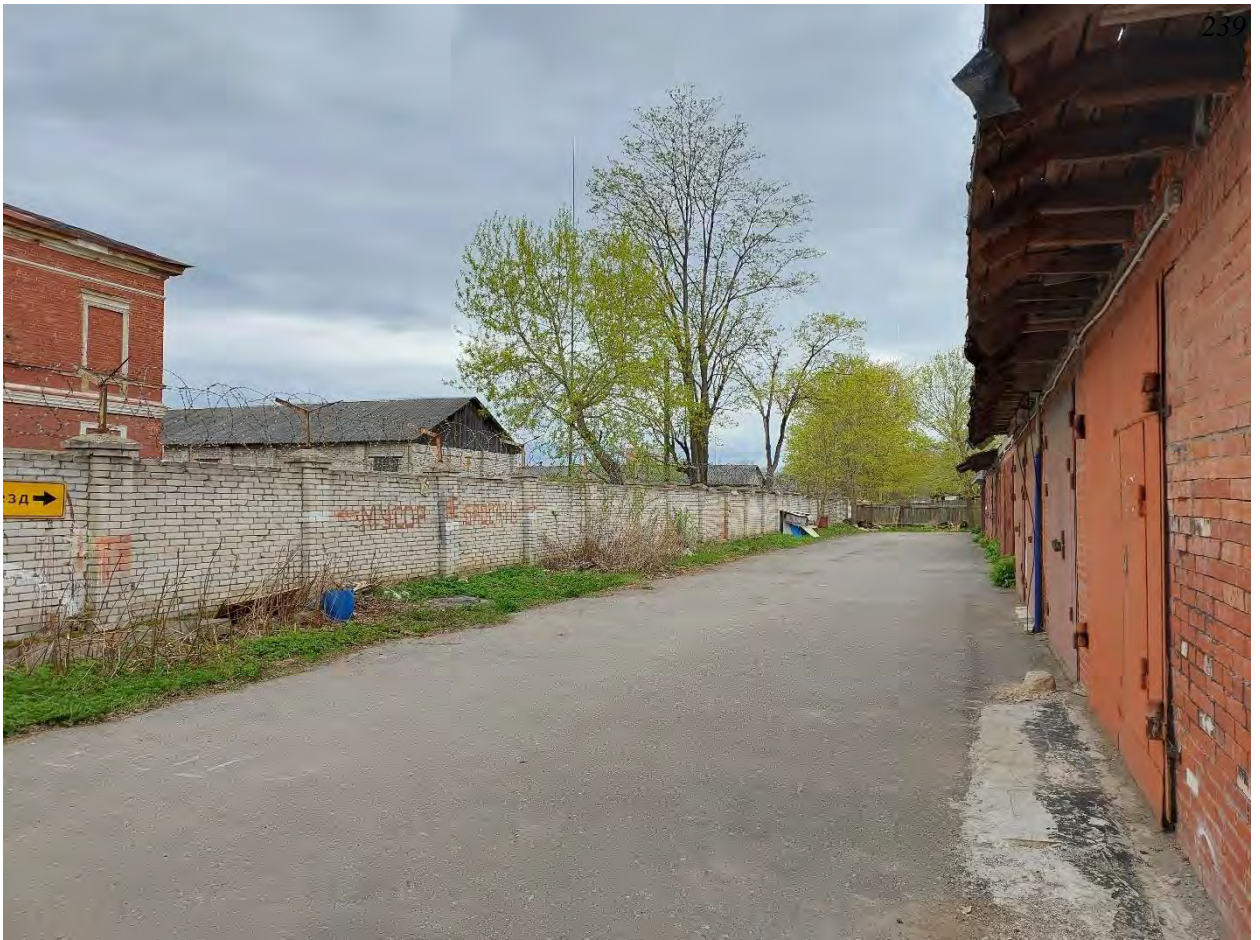
Фото.275. Вид на ограждение в/ч 67651 со стороны ул. Рощинская, здания бывших казарм, склад и гаражи.
