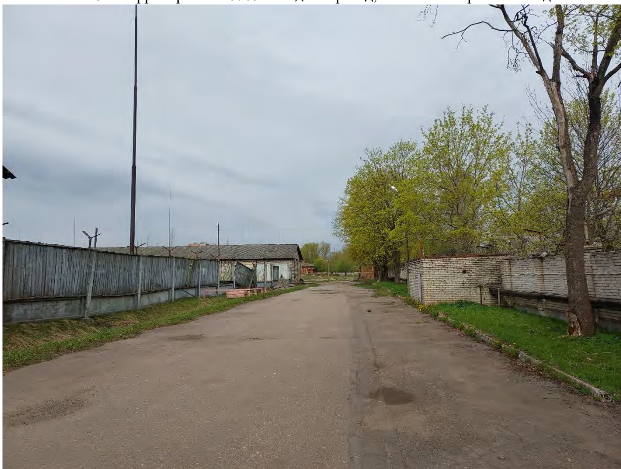
Фото.216. Территория в/ч 67651. Вид на проезд и склад.
