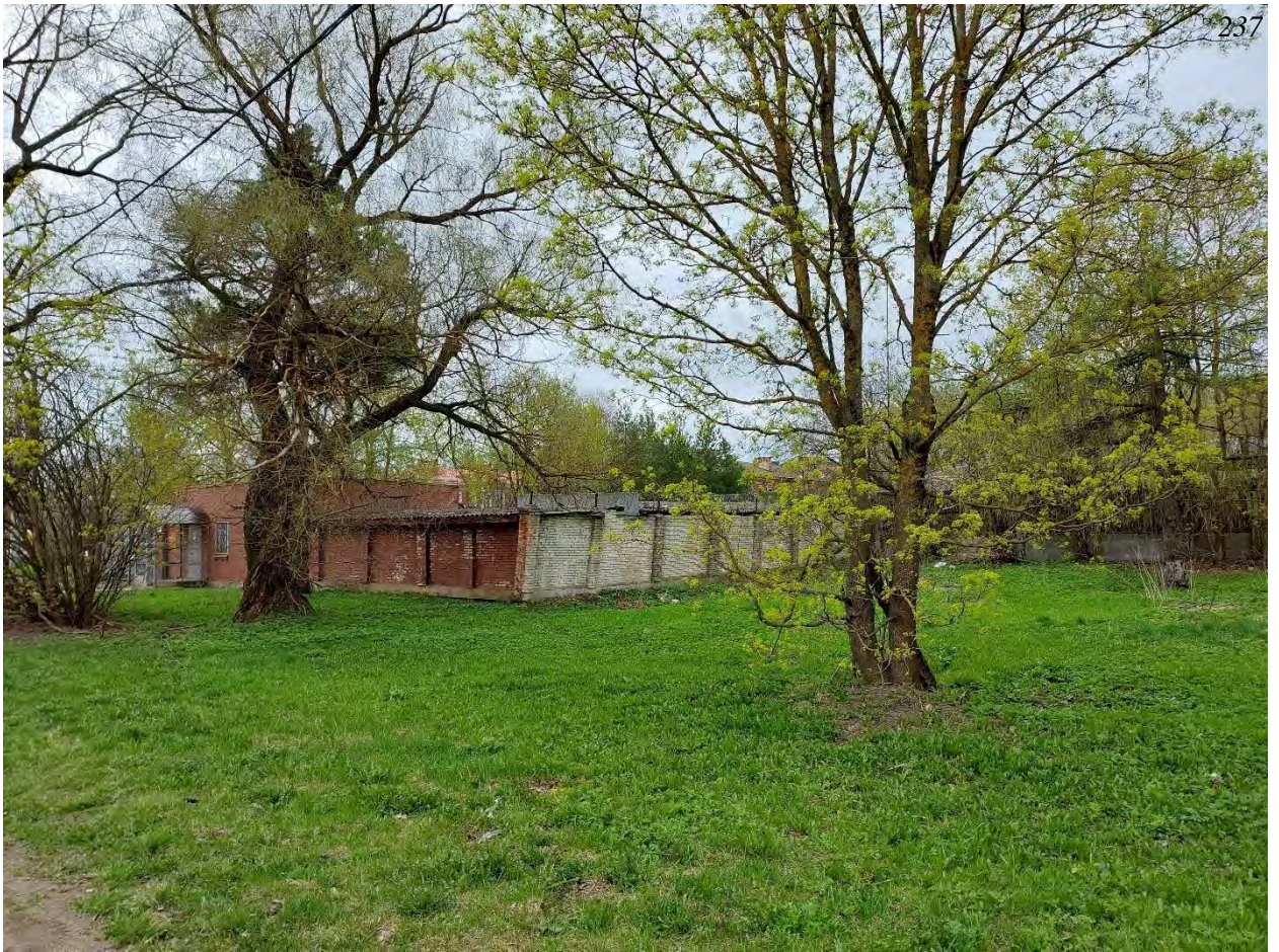
Фото.271. Вид с ограждение территории в/ч 67651. Со стороны ул. Рошинская.
