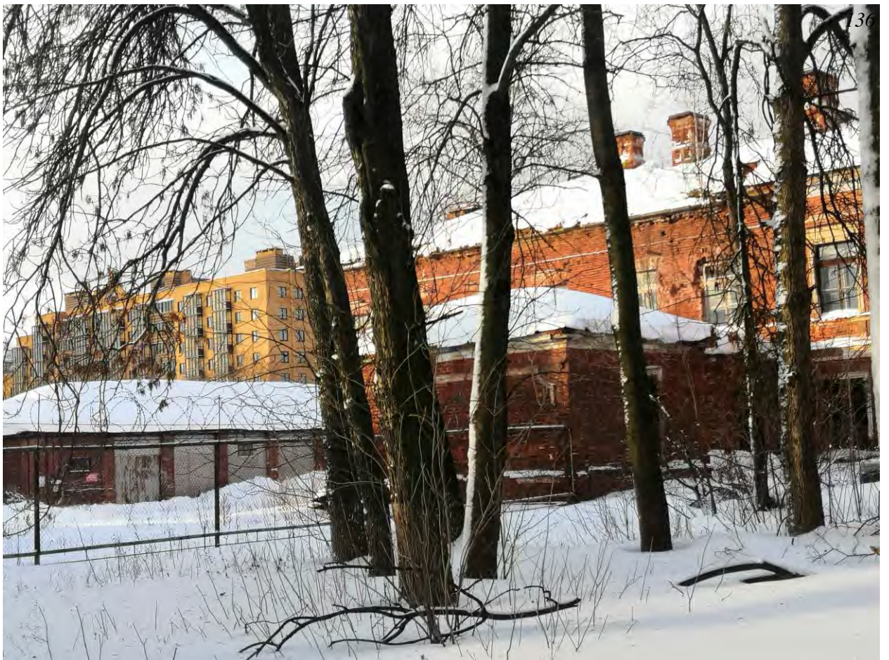
Фото.82. Казарма (расположена в центре территории военной части). Вид на юго-восточный фасад. Фрагмент.
