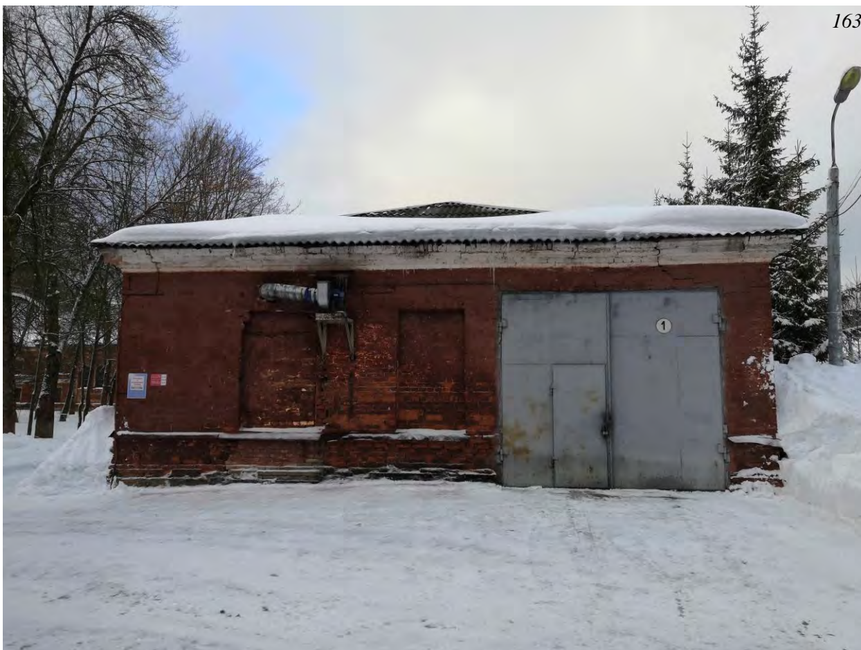
Фото.130. Здание мастерской (восточное). Вид на юго-восточный фасад.
