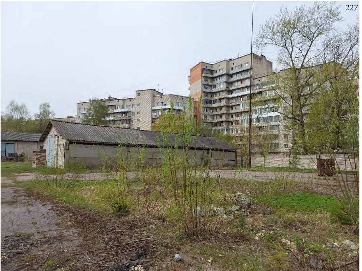
Фото.251. Территория в/ч 67651. Вид на объекты в складской зоне части.
