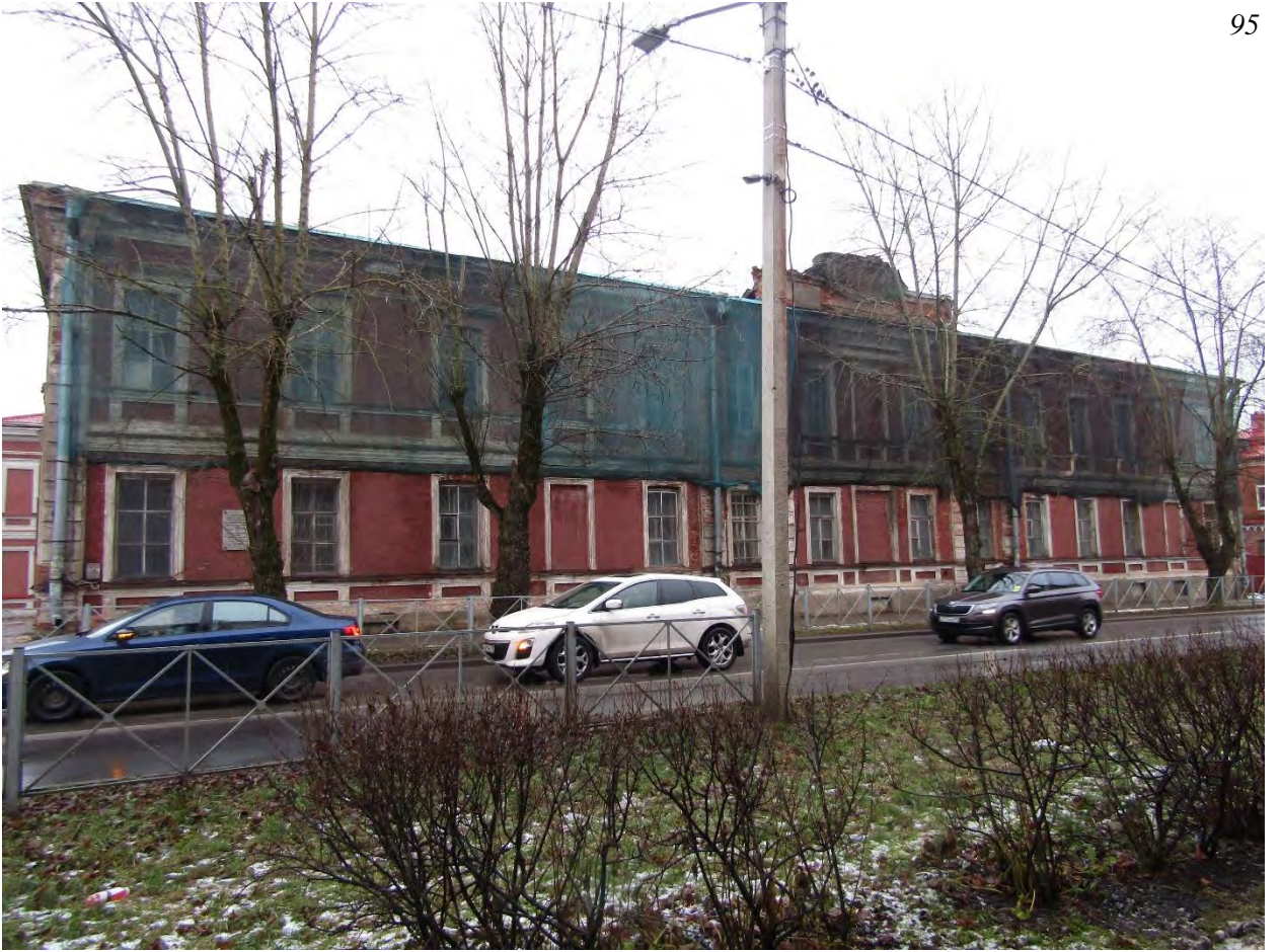
Фото.1. Здание офицерского собрания (г. Гатчина, улица 7-й Армии, 8А). Вид с ул. 7-й Армии.
