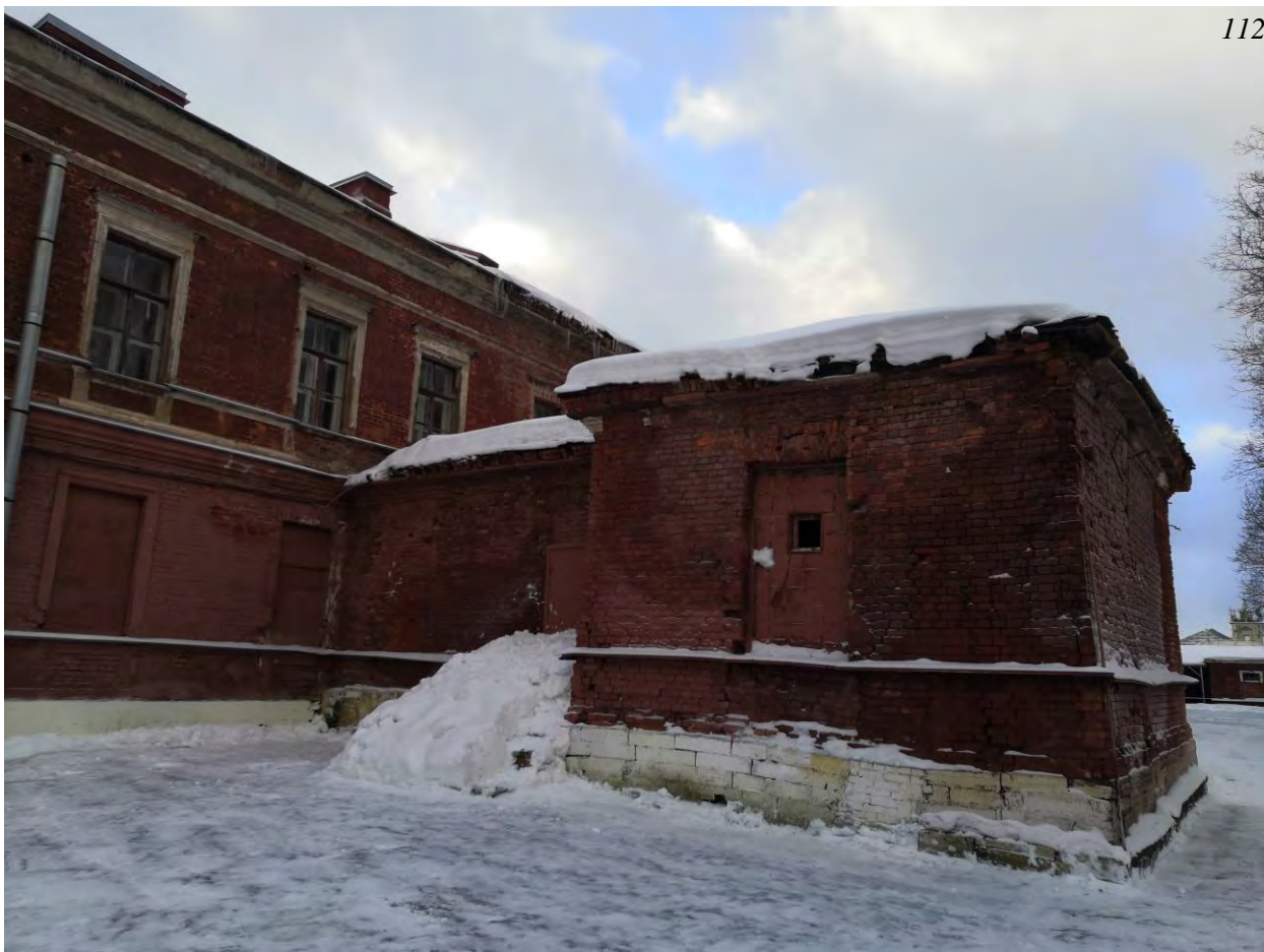
Фото.35. Казарма (г.Гатчина, проспект 25 Октября, 44). Вид на северо-западный фасад. Фрагмент.
