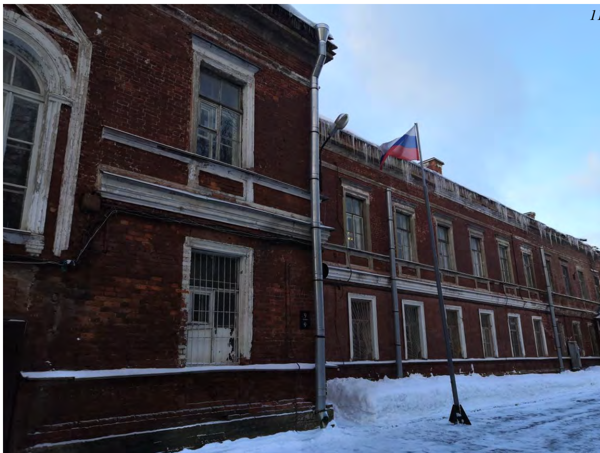
Фото.37. Казарма (г.Гатчина, проспект 25 Октября, 44). Вид на северо-западный фасад. Фрагмент.
