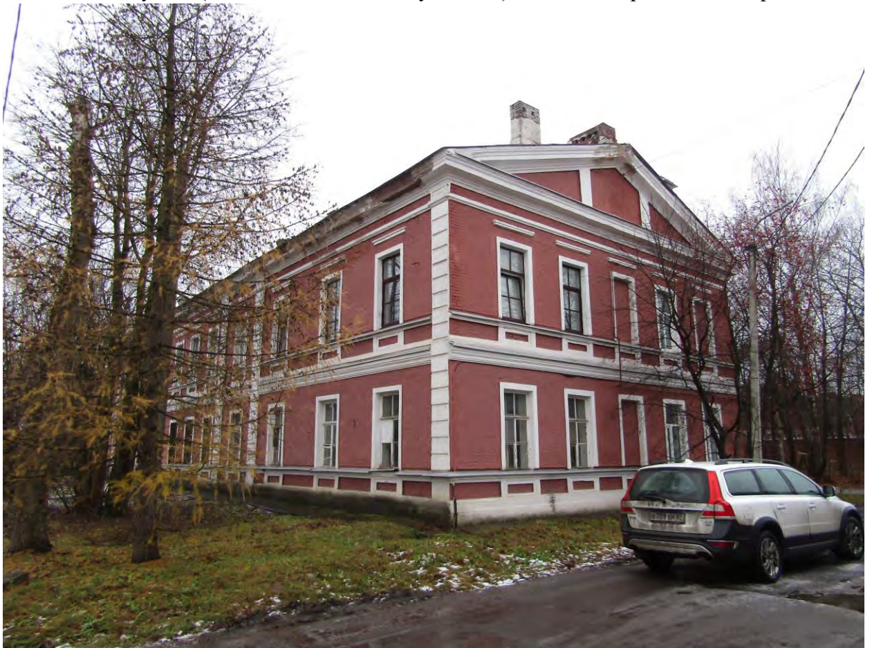
Фото.125. Службы (г.Гатчина, Рощинская улица, 4 ). Вид на северо-западный фасад.
