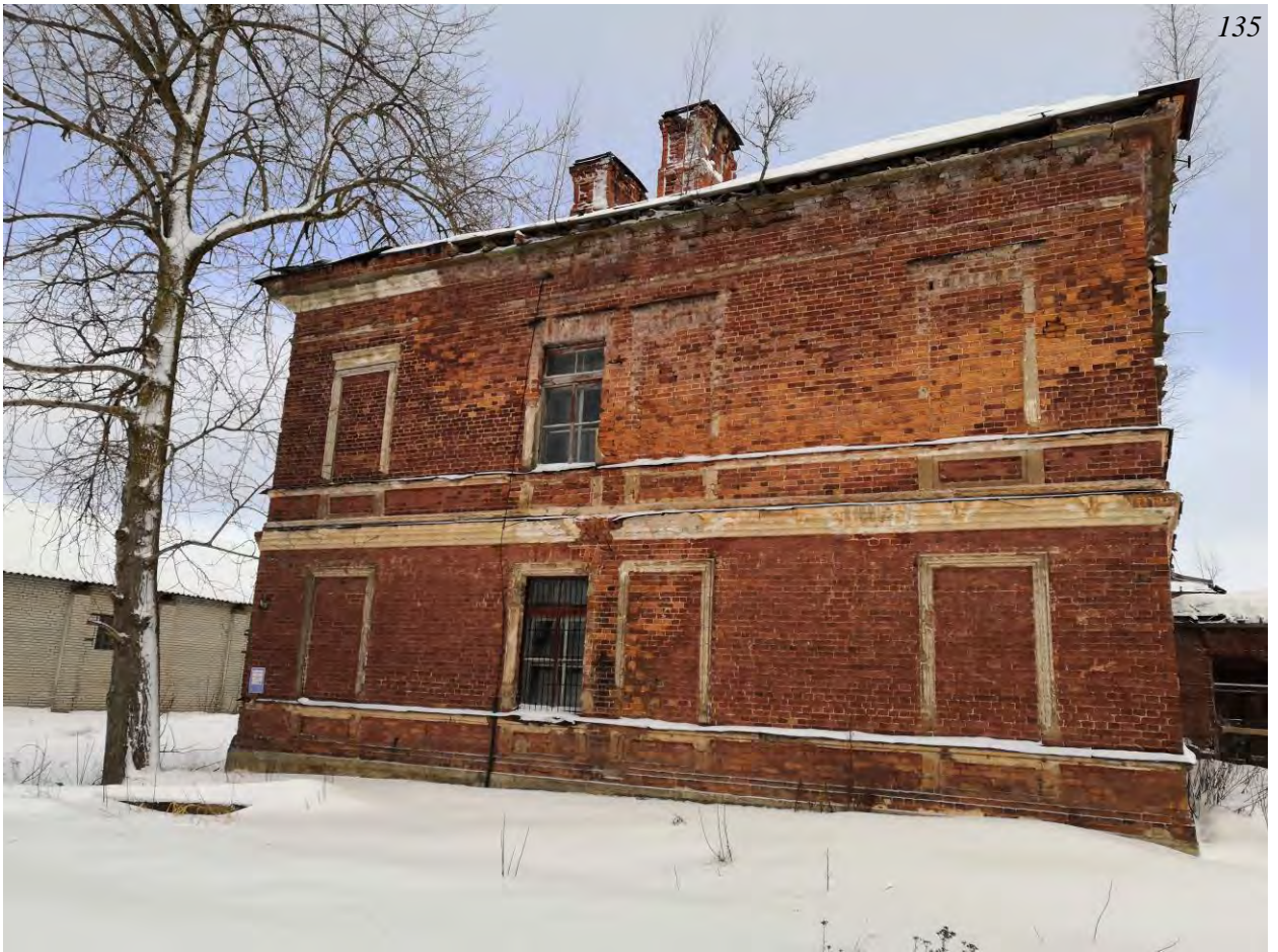
Фото.80. Казарма (расположена в центре территории военной части). Вид на юго-западный фасад.
