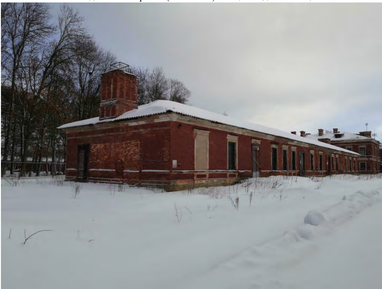
Фото.143. Здание мастерской (западное). Вид с запада.
