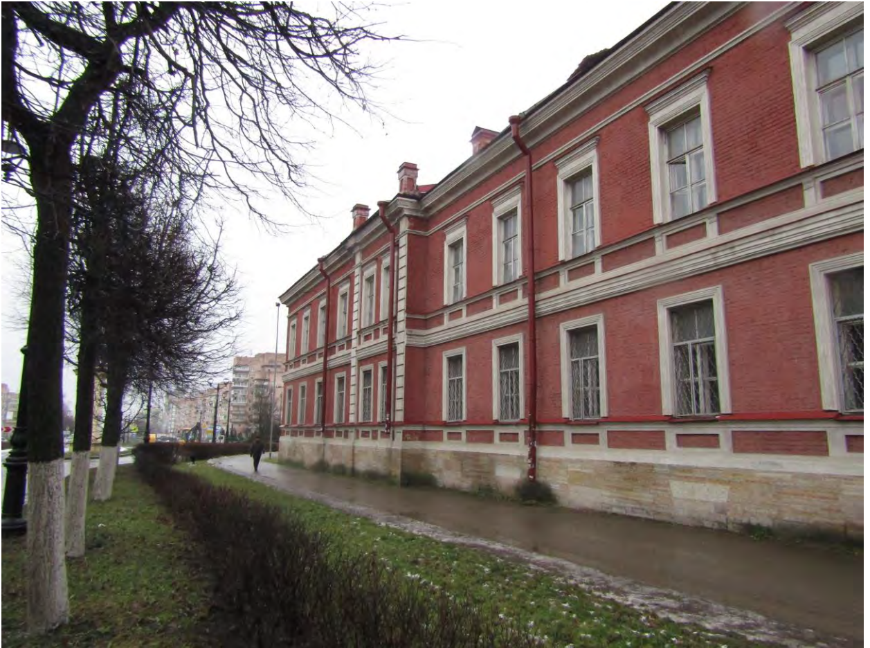
Фото.28. Казарма (г.Гатчина, проспект 25 Октября, 55). Вид на северо-западный фасад. Фрагмент.
