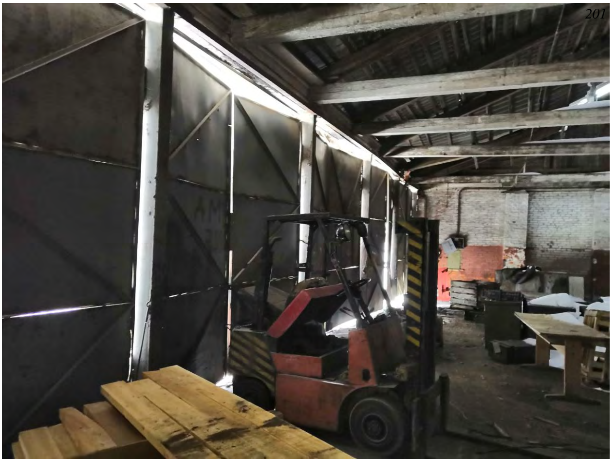
Фото.206. Конюшня (расположена на территории воинской части). Общий вид на помещение.
