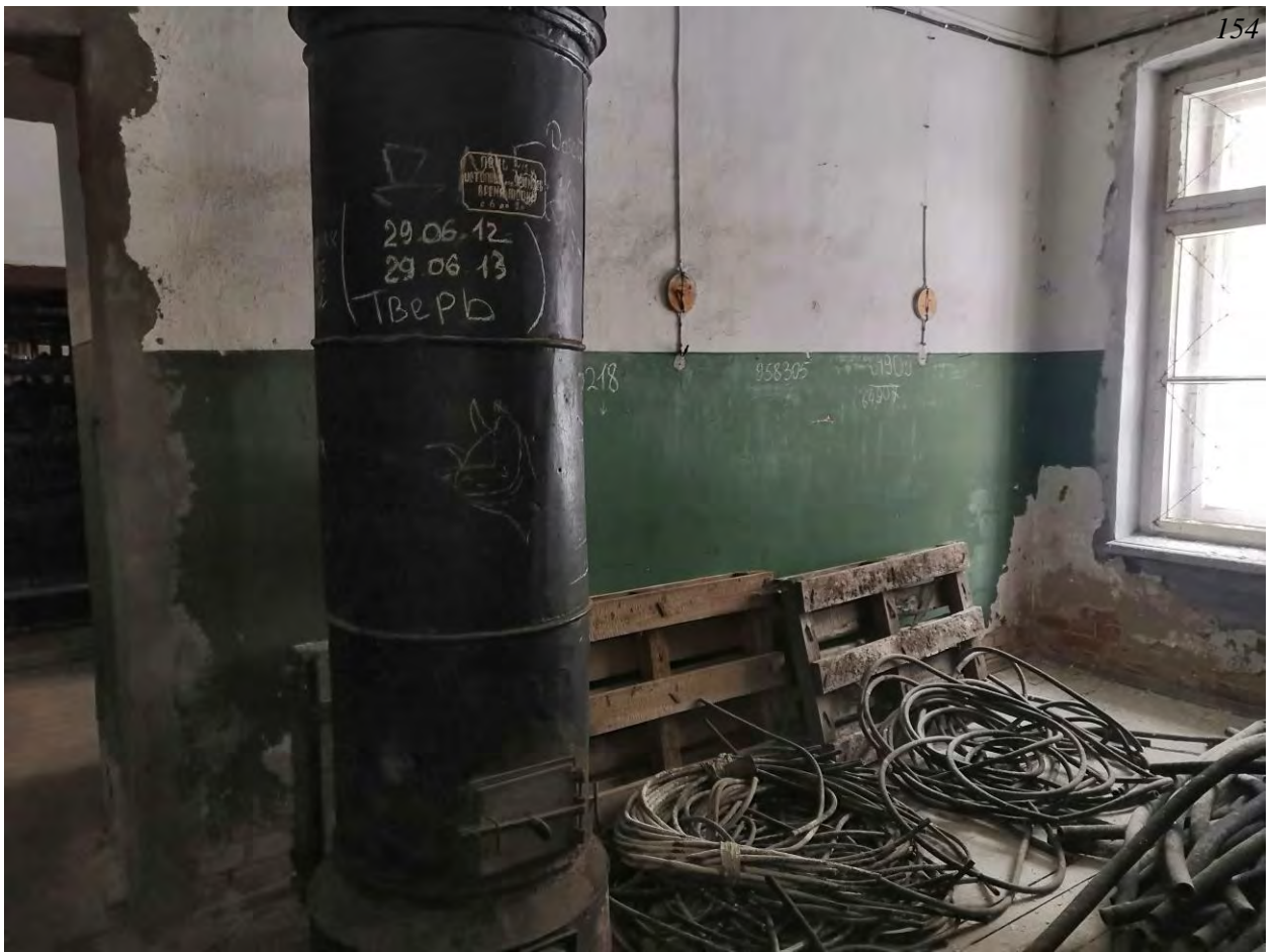
Фото.112. Казарма (расположена в центре территории военной части). Центральная часть. Ощий вид на помещение. Второй этаж.
