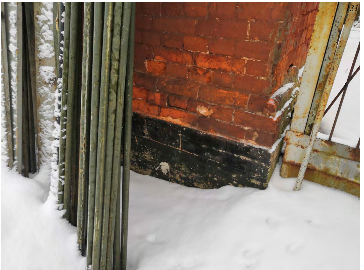
Фото.73. Казарма (расположена в центре территории военной части). Вид на цоколь.
