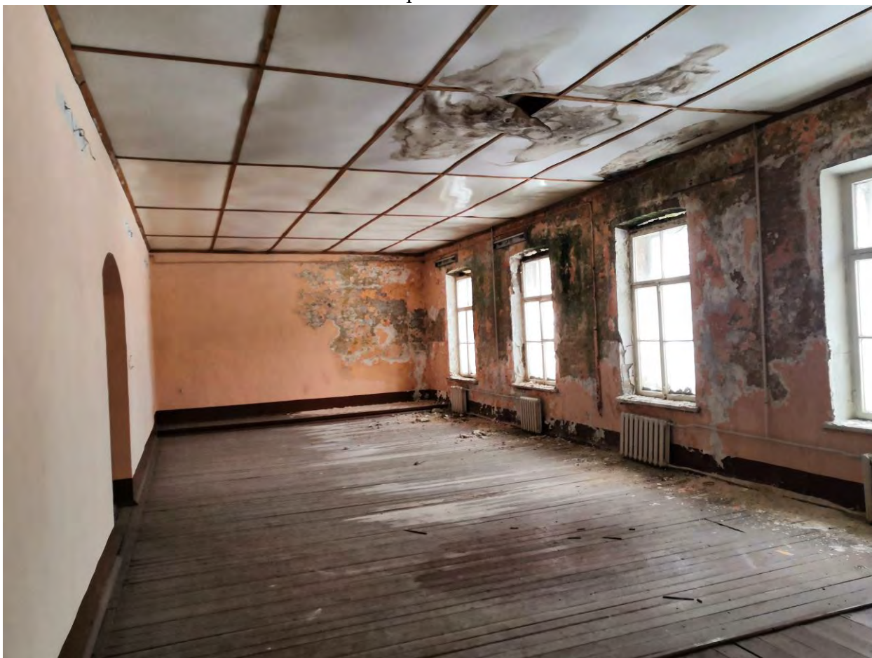
Фото.44. Казарма (г.Гатчина, проспект 25 Октября, 44). Восточная часть. Вид помещения. Второй этаж.
