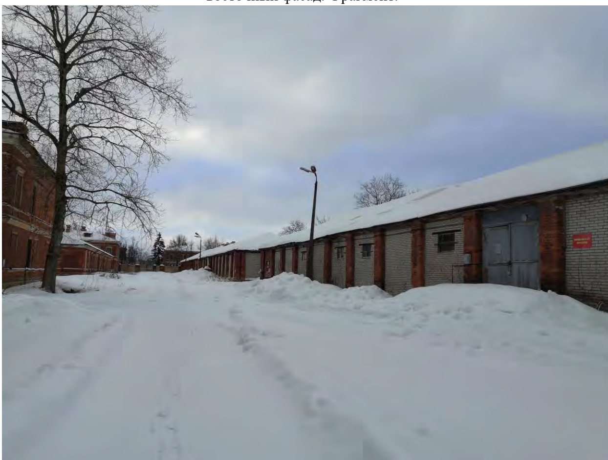
Фото.167. Западные сараи, два. (г.Гатчина, ул. 7-й Армии, 6 корпус 2). Вид на северо-восточный фасад.
