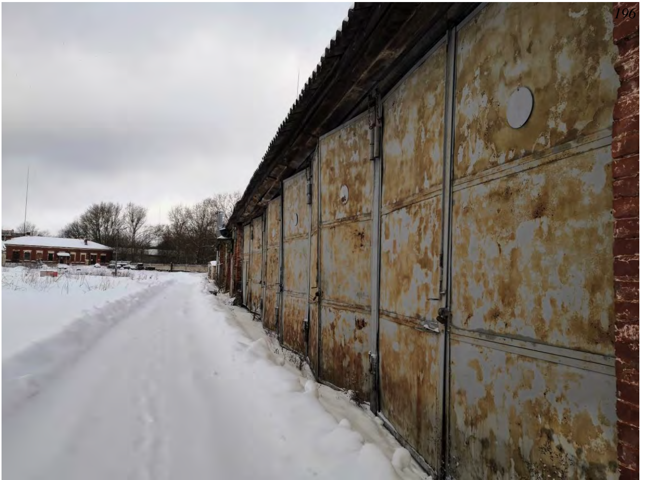
Фото.196. Конюшня (расположена на территории воинской части). Вид на западный фасад.
