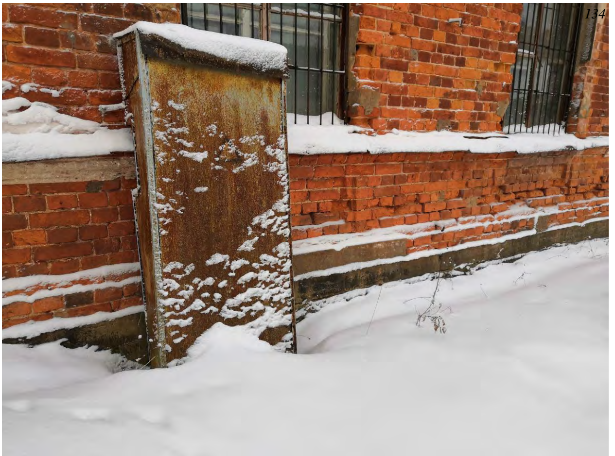
Фото.78. Казарма (расположена в центре территории военной части). Вид на цоколь.
