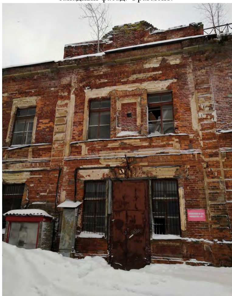
Фото.76. Казарма (расположена в центре территории военной части). Вид на северо-западный фасад. Фрагмент.
