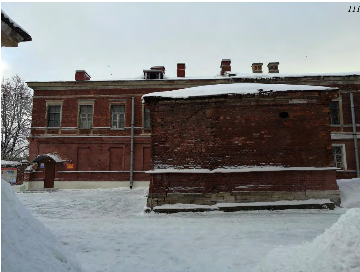
Фото.33. Казарма (г.Гатчина, проспект 25 Октября, 44). Вид на северо-западный фасад. Фрагмент.
