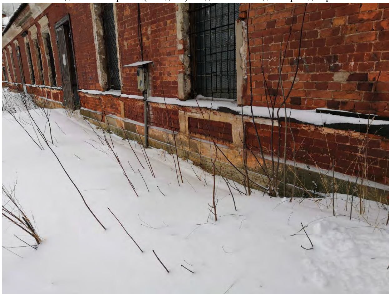
Фото.147. Здание мастерской (западное). Вид на цоколь юго-западного фасада. Фрагмент.
