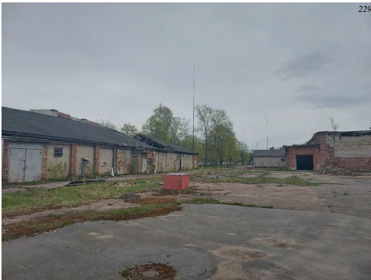
Фото.255. Территория в/ч 67651. Вид на объект «Конюшня».
