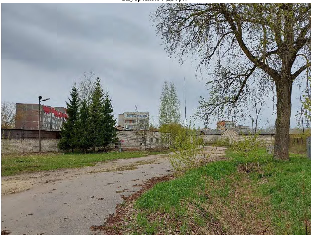
Фото.224. Территория в/ч 67651. Вид на ограждение и объекты в складской зоне внутреннего двора.
