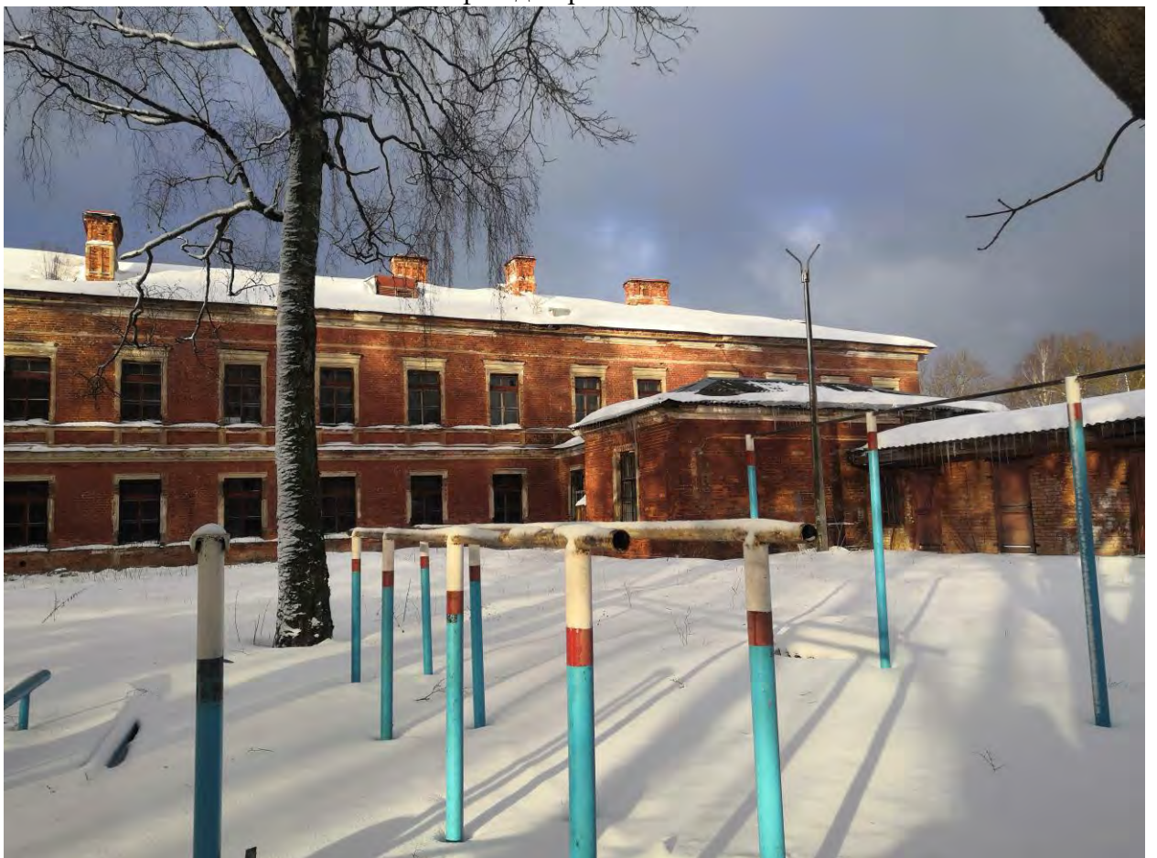
Фото.83. Казарма (расположена в центре территории военной части). Вид на юго-восточный фасад. Фрагмент.
