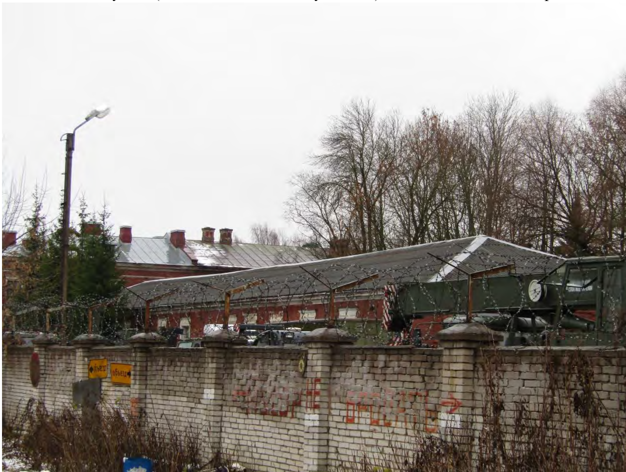
Фото.129. Здание мастерской (восточное). Вид на северо-восточный фасад.
