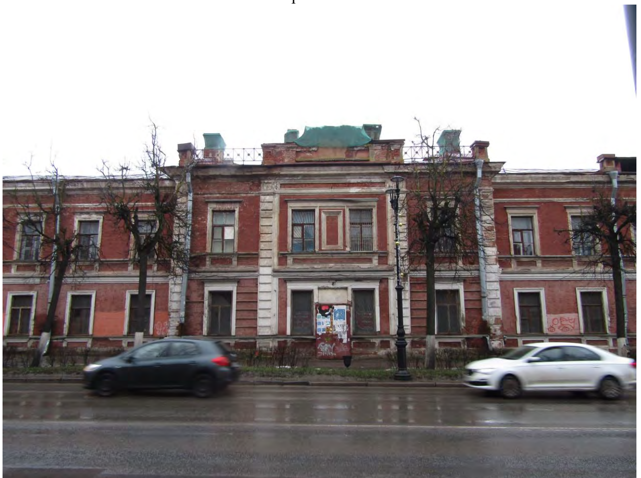
Фото.16. Казарма (г.Гатчина, проспект 25 Октября, 44). Вид на юго-восточный фасад. Фрагмент.
