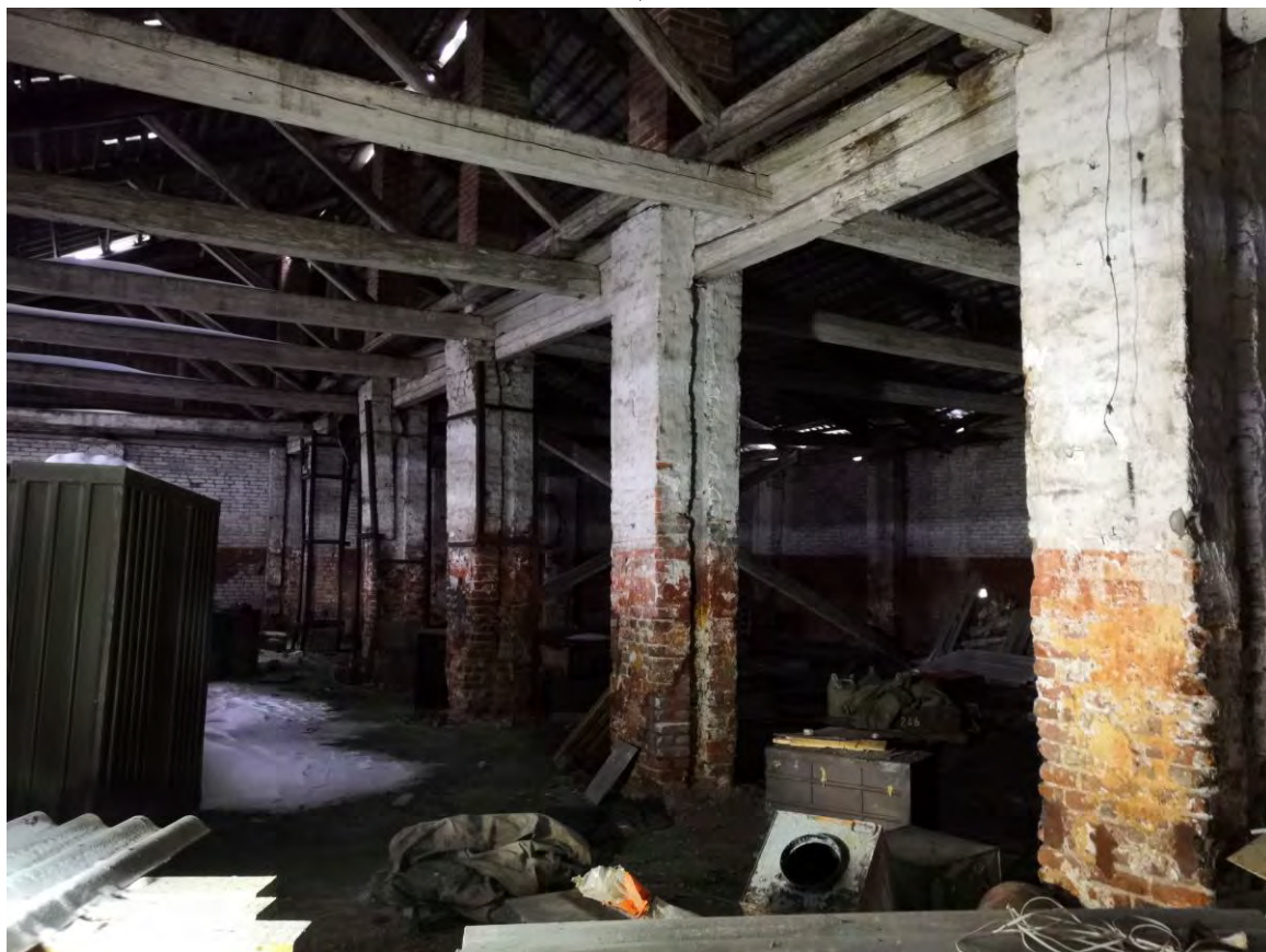
Фото.203. Конюшня (расположена на территории воинской части). Общий вид на помещение.
