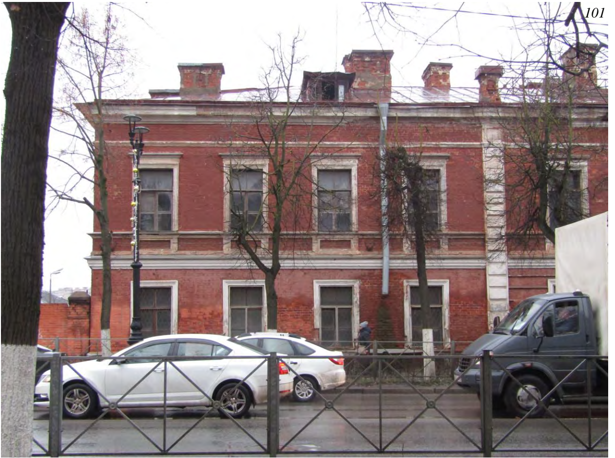
Фото.13. Казарма (г.Гатчина, проспект 25 Октября, 44). Вид на юго-восточный фасад. Фрагмент.
