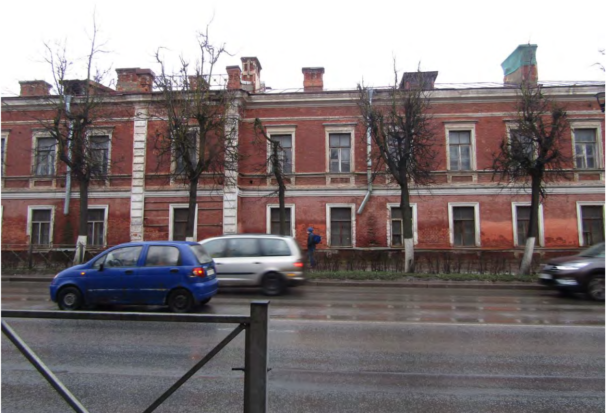
Фото.14. Казарма (г.Гатчина, проспект 25 Октября, 44). Вид на юго-восточный фасад. Фрагмент.
