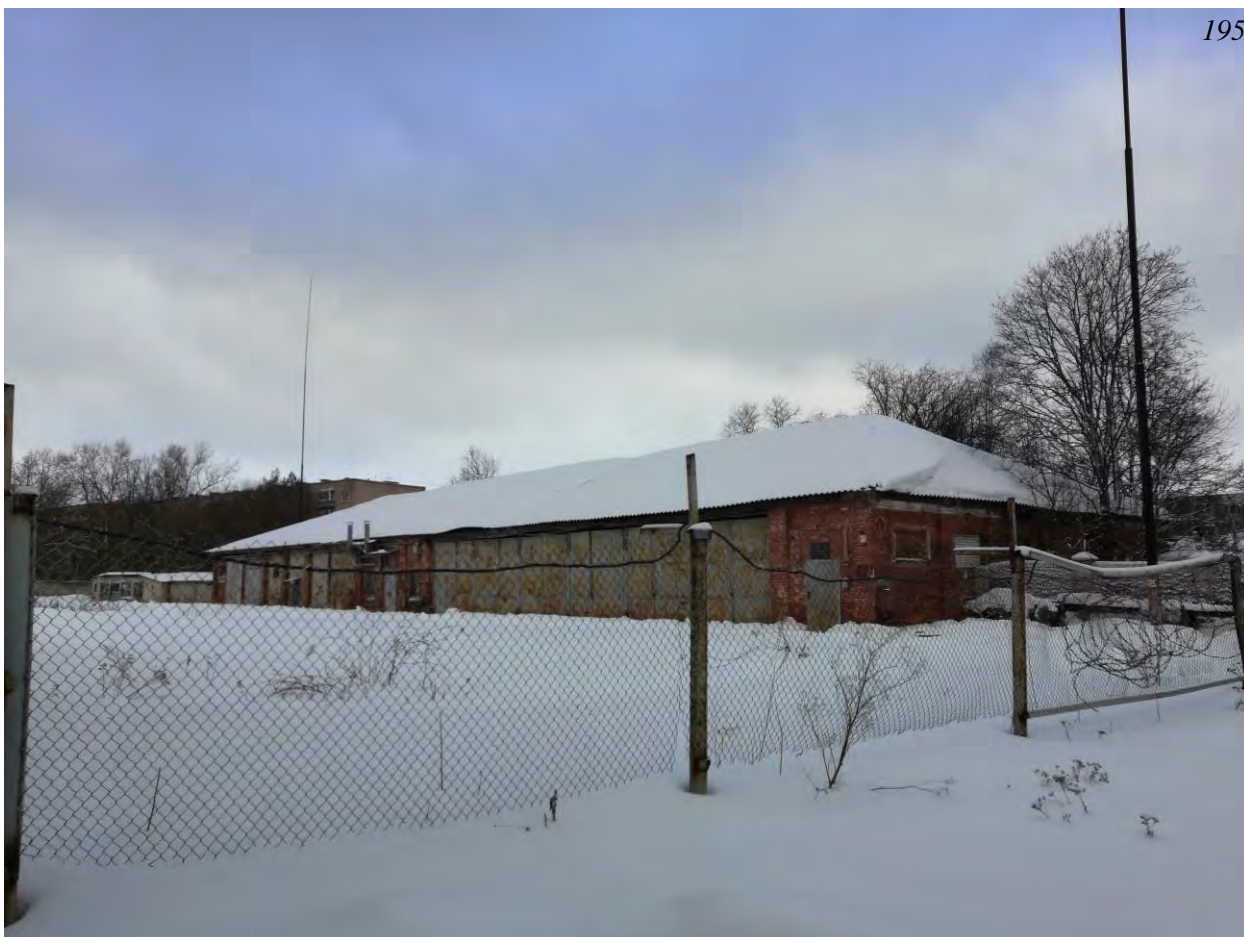
Фото.194. Конюшня (расположена на территории воинской части). Вид с юга.
