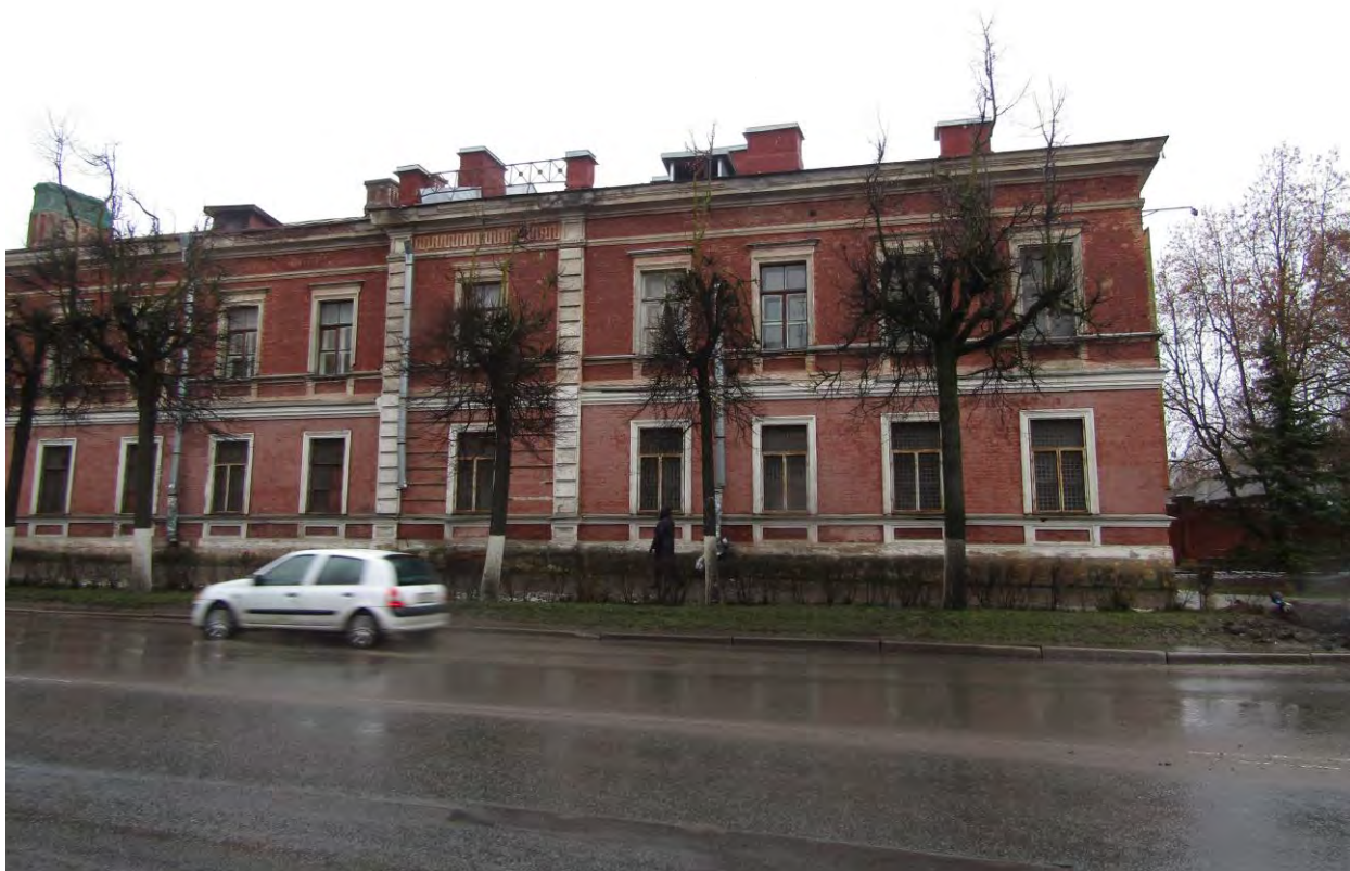
Фото.18. Казарма (г.Гатчина, проспект 25 Октября, 44). Вид на юго-восточный фасад. Фрагмент.
