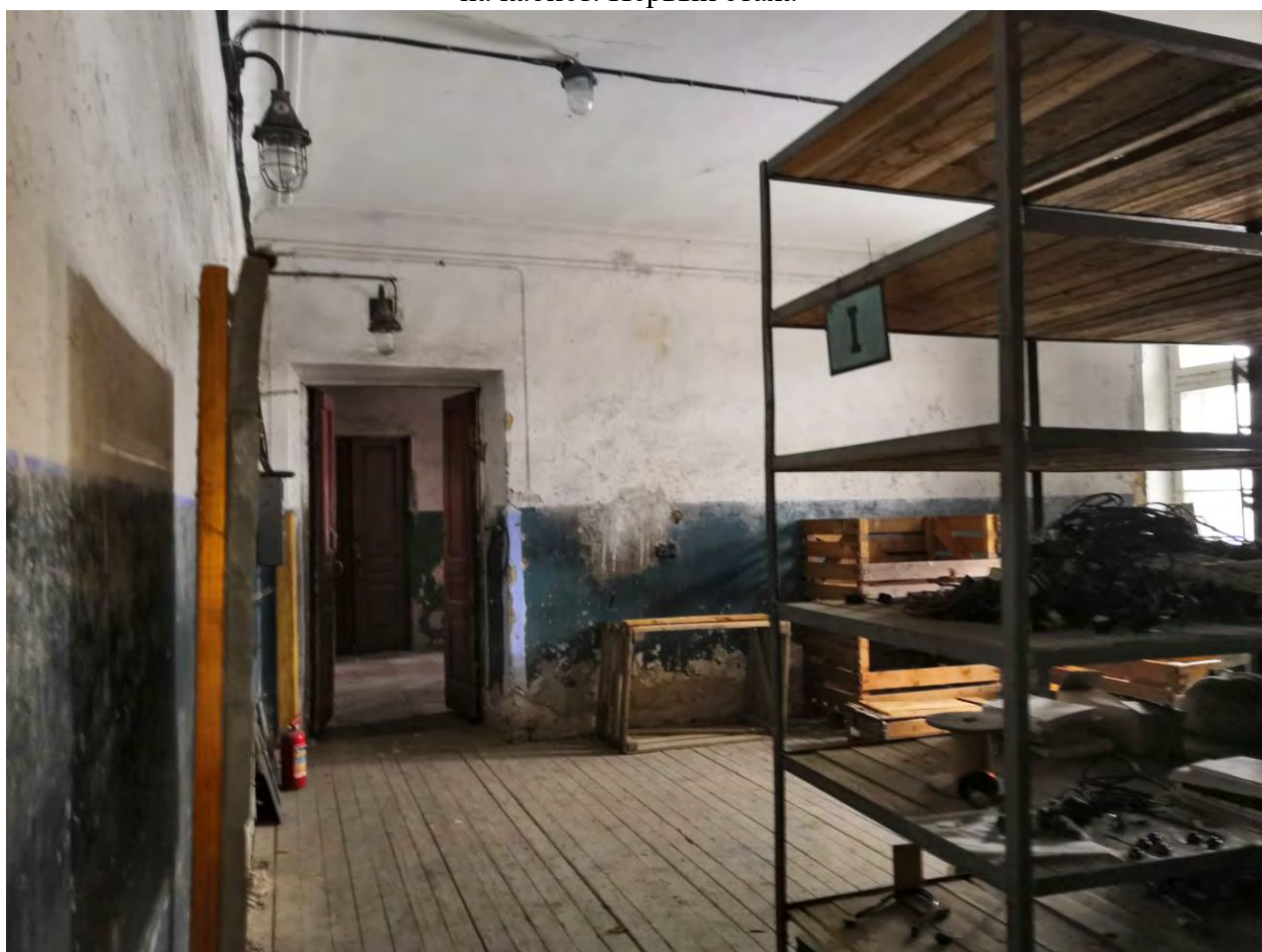
Фото.91. Казарма (расположена в центре территории военной части). Западная часть. Вид на складское помещение. Первый этаж.
