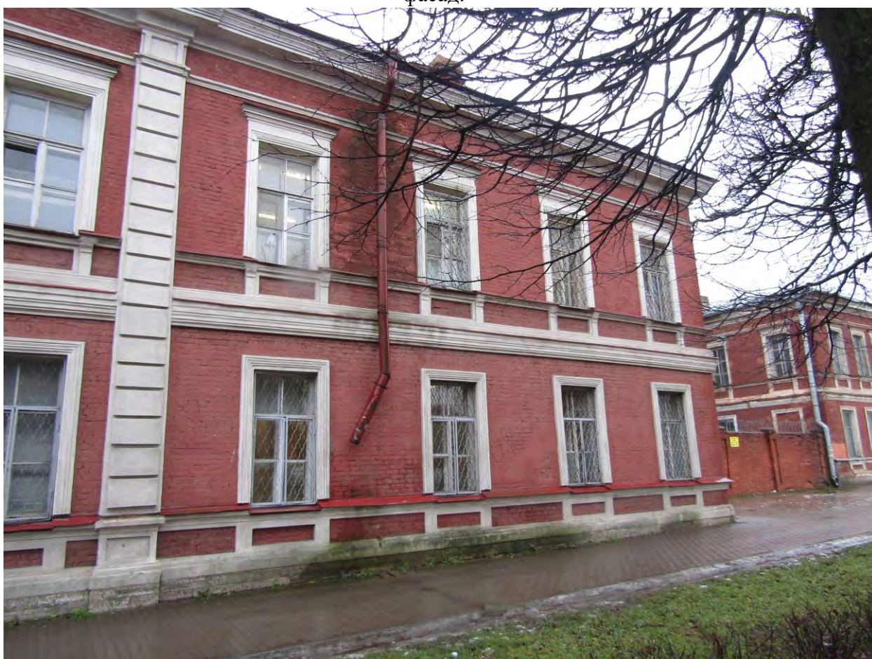
Фото.22. Казарма (г.Гатчина, проспект 25 Октября, 55). Вид на северо-западный фасад. Фрагмент.
