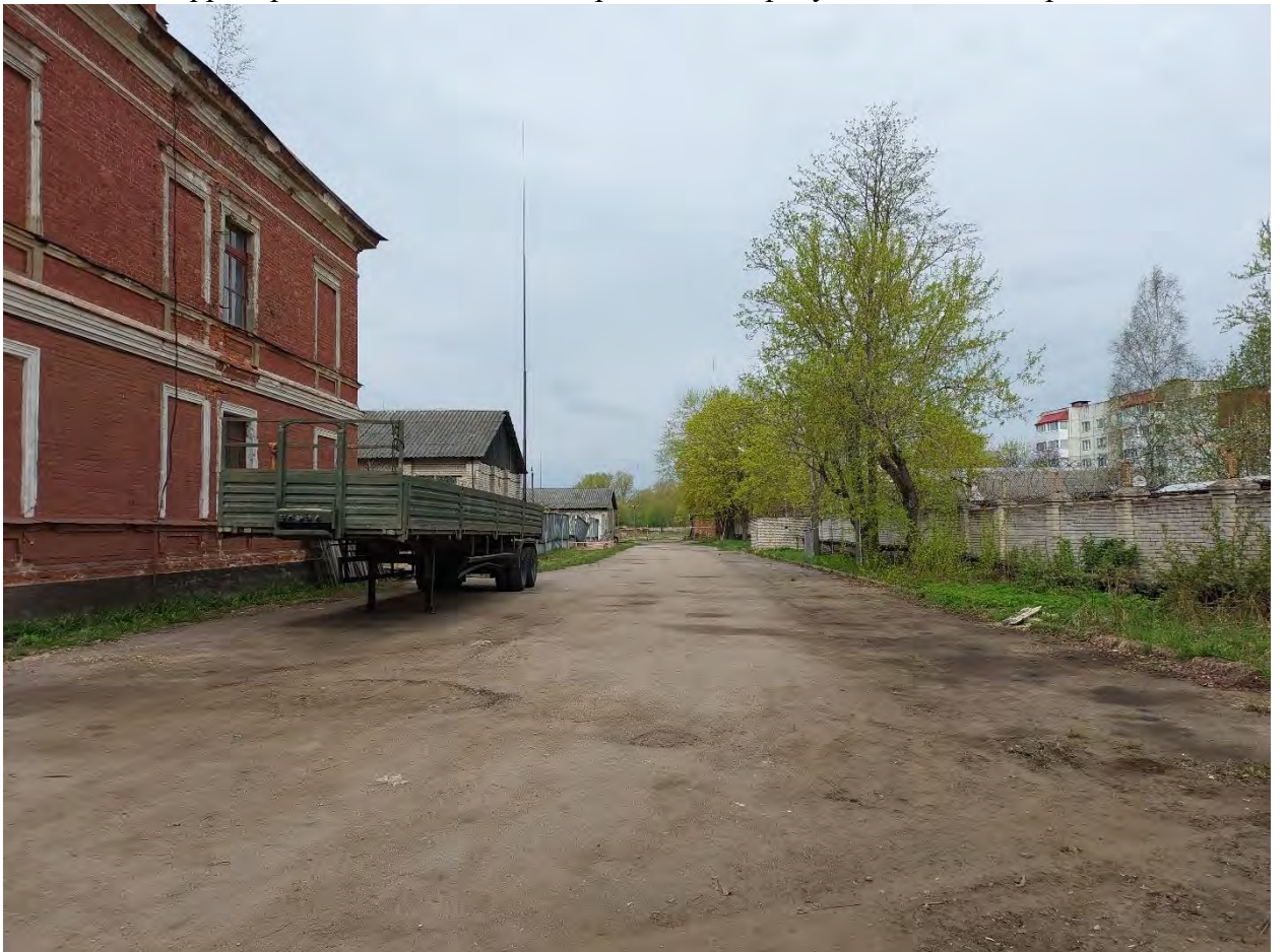
Фото.214. Территория в/ч 67651. Вид на проезд, бывшие казармы и ограждение.
