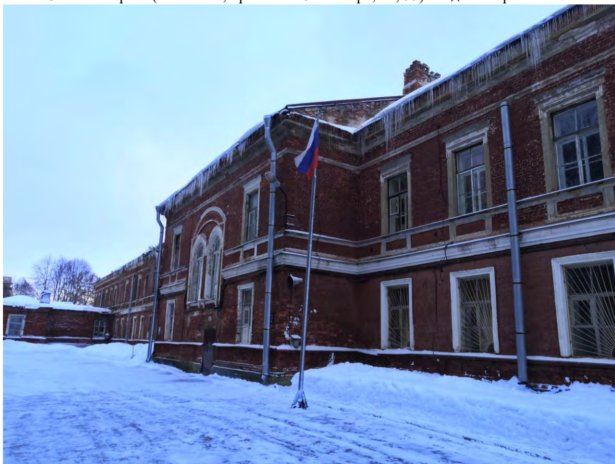
Фото.32. Казарма (г.Гатчина, проспект 25 Октября, 44). Вид на северо-западный фасад. Фрагмент.
