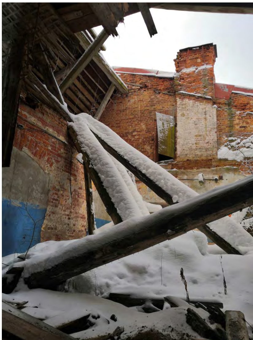
Фото.118. Казарма (расположена в центре территории военной части). Центральная часть. Ощй вид на помещение. Второй этаж.
