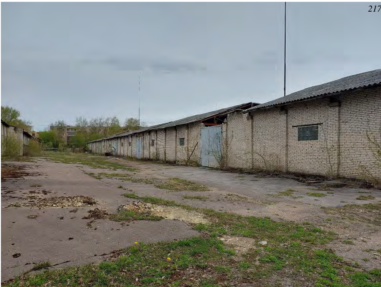
Фото.231. Территория в/ч 67651. Вид на объекты в складской зоне части.
