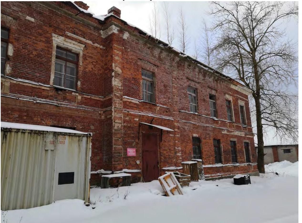
Фото.77. Казарма (расположена в центре территории военной части). Вид на северо-западный фасад. Фрагмент.
