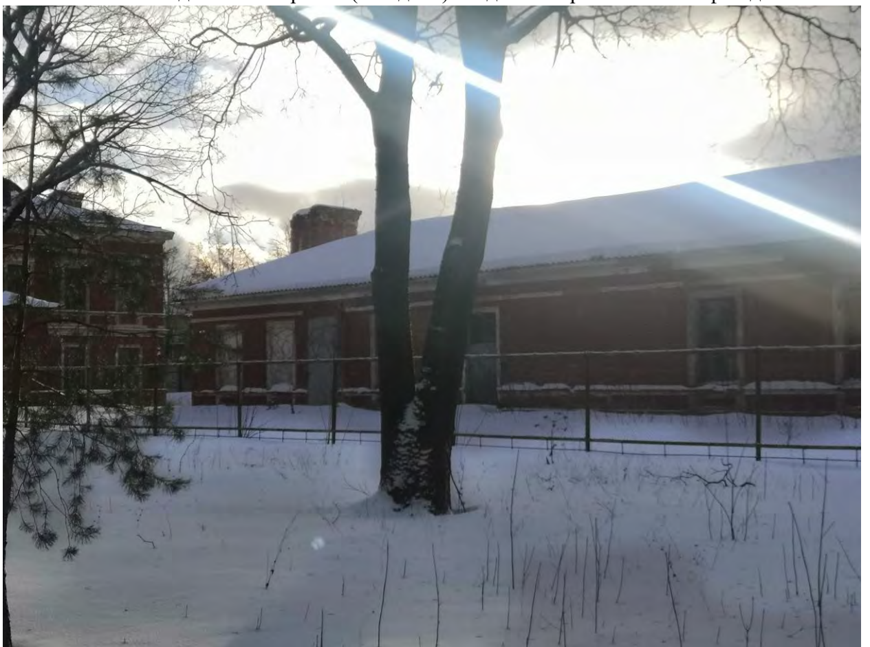
Фото.149. Здание мастерской (западное). Вид на северо-восточный фасад. Фрагмент.
