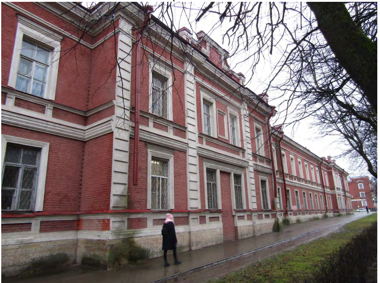
Фото.26. Казарма (г.Гатчина, проспект 25 Октября, 55). Вид на северо-западный фасад. Фрагмент.
