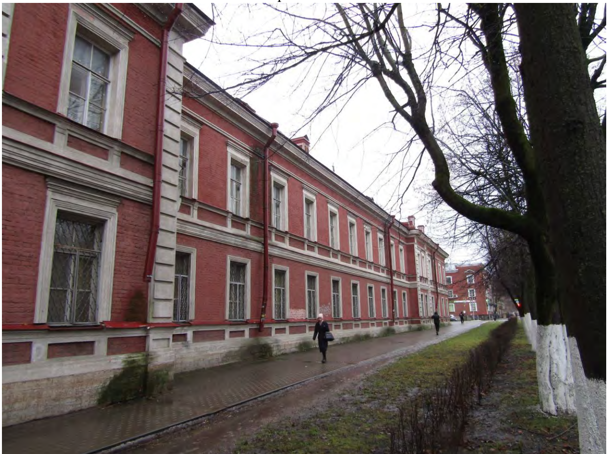
Фото.24. Казарма (г.Гатчина, проспект 25 Октября, 55). Вид на северо-западный фасад. Фрагмент.
