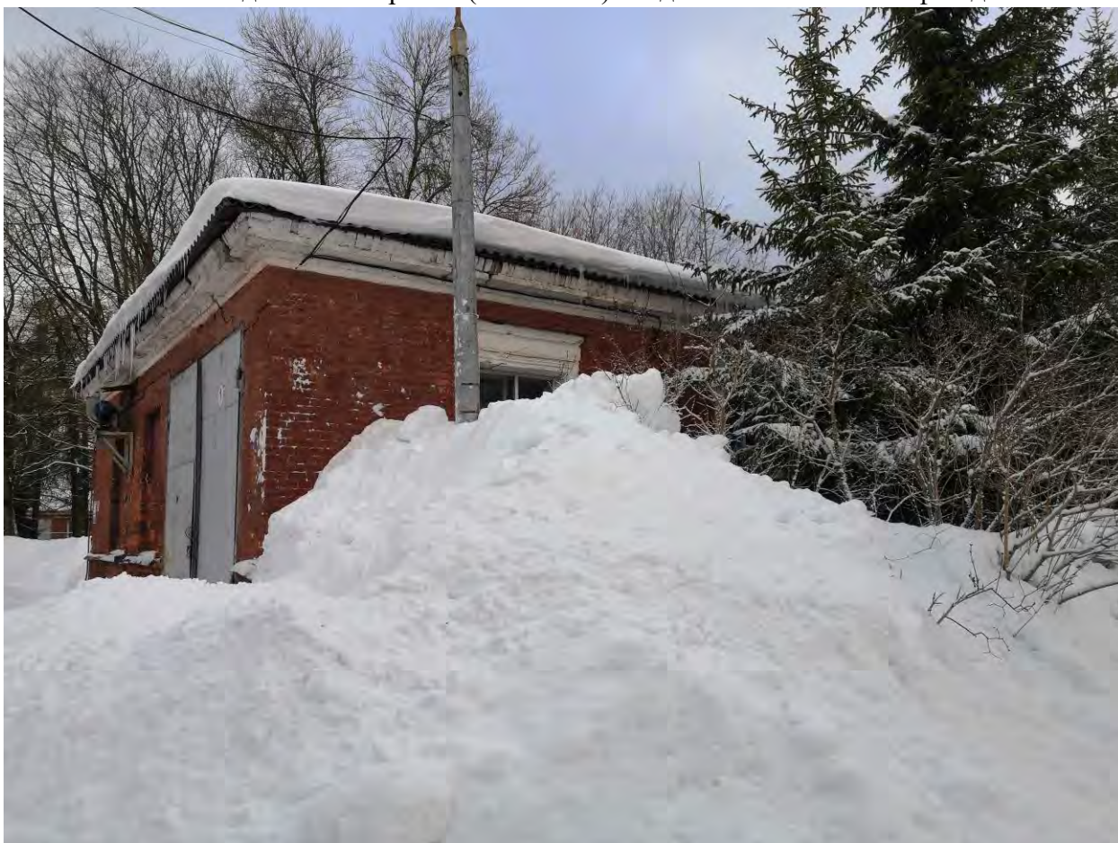
Фото.131. Здание мастерской (восточное). Вид на северо-восточный фасад. Фрагмент.
