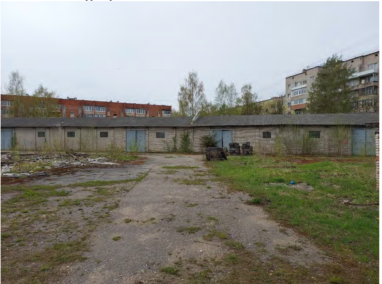
Фото.252. Территория в/ч 67651. Вид на объекты в складской зоне части.
