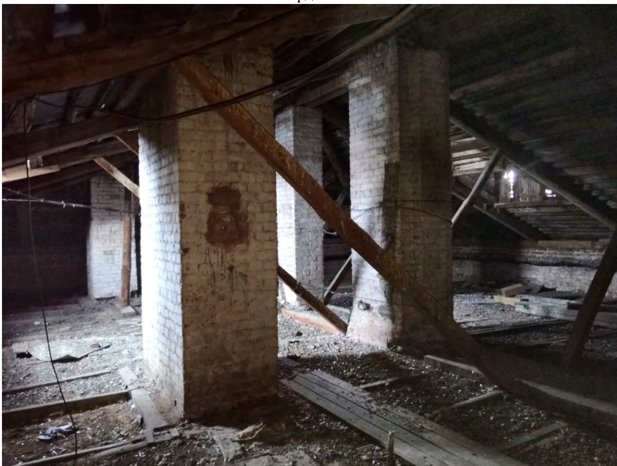
Фото.70. Казарма (г.Гатчина, проспект 25 Октября, 44). Вид на чердак.
