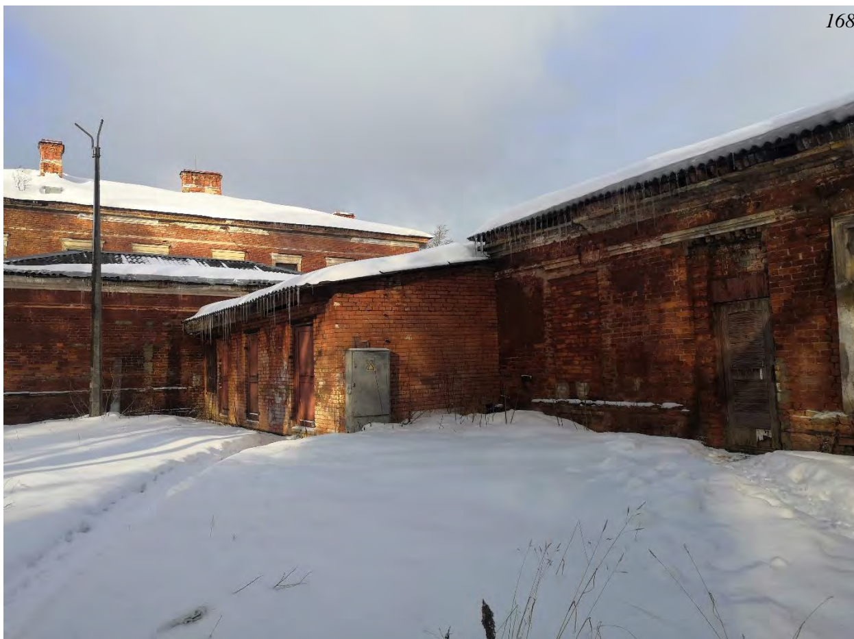
Фото.140. Здание мастерской (восточное). Вид на юго-западный фасад. Фрагмент.
