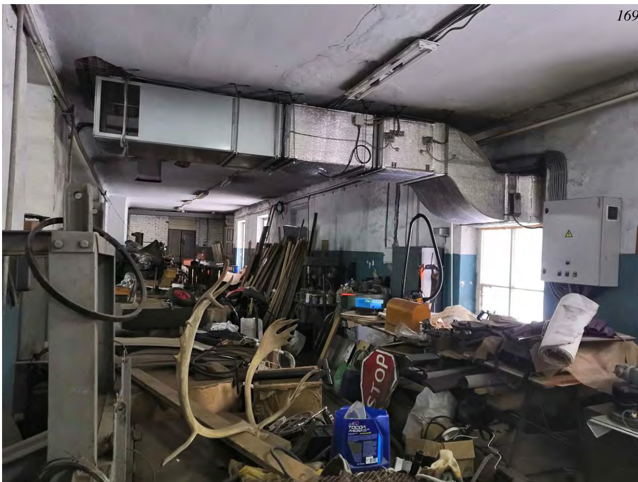
Фото.142. Здание мастерской (восточное). Общий вид на помещение.
