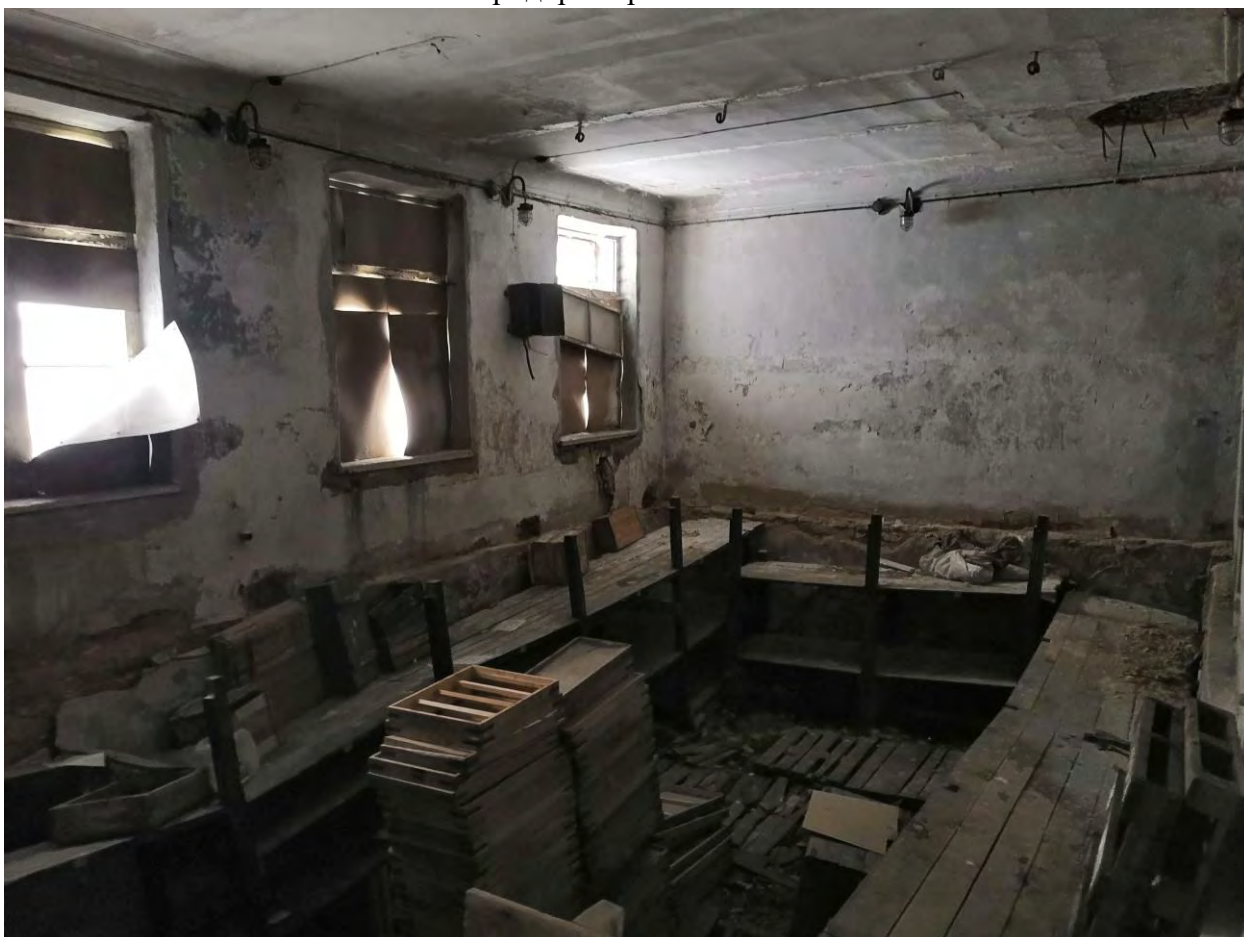
Фото.94. Казарма (расположена в центре территории военной части). Западная часть. Вид на помещение. Первый этаж.
