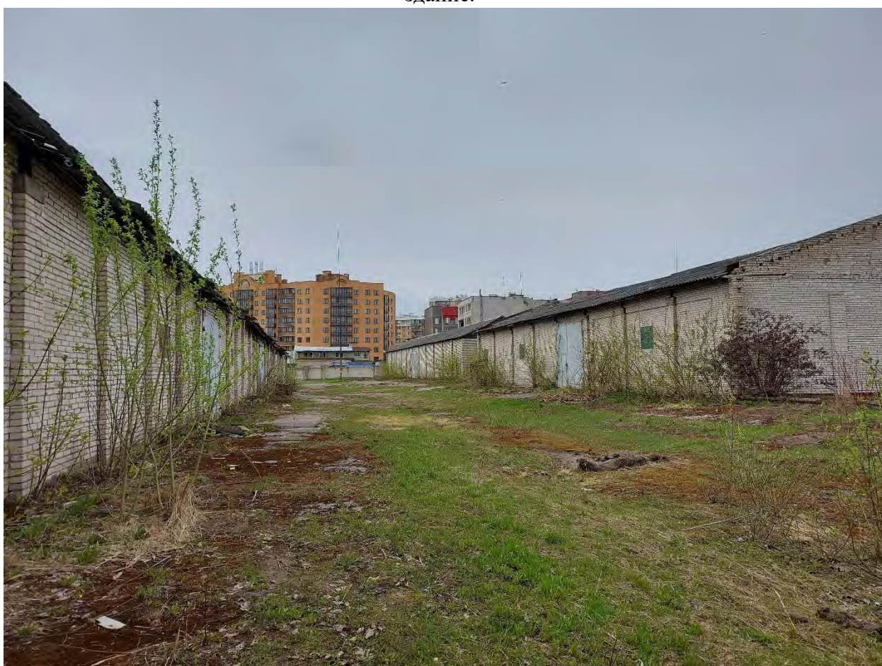
Фото.250. Территория в/ч 67651. Вид на объекты в складской зоне части.
