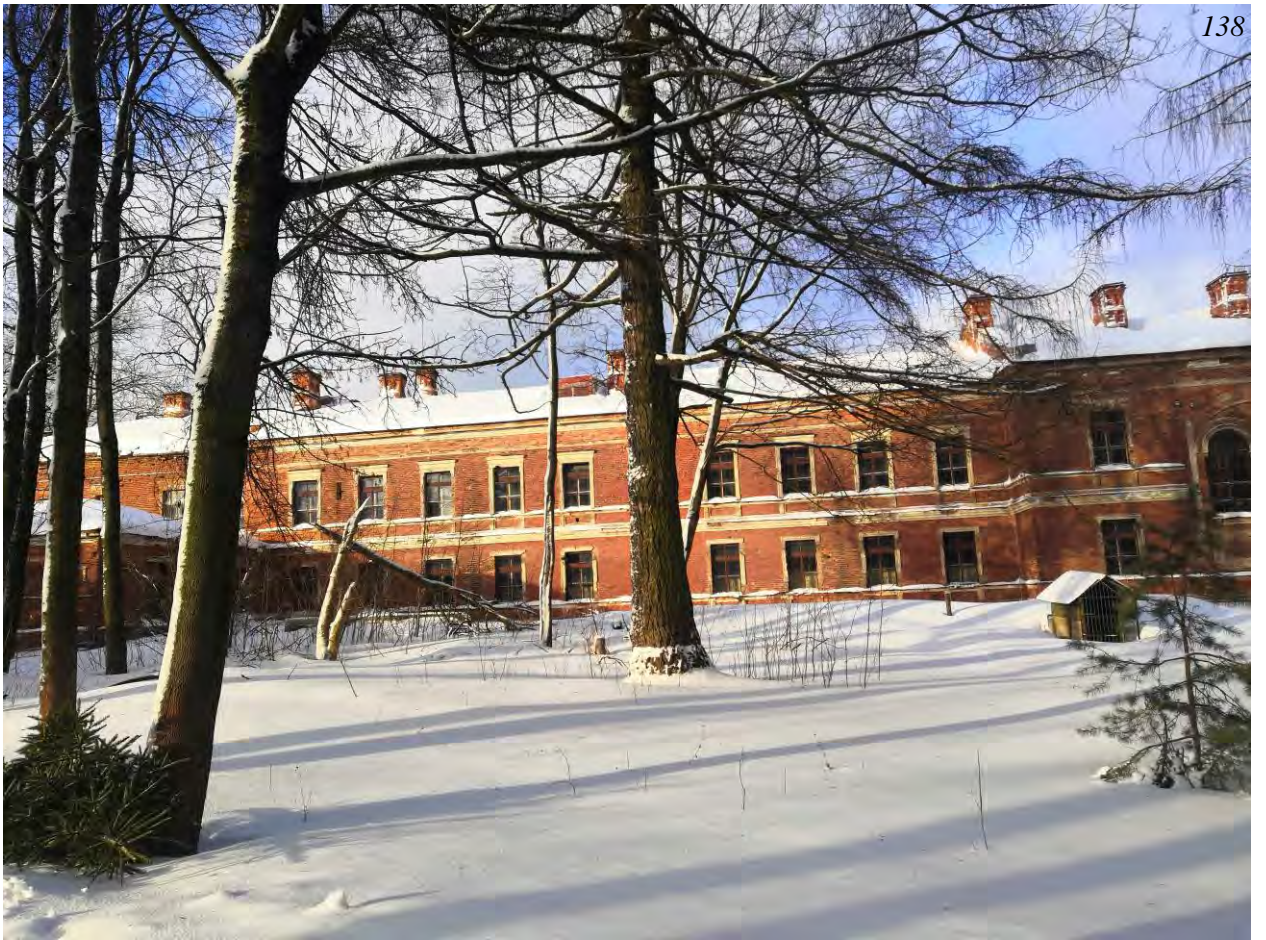
Фото.86. Казарма (расположена в центре территории военной части). Вид на юго-восточный фасад. Фрагмент.
