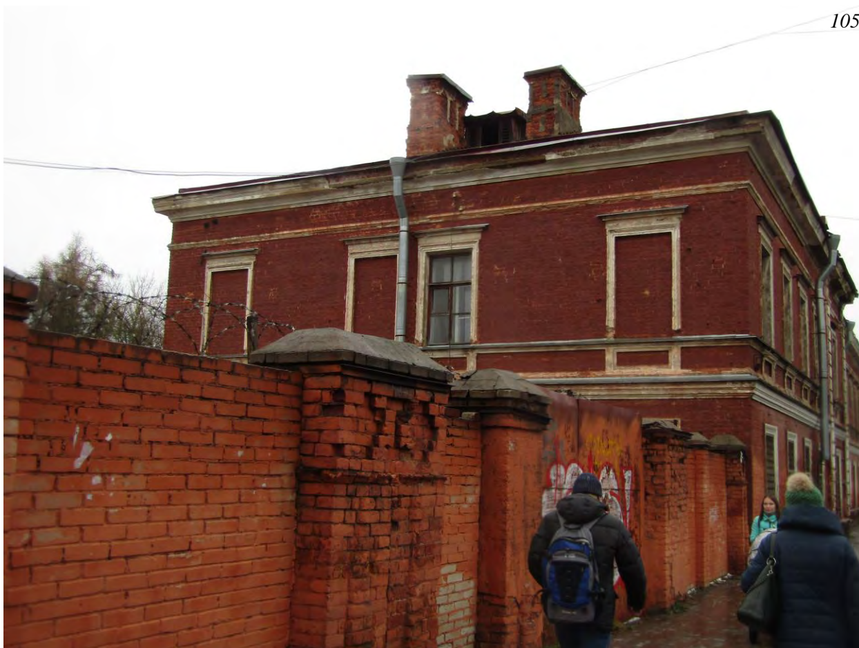
Фото.21. Казарма (г.Гатчина, проспект 25 Октября, 44). Вид на торцевой юго-западный фасад.
