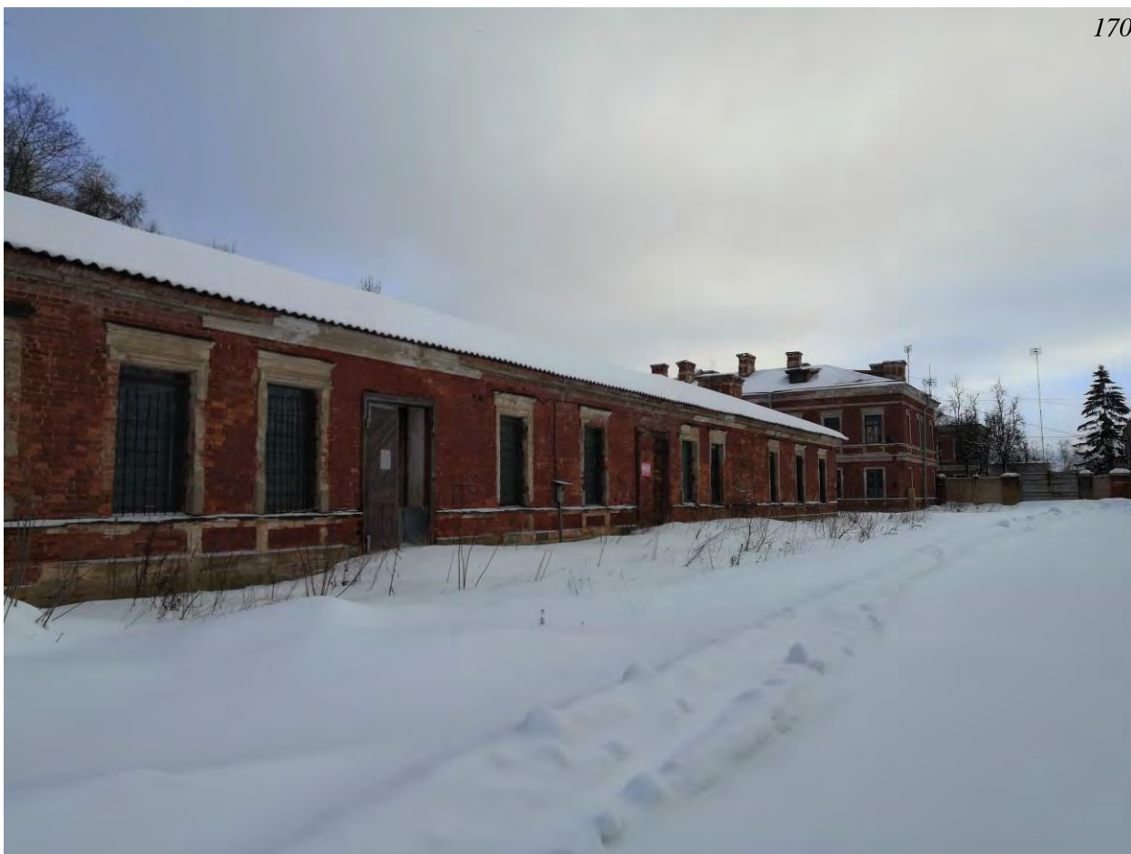
Фото.144. Здание мастерской (западное). Вид на юго-западный фасад. Фрагмент.
