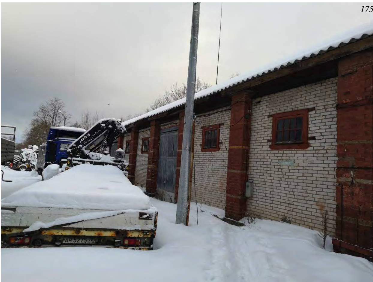
Фото.154. Артиллерийский сарай (расположено на внутренней территории военной части). Вид на юго-западный фасад. Фрагмент.
