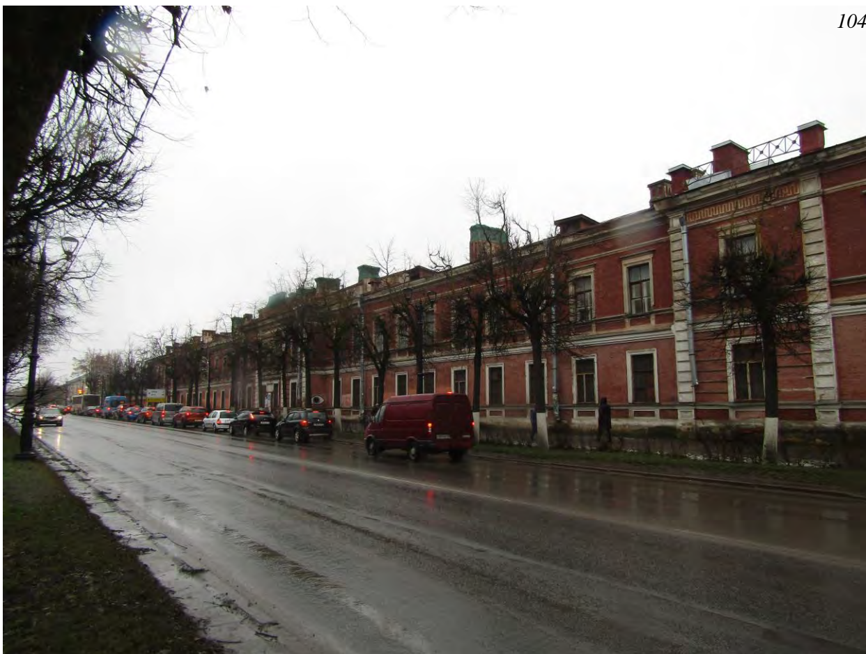
Фото.19. Казарма (г.Гатчина, проспект 25 Октября, 44). Вид на юго-восточный фасад с северо-востока.
