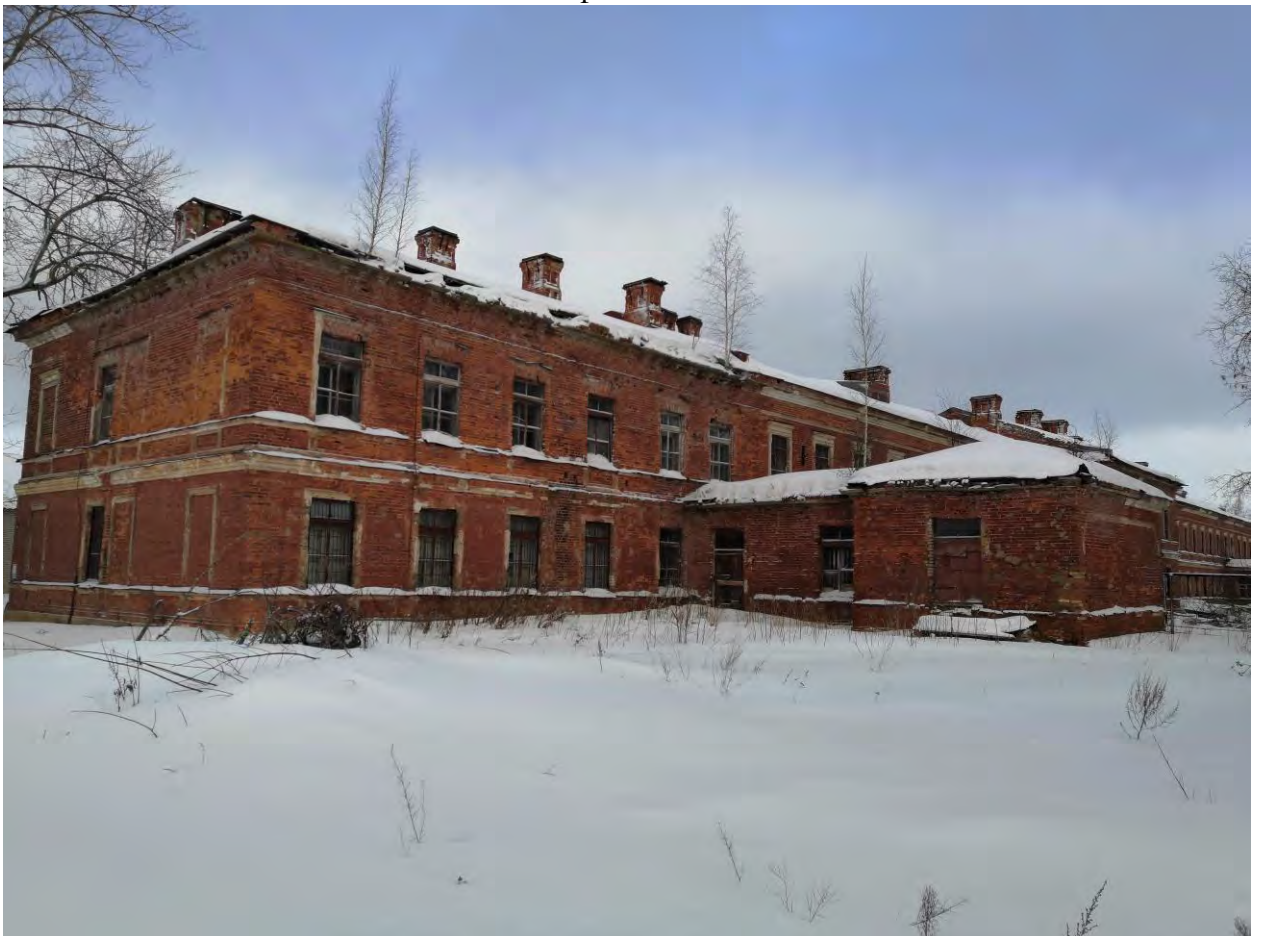
Фото.81. Казарма (расположена в центре территории военной части). Вид на юго-восточный фасад. Фрагмент.
