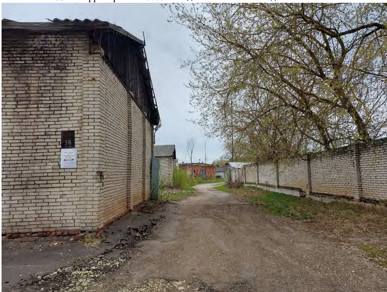
Фото.234. Территория в/ч 67651. Вид на проезд в складской зоне части.
