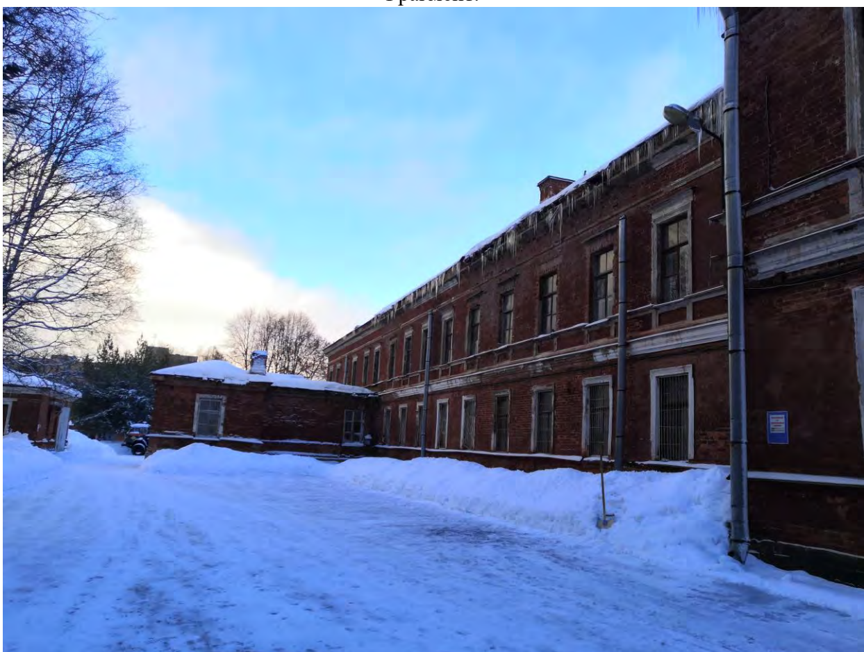
Фото.36. Казарма (г.Гатчина, проспект 25 Октября, 44). Вид на северо-западный фасад. Фрагмент.
