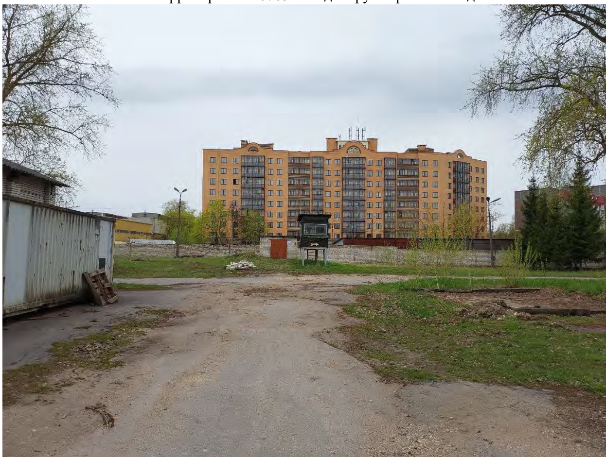
Фото.222. Территория в/ч 67651. Вид на ограждение в складской зоне внутреннего двора.
