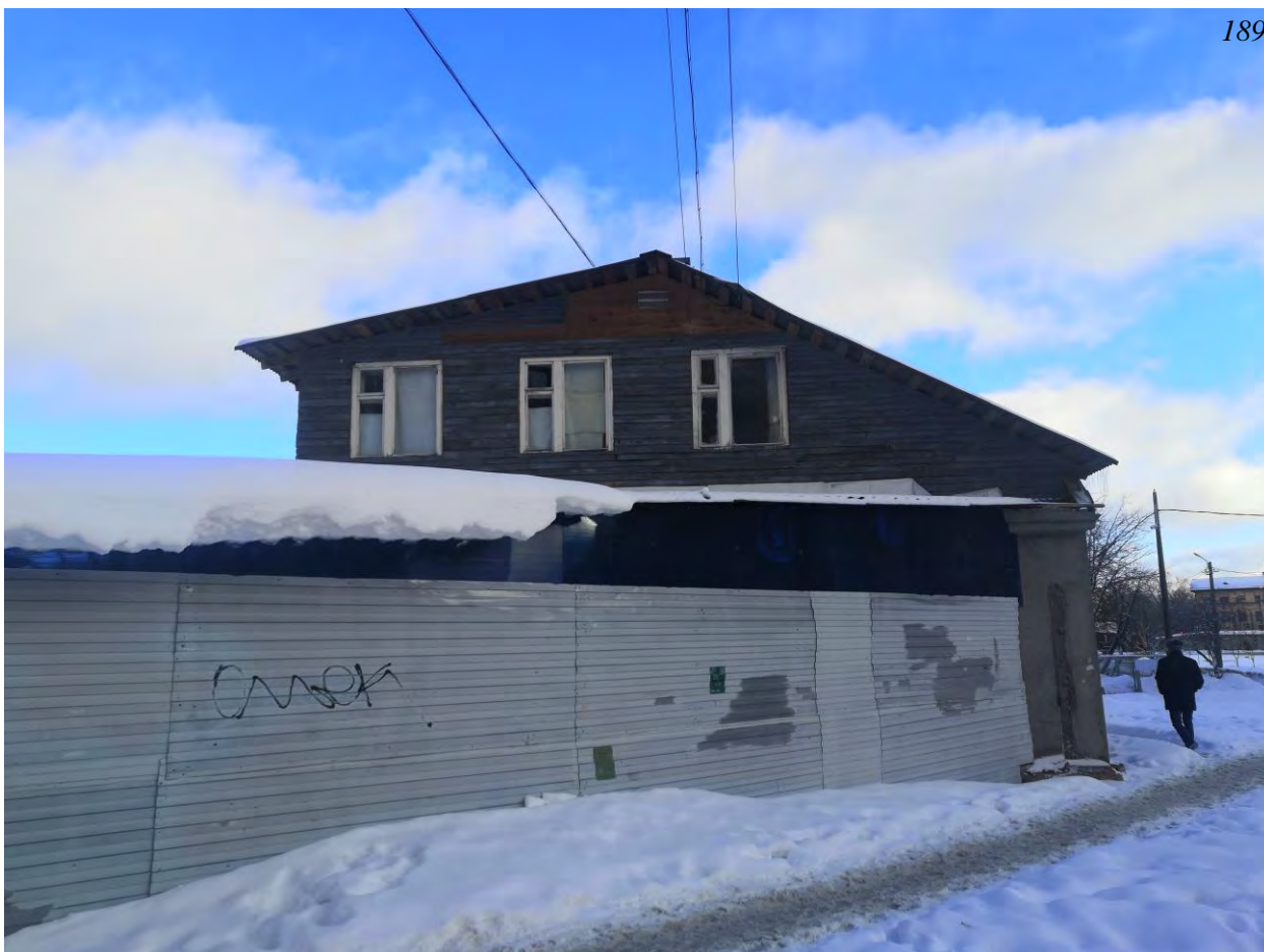
Фото.182. Кузница (г. Гатчина, улица 7-й Армии, 6А). Вид на западный фасад.
