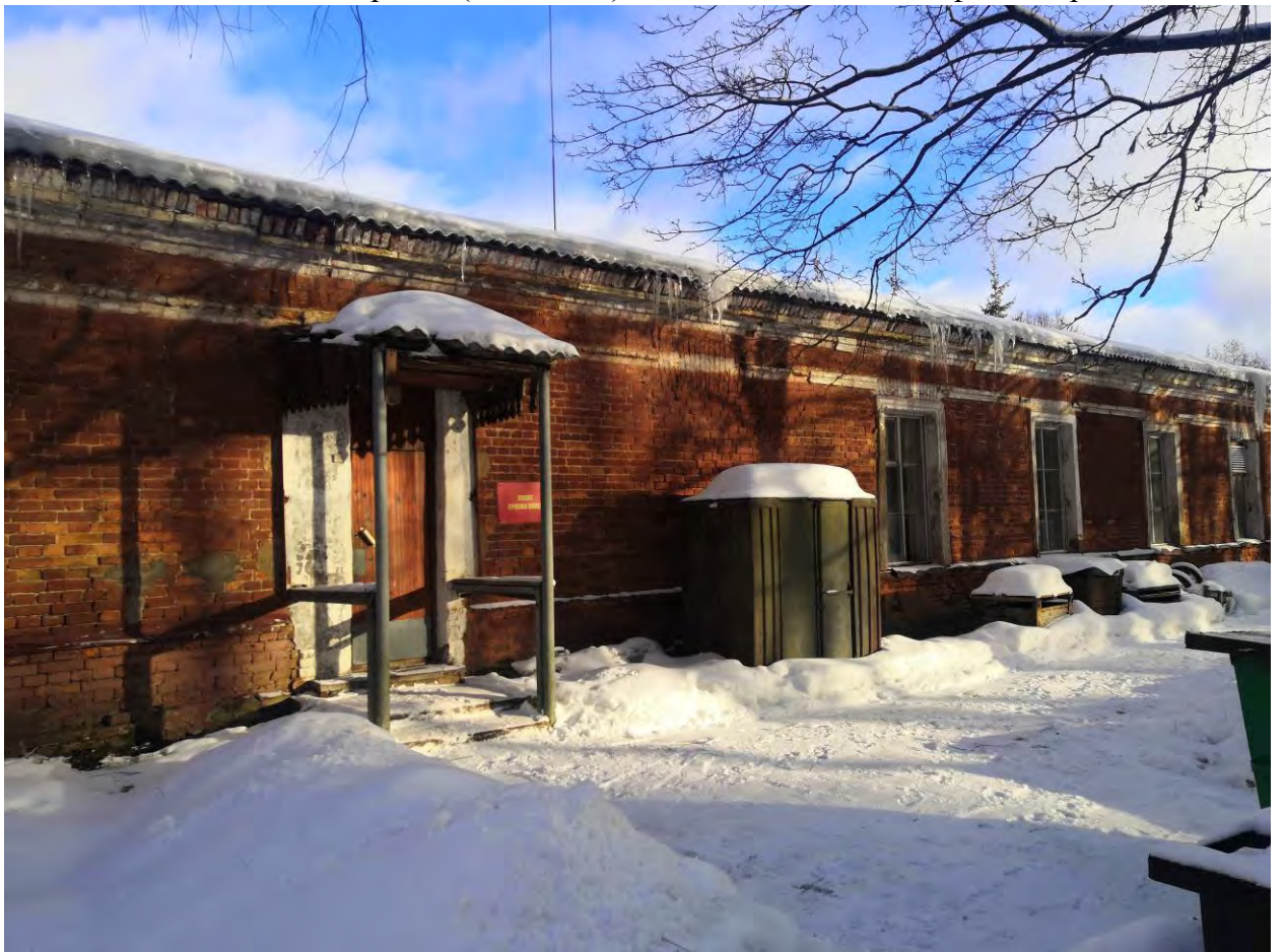
Фото.139. Здание мастерской (восточное). Вид на юго-западный фасад. Фрагмент.
