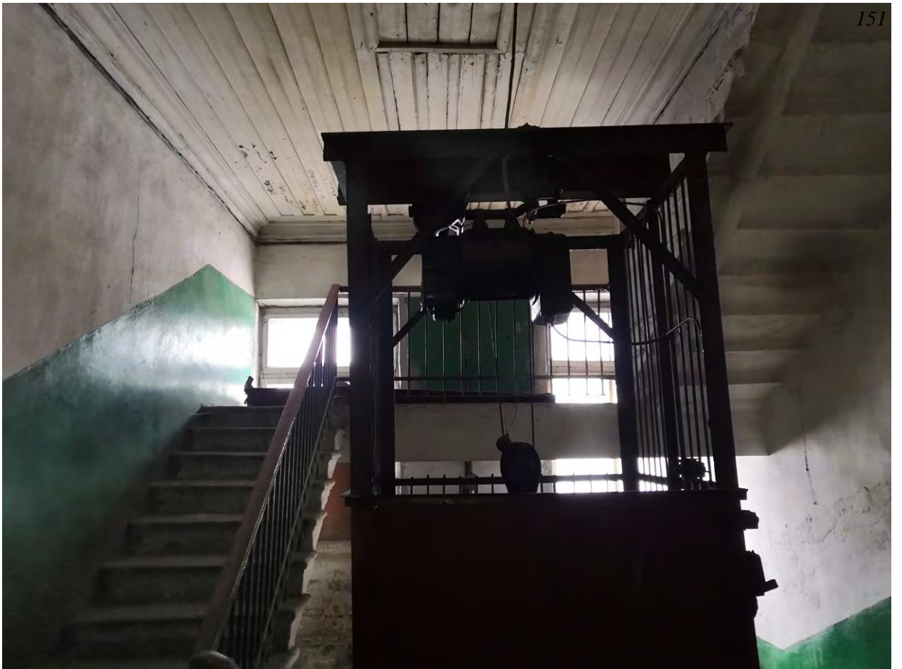
Фото.107. Казарма (расположена в центре территории военной части). Вид на центральную ЛК. Второй этаж.
