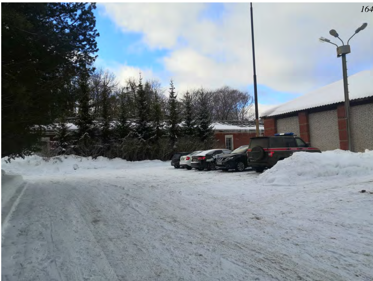
Фото.132. Здание мастерской (восточное). Вид на северо-восточный фасад. Фрагмент.
