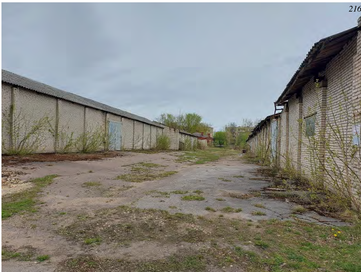
Фото.229. Территория в/ч 67651. Вид на объекты в складской зоне части.
