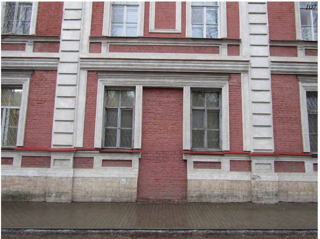
107 Фото.25. Казарма (г.Гатчина, проспект 25 Октября, 55). Вид на северо-западный фасад. Фрагмент.
