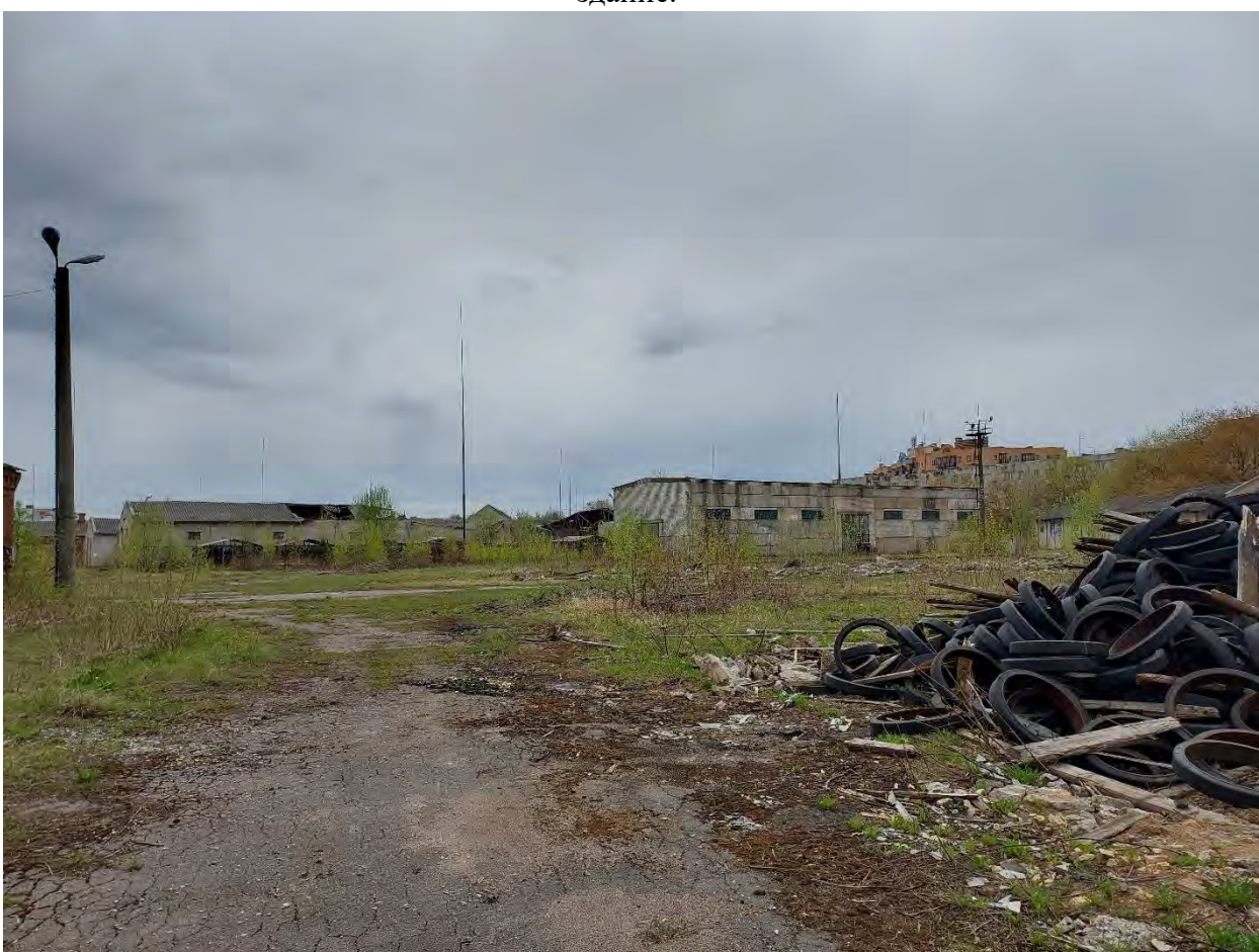
Фото.244. Территория в/ч 67651. Вид на объекты в складской зоне части.
