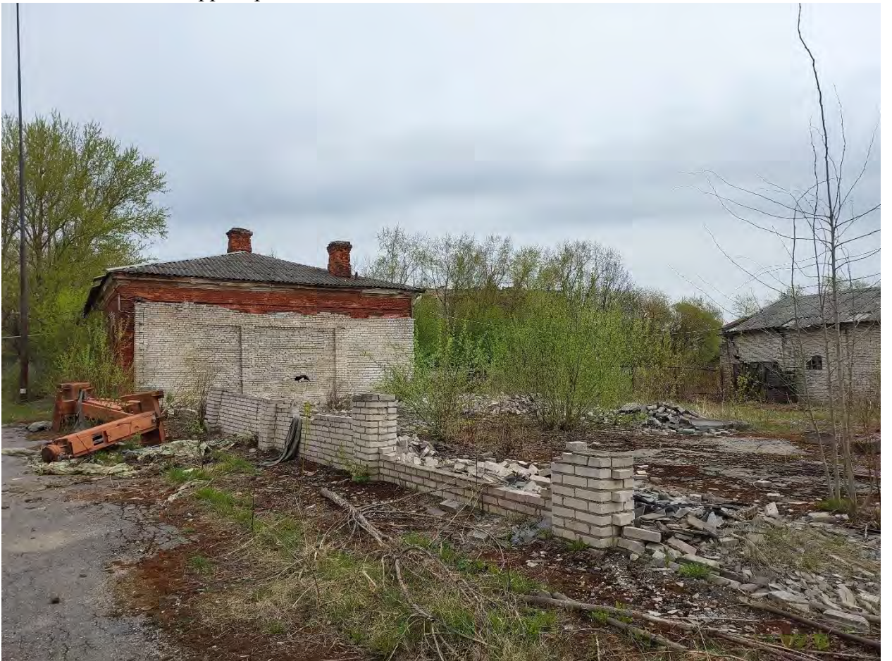
Фото.248. Территория в/ч 67651. Вид на объекты в складской зоне части.
