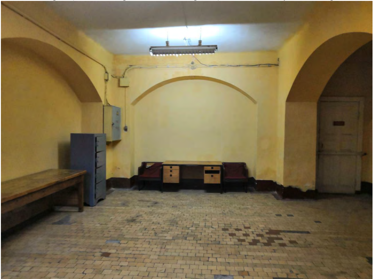
Фото.60. Казарма (г.Гатчина, проспект 25 Октября, 44). Вид на центральный холл. Первый этаж.
