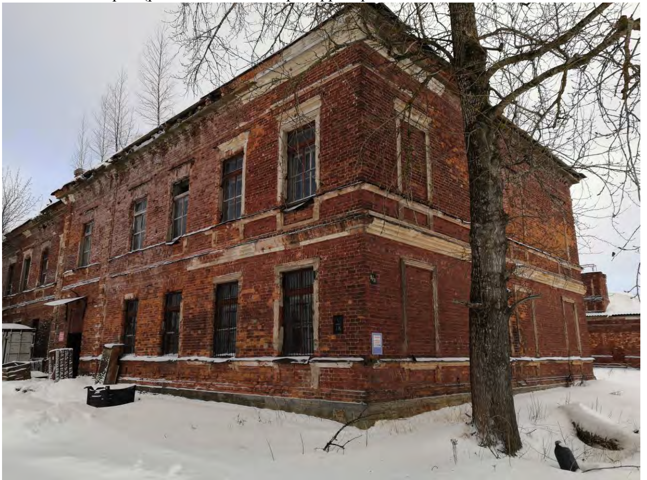
Фото.79. Казарма (расположена в центре территории военной части). Вид на северо-западный и юго-западный фасады.
