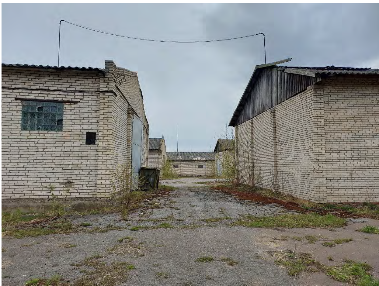
Фото.236. Территория в/ч 67651. Вид на объекты в складской зоне части.
