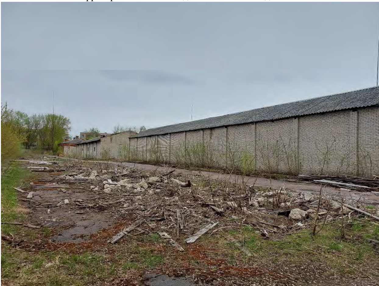
Фото.232. Территория в/ч 67651. Вид на объекты в складской зоне части.
