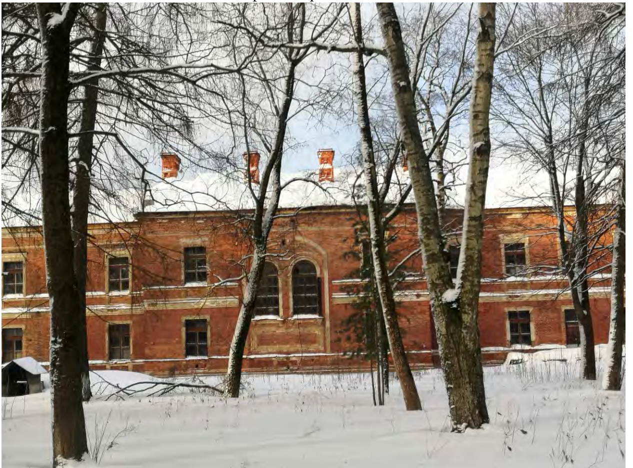
Фото.85. Казарма (расположена в центре территории военной части). Вид на юго-восточный фасад. Фрагмент.
