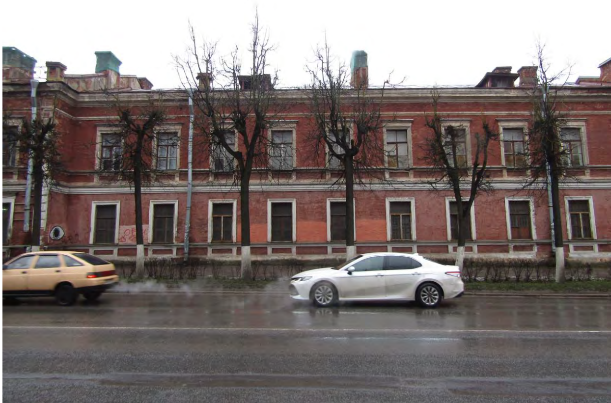
Фото.17. Казарма (г.Гатчина, проспект 25 Октября, 44). Вид на юго-восточный фасад. Фрагмент.
