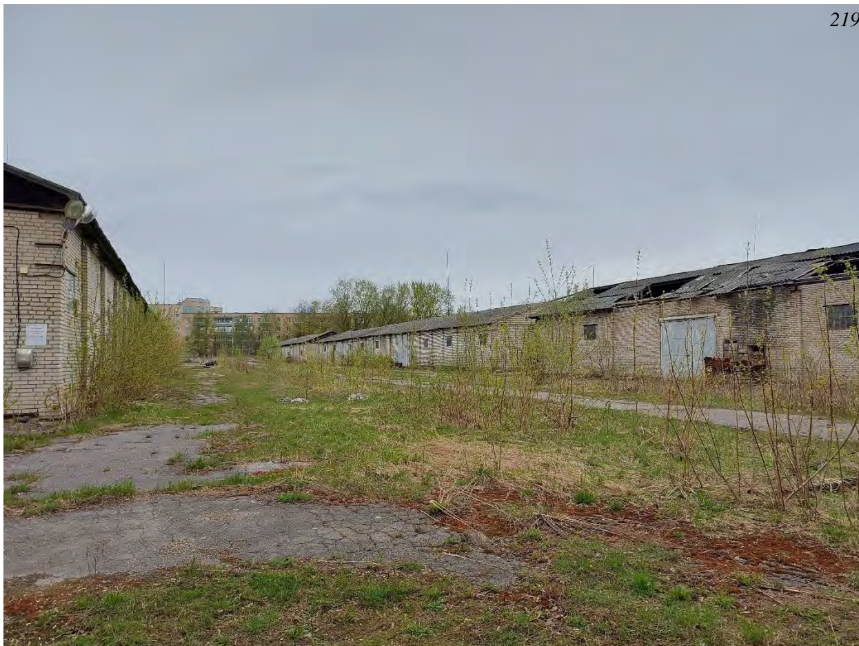
Фото.235. Территория в/ч 67651. Вид на объекты в складской зоне части.
