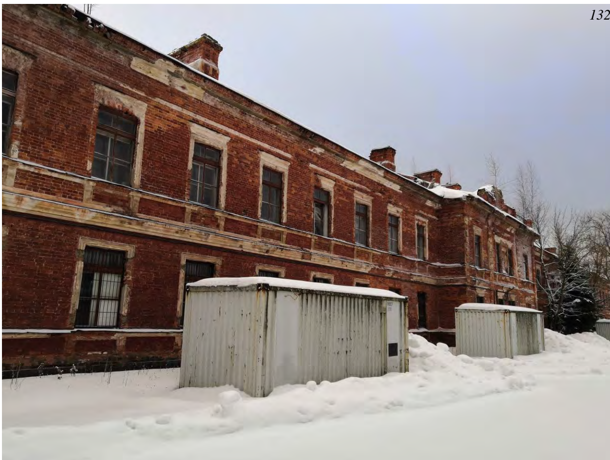
Фото.75. Казарма (расположена в центре территории военной части). Вид на северо-западный фасад. Фрагмент.
