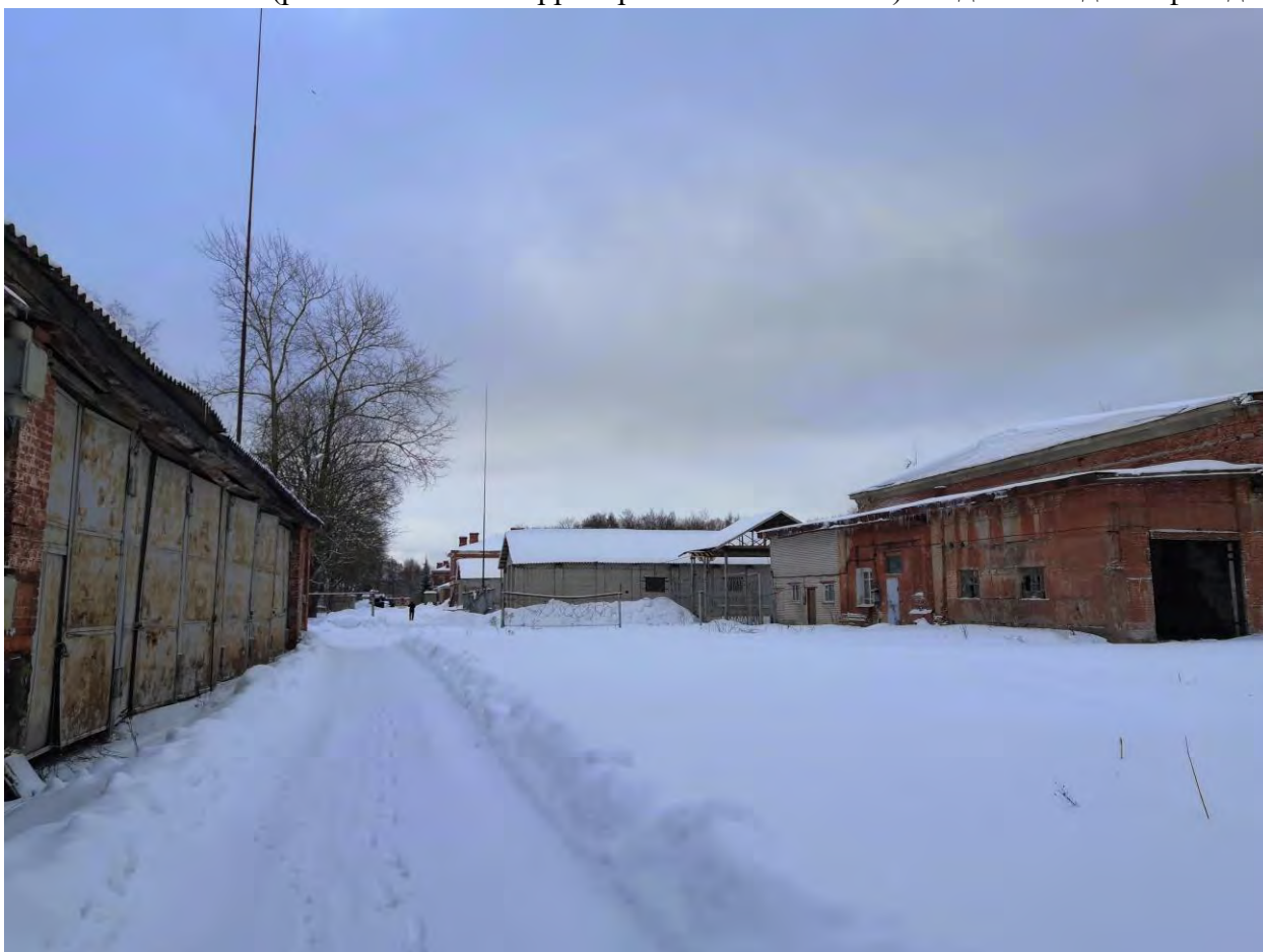
Фото.201. Конюшня (расположена на территории воинской части). Вид на западный фасад.
