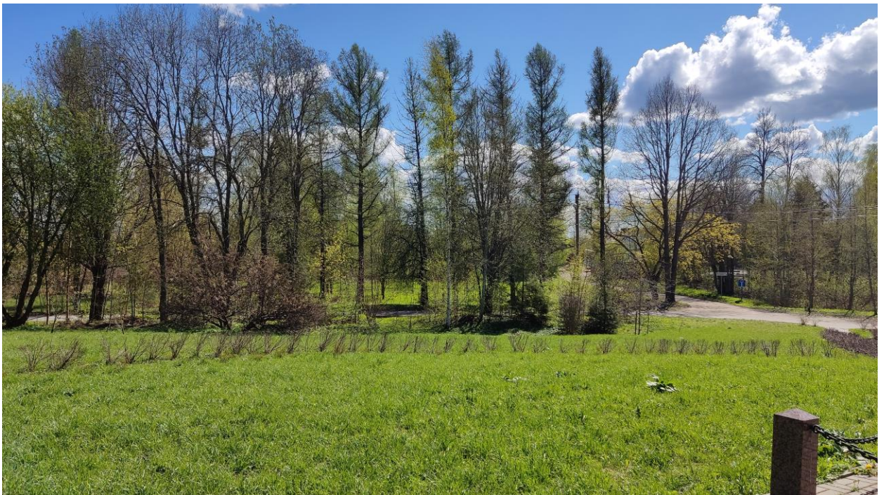
Объект культурного наследия регионального значения (ансамбль) ««Балашевский парк», 1817 г.». Фундамент оранжереи. Общий вид с северо-востока (от памятника А.Д. Балашову). 06.06.2022 г.
