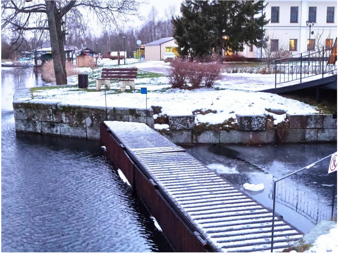
7. Вид объекта с севера.
