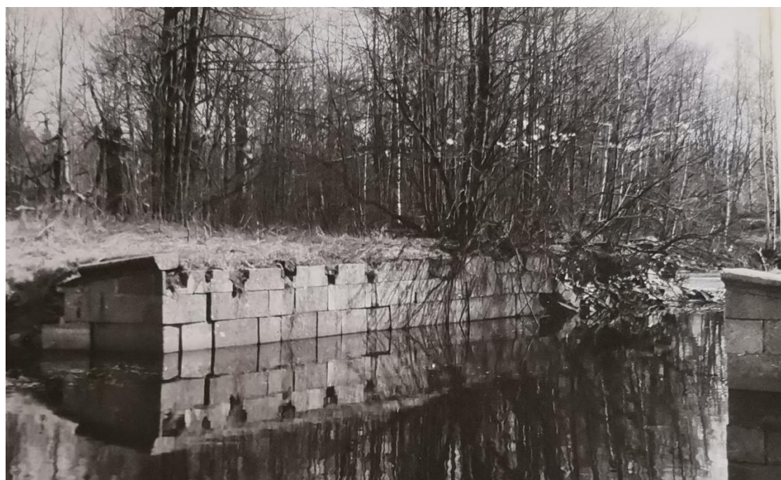
19. 1997 г. Белозерский южный водоспуск. Общий вид. Фото из: Лермонтова М.А. ук. соч., с. 306.
