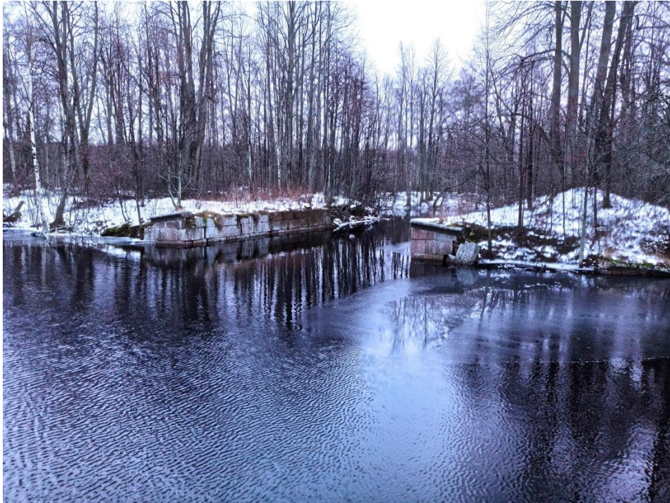
1. Общий вид объекта с запада.
