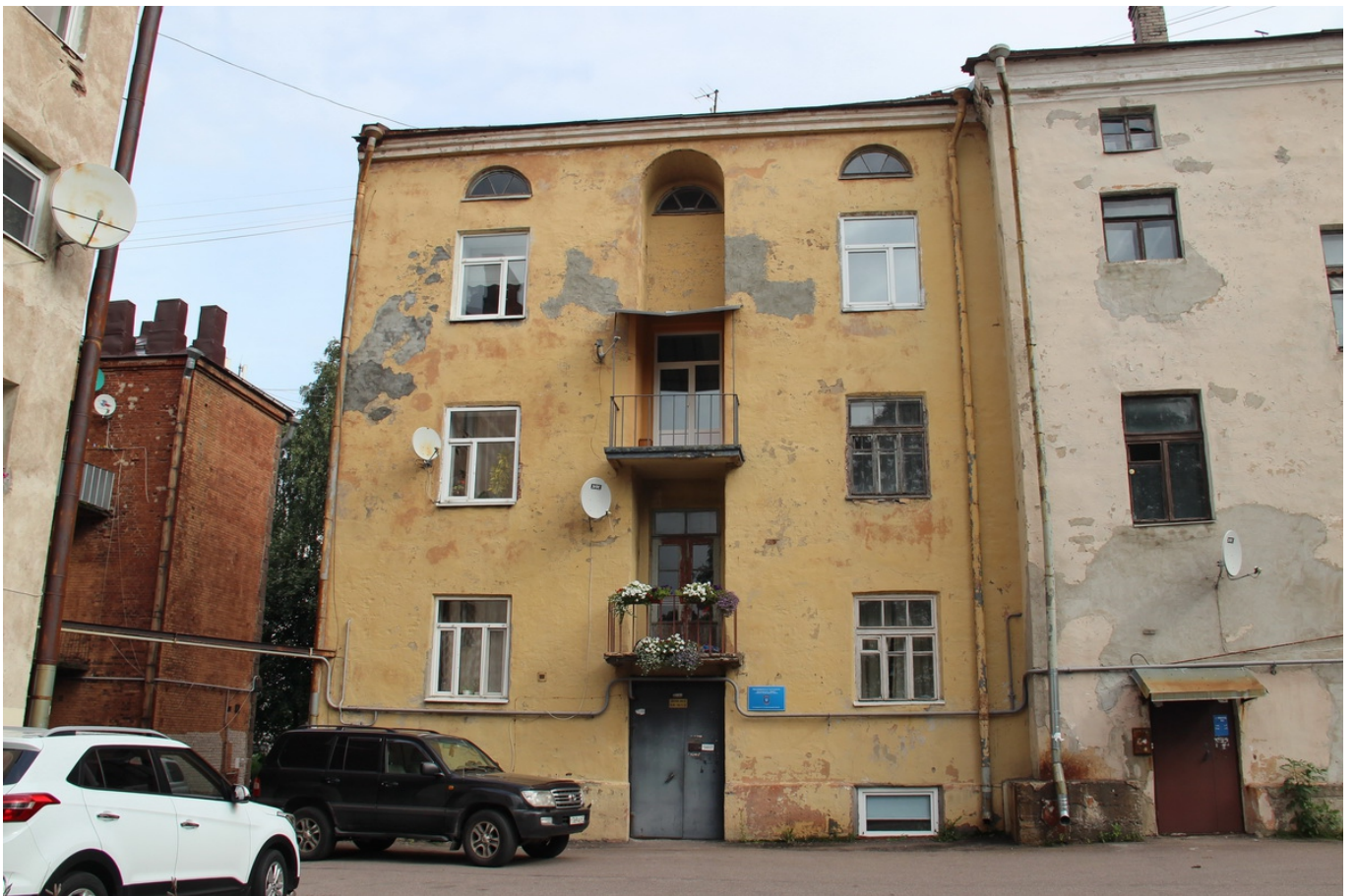
3 ОКН регионального значения “Жилой дом” ул. Выборгская, д. 3. Вид на южный дворовый фасад. Дата съемки: 13.10.2021 г.
