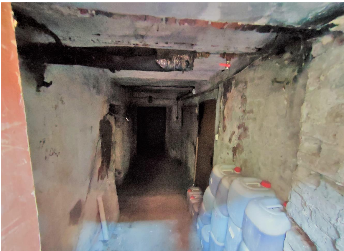
Фото 5. Вход в подвальные помещения. Дата съемки: 11.04.2022 г. Автор: Прокофьев М.Ф.
