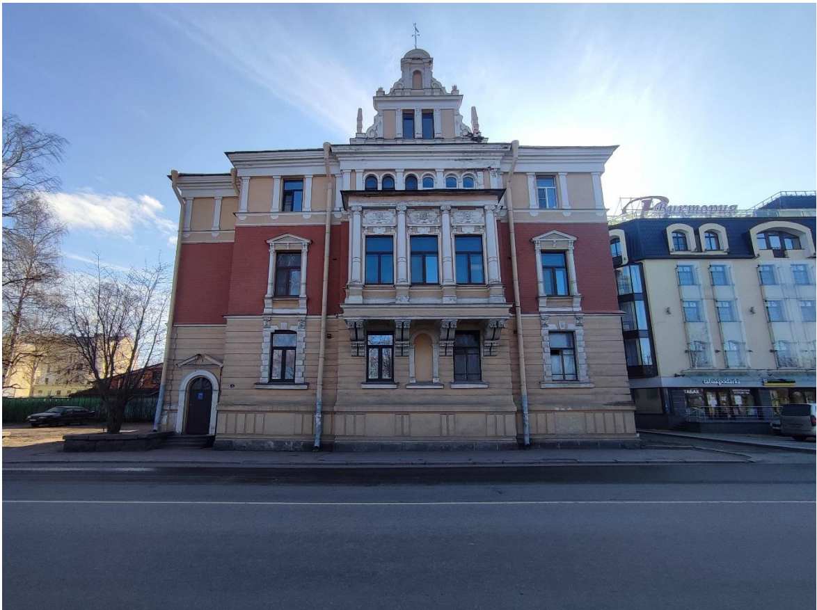
Фото 1. Общий вид здания с северо-востока, с наб. 40-летия ВЛКСМ. Дата съемки: 11.04.2022 г. Автор: Прокофьев М.Ф.
